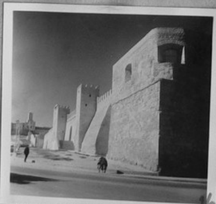
74-3408-26-Крепостна стена в гр. Сусе. /Г. Стоянов/ИК
