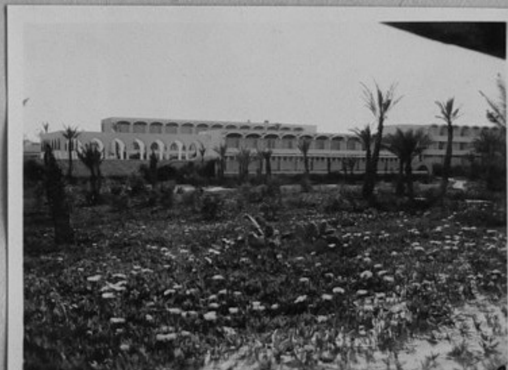
67-2523-29-Хотел Живара в град Сус-по проект на бълг.архитекти.
