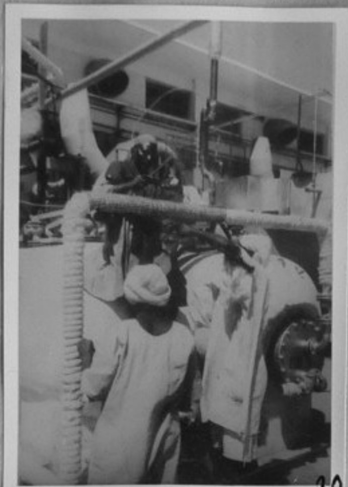
68-1440-30- Завършване на монтажната работа в котелния цех на завода за мляко в градчето Бабанус. Млекозаводът се строи с помощта на СССР./Репр./СС
