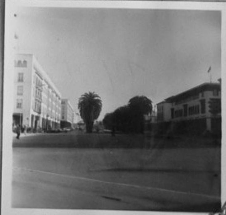
74-3406-26-Изглед от гр. Рабат. /Г. Стоянов/ИК
