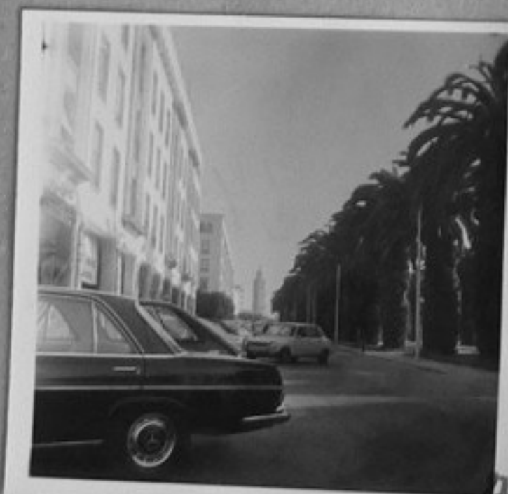
74-3406-27-Изглед от гр. Рабат. /Г. Стоянов/ИК
