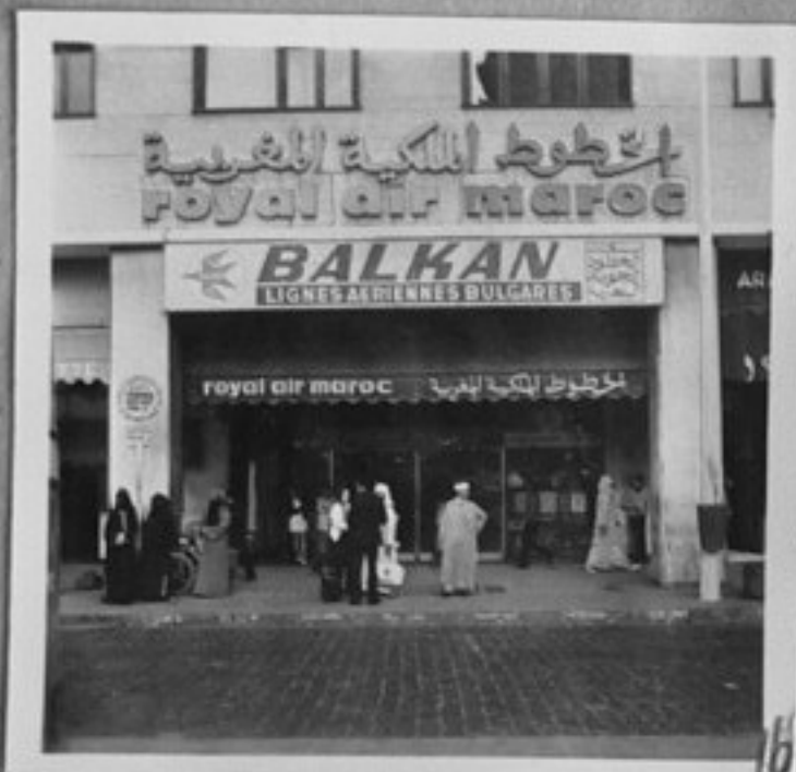
74-3401-16-Бюрото на авио-компания "Балкан" в гр. Казамбланка. /Г. Стоянов/ИК
