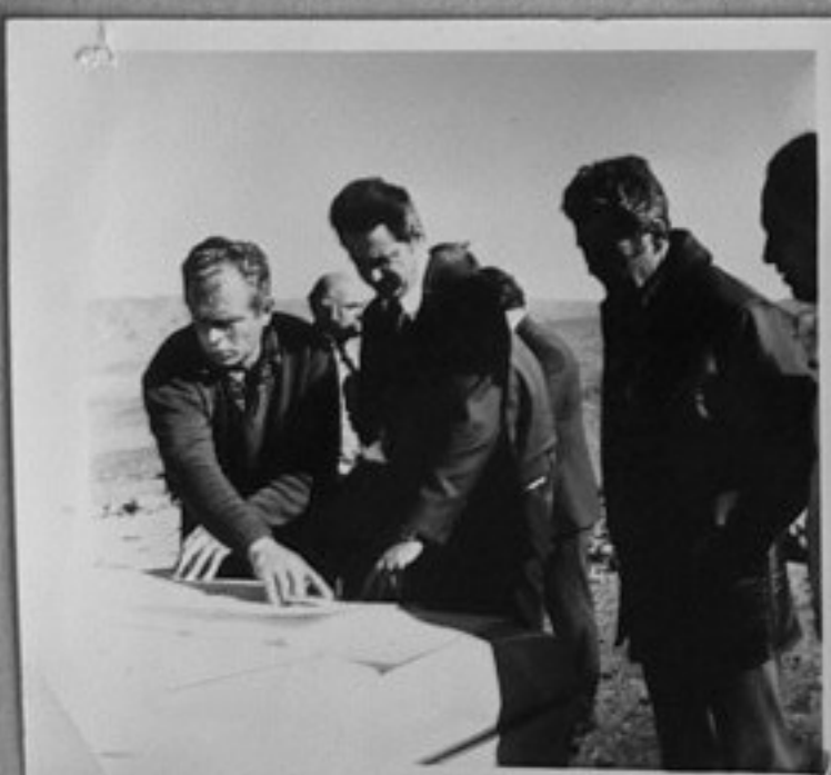
74-3403-26-ТЕС. Български специалисти работят по строителството на напоителната система на р. Драа. /Г. Стоянов/ИК
