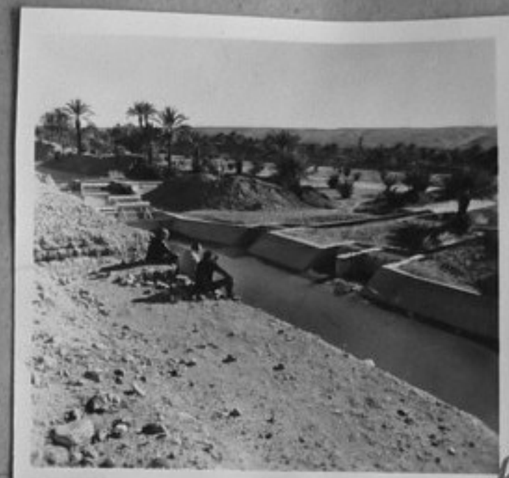
74-3403-6-Строителство на техноексплоатстрой.Разпреде- лителни съоръжения на напои- телната система по долината на р.Драа. /Г.Стоянов/ИК
