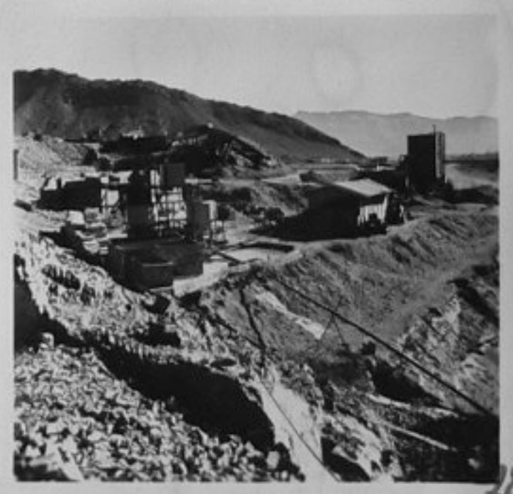
74-3403-28-ТЕС. Строителна база на строежа на напоителната система на р. Драа. /Г. Стоянов/ИК
