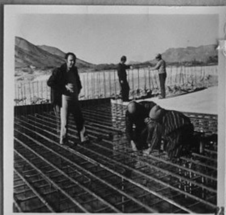
74-3403-23-Строеж на бараж по долината на р. Драа. /Г. Стоянов/ИК
