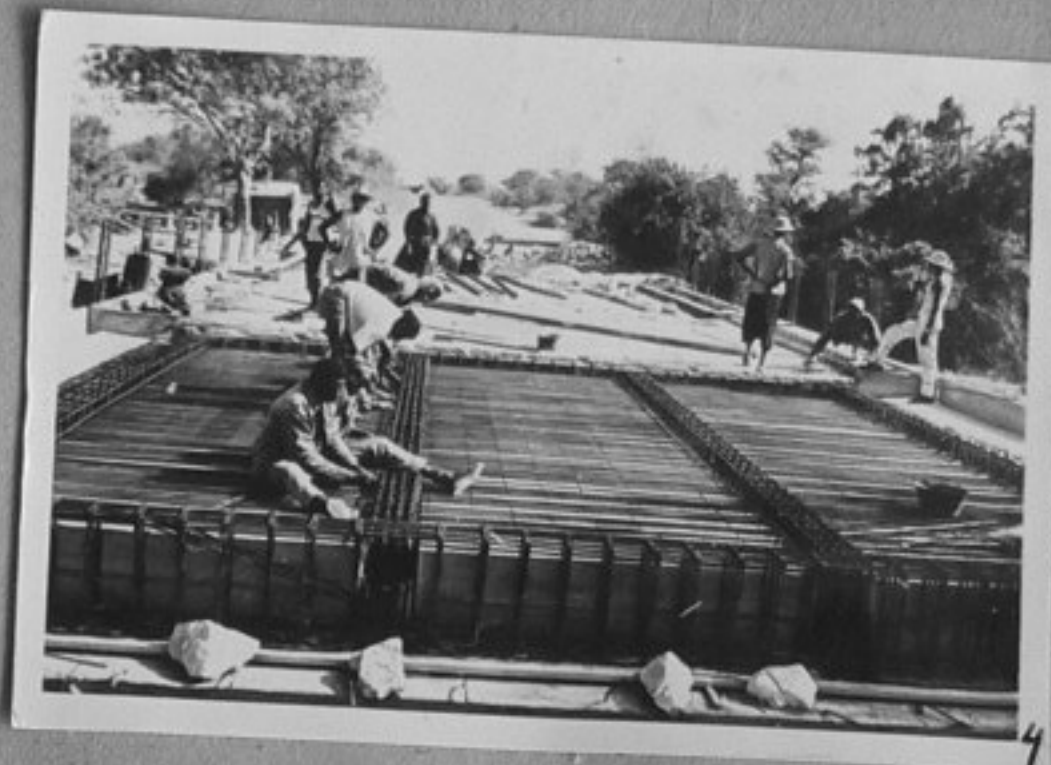
4-Малийски работници на строежа на нов мост.
