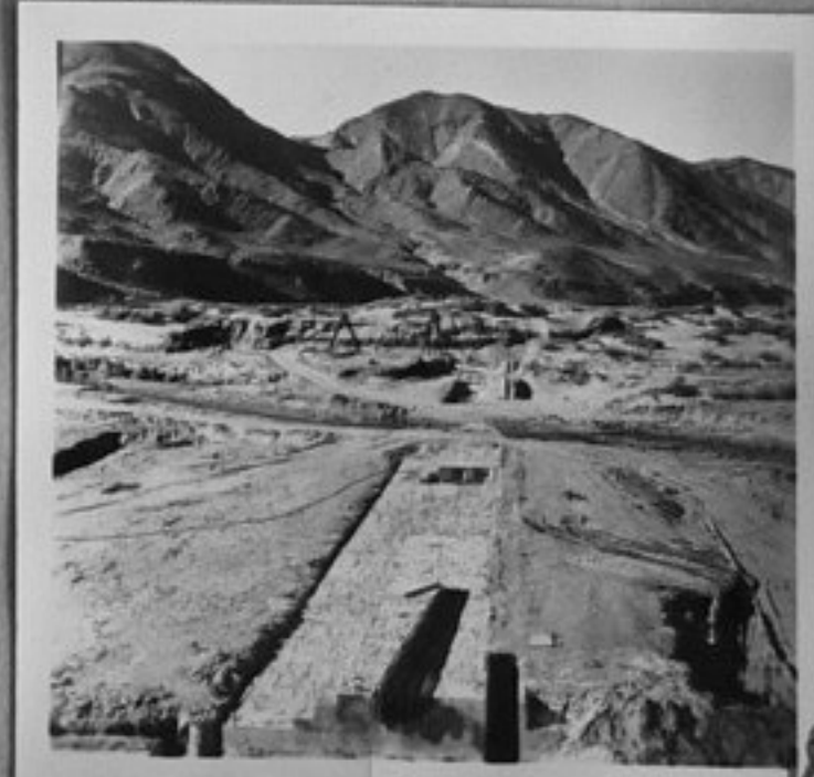
74-3403-18-ТЕС, строеж на бараж по напоятелната система на р. Драа. /Г. Стоянов/ИК
