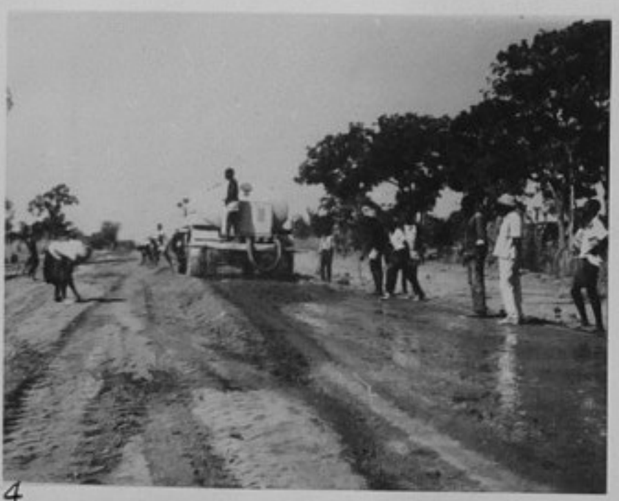
34 - Строеж на пътища в Малийската република. Поради твърдостта на почвата налага се трасето да бъде поливано с вода.
