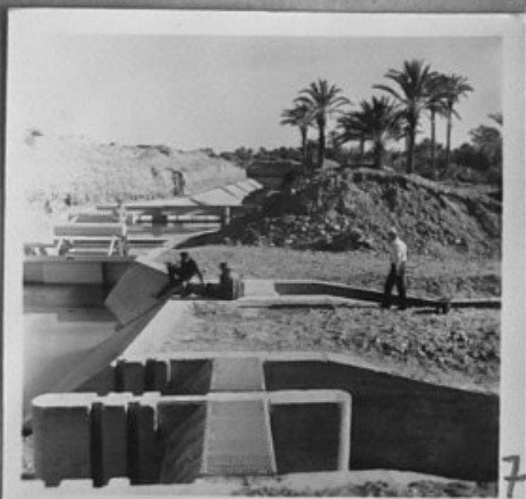
74-3403-7-ТЕС - разпреде- лителни съоръжения на на- поителната система на р. Драа. /Г.Стоянов/ИК
