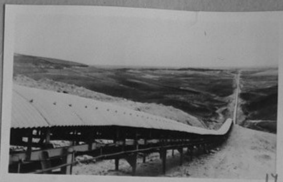
75-3574-16-17-Девет километрова транспортна линия за транспортиране на фосфатна руда от мините до Юсуфия, по която се пренася 420 т. фосфатна руда на час. /сн.ЧТК/, /репр./, ЗЩ
