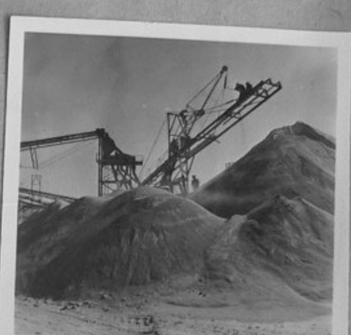
74-3405-21-ТЕС. На строежа на летище Триполи. /Г. Стоянов/ИК
