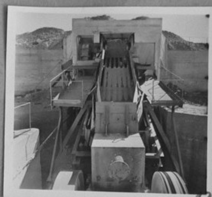
74-3405-12-ТЕС. Гр. Триполи. Съоръжения на строителната площадка на летище Триполи. /Г. Стоянов/ИК
