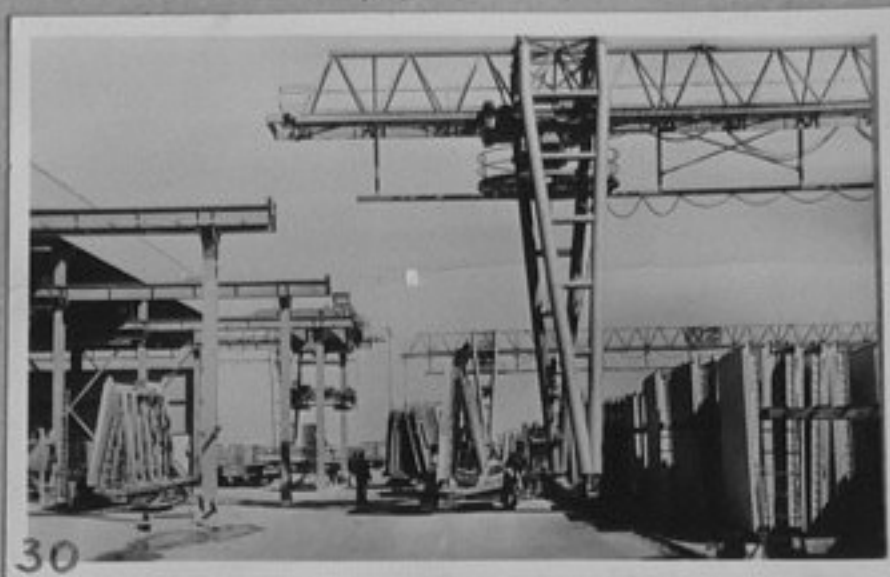
79-216-30 В един от цеховете на домо-строителен комбинат в Триполи репр./МД
