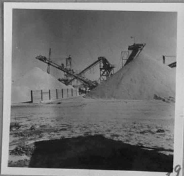
74-3405-19-ТЕС. Строитель- ная площадка на летище Триполи. /Г. Стоянов/ИК
