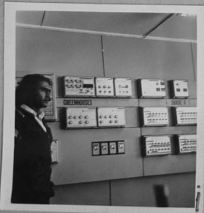
80-234-1 Из Либия - Командно табло на система от автоматични машини - използва се за парниково произв.на горски посадъчни материали
