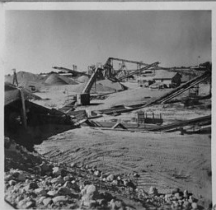
74-3405-15-ТЕС. Строителната площадка на летище Триполи. /Г. Стоянов/ИК
