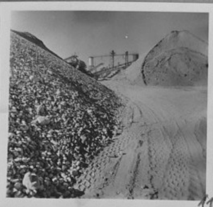
74-3405-11-ТЕС-гр. Триполи. Инертни материали на строителната площадка на летището. /Г. Стоянов/ИК
