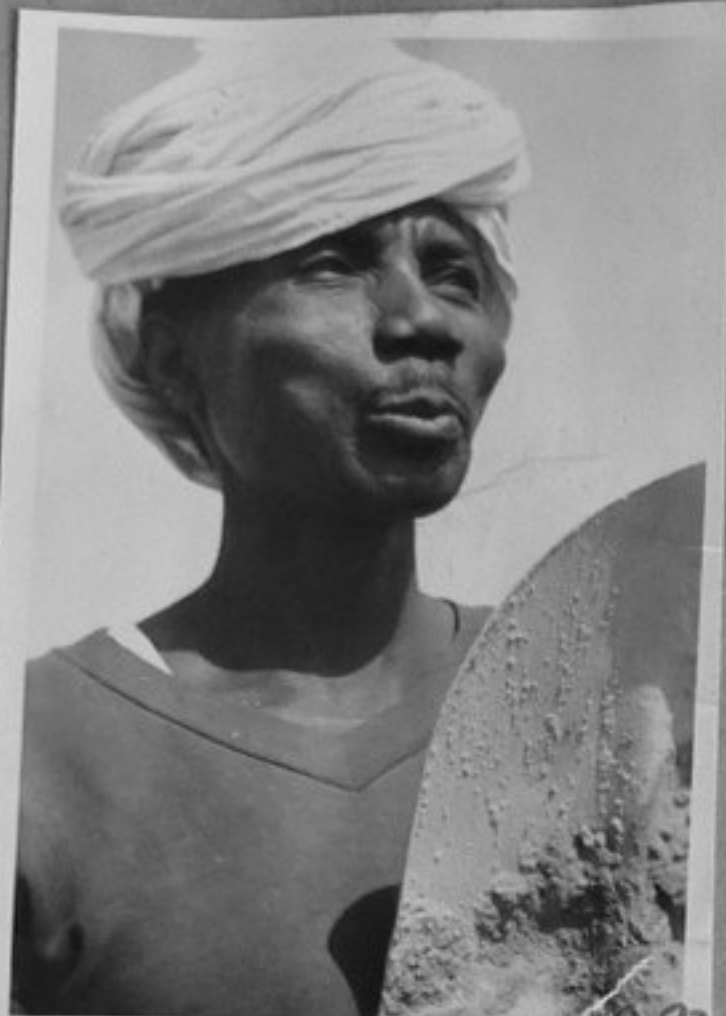
74-3405-23-ТЕС. Строител на летището в гр. Себха. /Г. Стоянов/ИК
