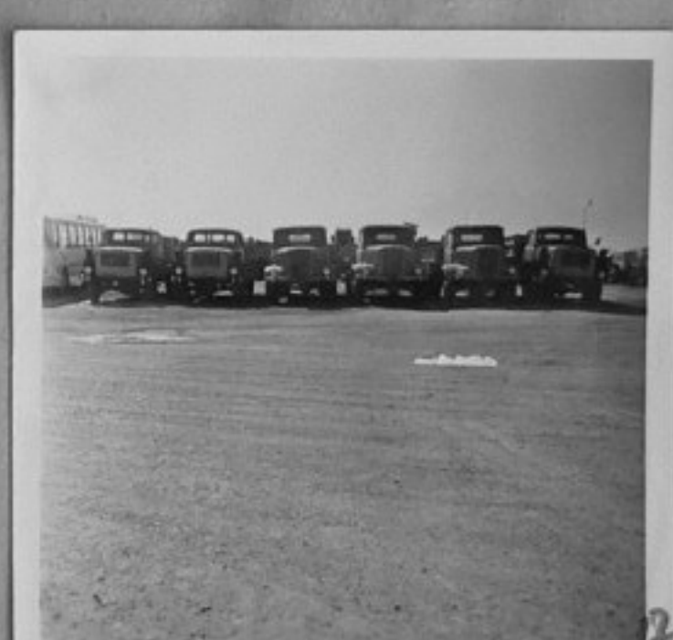
74-3409-17-ТЕС-Либия, гр. Триполи. Машинен парк на централната строителна база. /Г. Стоянов/ИК
