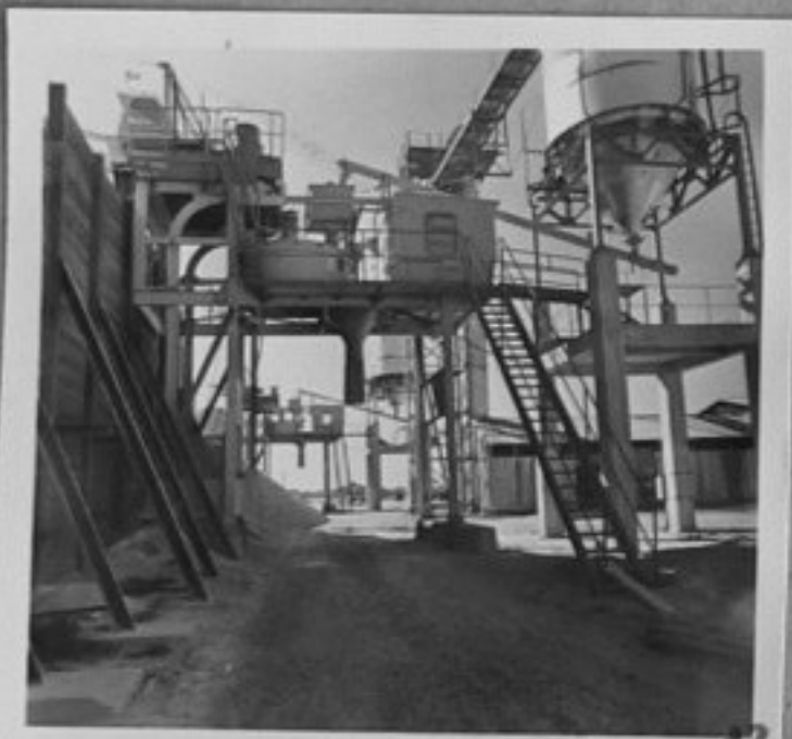
74-3405-13-ТЕС-гр. Триполи-летището. Бетонен възел. /Г. Стоянов/ИК
