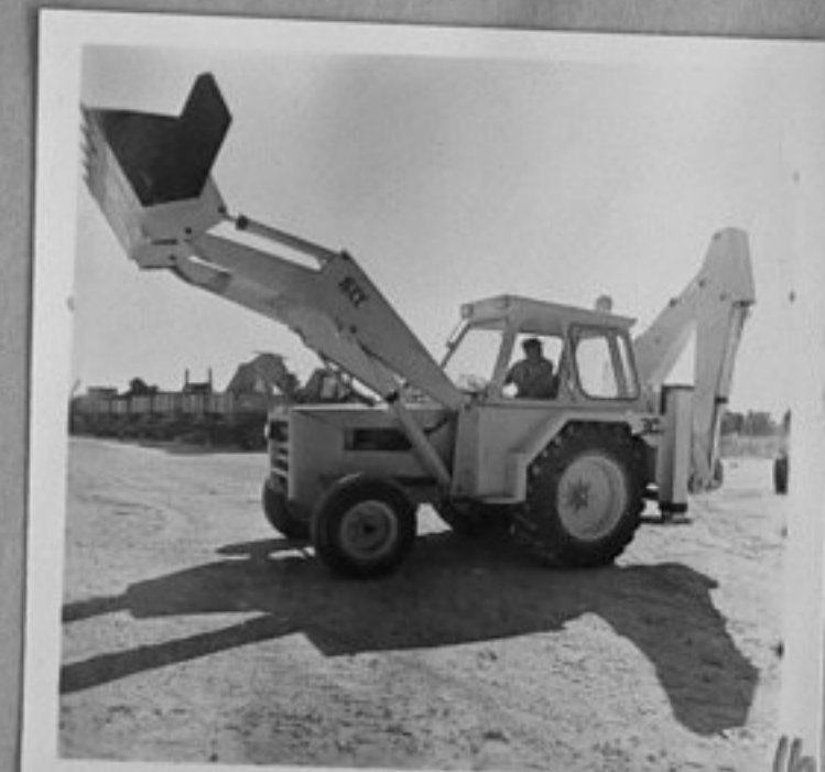
74-3409-16-ТЕС-гр. Триполи. Самотовареща и разтоварваща машина в централната строителна база на "Техноекспорт". /Г. Стоянов/ИК
