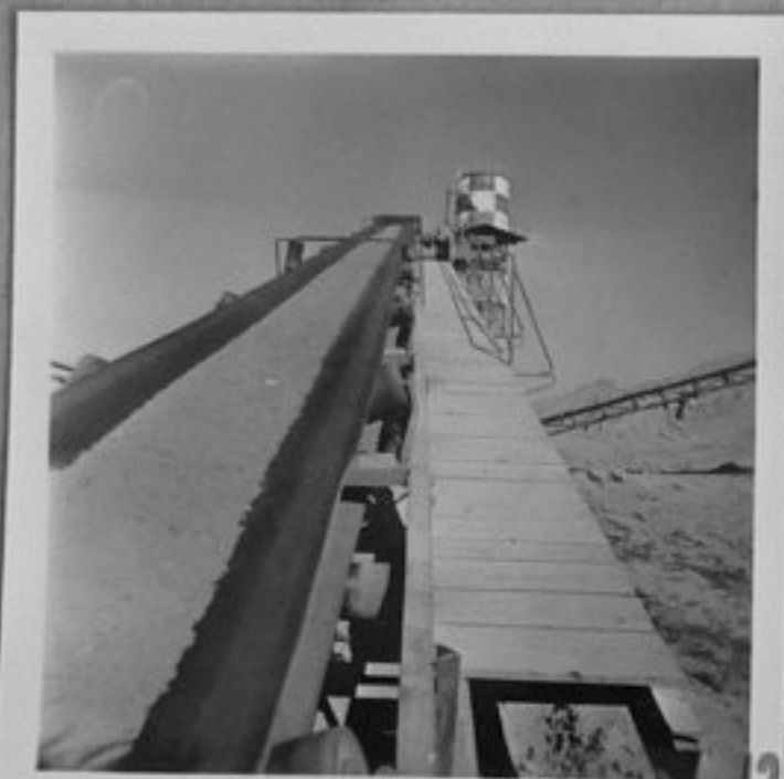
74-3409-12-ТЕС-гр. Триполи. Естакада на строителната площадка на летище Триполи. /Г. Стоянов/ИК
