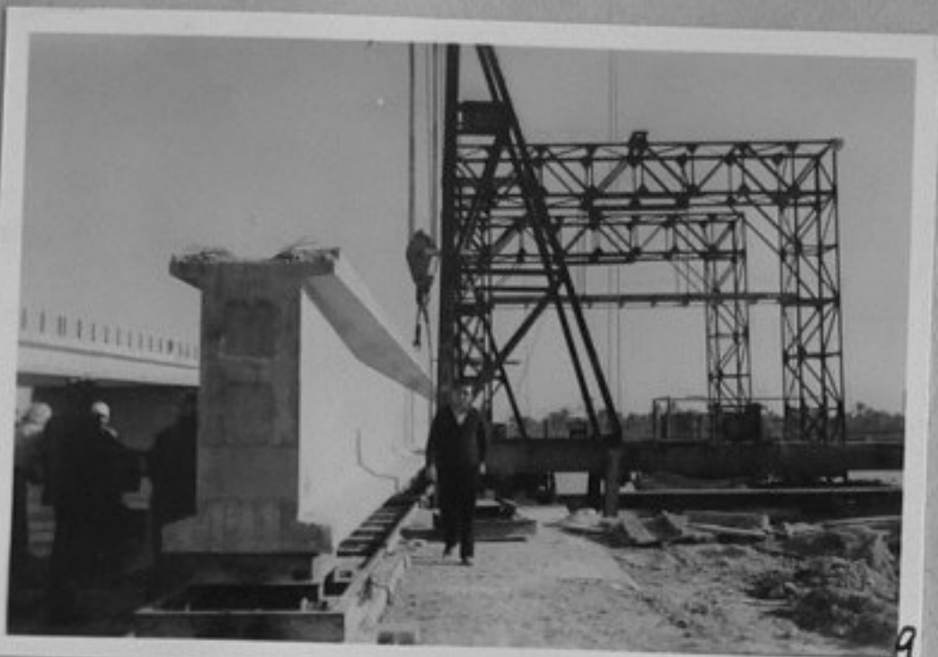
67-2528-9-Строежът на моста при Басра. /Ганчо Стоянов/СС
