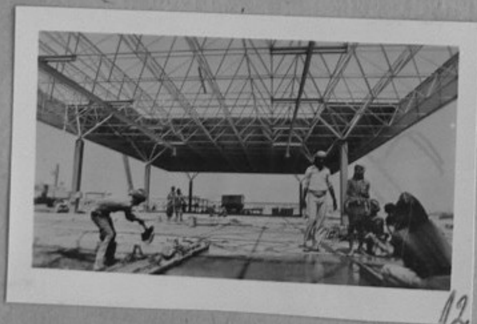
83-133-12 На строежа на един от корпусите на централните ремонтни работилници за мелиоративна техника.
