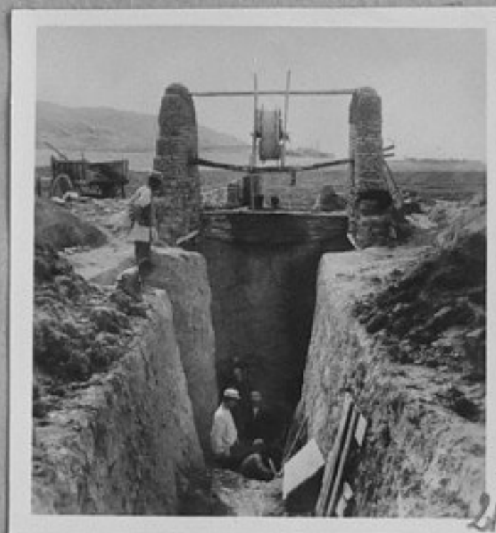
70-1701-21-Изгражда се обширна мрежа от подземни канали, които ще съхраняват и отвеждат водата до посевите. /репр.П.Щерев/ ХП
