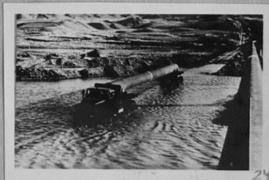
70-1131-24-На строежа на магистралния газопровод, който се строи в тясно сътрудничество със съветски специалисти. /репр.П.Щерев/ XII
