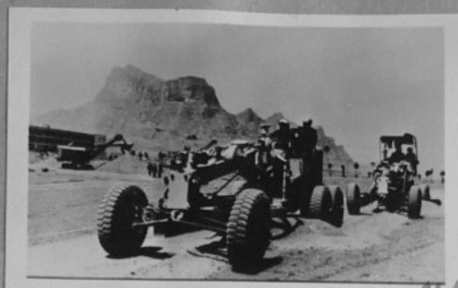
72-5594-161-Практически занятия в строителния учебен център, построен със съдействието на Съветския съюз. /репр./ ИК
