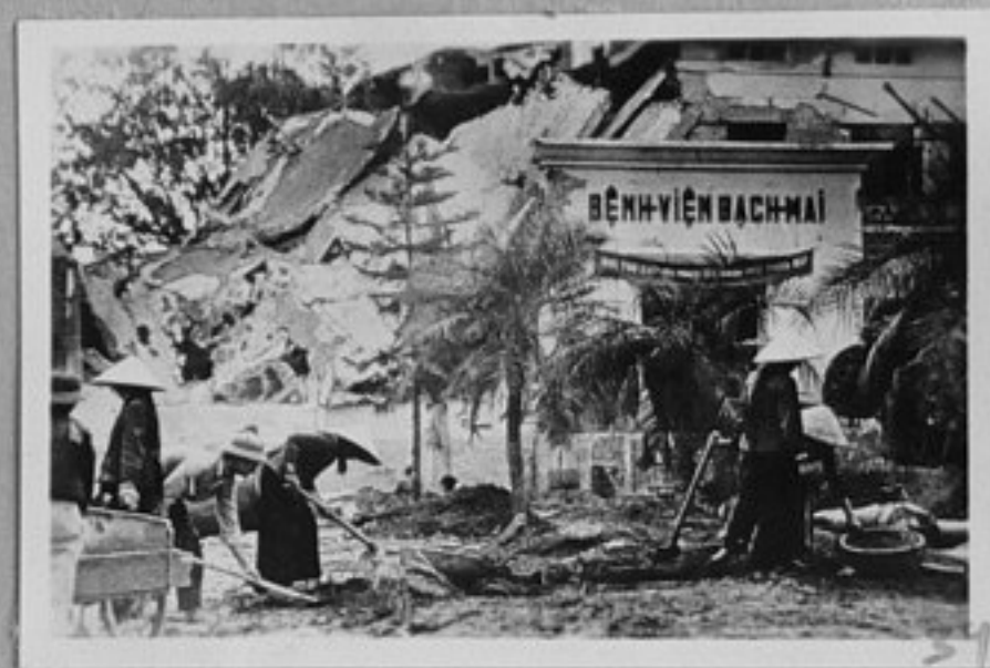
73-1043-34 - Жителите на Ханой разчистват и възстановяват напълно разрушената болница Батмай в Ханой. Болницата е била разрушена през декември 1972 г. Скоро ще израстнат корпусите на новия медицински център. /репр./ЕИ
