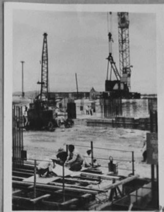
80-3115-20 С помощта на Съветския съюз започна строит. на ТЕЦ във Фа Лай, провинция Куанг Нин, североизточно от Ханой, чиято първа фаза ще бъде с капацитет 1300000 киловата годишно
