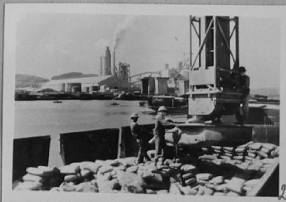
88-20-2-Циментов з-д Хоанг Тач в провинция Хай Хунг/на север от Ханой/ построен с помощта на Дания. /репр./ЛА
