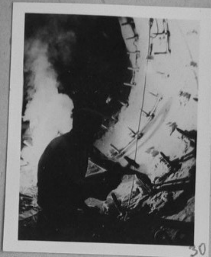
73-2980-30 - Въстановяване на засегнато от американските бомбардировки огнеупорна пещ в Циментовия завод в Ханой. /репр. П.Щерев/ТК
