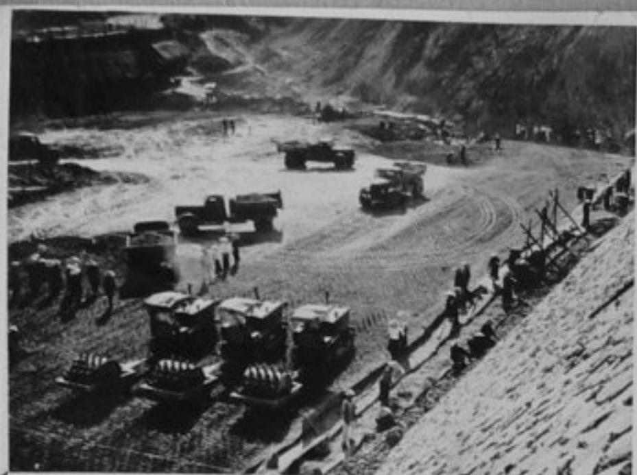
65/225-4-На строежа на язовир Камли. /ММ/ 24/36
