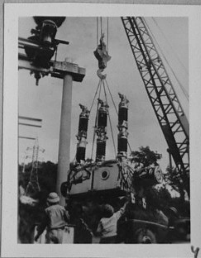
73-3863-4-Монтажна бригада при ВЕЦ Так Ва, провинция Йен Бай работи за бързото реставриране на предприятието от американските бомбардировки. /репр.П.Щерев/ТК
