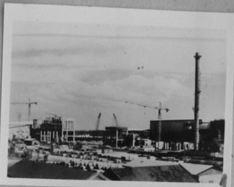
79-4158-1 В Бай Банг, провинция Вин Фу, северозападно от Ханой се строи хартиена ф-ка с помощта на Швеция, с проектна годишна мощност на производството 55000 тона - на строит. площадка във Бай Банг репр./МД
