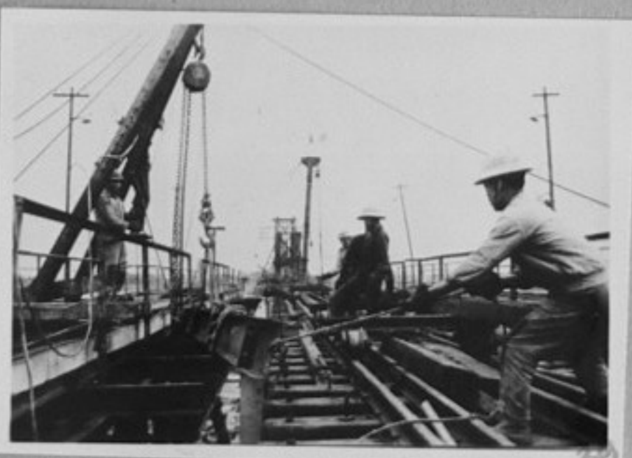
73-1043-39 - Възстановителни работи на моста в Лонг Биен от трудещите се - резултат от изпълнение на решението на ЦК ВПТ и Правителството на ДРВ. /репр./ ЕИ
