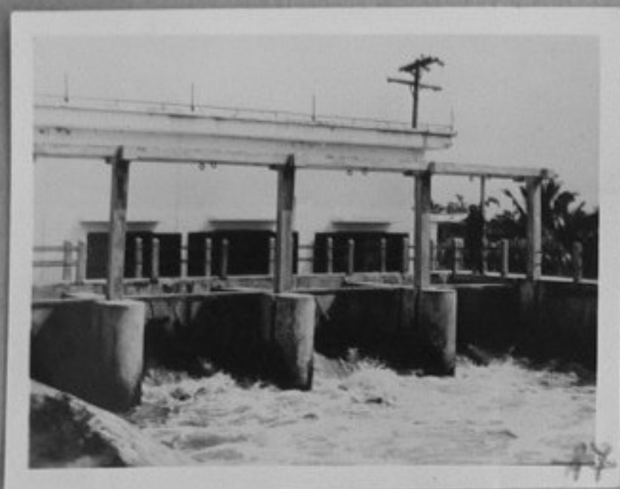
80-122-17 Новопостроената помпена станция "Хау Джианг I" в Хау Джианг в делтата на река Меконг има капацитет от 16000 куб.м в час. Тя напоява 2050 хектара и отводнява 700 хектара оризови полета в обл. Фунг Хиен репр./МД
