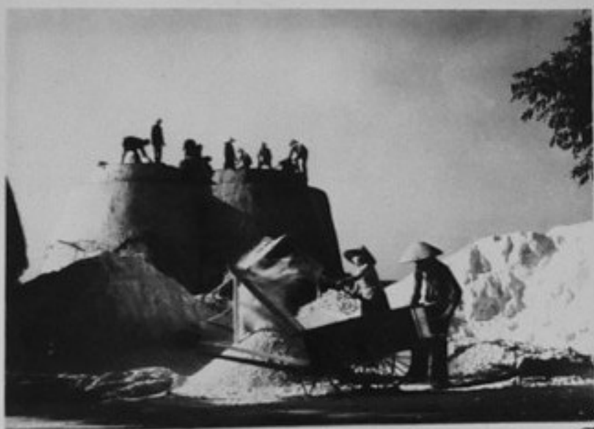
66/123-27 - Новопостроената варна пещ в Хоп Нхат, предградие на гр. Хайфон. /ЕИ
