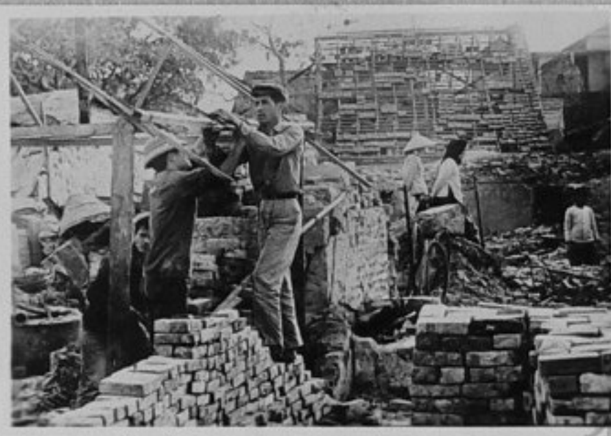
73-1043-26 - Докато мъжете строят и възстановяват разрушените от американските бомбардировки къщи, жените разчистват строителните площадки. /репр./ЕИ
