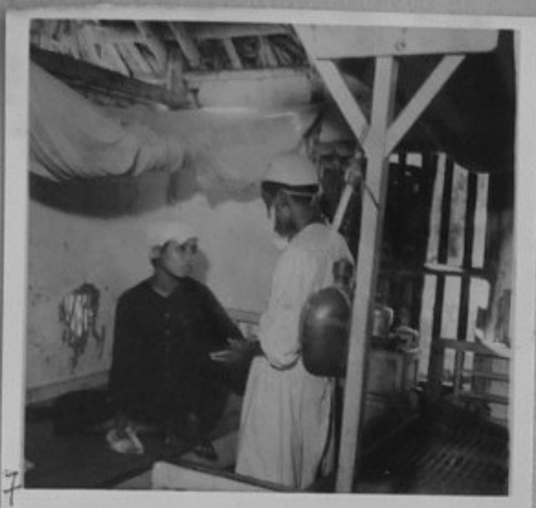
7 67-4377-7 - В разрушената болница.
