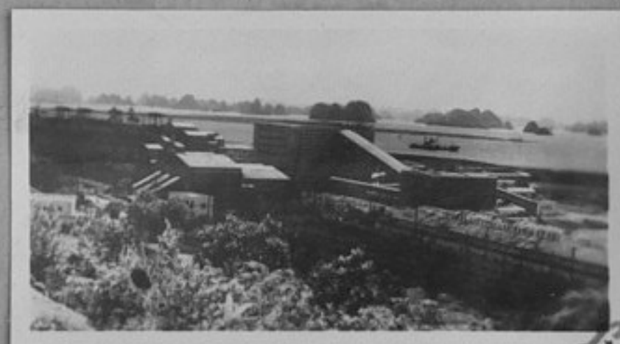
80-3115-23 Фабриката за сор- тиране на въглища в Ха Лонг Бай, построена с помощта на ПНР
