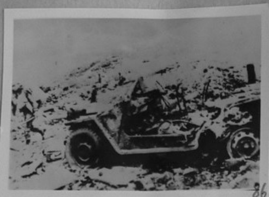
73-186-86-Разрушена блиндирана кола в Ан Кхе. /М.Хаджикостова/ТК
