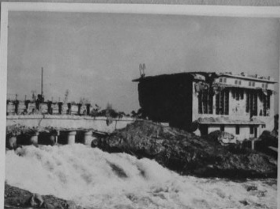
65/2767-34- Възстановяване на язовира и ВЕЦ Бан Тач в провинцията Тан Хоа след разрушаването им от американски бомбардировки. 24/36 ЕИ
