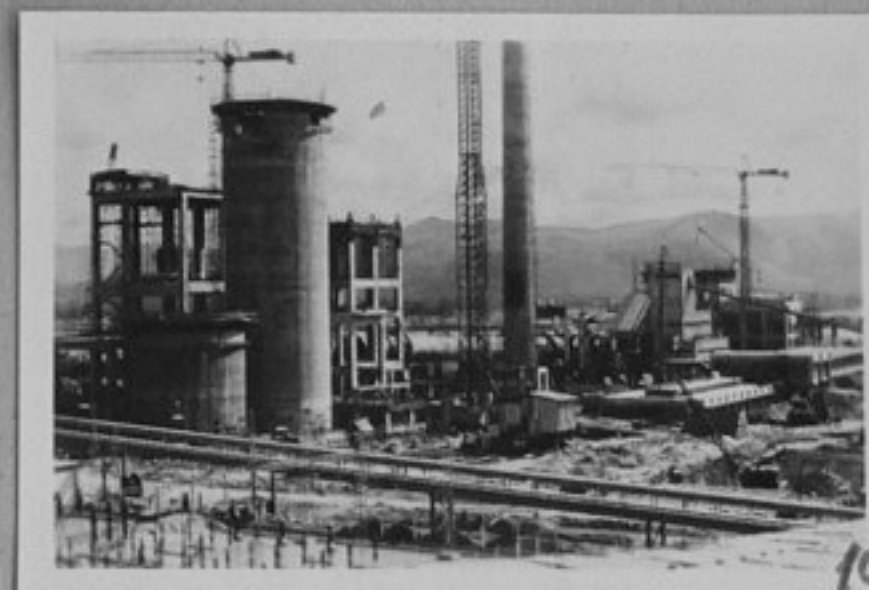
80-3115-19 Пред завършване е циментовият завод Хоанг Тач в провинция Хай Хуанг, на югоизток от Ханой, който ще има капацитет от 1200000 тона годишно след построяване на първата си фаза. Строежът се извършва с помощта на Дания Нгуен Тан/МД
