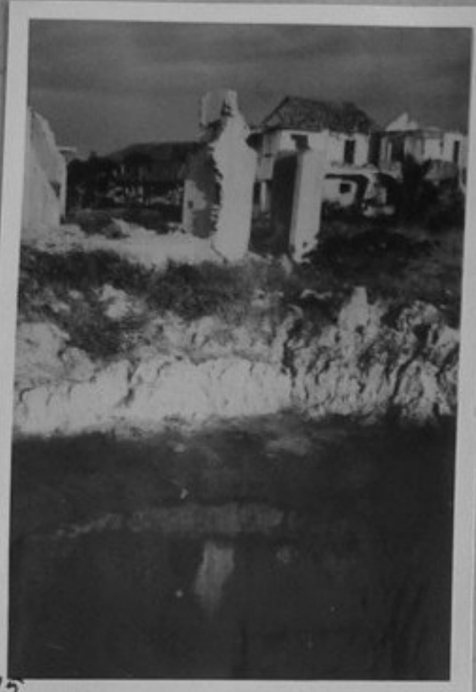
15 N 67-4377-15 - Разрушена болница. /ЕИ 24/36
