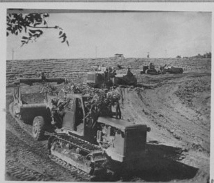
72-5919-14-Механизирана трудова бри- гада №21 към Министерството за опаз- ване водите и реките подсилва част от дига. /Репр.П.Щерев/МК
