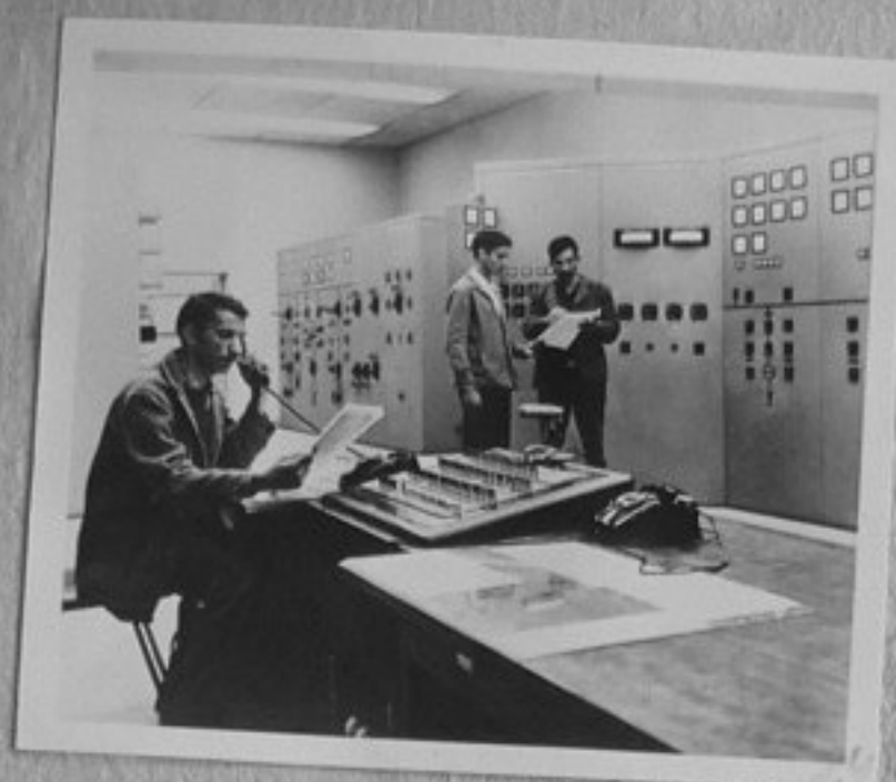
72-4252-24-Централният пулт за управление във ВЕЦ в Нагла. /репр./ ИК
