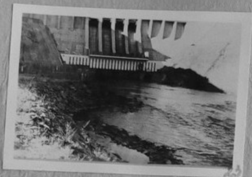
72-4252-23-Общ изглед от ВЕЦ в Нагла, най-мощната в страната на 70 км от столицата, построена с техническото съдействие на СССР. Тя снабдява с енергия промишлените предприятия на Кабул. /репр./ ИК
