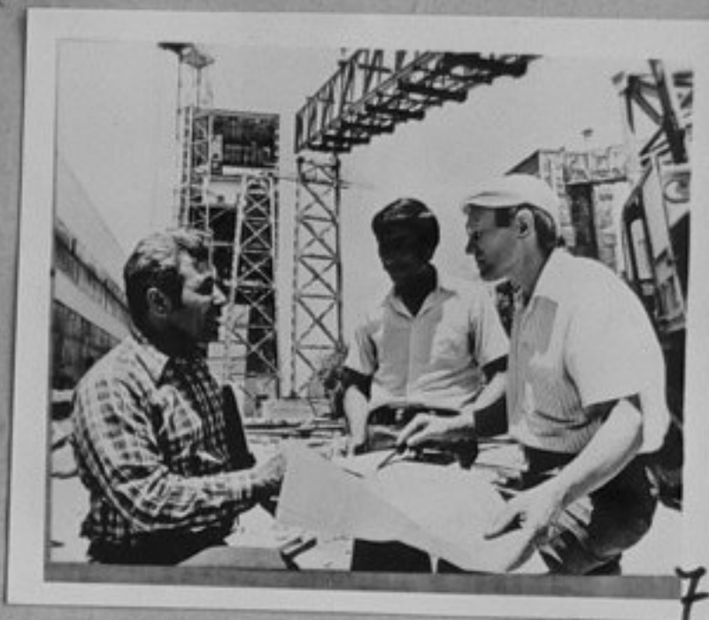
82-1416-7-От ляво на дясно: началникът на конструкторското бюро на Кабулския домостроителен комбинат Али Балуч, инж. на участъка Абдул Хаким и съв. инж. Владимир Глухенский на монтажа на новата естакада, /репр./ЛА
