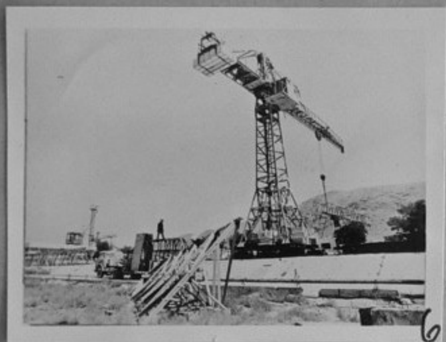
82-1416-6-Готова продукция на Кабулския домостроителен комбинат се отправя за строежите. /репр./ЛА
