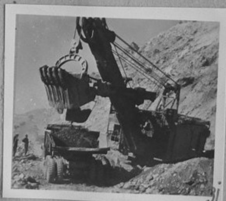
70-1444-31-Строителство на ВЕЦ "Наглу". /репр. П. Щерев/ XII
