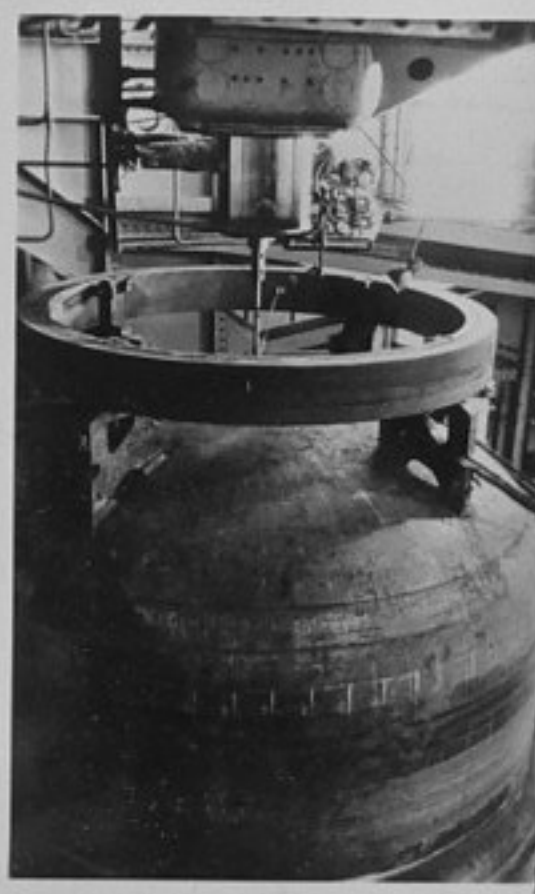
78-2495-3,4 В комбината "Шкода" в Пилзен се работи върху скъсения парен котел на атомния реактор, който ще бъде използван в реакторната зала за изпробване на капацитет за парни котли "ВВЕР-440"
