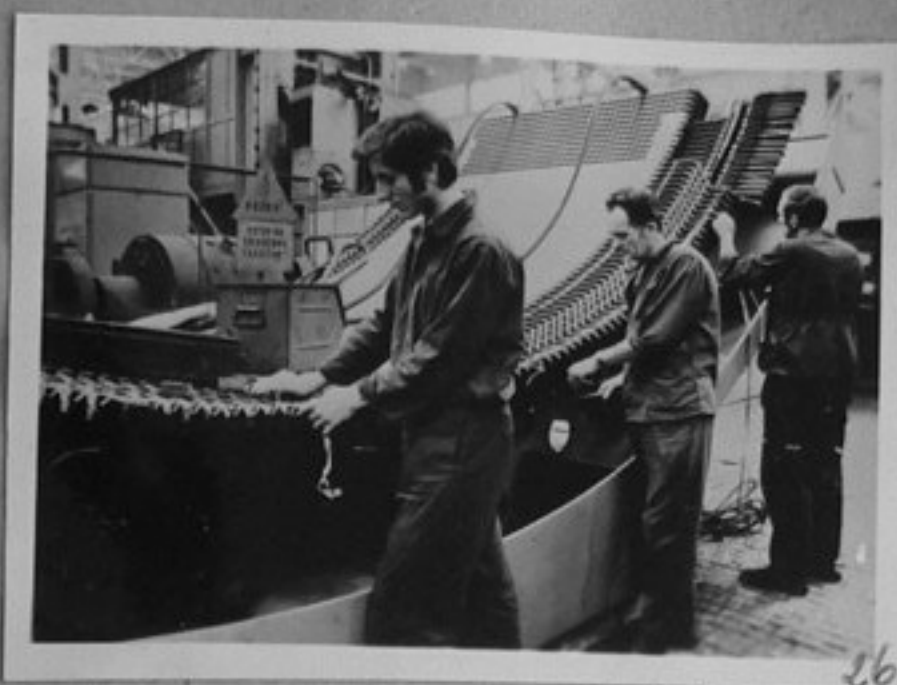
74-196-26-Монтажният цех за хидро-генератори за променлив ток, част от заводски статор. /репр. П. Щерев/ТК
