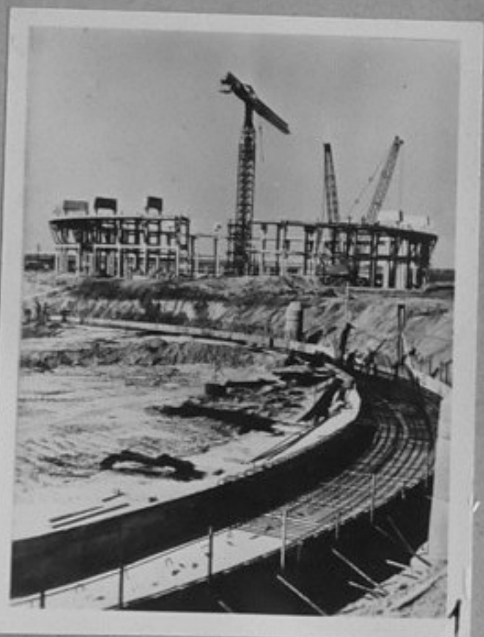
78-2495-1 В близката околност на атомната електростанция в Ясловске Бохунице, Западна Словакия, с пълна пара се работи на строежа на втора атомна електростанция от типа "Воронеж" - строителство на охладит. кули на новата атомна електростанция репр./МД
