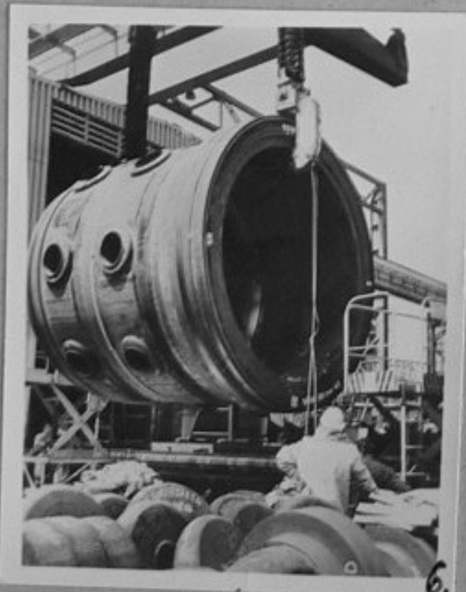
78-2495-3,4 В комбината "Шкода" в Пилзен се работи върху скъсения парен котел на атомния реактор, който ще бъде използван в реакторната зала за изпробване на капацитет за парни котли "ВВЕР-440"
