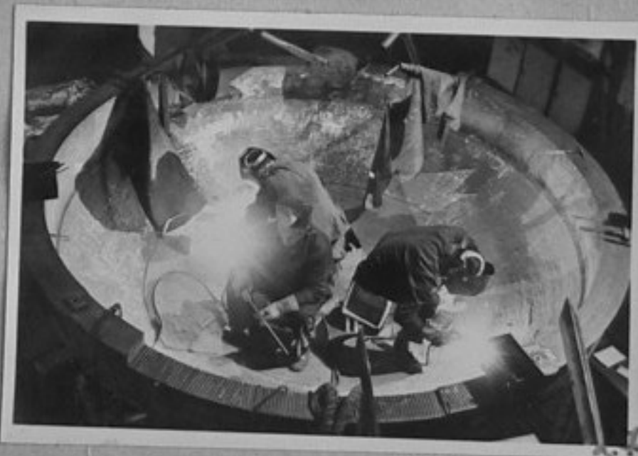
79-251-26,27 В завода за турбини "Шкода" работниците също са обвърнати с лице към неотложните задачи на енергийната промишленост. Те ще монтират няколко турбоагрегата с обща мощност близо 1000 мегавата, предназначени за чуждестранни клиенти. - подготовка на статор за нова листова преса "Полди-II" в Држи, Централна Бохемия репр./МД
