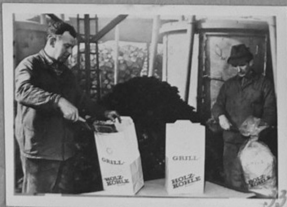
72-2020-32-Изваждане на дървени въглища от дестилационни пещи след процеса на суха дестилация. /репр.П.Щерев/МК
