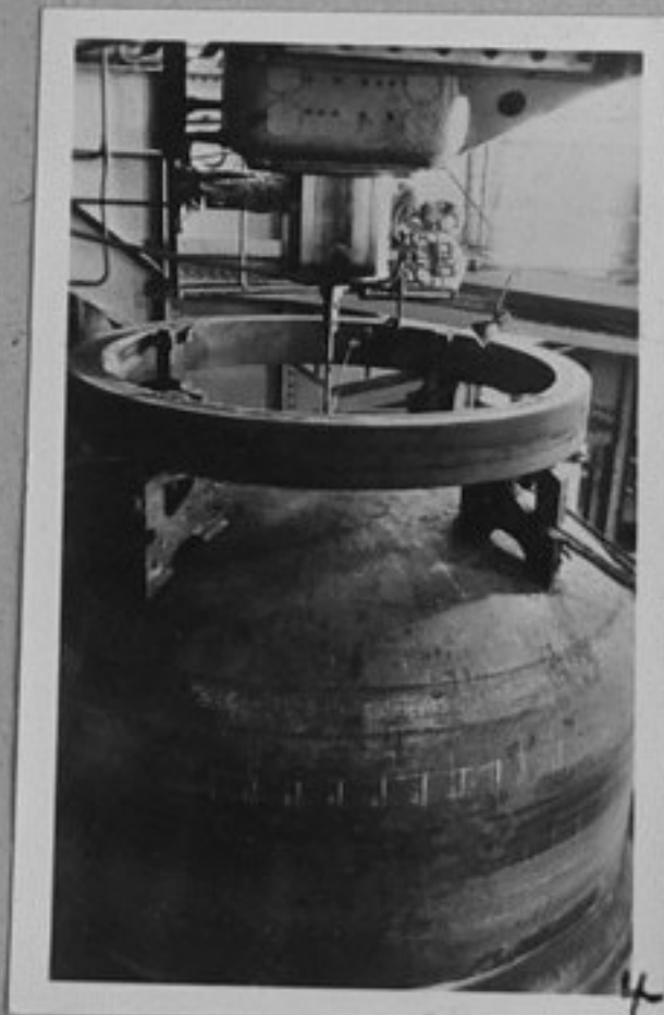
78-2495-3,4 В комбината "Шкода" в Пилзен се работи върху скъсен парен котел на атомния реактор, който ще бъде използван в реакторната зала за изпробване на капаци за парни котли "ВВЕР-440"
