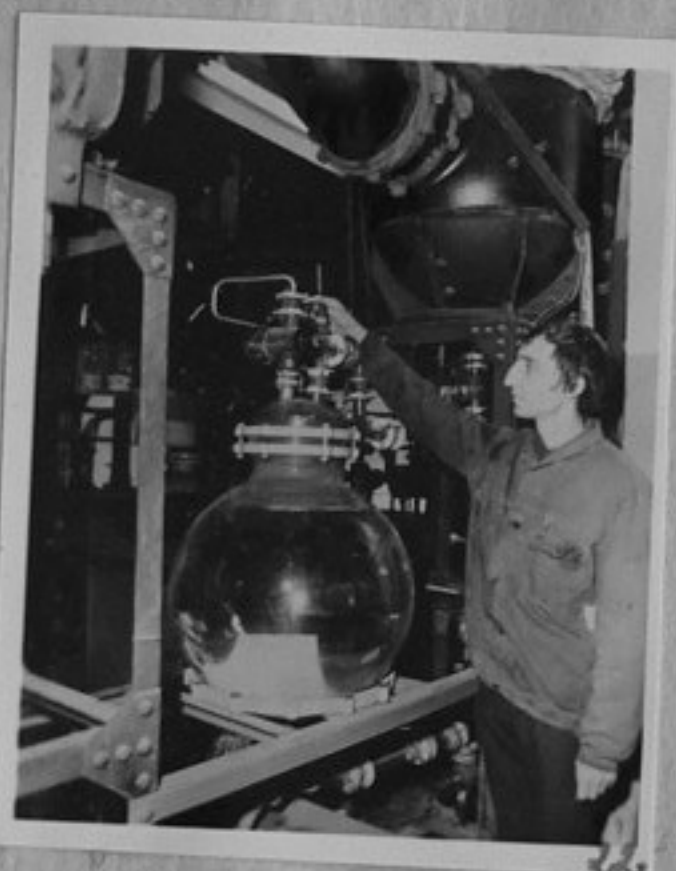
74-196-22-Дистилационна колона за 35% водороден пероксид в Хим.заводи в Соколов, Северна Бохемия. /репр.П.Щерев/ТК
