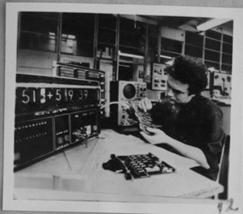
81-1383-12 Владимир Новотни провежда контрол чрез микро- процесор на агрегат от НС 660 контролна система
