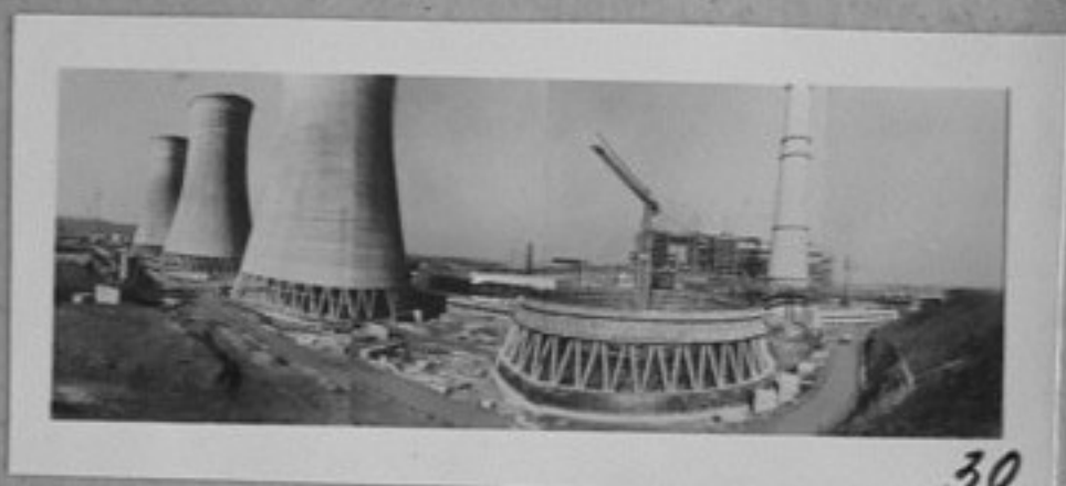
77-3222-30-Общ изглед от строителството на новата ТЕЦ в Чвалетице. /репр./ЛА
