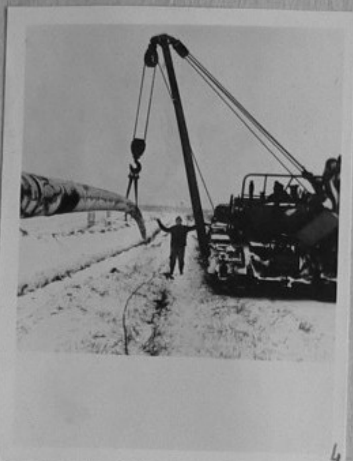
74-14-3,4-Първите метри от тръбопровода за транспорт на етилен от ГДР в Северна Бохемия. /репр.П.Щерев/СТК
