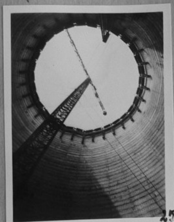
76-2794-25-Бригада от 55 души работи на строителството на охлаждащата кула на ТЕЦ "Почеради II". /репр./, ЙБ
