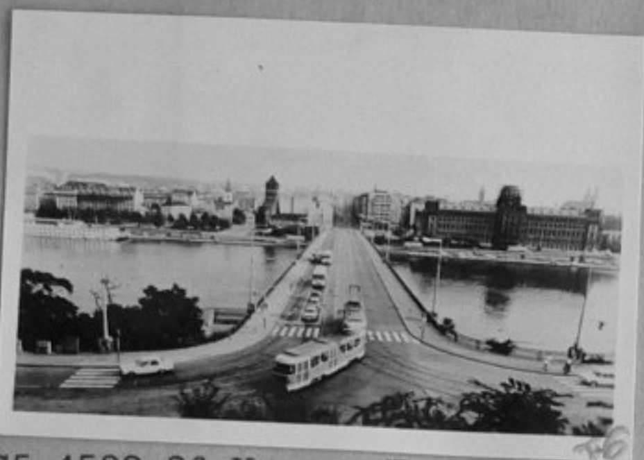
75-4522-26-Мостът Шверма, дълг 243 м и широк 24 метра, е построен в 1951 г. на мястото на предишния верижен мост Стефаник.
