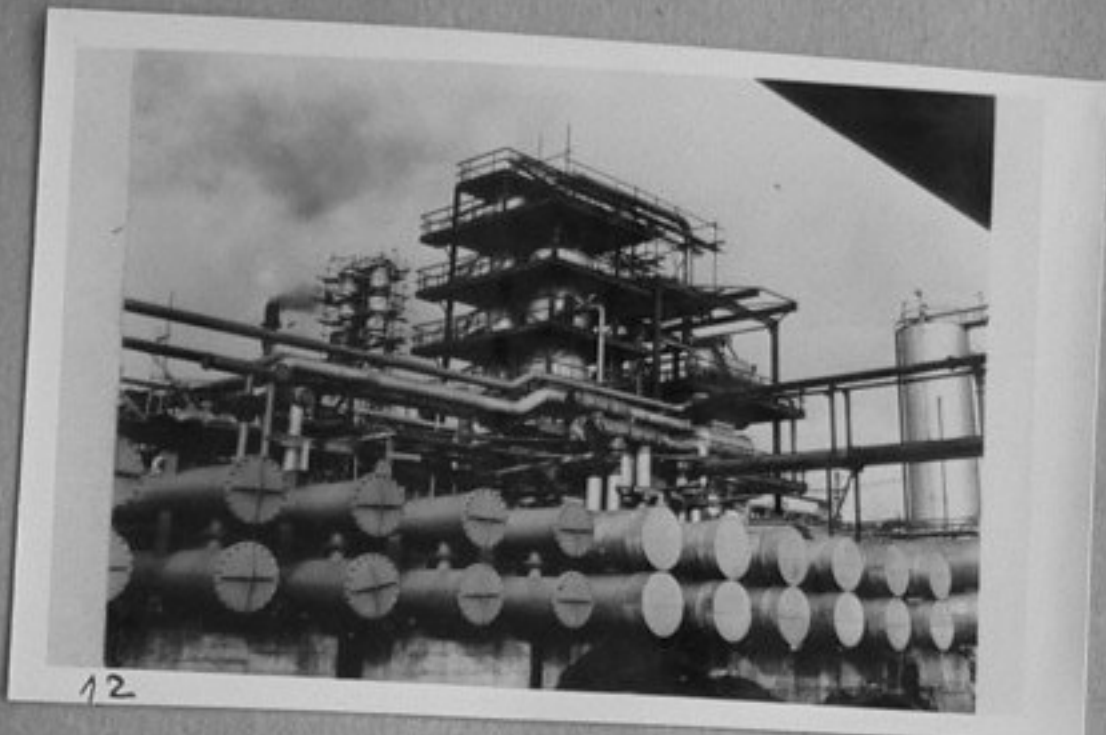
62/1094-12-Част от химическите съоръжения на завода за кокс "Йн Шверма" в Острава с новите модерни бензолони всмукатели. /ММ/
