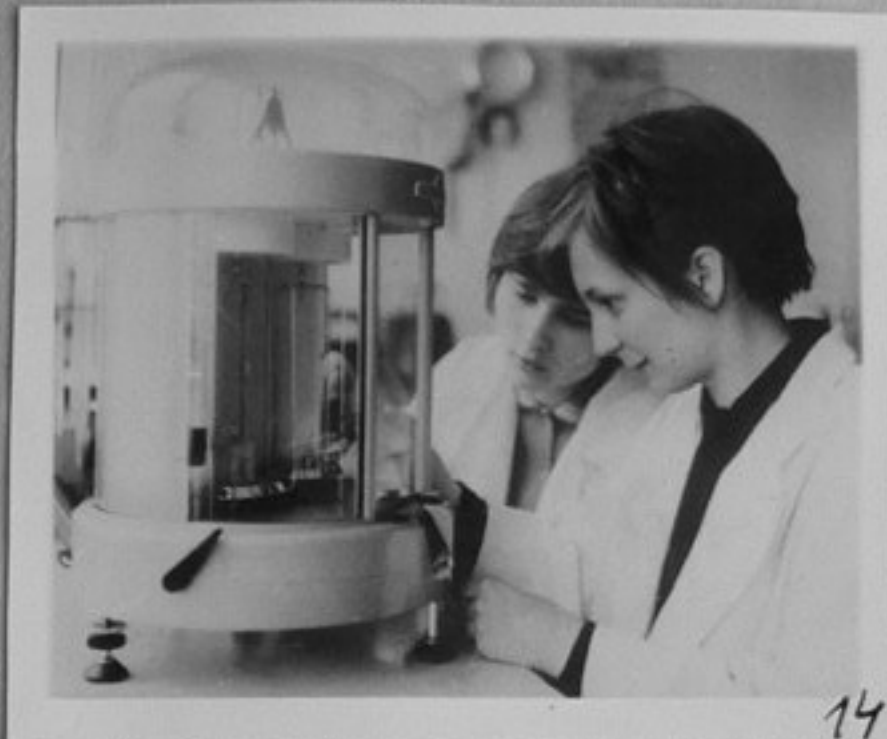
67-4023-14 - Ученички на практика в химическата лаборатория, разглеждат устройството на аналитичните везни. /ЕИ 24/36
