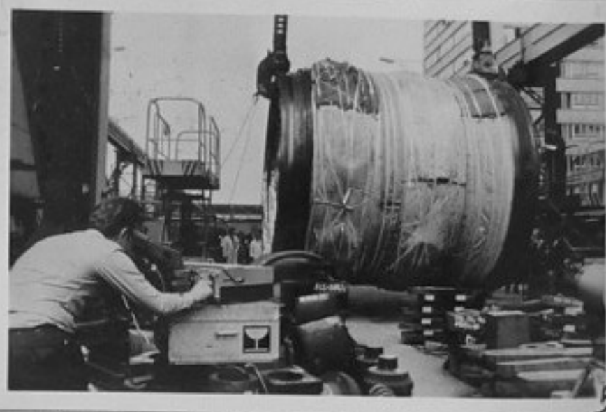
78-2495-5 Работниците от "Шкода" подготвят за каляване първата гигантска секция на парния котел "ВВЕР-440" на атомната електроцентрала – поставяне на секцията в пещта репр./МД
