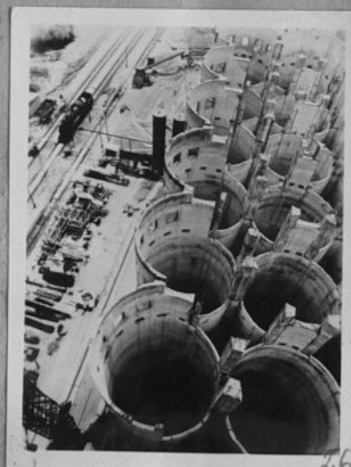
76-2794-26-Строеж на силоси с капацитет 38000 т край Мимон, Северна Бохемия, където израства промишлено-търговски комплекс за фуражни смеси. /репр./, ИБ
