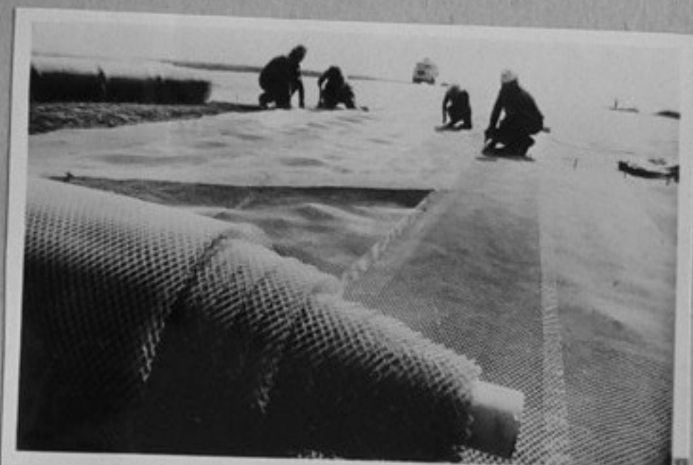
84-1092-17 Полагане на полимет- полиуретанови мрежи за заздравя- ване на пистата на Селскостоп. авиация в кооператива в Хусто- пече репр./МД
