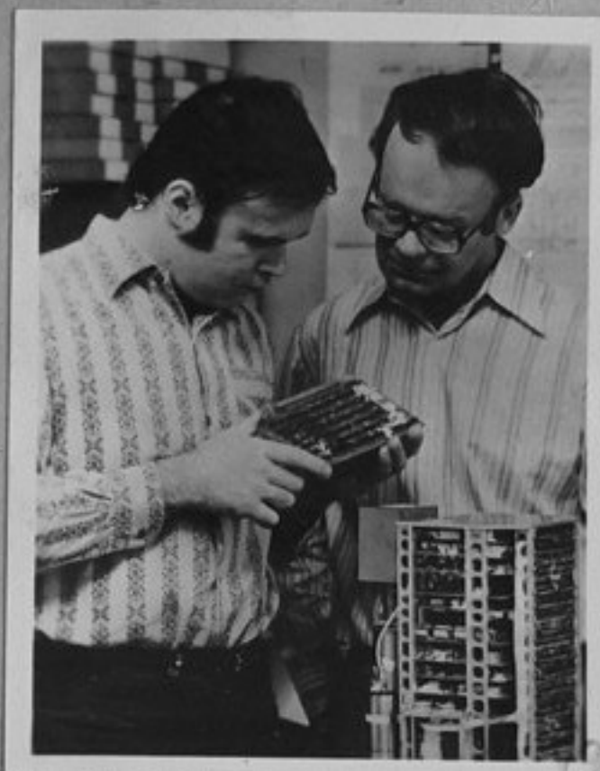
80-2158-19 Инж. Ян Шмилауер и Милослав Хонк от Геофизич. институт на Чехословашката академия на науките правят визуален контрол на паметта на спектрометър, посредством който се изучава динамиката на йоносферата репр./МД
