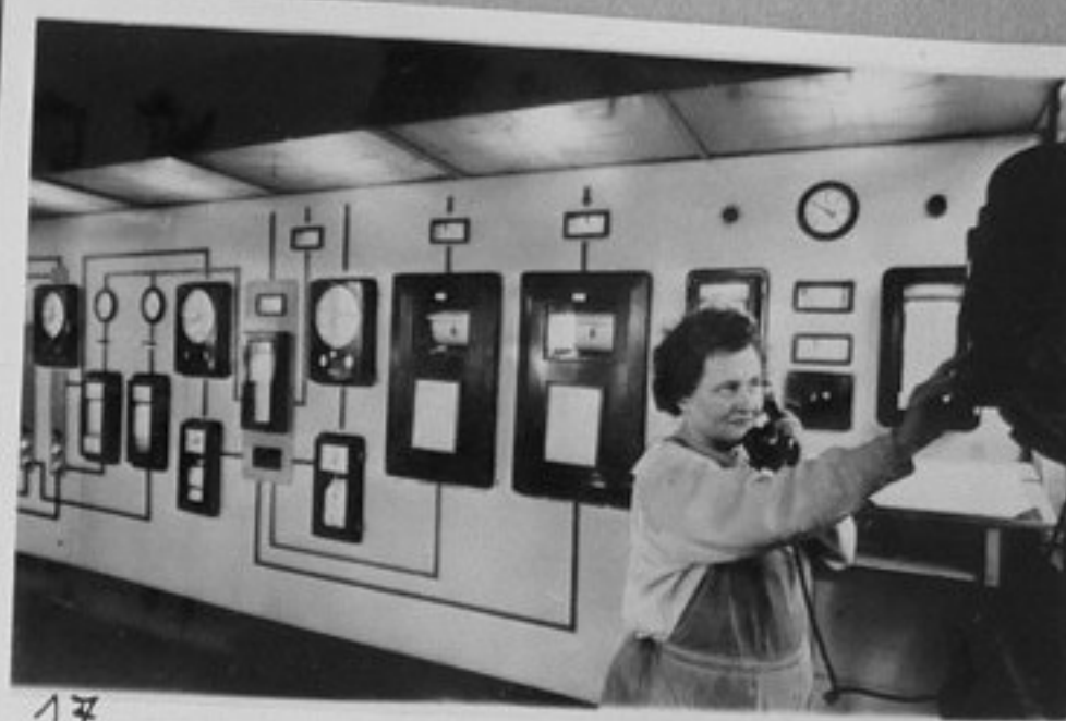
62/1094-17-Уреди за далечно командване на съоръженията за рафиниране на нафта, който се получава по петролопровода "Дружба" от Съветския съюз и чийто южен клон завърши в Заслужи край Мост./ММ/
