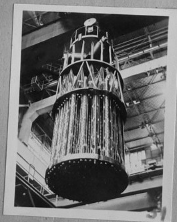
81-1033-31 Правят се завършителните работи на така наречените блокове от обезопасителни тръби - преместване от монтажната кула до хоризонталната фрез машина, където отделните части се поставят в системата на дъното репр./МД
