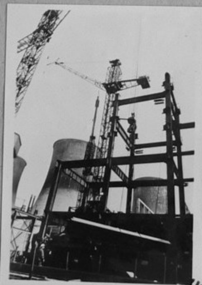
76-2794-24-Работници от Полша помагат при строителството на ТЕЦ "Почеради II". /репр./, ИБ
