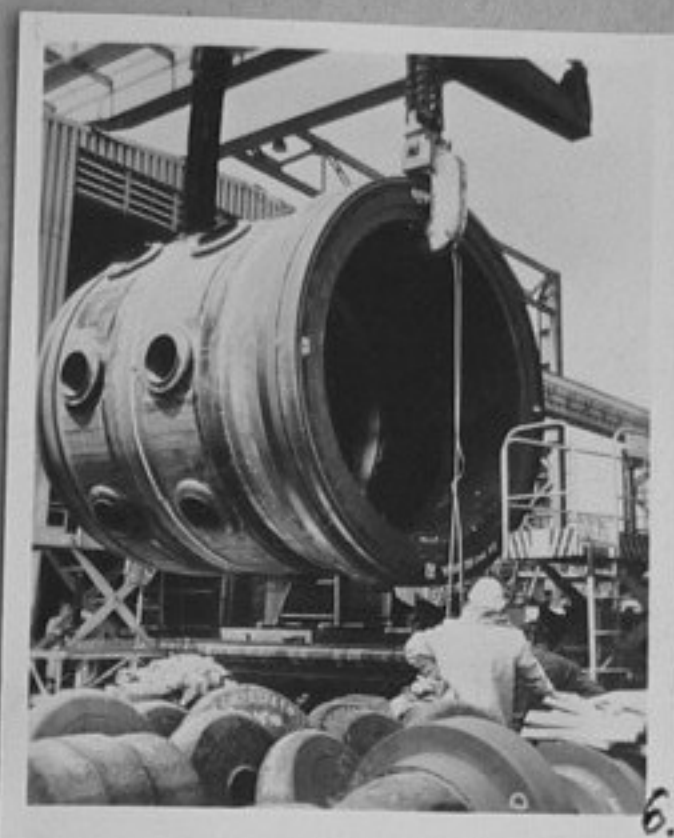
78-2495-5,6 Работниците от "Шкода" подготвят за каляване първата гигантска секция на парния котел "ВВЕР-440" на атомната електро-центра - поставяне на секцията в пещта репр./МД
