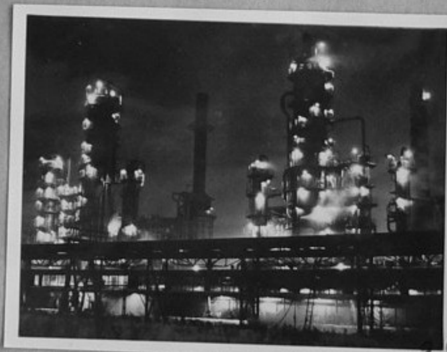
75-2651-25-Нощен изглед на част от нефтохимическите заводи Словонафт до Братислава. /репр./ТК
