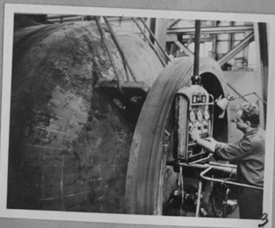
78-2495-3,4 В комбината "Шкода" в Пилзен се работи върху скъсен парен котел на атомния реактор, който ще бъде използван в реакторната зала за изпробване на капаци за парни котли "ВВЕР-440"
