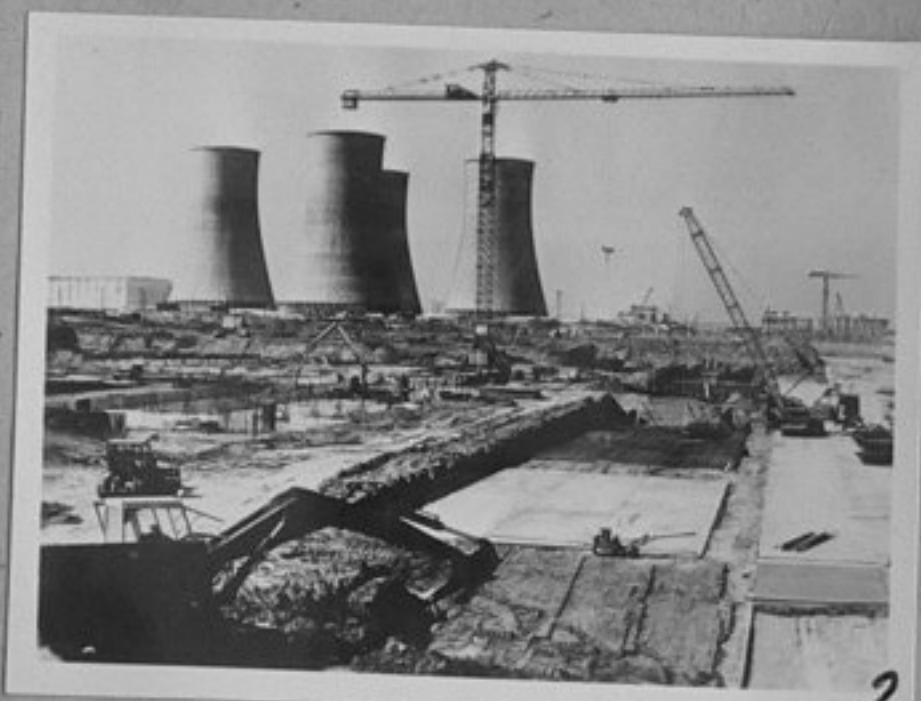
78-2495-2 Поставяне на стоманобетонните основи на бъдещата машинна зала на новата атомна електростанция, която се строи сега в ЧССР в близост до старата АЕЦ в Ясловске Бохунице, Западна Словакия репр./МД
