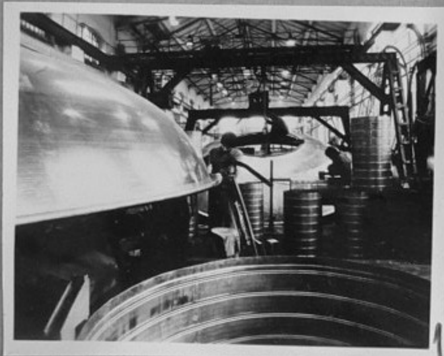
75-3051-1-Милан Микулец/вляво/ нивелира първаза на вътрешен меден казан на пивоварен ре- зервоар, произведен в заводи- те "Победният февруари" в Храдец Кралове. /сн.ЧТК/, репр., ИК
