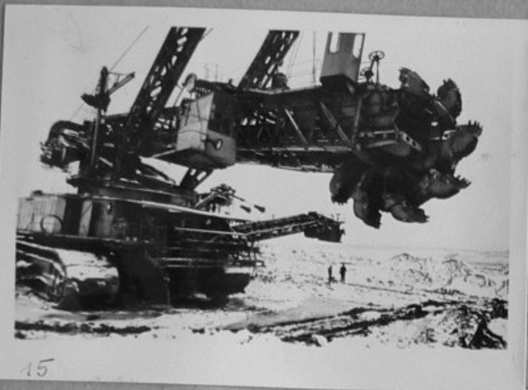
15,14 - Мощен роторен багер К-300, производство на машиностроенето в Чехословакия, на работа в каменовъглените рудници край Карлови Вари. Багерът има капацитет 720 куб.метра пръст и камъни на час.
