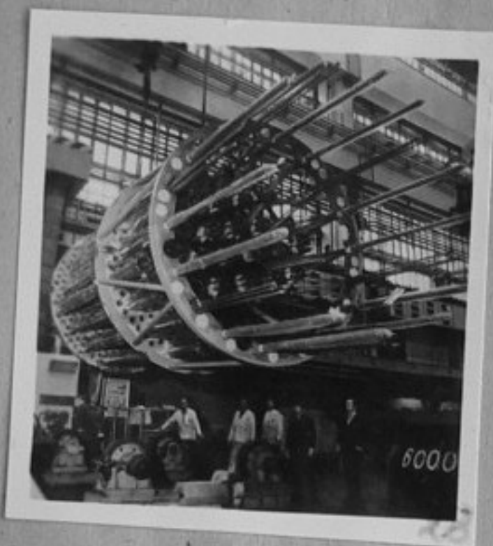
81-1033-28 В заводите "Шкода" в Пилзен се работи с пълни обороти над котлите за реакторите за лека вода VVER 440 и тяхните вътрешни части репр./МД
