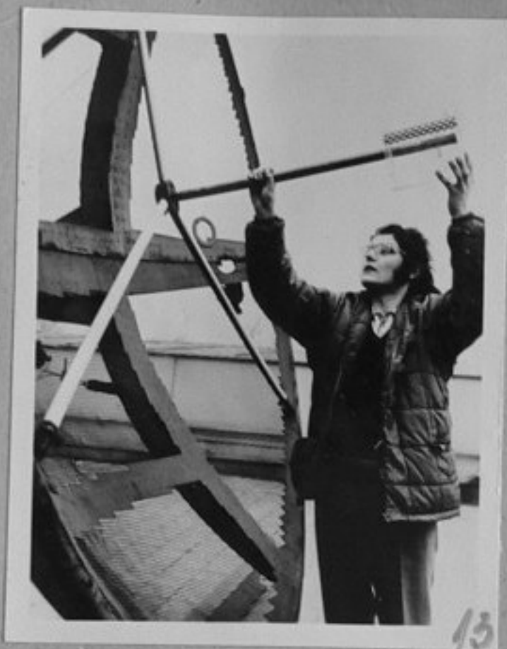
75-4488-13 Ярослав Медек монтира радиатор на телескоп за наблюдаване на протонни изригвания на Слънцето на дължина на вълната 22 см. репр./ЗЩ
