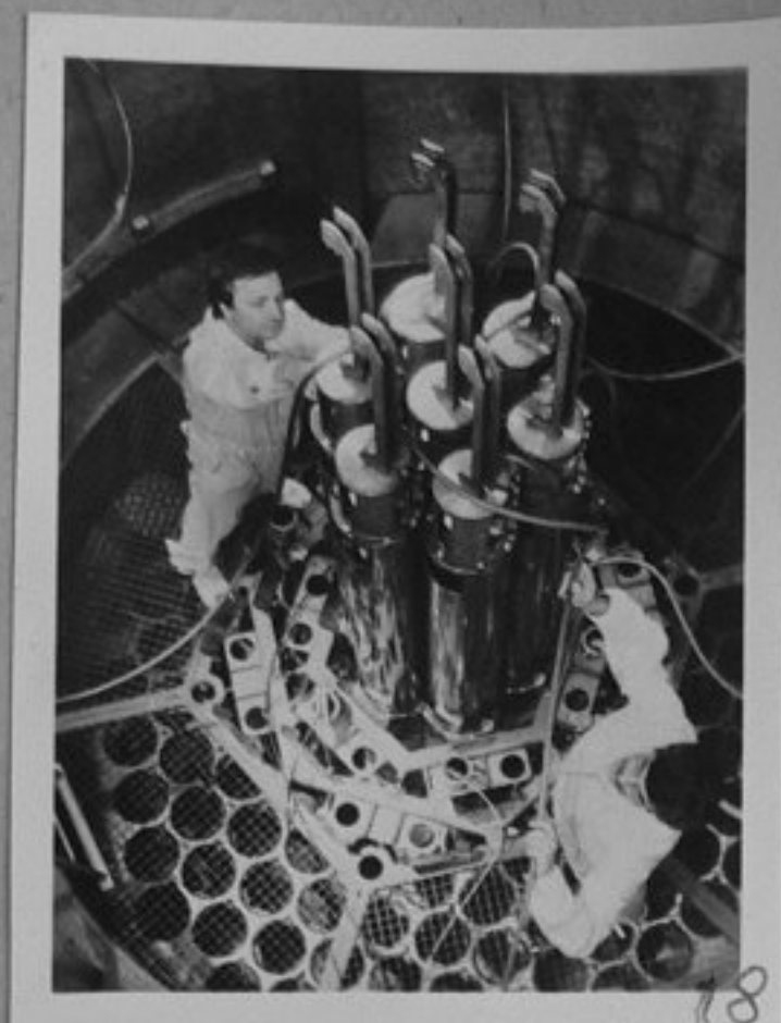
85-887-18-Проверка на регуляционни- те устройства. 9репр./ЛА
