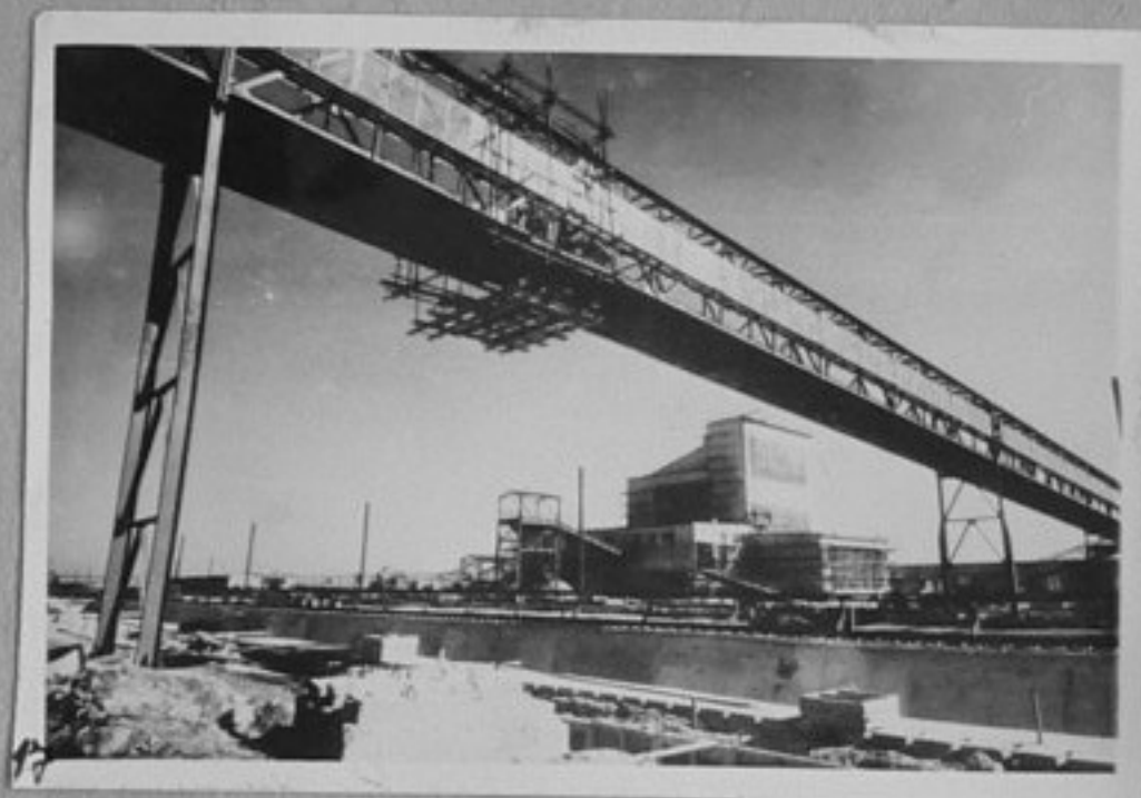
17-Монтаж на мост до Вржесова - Северо- чешка област /IV.65 г./
