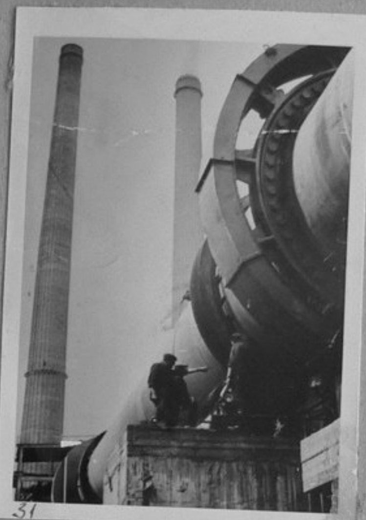
31- Монтаж на въртящата се преса в циментовия завод в Банска Бистрица. Производството на новия завод ще увеличи с 190.000 тона годишния добив на цимент в Чехословакия /2.VI.1961 г./
