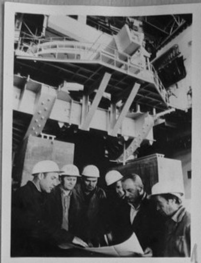
75-4488-1-Съветски и чехословашки специалисти на строителството на електростоманодобивния завод в Дрин до Кладно, Централна Бохемия. /Репр./, ЗЩ.
