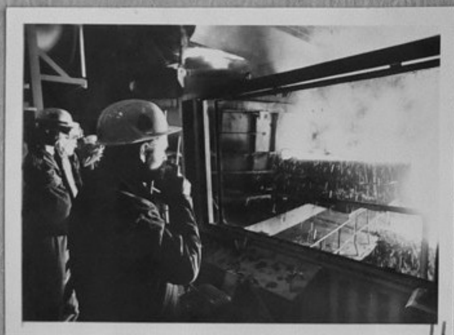
76-1349-11-В края на 1975г. влезе в пробна експлоатация ПОЛДИИ-заводи за електростомана в Дрин, близо до Кладно, Централна Бохемия. /сн:ЧТК,ЧССР/, /репр./, ЗЩ.
