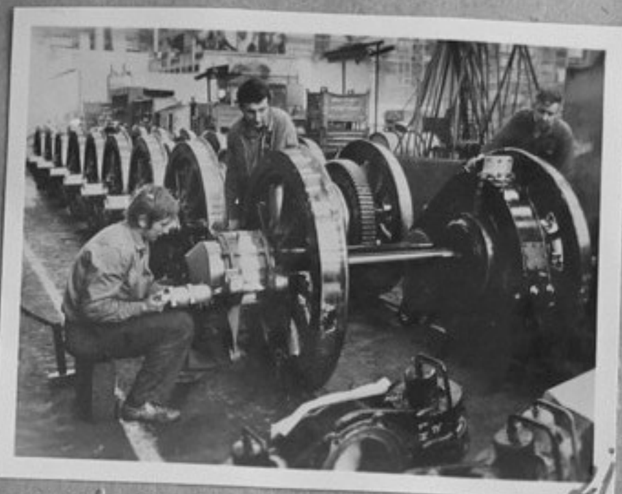
74-1323-21-В заводите за електрически локомотиви "Шкода" в Пилзен. Монтиране на лагери на двигателната ос на комплекта-колела за ел. локомотив "Е 62/". /Репр. П. Щерев/СС
