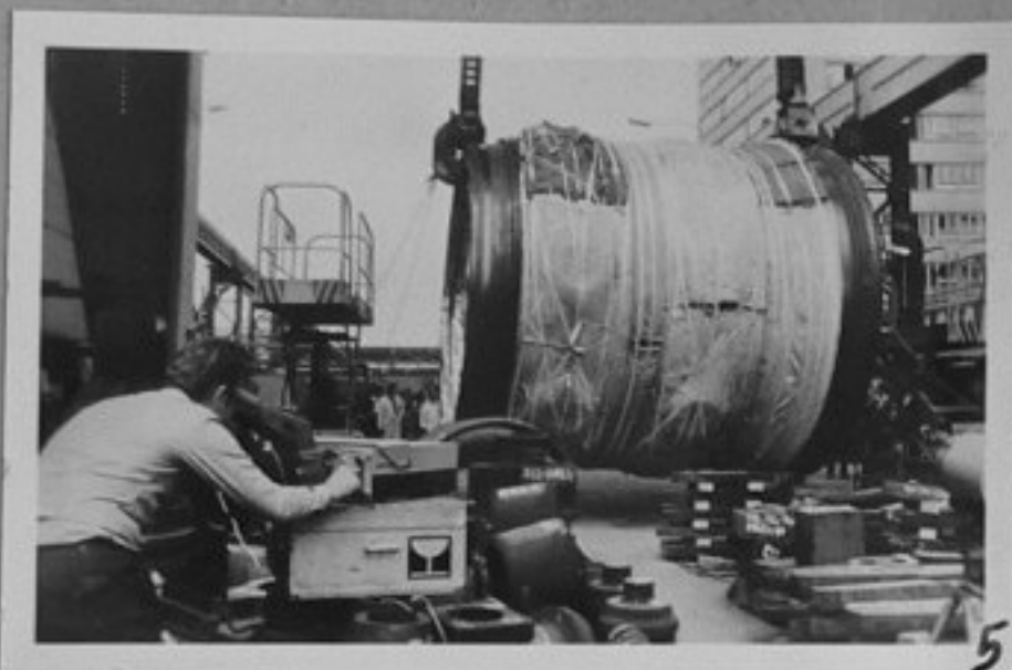
78-2495-5,6 Работниците от "Шкода" подготвят за каляване първата гигантска секция на парния котел "ВВЕР-440" на атомната електро-центра - поставяне на секцията в пещта репр./МД
