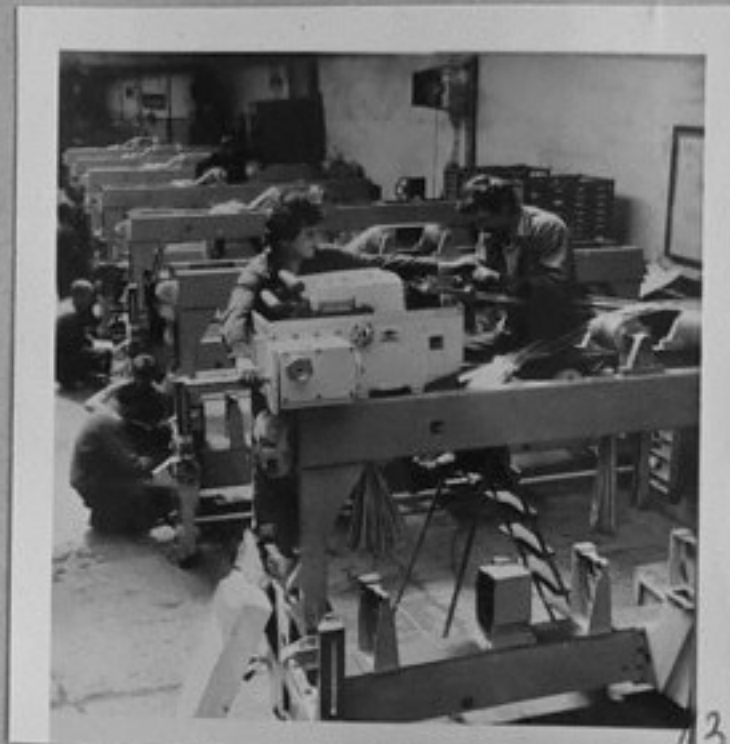
85-1042-12,13,14-В з-да в Храстава се работи върху нов модел тъкачен стан, с който ще се достигне скорост на тъкане 1 00 м в минута- /репр./ЛА
