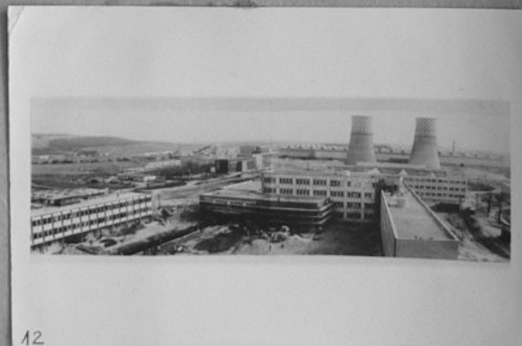
12-Изглед от металургическото училище към Източнословашкия металургичен завод при Кошице. /IV.65 г./
