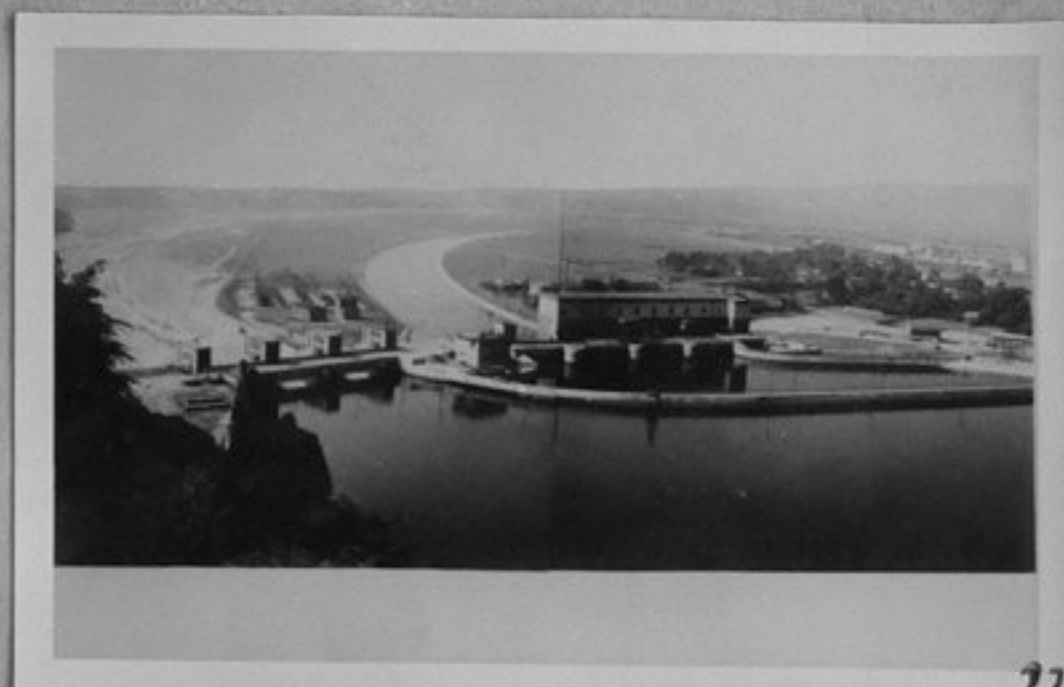
22 - Новата хидроелектрическа стан- ция в Крпелейни в Централна Словакия.
