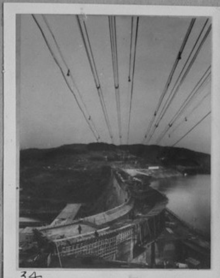
61/4142-34-Орлик на р. Влтава-строеж на язовирната стена.
