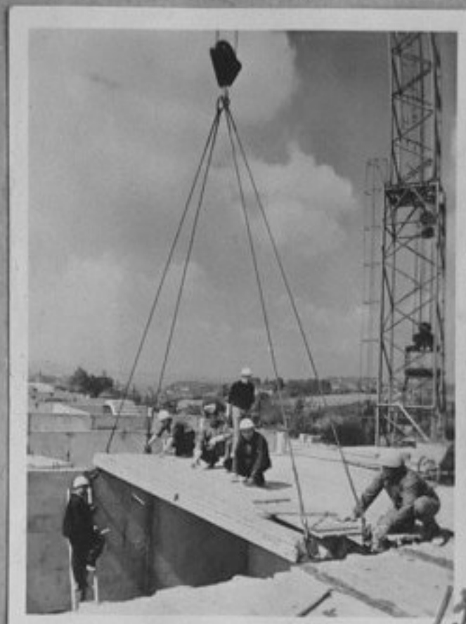
74-1323-13-Монтиране на етаж с готови панелни конструкции на новата жил. сграда в Прага-"Север- ният град".
