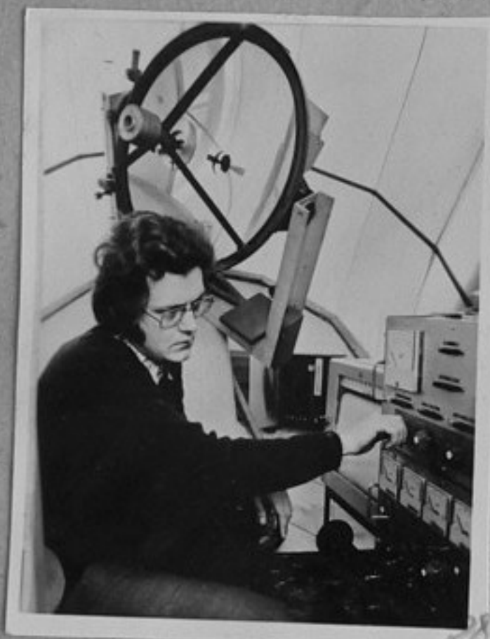
80-1494-28 Инж. Ярослав Медек от обсерваторията "Николай Коперник" в Бърно настройва електр. устройство на радиометъра, за да наблюдават слънчевата активност в 37 килохерц честота репр./МД
