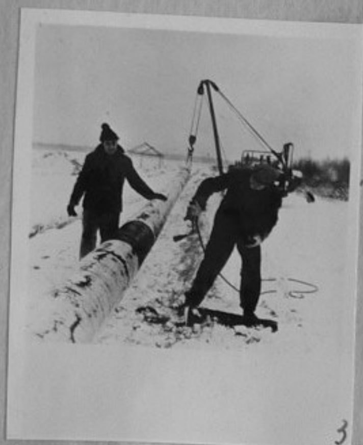
74-14-3,4-Първите метри от тръбопровода за транспорт на етилен от ГДР в Северна Бохемия. /репр.П.Щерев/СТК
