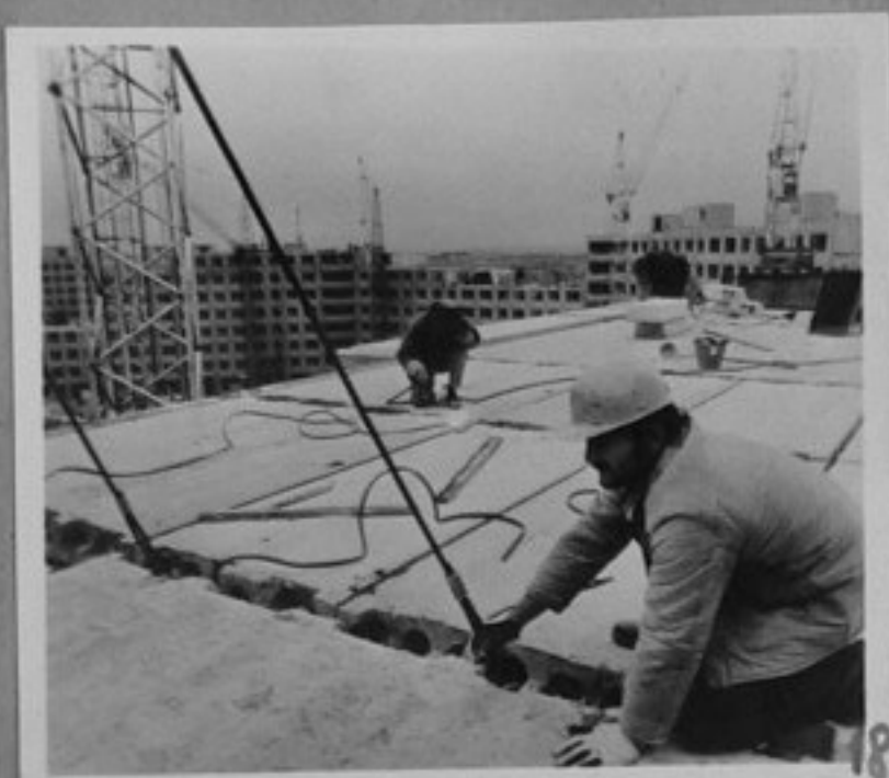
84-1092-18 Монтажната бригада на Ярослав Шулиц на строежа на нови блокове в Прага репр./МД
