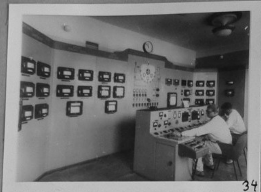
67-4023-34 - Изглед от кабината с контролните съоръжения и контролен пулт на чехословашкия атомен център. 24/36 ЕИ
