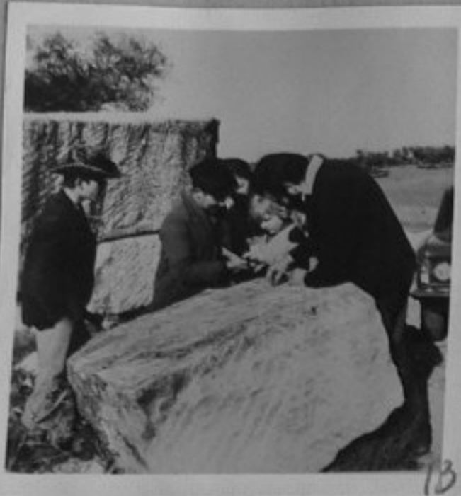
76-1164-13-На 30 км от град Евора в провинция Алантеко се намира кооперативно стопанство, основано след революцията, която сложи край на едрата собственост върху земята. На снимката: на строителната площадка
