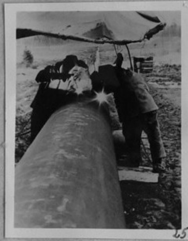
73-3863-25-Съветски и финландски специалисти монтират петролопроводни тръби за петролопровода СССР-Финландия. /репр. Б. Попов/ТК
