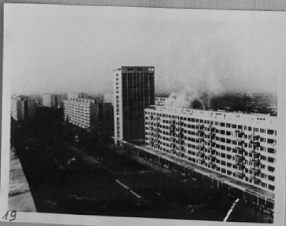
64/701-19-Строеж на нови жилищни сгради в Букурещ. /мм/
