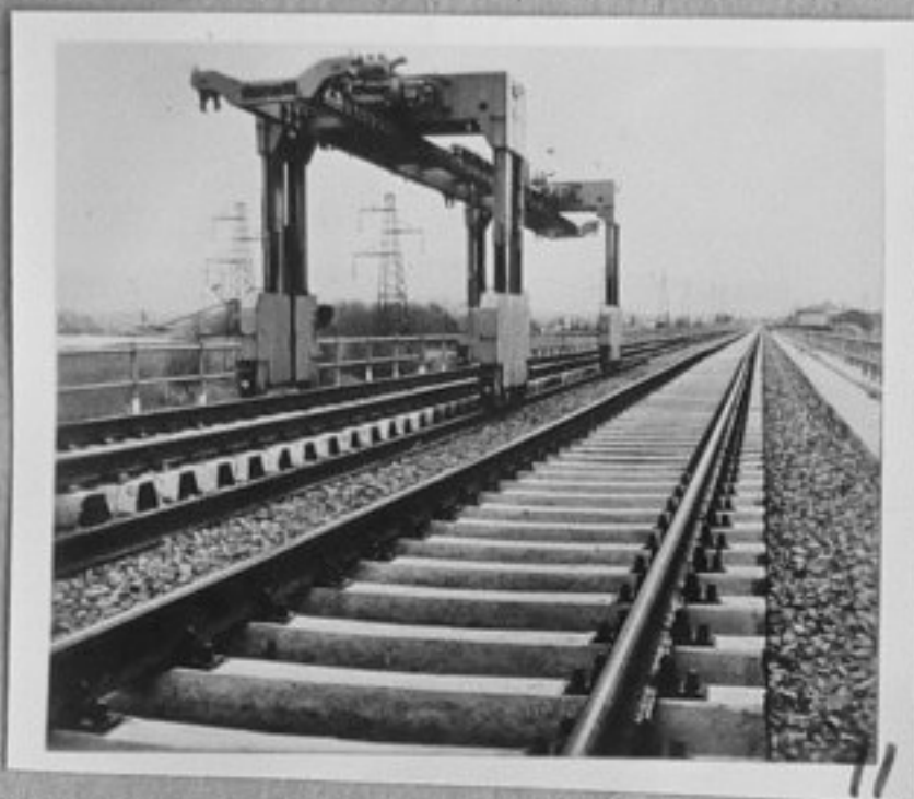
75-2585-11-Строителните работи на новата ж.п. линия Рим-Флоренция. /репр./ТК
