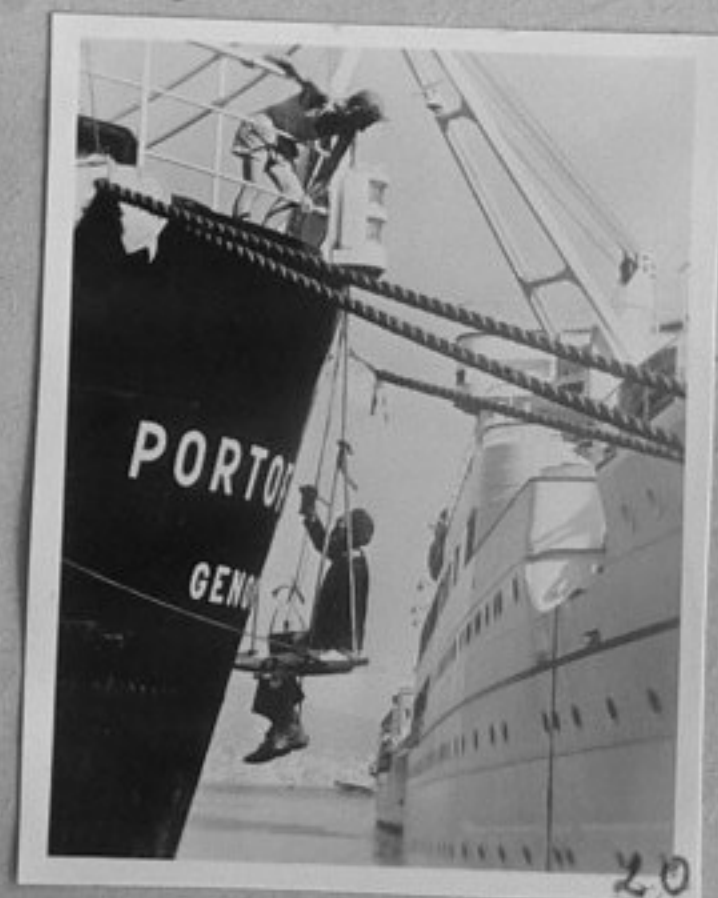
83-1798-20-Боядисване на трансатлантически кораб в пристанището на Неапол.
