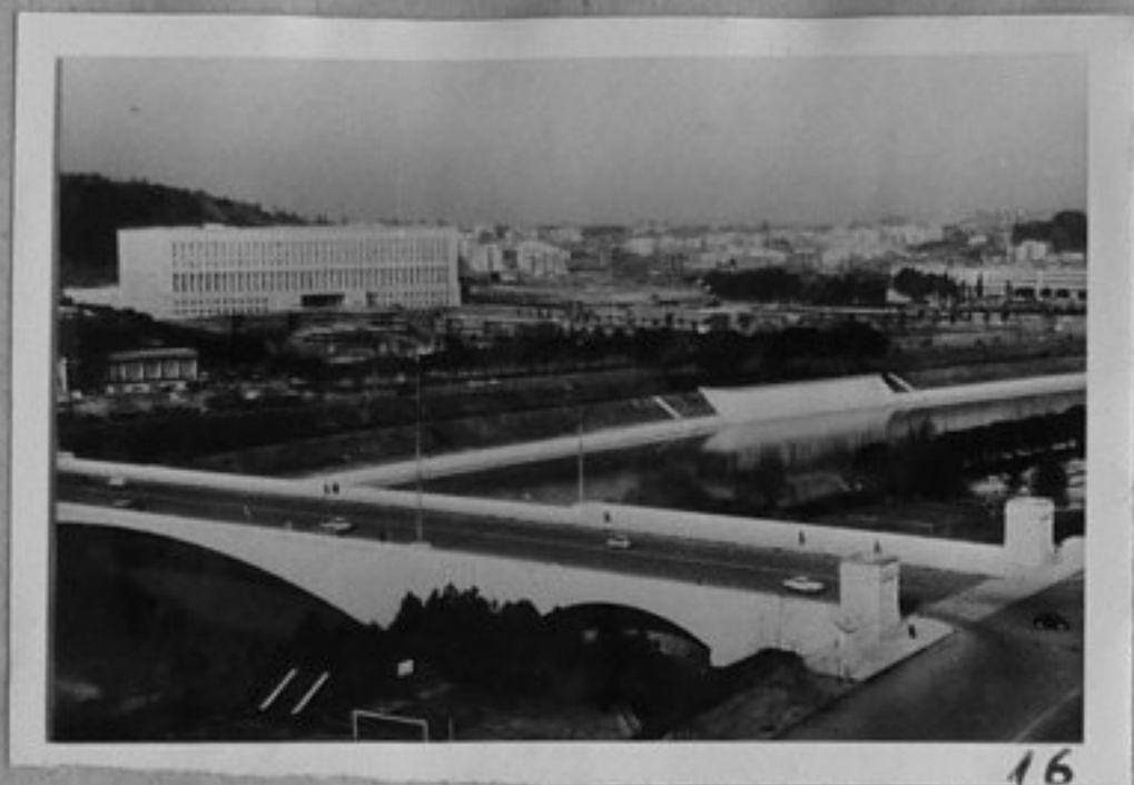
16-Общ изглед от стадиона "Италия". Вляво /бяла сграда/ министерството на външните работи.
