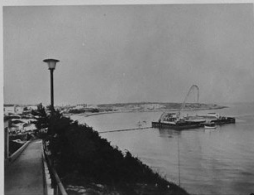
72-2-26-Момент от спускането на дъното на морето на тръбопровод, който ще доставя питейна вода на остров Сардиния от 5,300 м далечина от брега.
