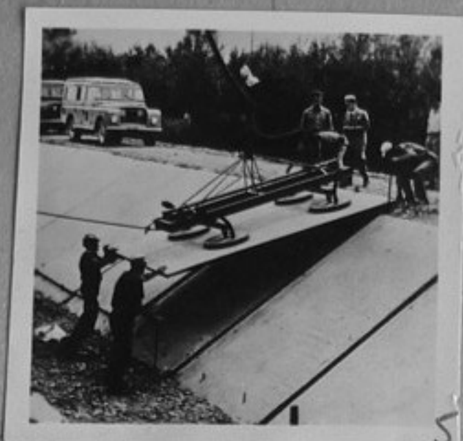
69-3308-5-Облицоване на напоителен канал в ломбардия със сглобени циментови плочи.
