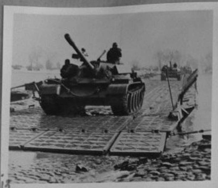
70-1758-13-Понтонен мост, построен от пионерните час- ти за осигуряване преминава- нето на танкови поделения. /репр.П.Щерев/ XII
