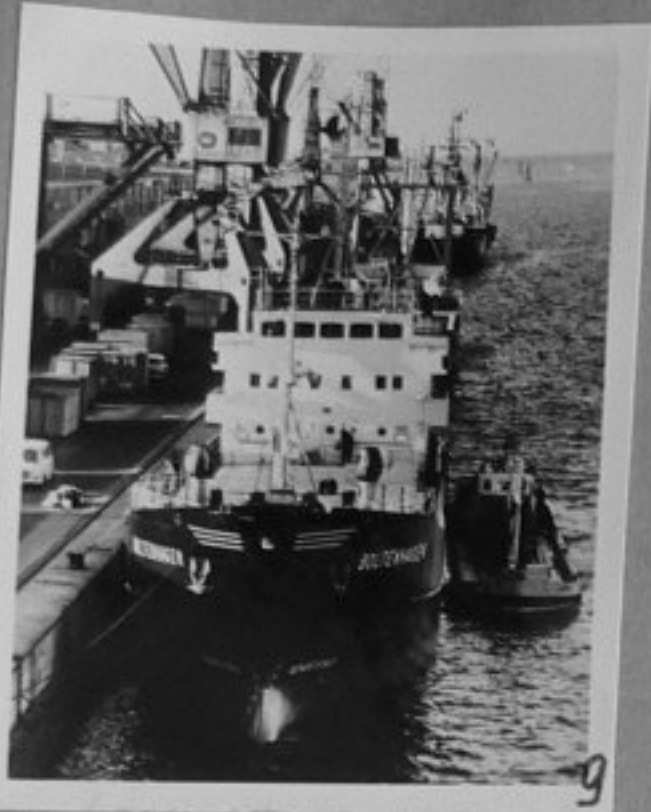
71-249-9-Новият товарен кораб "Болтенхаген" с то- вароподемност 780 тона, построен в корабостроител- ниците "Бойценбург". /репр.П.Щерев/ХП
