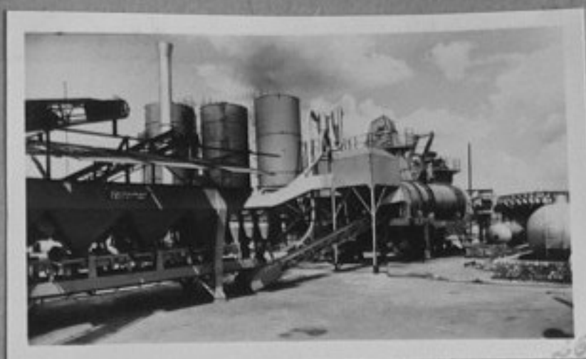
70-1806-25, 26-Автоматични съоръжения за пътно строителство "Телтомат-4". С помощта на тези машини е възможно бързото покриване на пътищата с асфалт. /репр.П.Щерев/ XII
