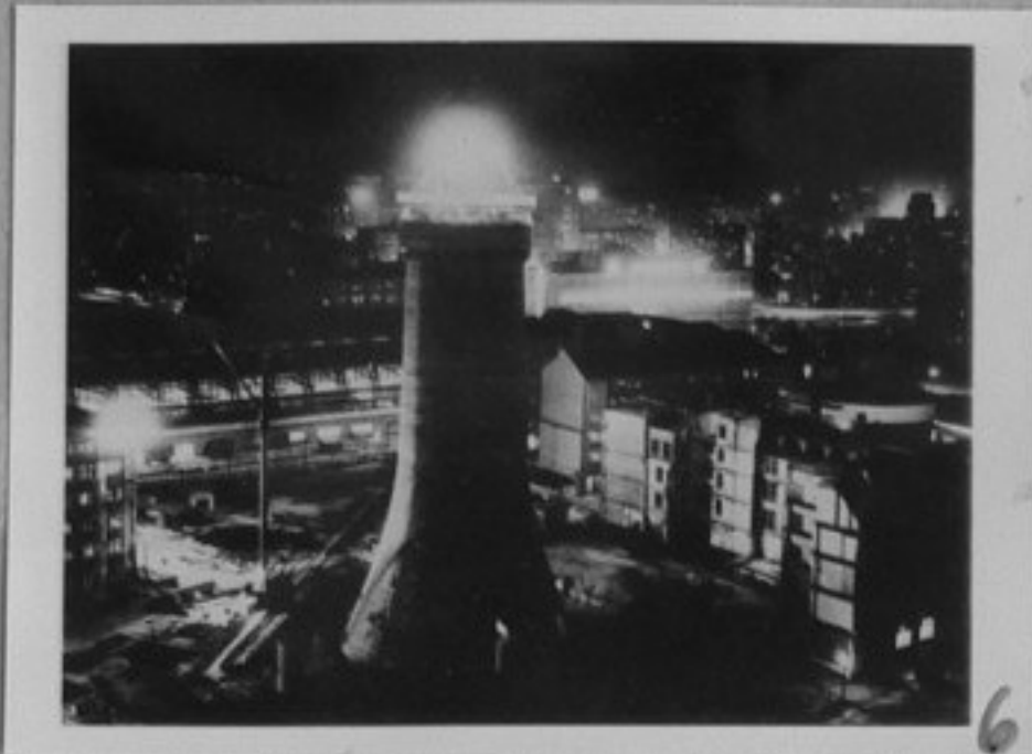
66/2929-6 - Нощна снимка на строежа на телевизионната и УНБ кула в Берлин. До края на годината ти ще достигне 150 м. височина. При окончателното си завършване ти ще е висока 361,60 м. /ЕИ 24/36
