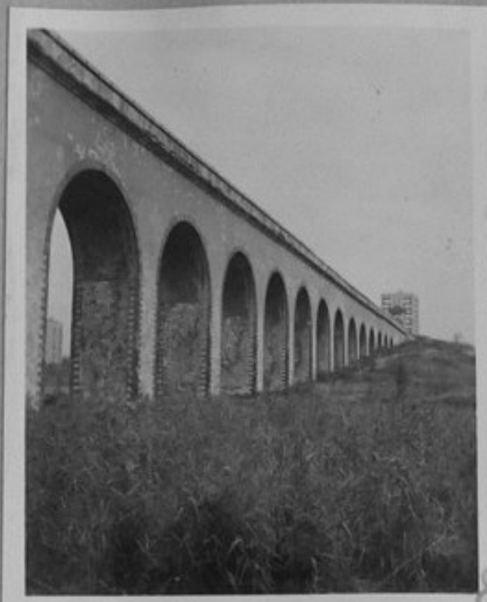
69-4122-8-Стар водопровод - Москва. /Б.Юскеселиев/ ИК
