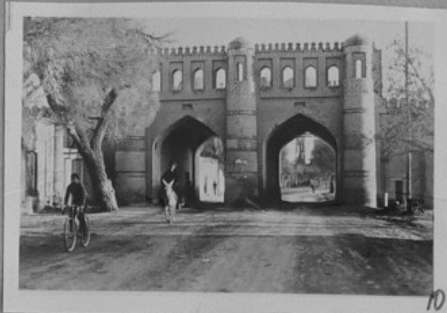
69-4112-10-Една от десетте градски врати на Хива на шесткилометровата стена, която някога е обкръжавала външния град Дишан Калу. /репр./ ХП
