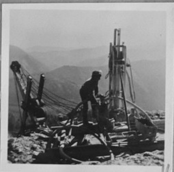
75-3570-11-Сондажни работи в карьерата до селището Означенное, Източен Сибир, където се намират големи залежи от мрамор. /репр./, ЗЩ.
