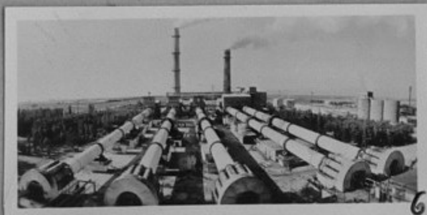
78-2945-6 КИРГИЗКА ССР. Въртеливи печи за изпичане на клинкери. Те се управляват от електронно-изчисли- телни машини.
