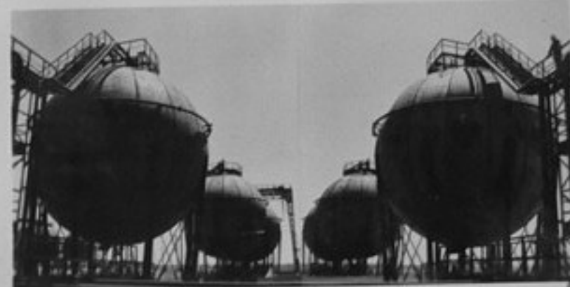
69-4173-18-На една от строителните площадки на Сумгайтския химически комбинат, Азербайджанска ССР. /репр./ XII
