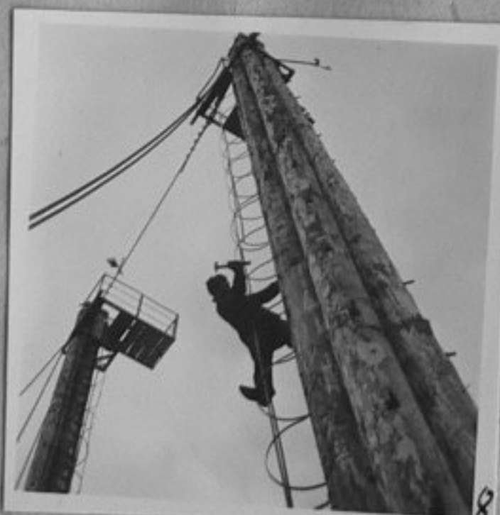
68-4483-5,8-10-Монтиране на мачти за кабел-крановете в долния склад. /Т.Хорисян/ ХП
