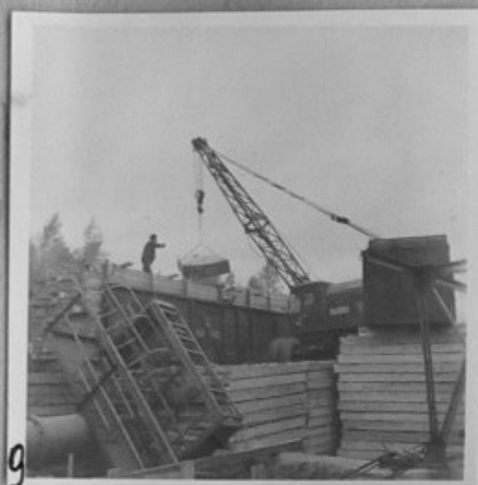
68-4481-9-Разтоварване на строителен материал. /Т.Хорисян/ ХП
