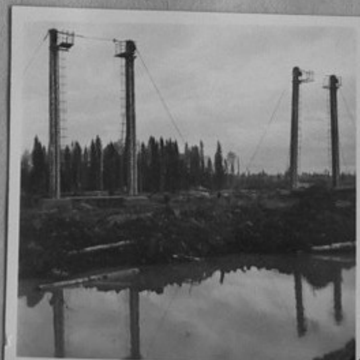
68-4483-5,8-10-Монтиране на мачти за кабел-крановете в долния склад. /Т.Хорисян/ ХП
