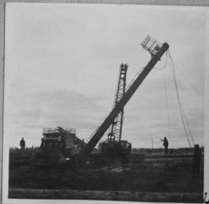
68-4487-4-Издигане на мачтите при строителството на долния склад. /Т.Хорисян/ XII
