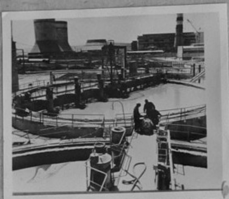
72-5232-6 - Обработка на цимент в хоризонтални басейни в Разданския химически комбинат. Комбинатът е още в строеж. Той ще има три крупни производства: глиноземно, циментено и химическо. /репр./ЕИ
