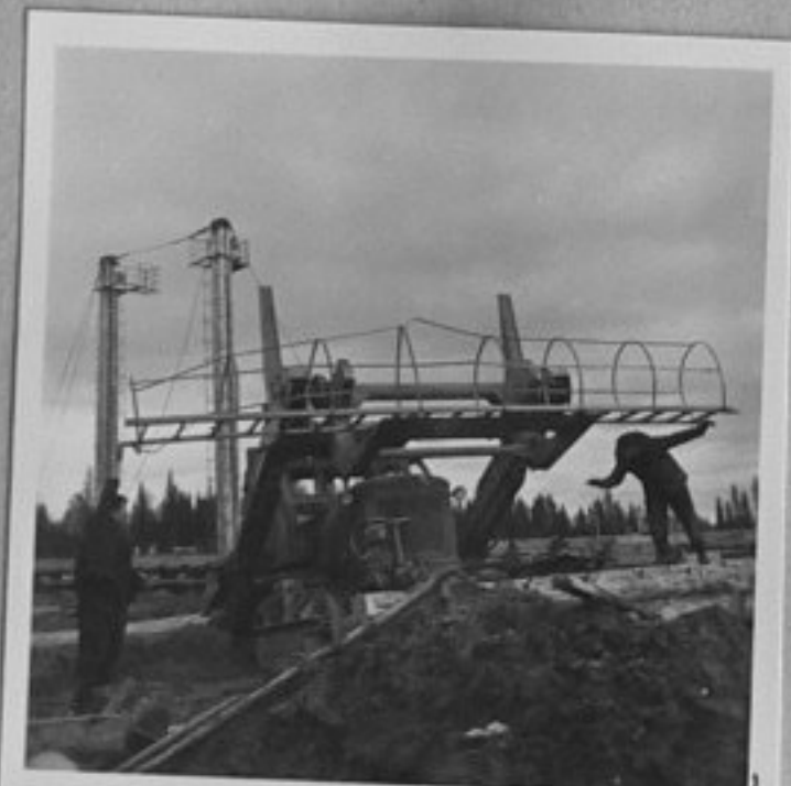
68-4480-4-Монтаж на вертикална стълба за кабел-кран. /Т.Хорисян/ ХП
