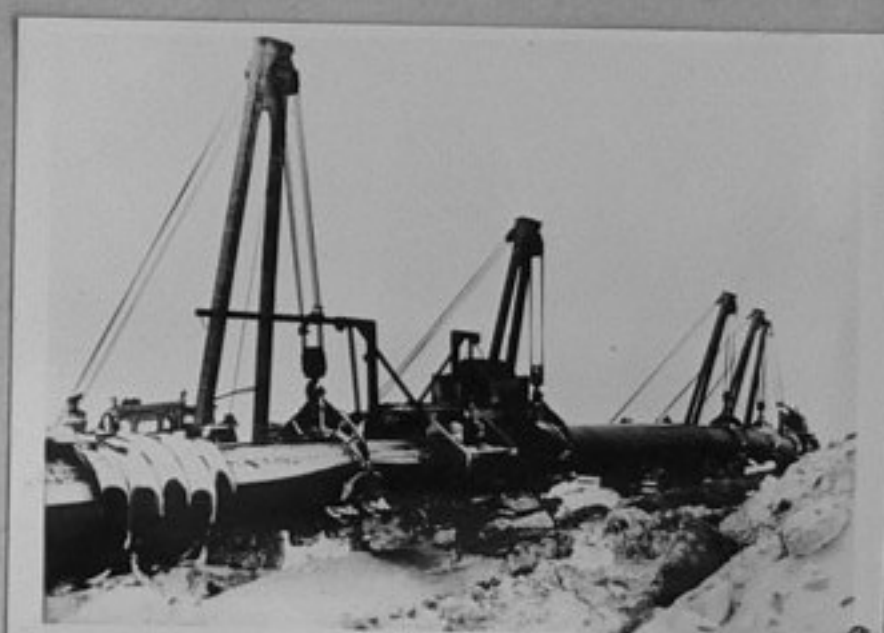
76-1497-9-Казахска ССР. На строежа на мощния международен газопровод Оренбург-западната граница на СССР. /сн:ТАСС/, /репр./, ЗЩ.
