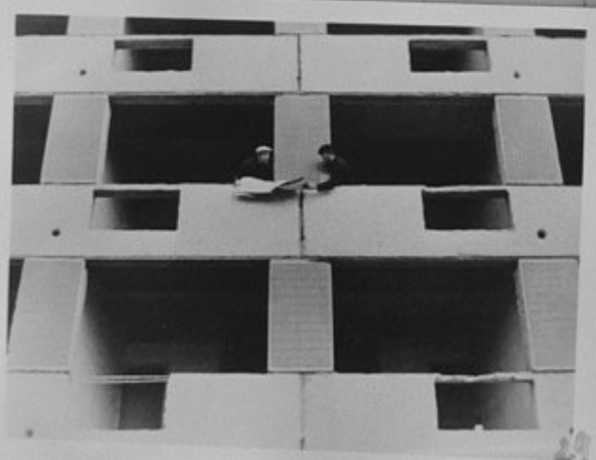
72-4250-29-Фрагмент от украсения с аглопоритосиликатни панели нов жилищен блок с използване на вертикални блокове цветни керамични плочки. /репр./ ИК
