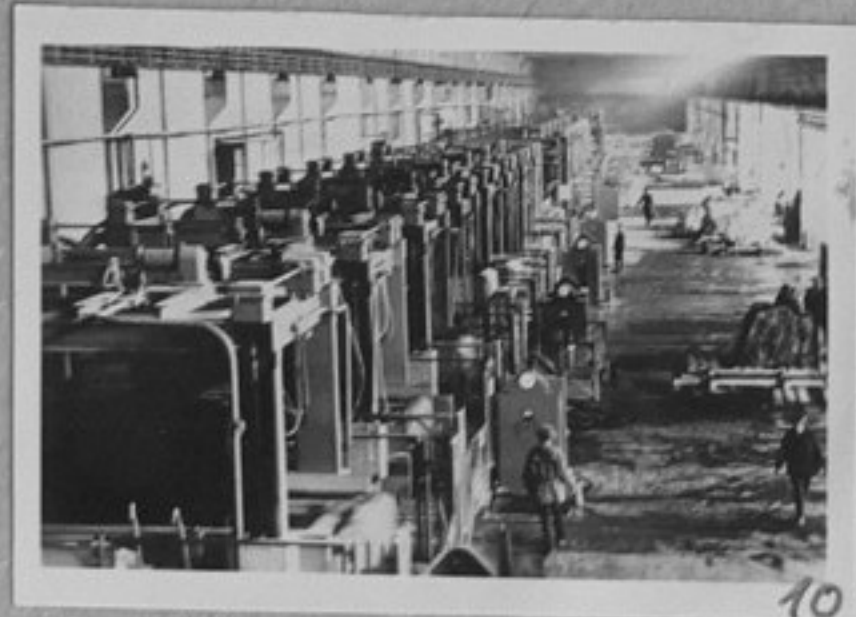
75-1474-10-В цеха за рязане на мрамор в новия каменнопеработващ завод в селището Означенное, Източен Сибир. /репр./, ИК
