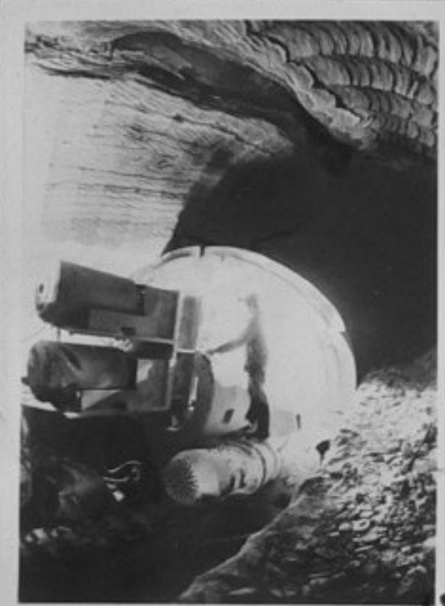
76-4057-18-В една от шахтите на Трети Березниковски калиев комбинат. Изкопаването на рудата става с високопроизводителния комбайн "Карганда".
