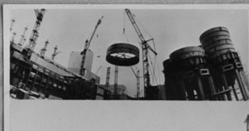
79-415-1-Монтаж на силосните кули, в които ще се натрупва изходния материал за производството на целулоза в Усть-Илимск-всесоюзен ударен обект.
