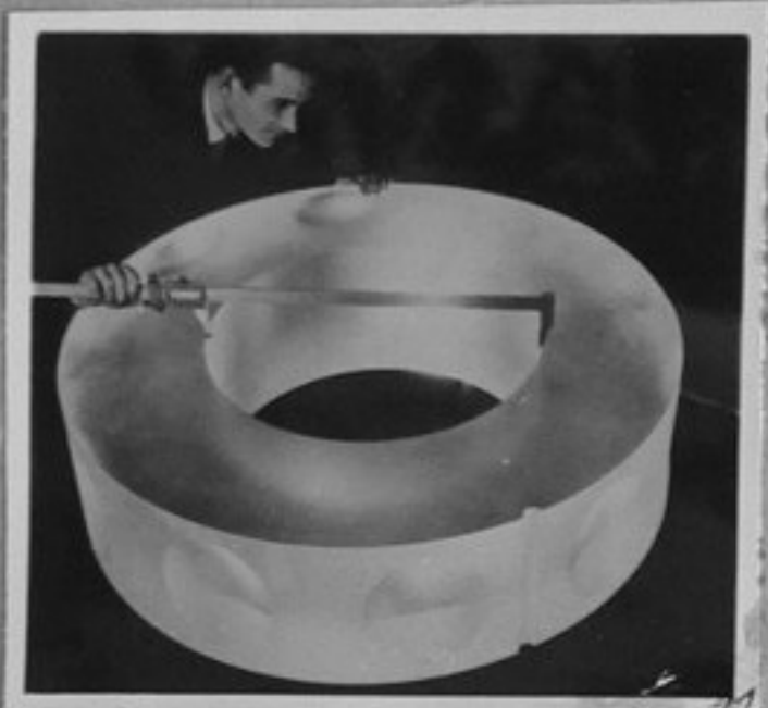
66/724-11-Измерване на вътрешния диаметър на голям пластмасов снатилятор от ст. инж.технолог В.Кизим. 24/36 /ММ
