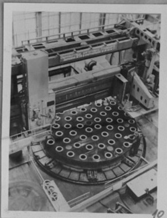
70-134-10 - Ленинградско оптико-механично обединение /ЛОМО/. Обработка на 6 метрово огледало на телескоп за зеленчуковата обсерватория. /репр./ /ИК/
