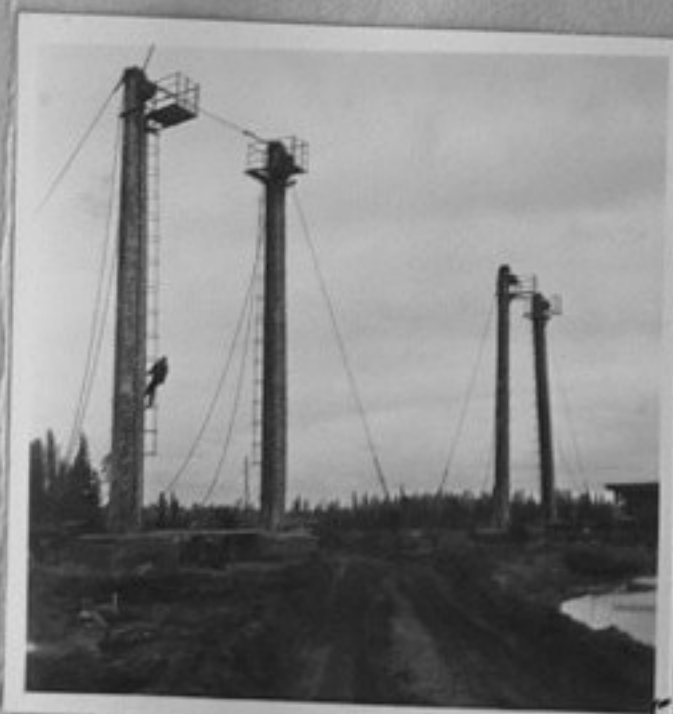
68-4483-5,8-10-Монтиране на мачти за кабел-крановете в долния склад. /Т.Хорисян/ ХП
