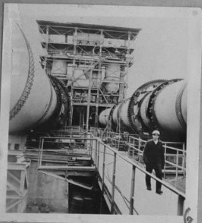
73-2981-6-Ротативни пещи за калциране на анхидридни пълнежи в хим.заводи "Вишов". /репр./ЛА
