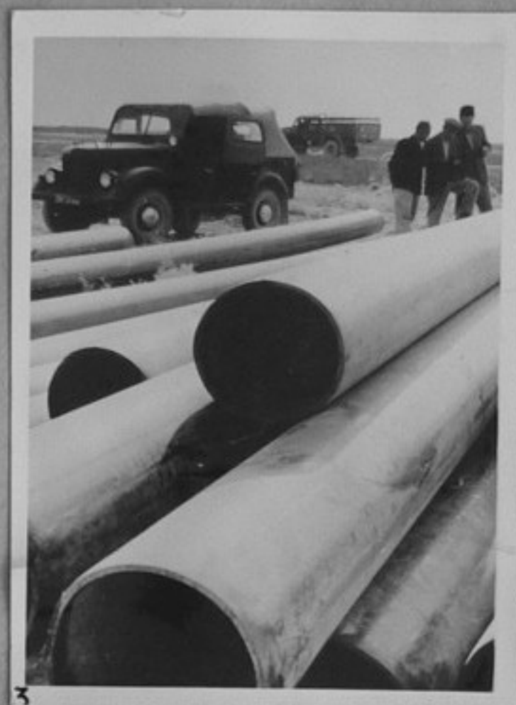
3 63/3546-3-Водопроводни тръби от полиетиленов материал, които се използват, поради издръжливостта им при налягането на почвените води. /ММ/
