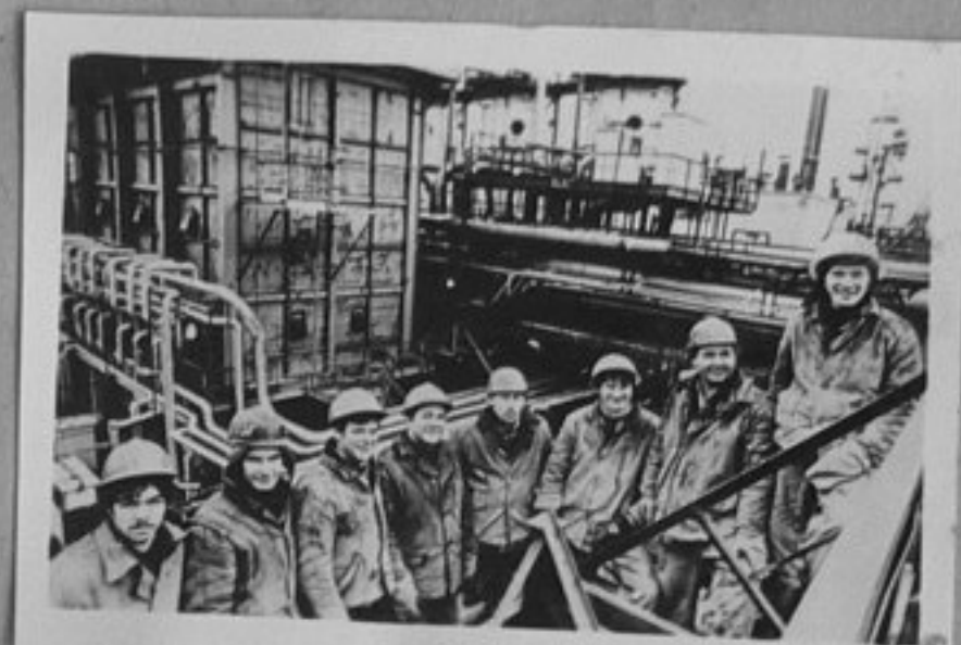
80-323-26 Бригадата на монтажни- ците от Киришския СМУ от тръста "Нефтезаводмонтаж", една от най- добрите бригади на строежа на "Парекс". Рък. на бригадата е вете- ранът на киришския строеж, носи- телят на ордена "Трудово червено знаме" Г. С. Василев/петият в ляво/ репр./МД
