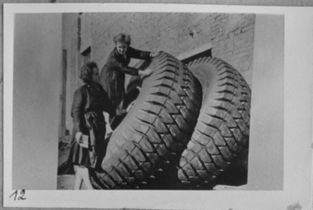
12 61/3770-12-Воронежският завод за автомобилни гуми е започнал производството на гуми за тежкотоварни камиони. Външният диаметър на гумите е 2.25м., ширина на профила 74 см и тежест-800кгр.
