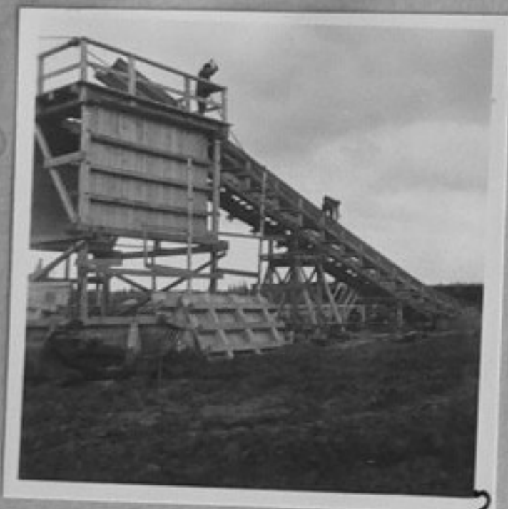
68-4480-2-Строителство на склад за битови нужди. /Т.Хорисян/ ХП
