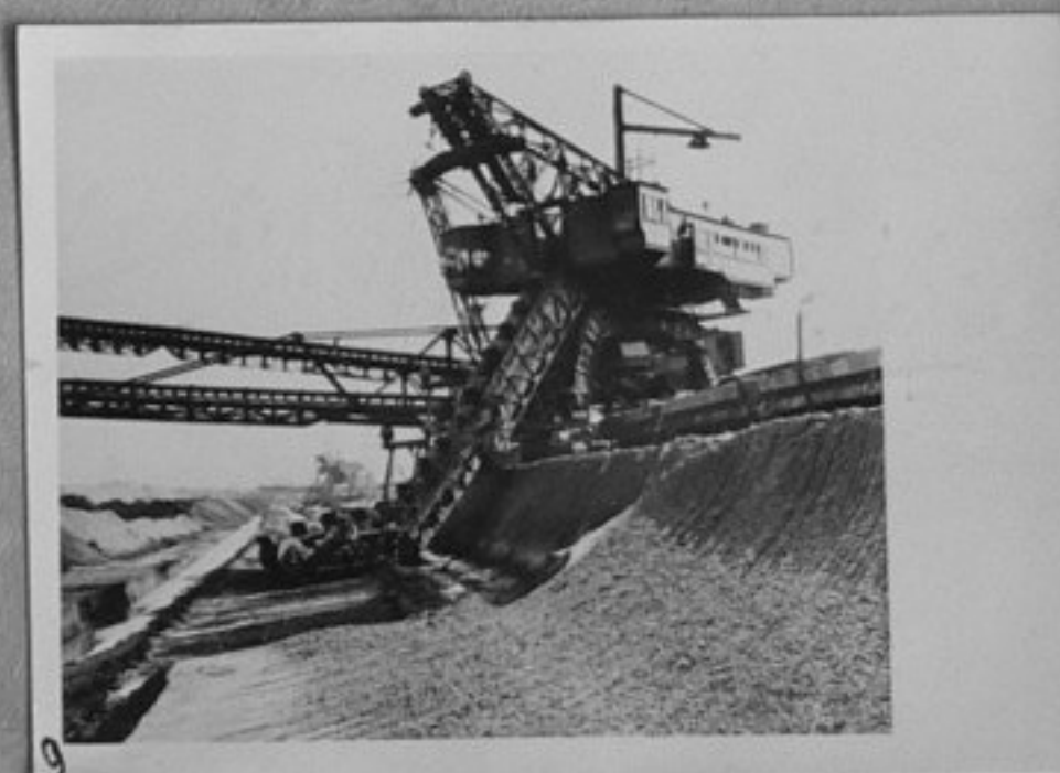
61/3513-9-Добиване на фосфоритна руда с помощта на екскаватори за фосфоритния завод в Брянск, където изработват за нуждите на селското стопанство с хиляди тона фосфоритно брашно.
