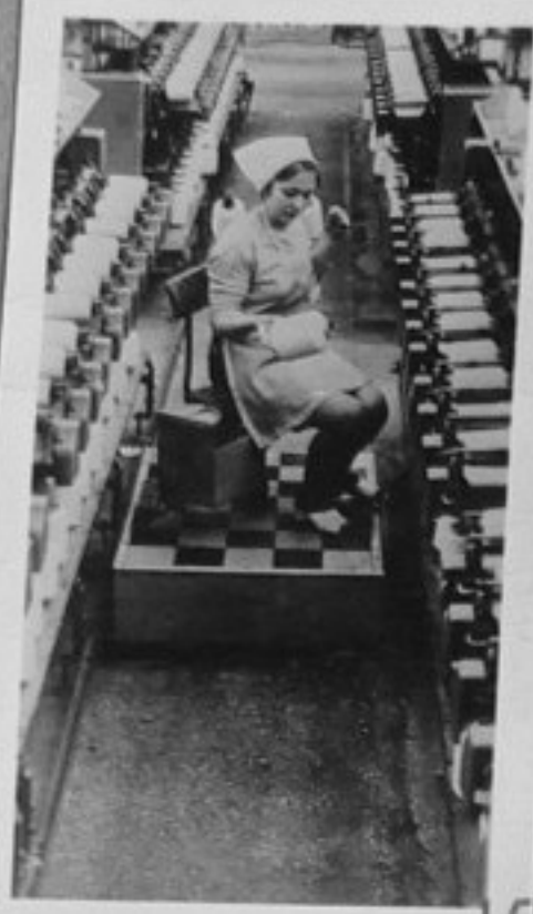
76-1626-16-Белоруска ССР. Подвижно кресло за работниците, обслужващи пренамотаващите машини в Могилевския комбинат за синтетични влакна "В.И. Ленин" от обединеното "Химволокно". Креслото е изготвено в предприятието. /сн:ТАСС/, /репр./, ЗЩ.
