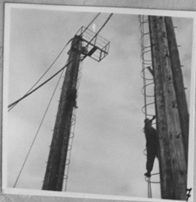
68-4480-7-Монтаж на мачтите за кабел-крановете. /Т.Хорисян/ ХП
