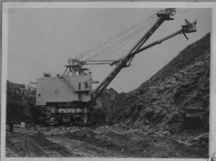
16-Ескаватор ЗВБ-6 на работа при разкриване на една кариера.
