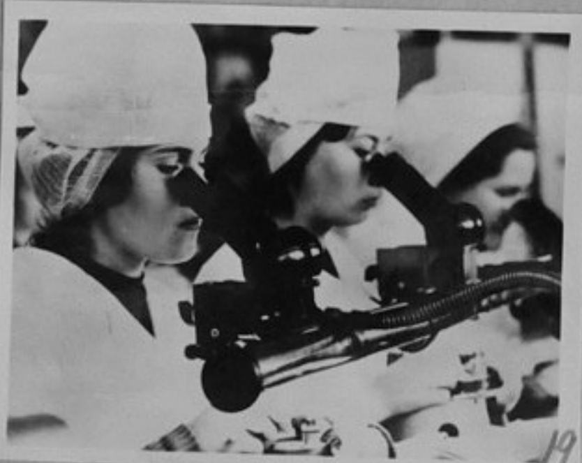
74-2179-13, 19-Контрол на радиалното и осево биене на часовниковите кола с помощта на микроскоп във Втори часовников завод. На преден план-контрольорът-Л. А. Полушкина. /Репр. П. Щерев/СС
