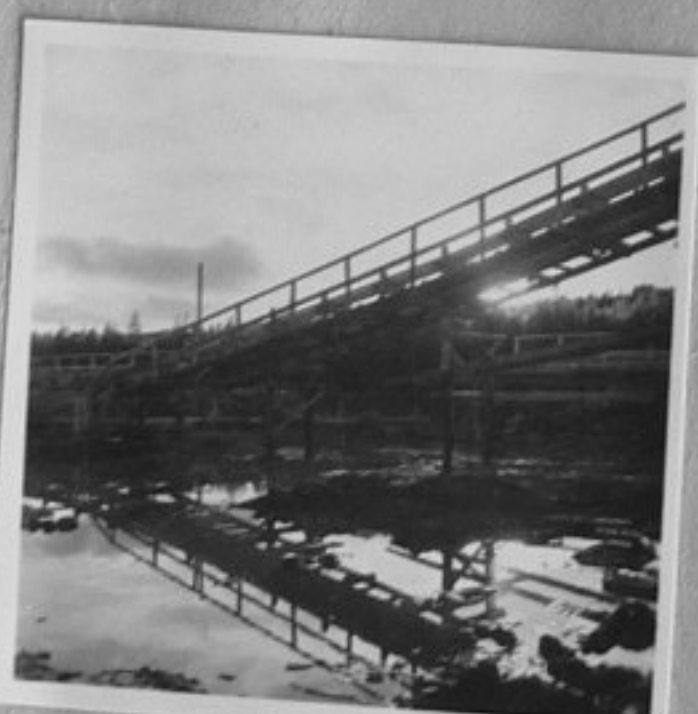
68-4477-10-Из строителство- то на долния склад. /Т.Хорисян/ ХП
