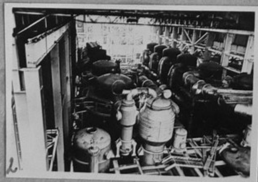
79-415-2-Монтаж на котли в един от цеховете на целулозния завод в Уст-Илимск. /репр./ЛА
