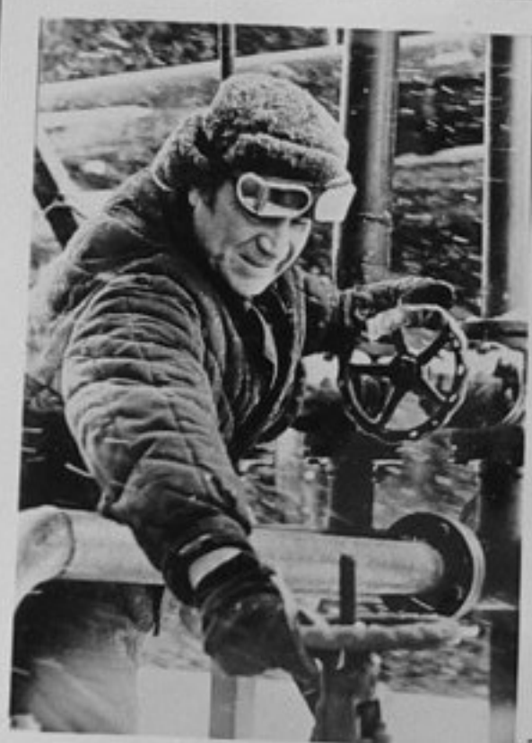
Естонска СССР. 72-4857-5 - Операторът Н.Котенко при съоръженията за дефеолация, която прочиства водите от шистов фенол. /репр./ЕИ
