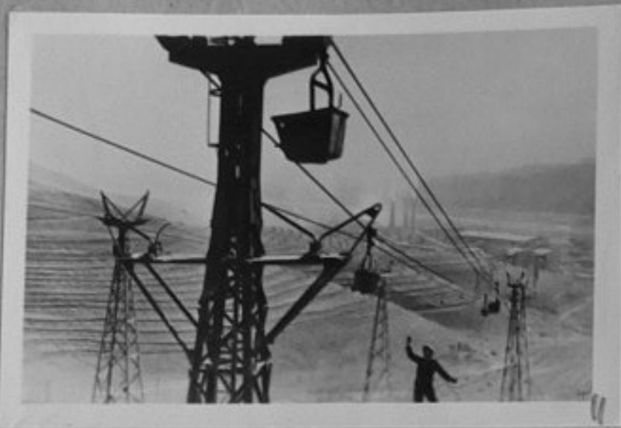
72-4497-11-Въжената линия на Душанбинския циментен завод дълга 7.5 км., по която се доставя циментна суровина от карьерата, Таджикска ССР./репр. Л.Кръстевич/ИК
