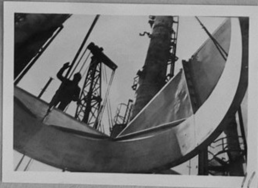
69-4173-11-Монтаж за въздушни хладилни инсталации в Новоуфимския нефтопреработвателен завод. /репр./ ХП
