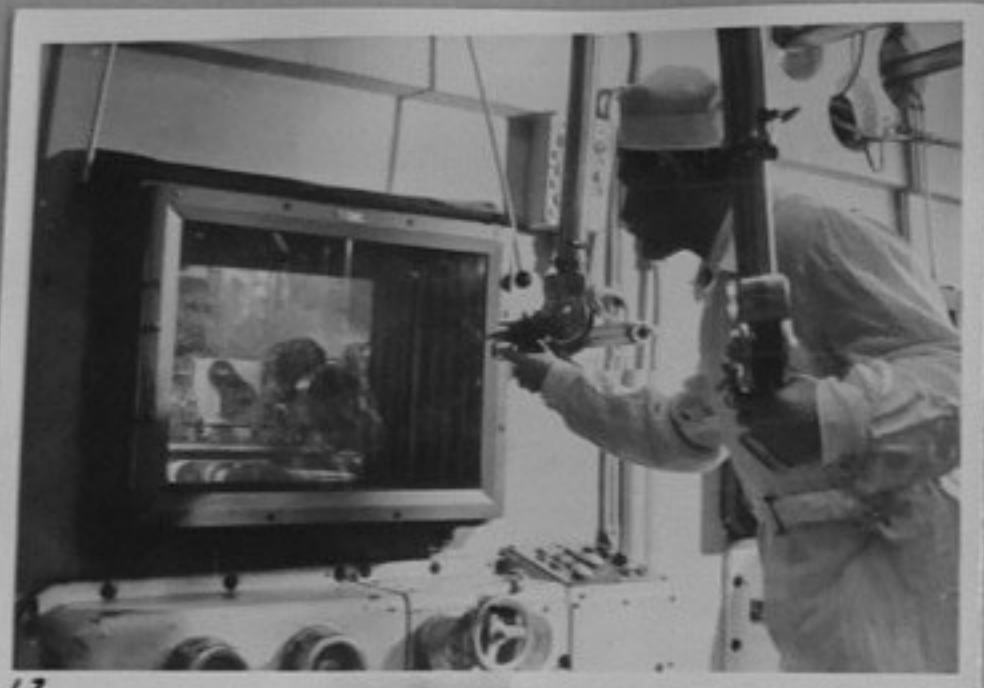
13-Съоръжения за управление от разстояние на уреда за рязане на радиоактивен метал в камерата с радиоактивни вещества.
