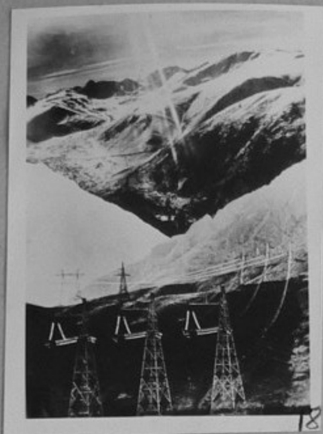
78-765-18-Един от участъците на строежа на ЛЭП-500. Пет километрово трасе е вече подготвено за предаване в експлоатация. /репр.ТАСС/МК
