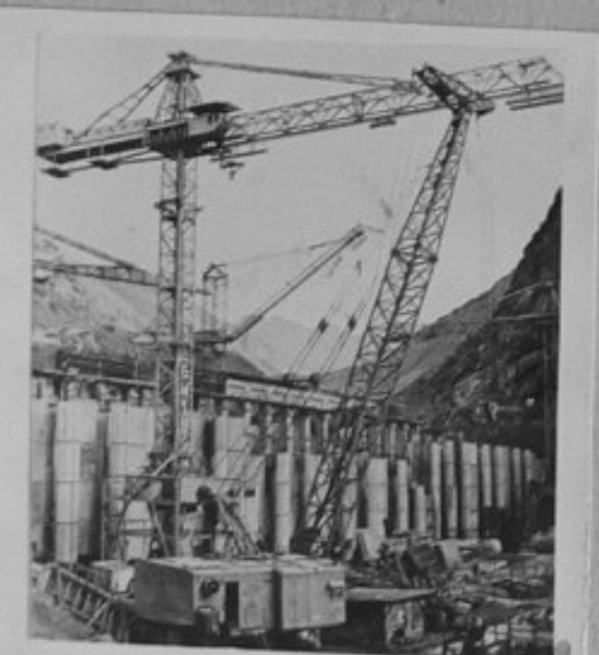
72-3358-2-Изглед от строителните работи на Нурекската ВЕЦ на р. Вахш, главен строеж в Таджикистан. ВЕЦ на р. Вахш ще има мощност 2.7 милиона киловата, ще произвежда около 12 милиарда квч електроенергия в година. /репр. П.Щерев/ИК
