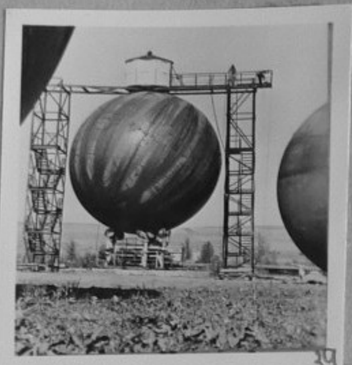
73-144-39-Чечено-Ингушка АССР. Монтаж на сферични резервоари на строежа на Газопереработвател- ния завод в Терския хребет, бли- зо до гр. Грозни. /Репр. П. Щерев/МК
