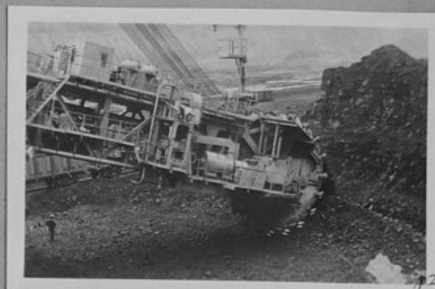
85-1362-13-Мощен роторен комплекс ръководи добива на въглища на Березовския въглищен разрез. /репр./ЛА
