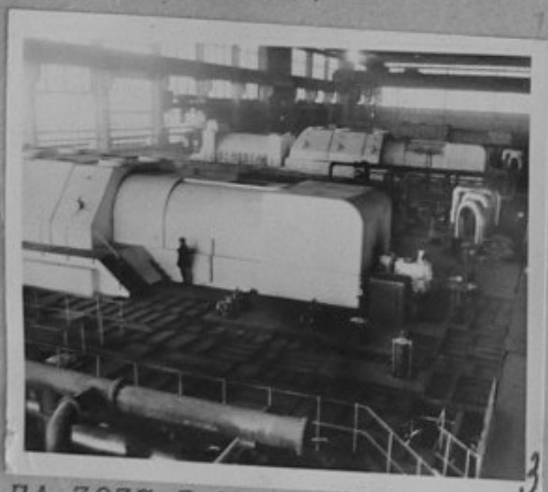
74-3037-3-Машинната зала на Рязанската ВЕЦ с три енергоблока, всеки с мощност 300 хил. киловата. /Репр. П. Щ./, СС
