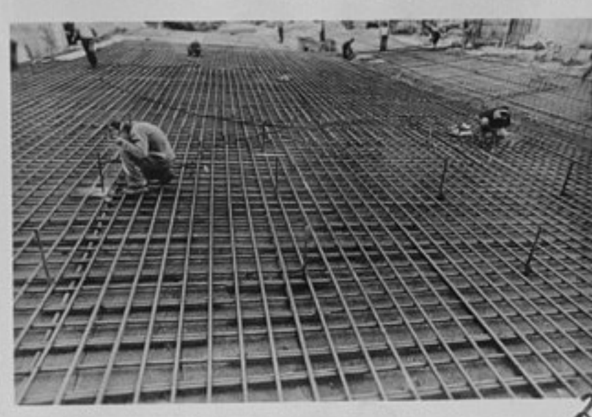
77-3189-25 Строители от тръста "Оскол-строй" съвместно с български строители поставят фундамента на корпуса на Стойленския миннообогатителен комбинат в Стари Оскол репр./МД
