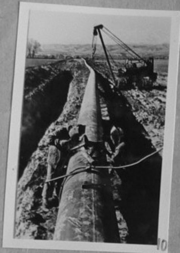
72-4497-10-Монтаж на газопровода Калиф-Душанбе. /репр./ИК /Таджикска ССР/
