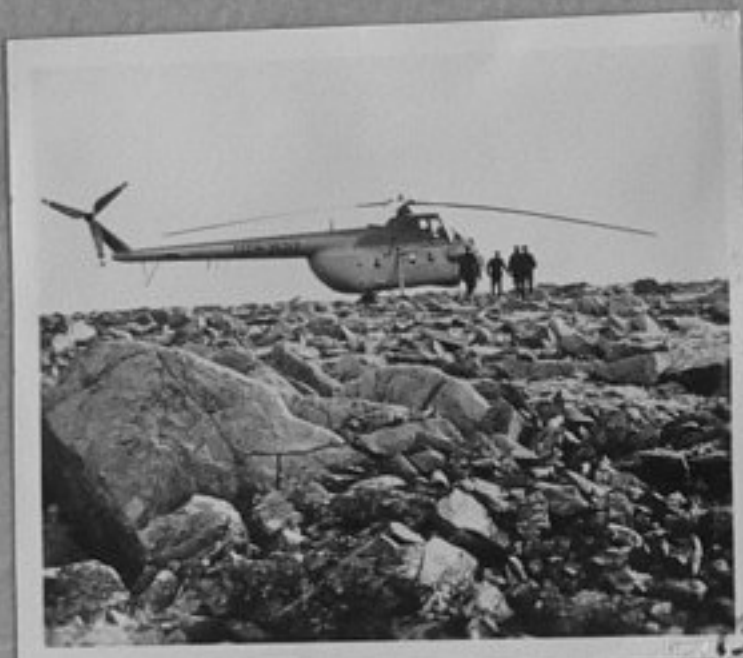
72-864-13-Изследвания на необитаеми труднодостъпни райони за прокарване на съоръженията за северния газопровод Надим-Ухта в Полярен Урал. /репр./ИК
