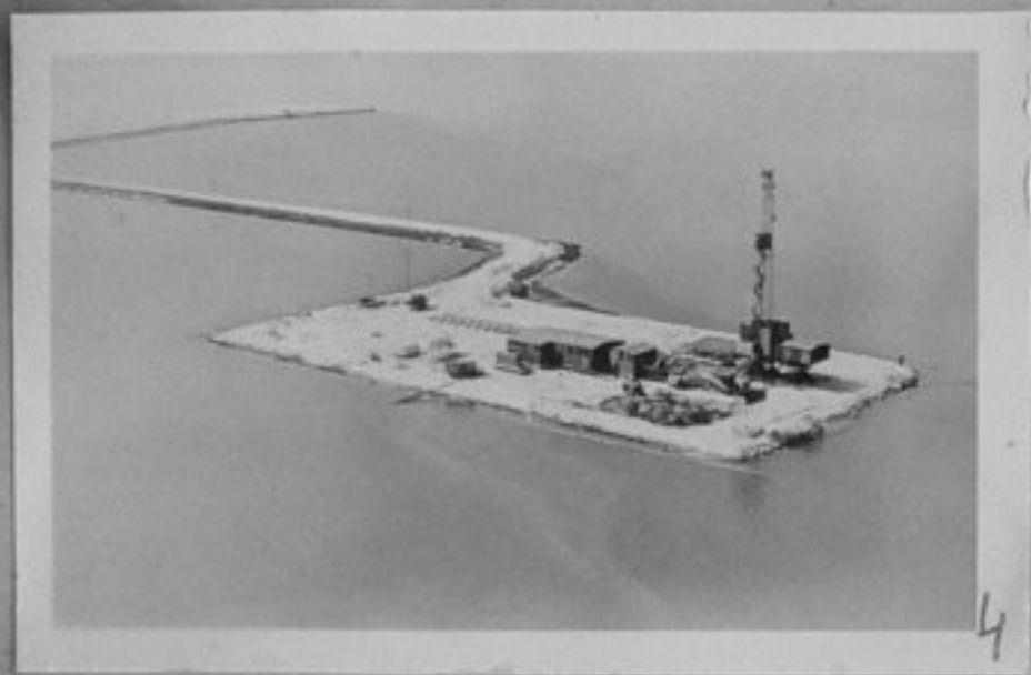
86-1051-4-Езерото Самотлор е в центъра на нефтонаходището на Тюмен. Кулата за строителството на няколко експлоатационни сонди. /репр./ЛА
