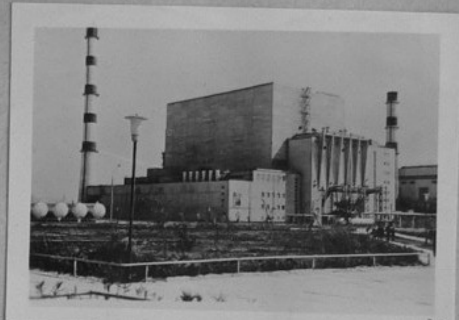
73-3911-14-Изглед от помпената електростанция с реактор с бързи неутрони БН-350 в гр. Шевченко в Казахска ССР. /репр. П. Щерев/ТК
