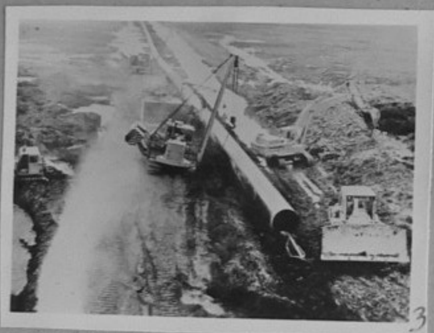
83-429-3 Сглобяване на отделните части на газопроводните тръби в едно на трасето на транс континенталния газопровод. репр./ВЛ
