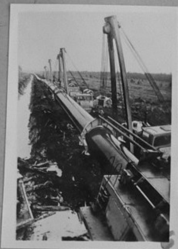
80-3513-6 Коми АССР. На строежа на новия газо- провод Пунга-Вуктил-Ухта- Грязовец С. Губски/МД
