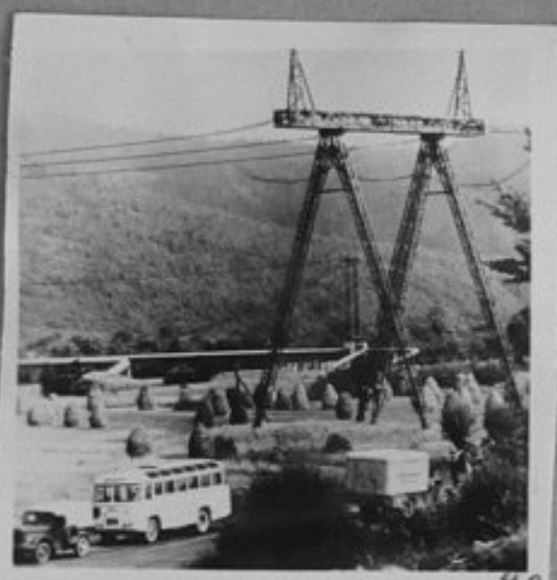
73-5593-49-СИБ. Готовият участък: II етап от международния газопровод "Братство". /репр. П. Щерев/ЛА
