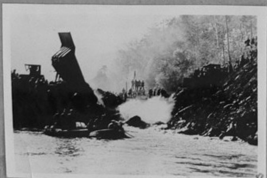
76-29-8-На строежа на Саяно-Шуменската ВЕЦ -11.октомври 1975г. Преграждането на Енисей. Още няколко минути и бушуващата стихия ще бъде укротена. /Репродукция/, ЗЩ.
