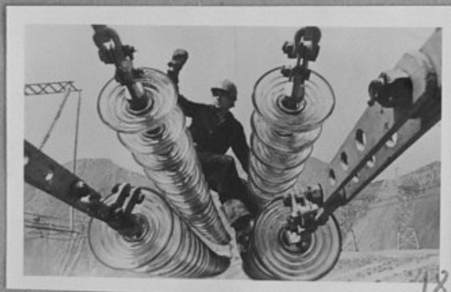
75-3570-18-Токтогулската ВЕЦ, Монтажникът Валери Беляков мон- тира изолаторите на откритите разпределително устройство на централата. /репр./, ЗЩ
