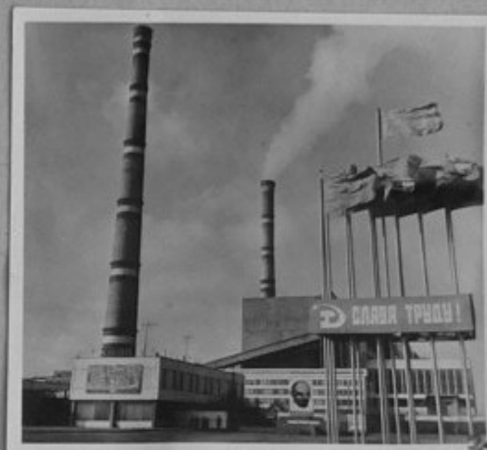
78-1463-30 Запорожката ВЕЦ - една от най-големите в Европа топлини електро- централи. От началото на пускането ѝ са изработени 51 милиарда 534 милиона киловат- часа електроенергия репр./МД
