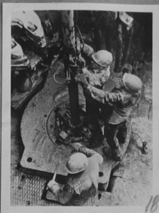
74-4719-18-Поставяне на нова сонда на Оренбургското газово местонахождение. /репр. П. Щерев/ТК
