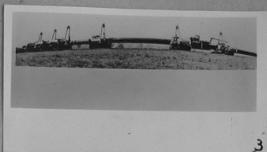
76-2337-3-Изоляционна колона на ленинградци на участъка Оренбург-Уралск. /репр.Е.Радулова/ЛА
