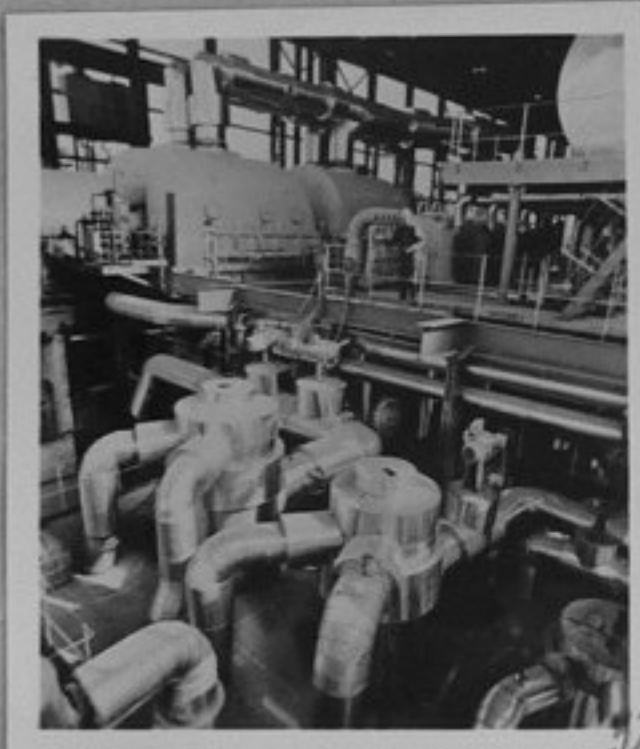
73-3227-32-Турбиният цех на Колската ато- мна електроцентрала. /репр.П.Щерев/ТК
