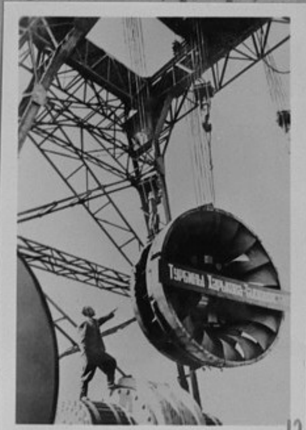
72-4497-12-Работното колело на турбината на Нурекаската ВЕЦ. /репр./ИК
