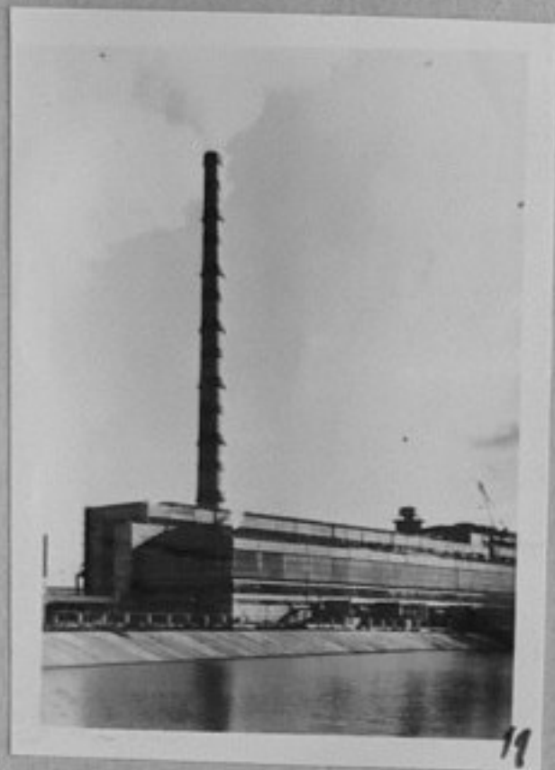
71-6113-11 - Изглед от Костромската хидро-електроцентра. /реп./ЕИ
