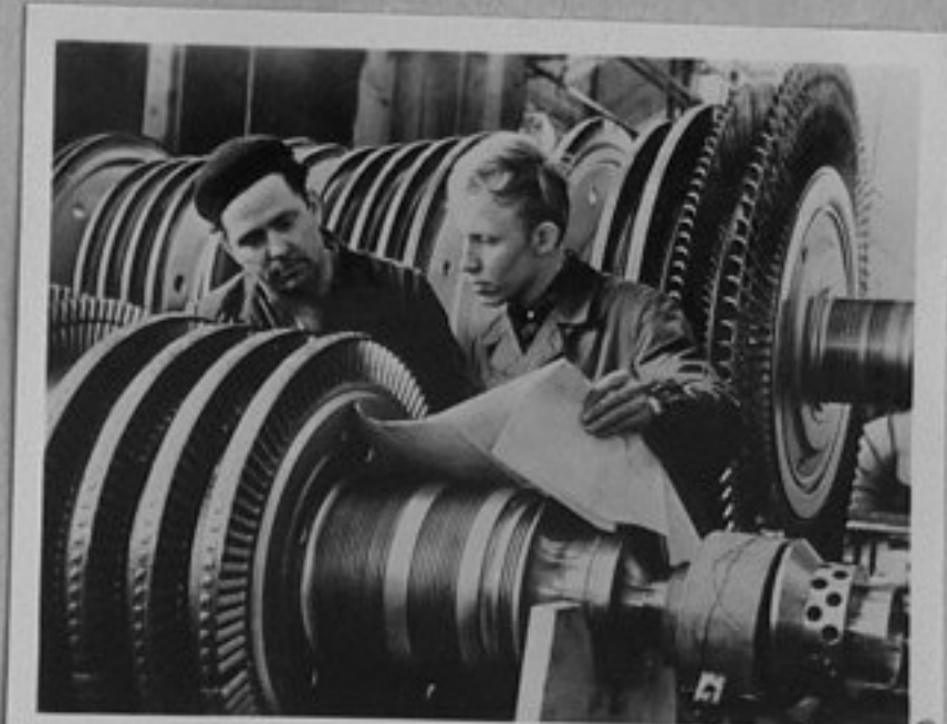
72-5845-43-Монтаж на ротора на турбина с мощност 12 хиляди киловати в Калужския турбинен завод 1970 г. /репр.П.Щерев/ИК
