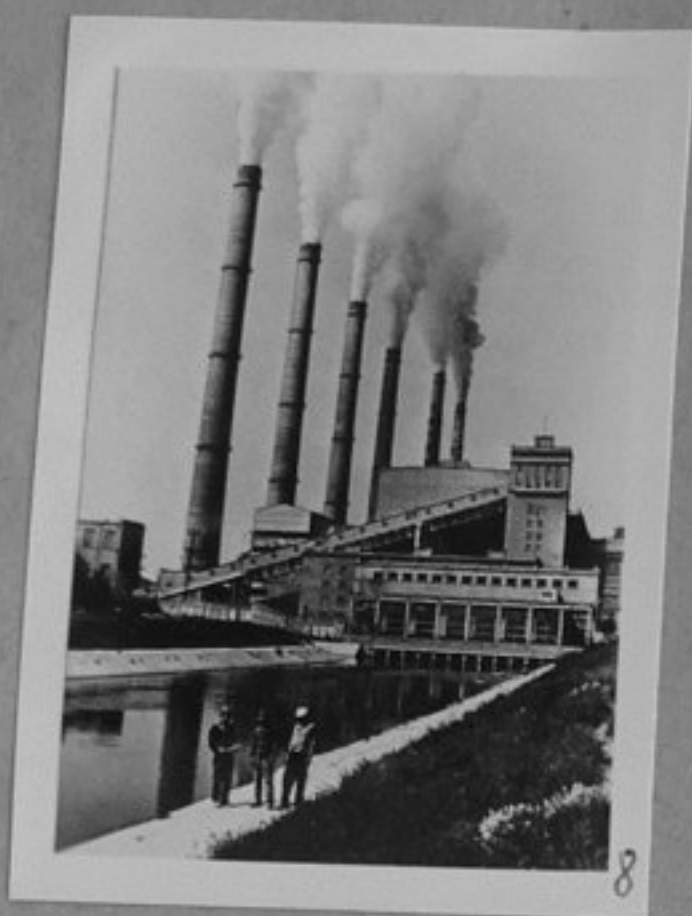
72-4857-8 - Изглед от Прибалтийската електроцентра "Ленински комсомол" най-голямата в Естонска ССР. Тя произвежда 12 милиарда киловатчаса в година. /репр./ЕИ
