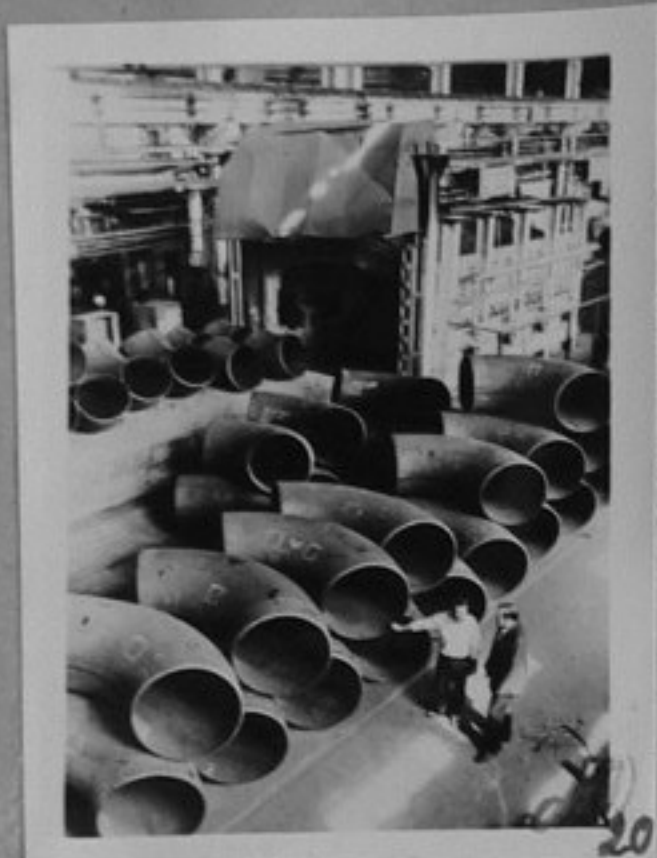
82-1810-20-На участъка за пригот- вление на отводни тръби за га- зопровода. /репр./ЛА
