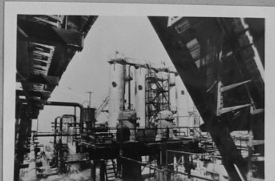
86-111-26-Строящият се блок за пречистване на газта от серни примеси в Щуртане. репр./ЛА
