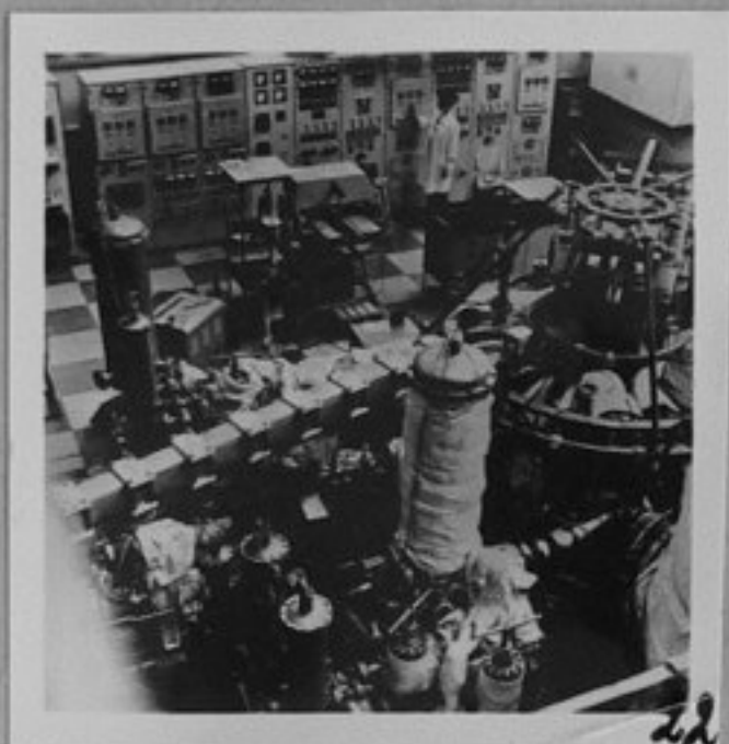
76-2336-22-Монтиране на "Токамак-II" в Института за атомна енергия "И.В.Курчатов." /Е.Радулова/ЛА
