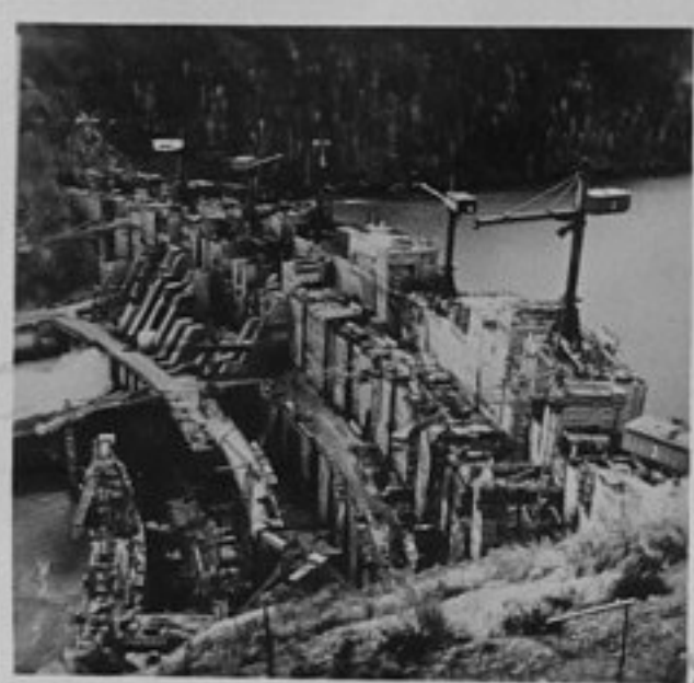
80-911-17 Красноярски край. В навечерието на 7 ноември - деня на 62-годишнина на ВОСР даде ток вторият агрегат на строящата се на Енисей Саяно-Шушенска ВЕЦ. Изглед от строит. на стената на левия бряг на Енисей репр./МД
