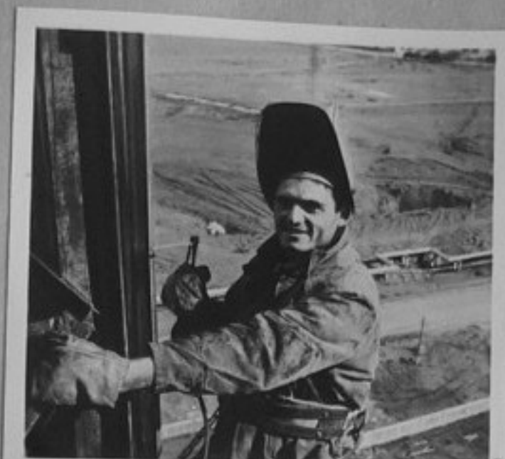
72-864-33-Общ изглед от охладителната кула на Парната електроцентрала. На снимката заварчикът О.Оганесян. /репр./ ИК
