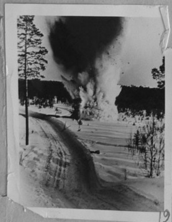
75-1965-19-Томска област. Откриване на нови нефтона- ходища. Сондажът започва с взривяване. /сн.А.Кузнецов/, репр., ИК
