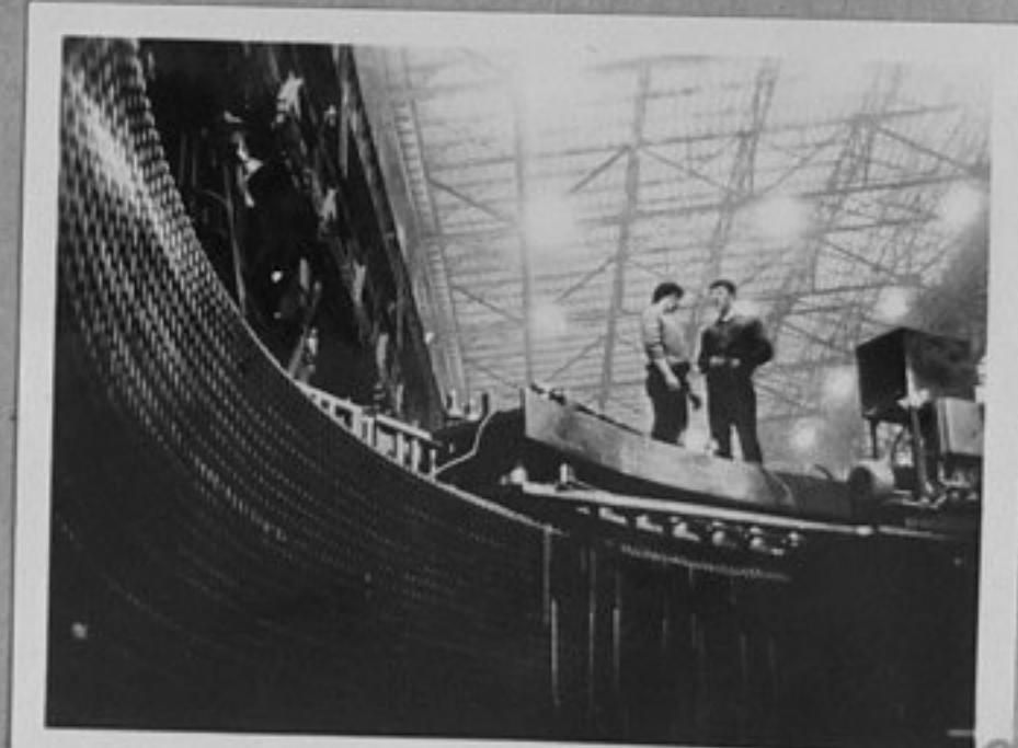
76-29-23-Монтаж на статора на хидрогенератора за Уст-Илимската ВЕЦ в Уралския завод за тежки електрически машини в гр.Свердловск. /Репродукция/, ЗЩ.
