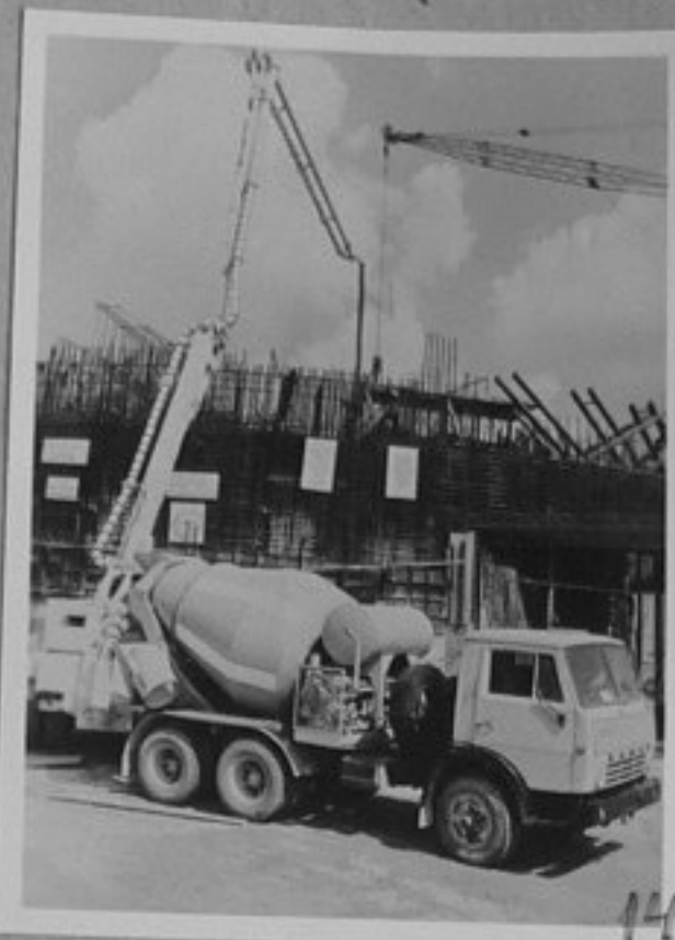
78-2945-14 Авто-бетоносмесител С-1036 и агрегат за подаване бетона на височина, работещи на монтажа на апаратното отделение на първия блок на АЕЦ
