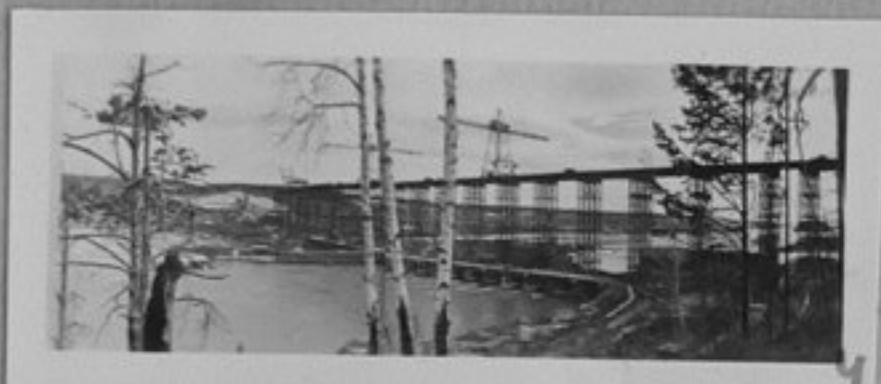
72-3358-4-Изглед от строежа на Уст-Илимската ВЕЦ на р.Ангара. /репр.П.Щерев/ИК
