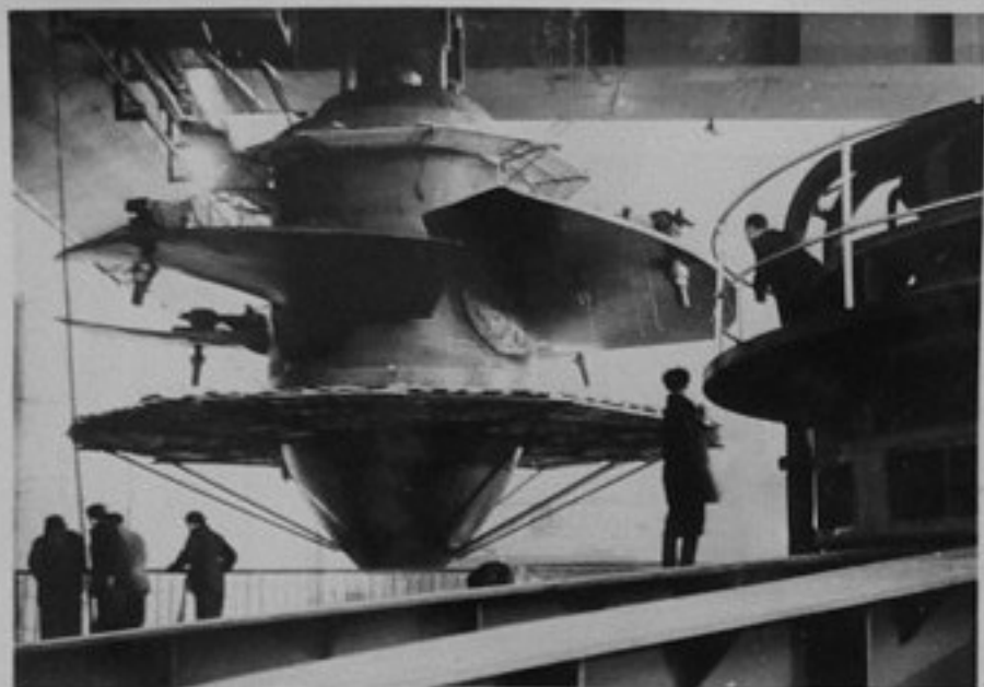
62/273-8 - Монтаж на работното колело на един от агрегатите на електростанцията на Воткинския хидровъзел в Пермска област.
