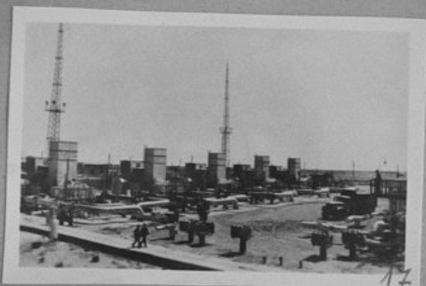
85-1362-17-Газли-компресорната станция. репр./ЛА
