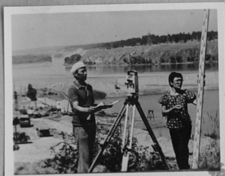
80-2886-16 Г еодезистът И.А.Бирюкова и технич.ръководител А.Н.Любушкин на строителната площадка на Шулинската ВЕЦ Г.Гелфанд/МД
