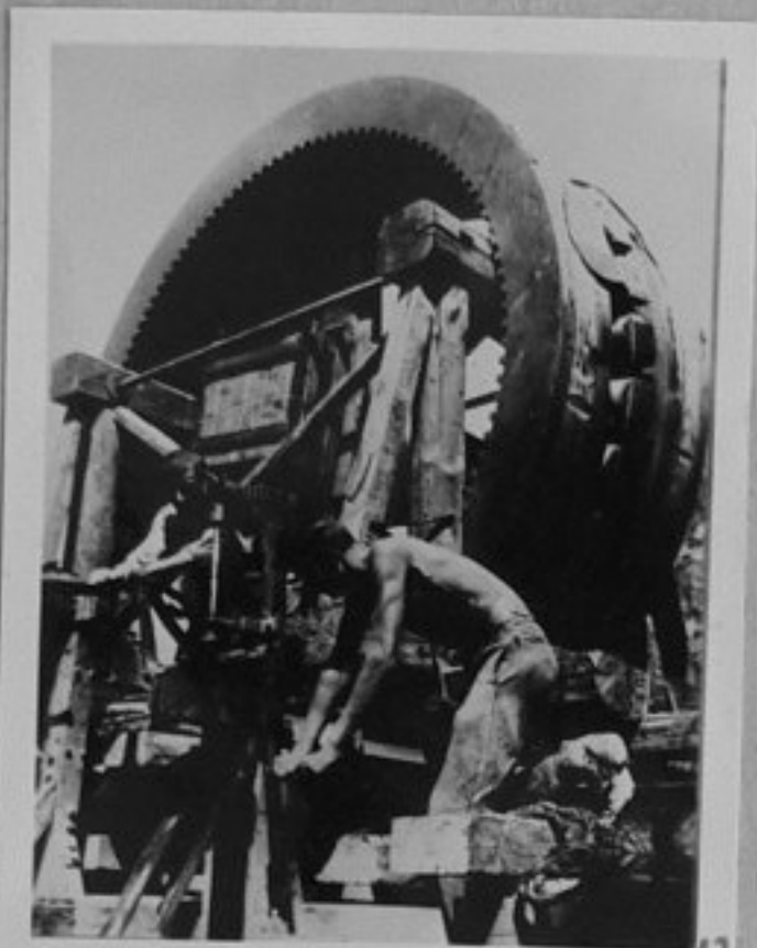
72-5845-42-Монтаж на агрегати на строежа на Ташкентската електростанция 1931 г. /репр.П.Щерев/ИК
