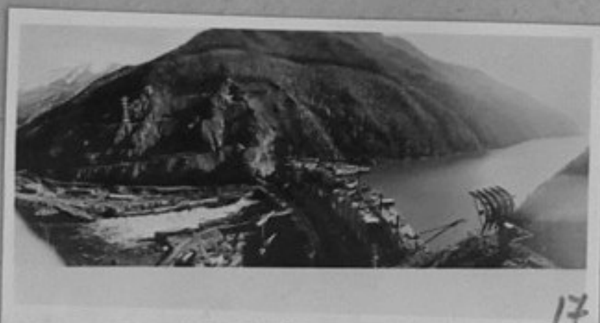
79-416-17-Красноярски край.Монтаж на стартера на първия агрегат на Саяно- Шушенската ВЕЦ, който ще има мощност 640 хил.келовата. /репр./ЛА
