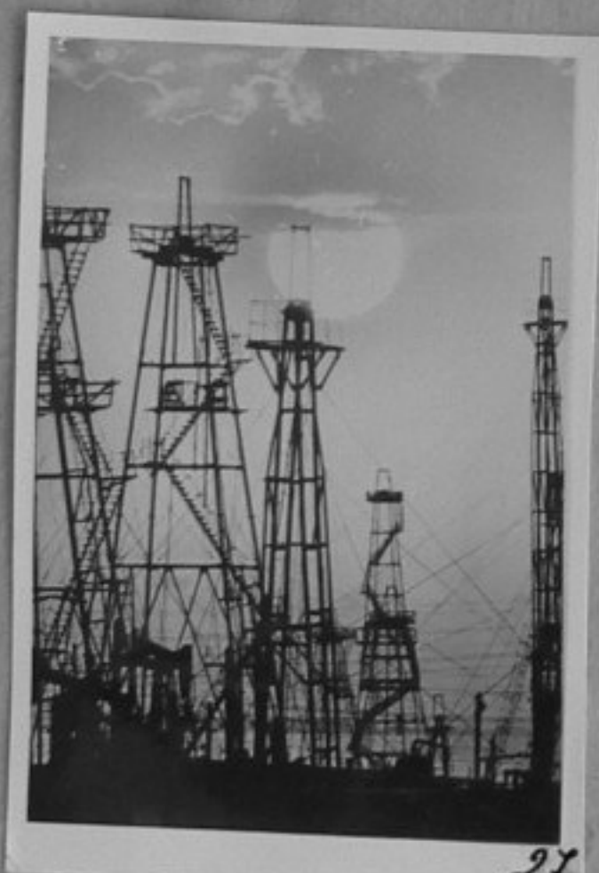
65/2888-27-"Стоманена гора"- изглед от нефтените залежи в Азърбайджан. 24/36 ЕИ
