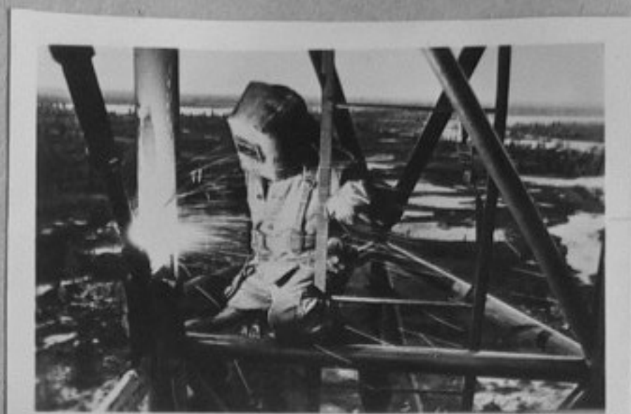
83-429-10 Заваряване на метални конструкции за кулата за високовол- тово електропредаване.
