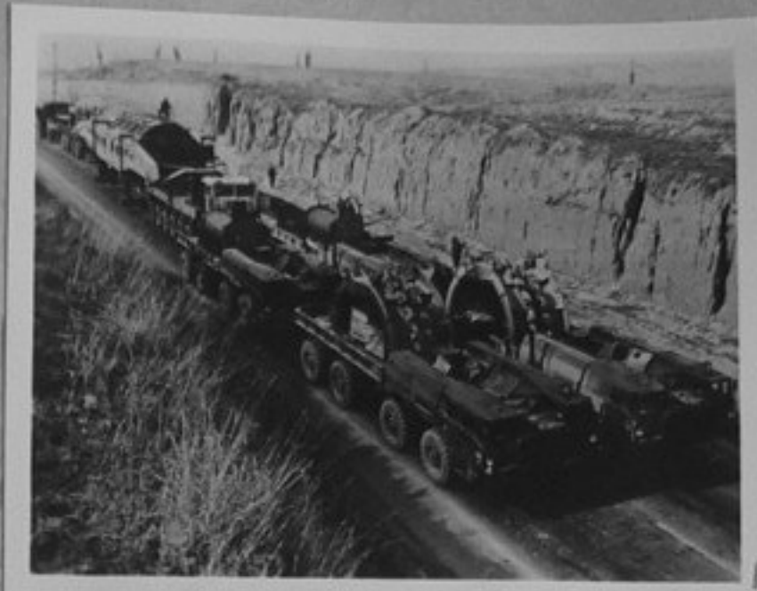
73-1963-5-Транспортиране на 300-тонен трансформатор за третия пусков агрегат на най-голямата в средна Азия ВЕЦ-Нурецката. /репр.П.Щерев/ТК
