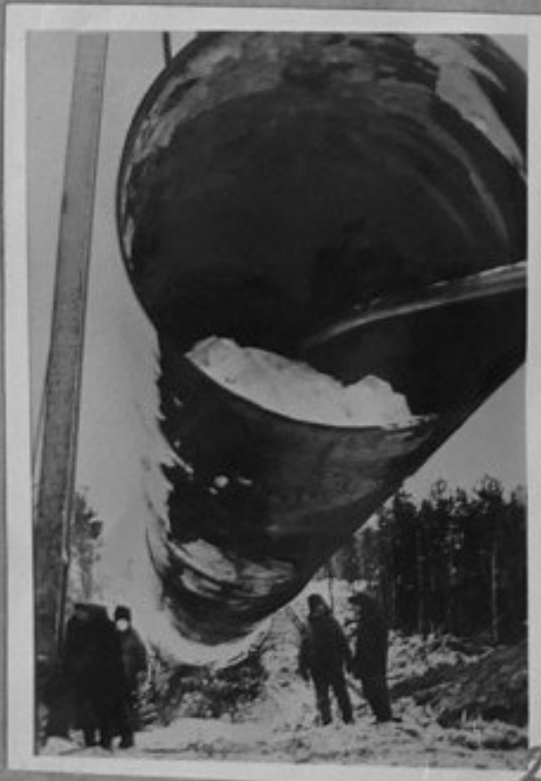
74-1694-2-Третият етап от работата по трасето на 566 километровия газопровод Надим-Пунга. Транспортира газ от Ямало-Немечкия нац. окръг до пром. райони на Урал.
