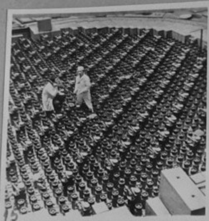
79-416-15-Инж.от монтажно-настрое- ното у-ние С.Басловяк и старшият майстор на лабораторията на Курска- та АЕЦ правят проверка на система- та на защита на реактора преди не- говото пускане в действие. /репр./ЛА
