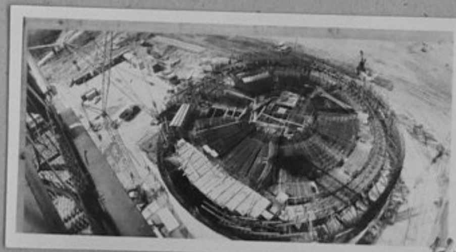
78-2945-12 Калининска област. Монтаж на армо-конструкцията и облицовката на долната херметическа плоча на апаратното отделение на първия блок на Калининската АЕЦ. На Всесъюзния ударен комсомолски строеж работят няколко хиляди юноши и девойки
