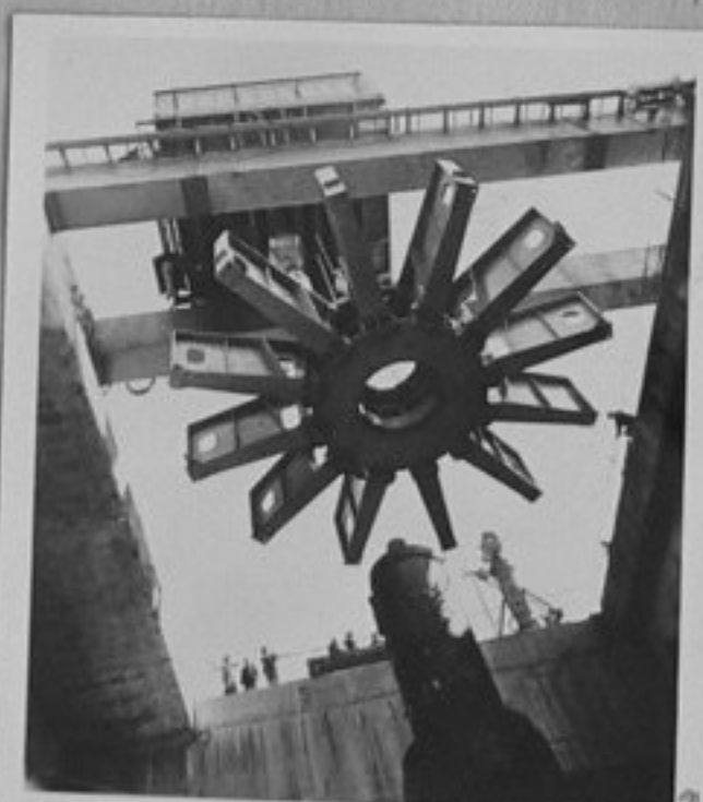
72-3358-3-Монтиране на генератор на първа турбина в Нурекската ВЕЦ. /репр. П.Щерев/ИК
