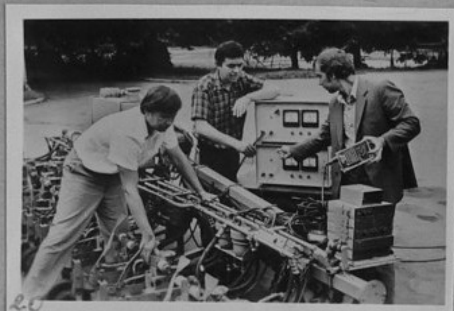
83-2054-20-Инж.С.М.Зотов от Харковския НИИ, водещият инж.конструктор от Софийския и-т по радиоелектроника В.Е.Пелов и инж.от Украинския НИИ за селскостопанско машиностроене Ю.В.Гризенков настройват светлочувствителните датчици на дванадесет-редната машина преди изпитание. репр./ЛА
