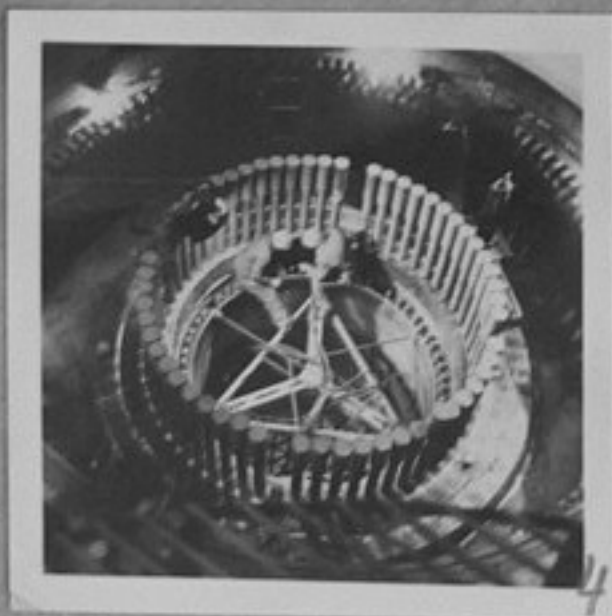
70-1408-4-Монтаж на реактора на втория блок в Нововоронежката атомна електростанция. /ИК/
