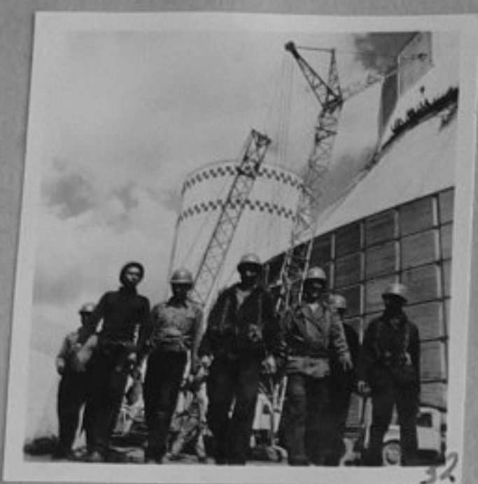
72-864-32-Монтажници на високи строежи, работещи на строежа на Разданската ГРЕС /парна електроцентрала/. /репр./ ИК
