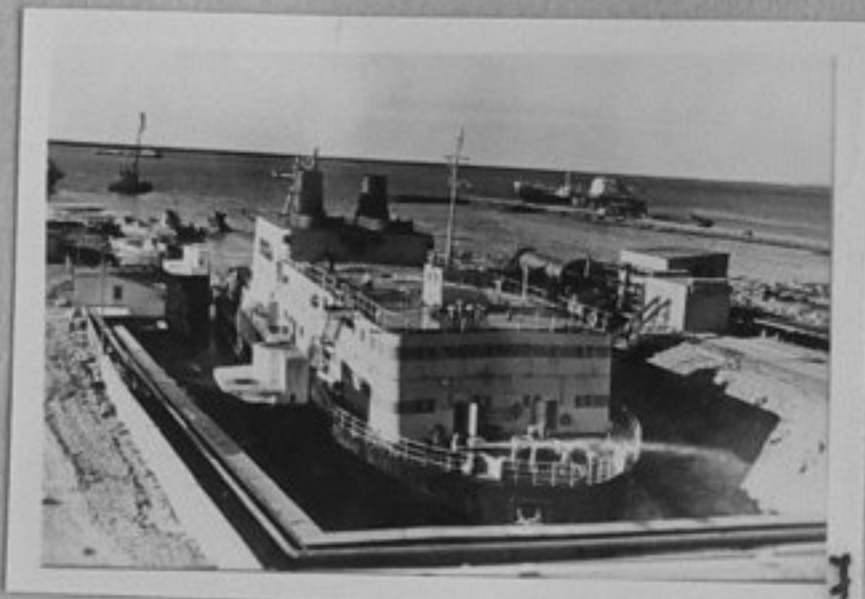
71-6116-7-Плаваща електростанция "Северно сияние-01" на левия бряг на р.Колима, близо до Черски. /репр.П.Щерев/МК
