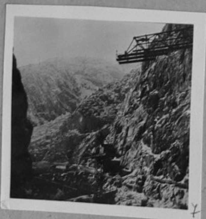
72-4858-7 - Изглед от строителните работи на Токтогулската ВЕЦ, Литовска ССР. /репр./ЕИ
