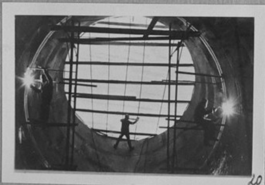
72-4858-20 - Монтаж на гигантски водовод с диаметър 7 м. на Токтогулската ВЕЦ. /репр./ЕИ
