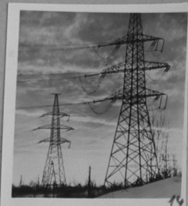
84-245-14-По този далекопровод ток от Калининската АЕЦ се влива в енергийната система на страната.
