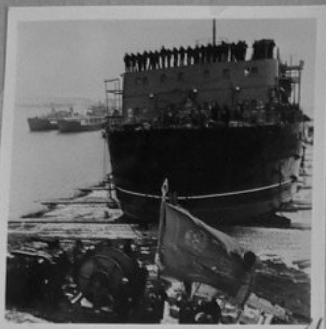
69-3284-21-Плаващата електростанция "Северно сияние" при спускането ѝ във водата в Тюркмения. /репр./ ИК
