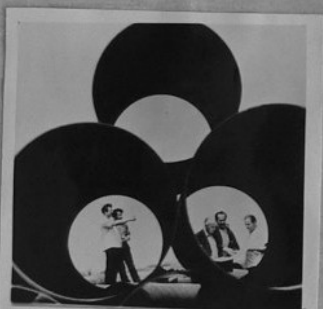
73-5593-50-Строители на електро-системата "Мир" II участък от международния газопровод "Братство" /репр. П. Щерев/ЛА
