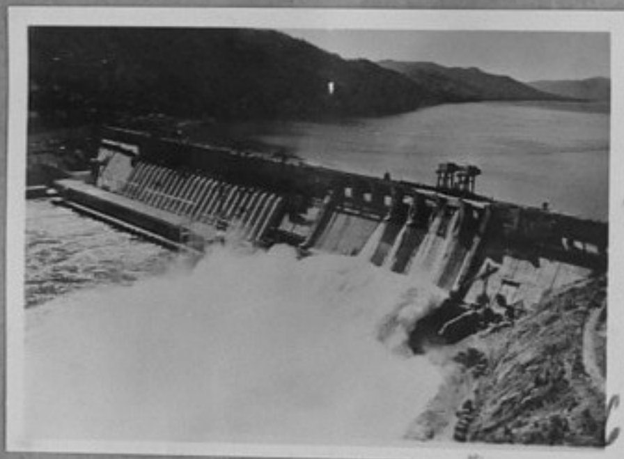
74-4055-6-Изглед от най-голямата в света Красноярска хидроелектростанция в Сибир с мощност 6 милиона киловата. /репр. П. Щерев/ ИК
