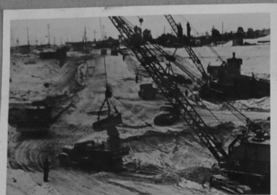
12-На строежа на киевската Комсомо́лска ВЕЦ - пета степен от Днепърската каскада от електростанции.
