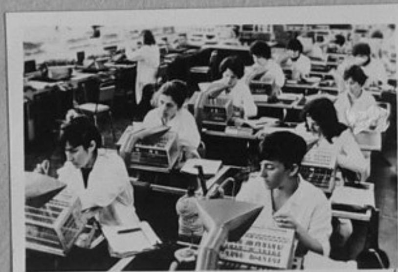
82-1559-4-В монтажния цех на завода "Телемаханика". /репр./ЛА
