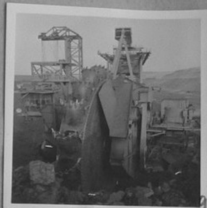
75-768-3,6,9-Роторният багер на открития рудник "Екибастус" най-голямото въглищно находище на СССР. /О.Юскеселиев/ТК
