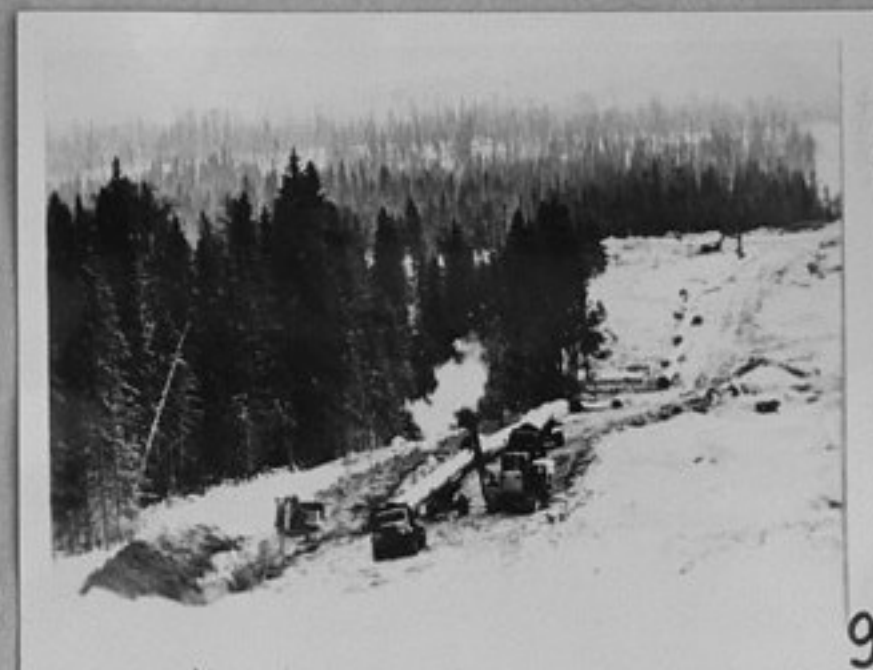
82-1451-9 Полагане на тръби в пемския участък на газопровода Уренгой-Новопсков в урелската тайга. /репр./ЛА
