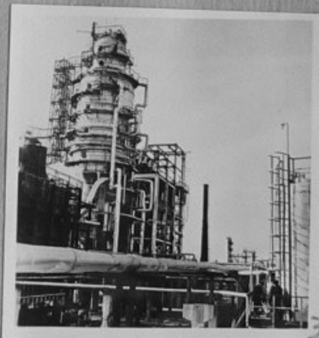
72-4253-3-Общ изглед от новите съоръжения за ва- куумна дестилация на ма- зут към Красноводския неф- топреработвателен завод. /репр. П. Шерев/ИК
