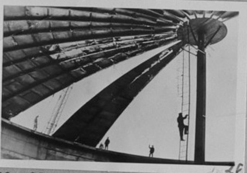
76-1281-26-Монтаж на един от гигантите-резервоари на строящата се база за смесване на нефт, недалеч от град Куйбишев. Работата се извършва от специалисти на Новокуйбишевското монтажно управление на тръста "Нефтохиммонтаж". /Репродукция/, ЗЩ.
