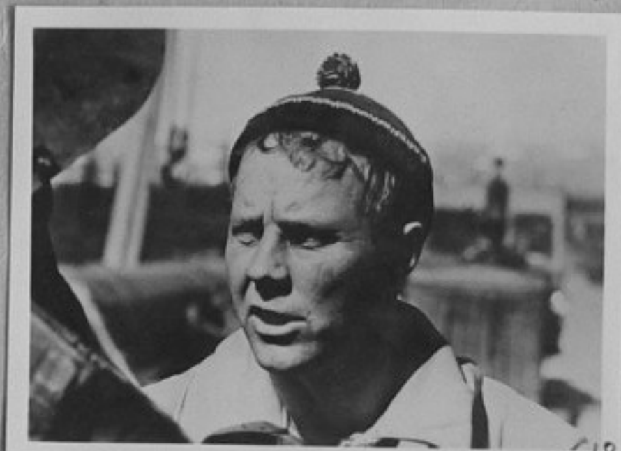
72-864-18-Заварчикът Анатолий Демин - един от строителите на новия газопровод Надим-Ухта, работил като специалист на много други газопроводи-магистрала в различни райони на страната. /репр./ ИК
