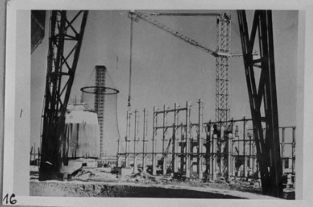
16-Строеж на нова топлоцентраля в Москва.
