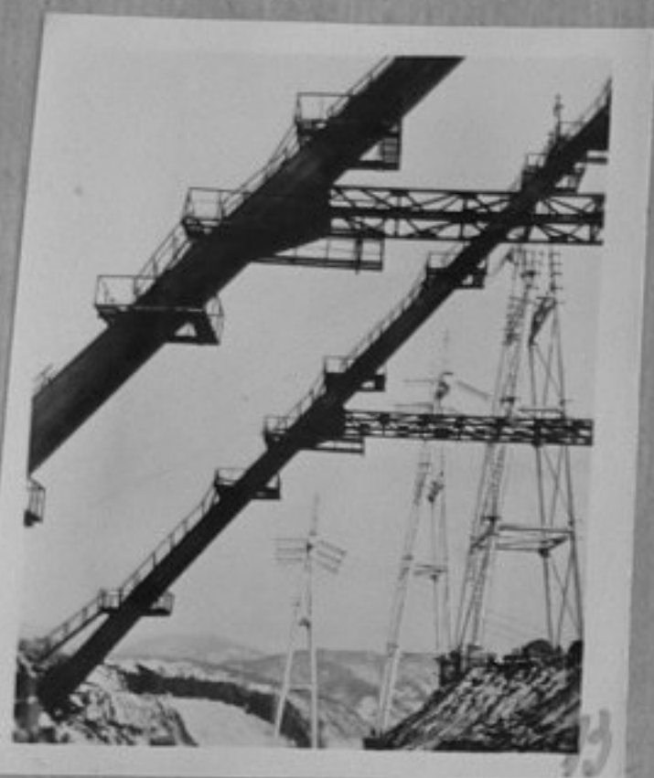
72-2366-13 - Сибирски пейзаж. Високоволтова линия на Красноярската хидроенергетична централа. Снимка: А.Гостев.
