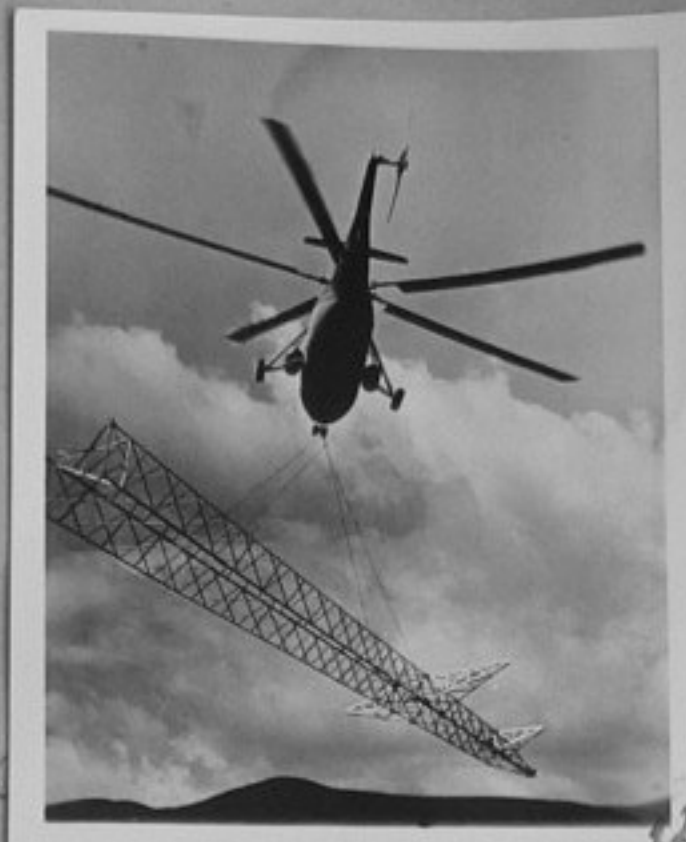
80-127-12 Хеликоптерът МІ-6 доставя стълб за електрическа трансмисия в Магаданска обл. репр./МД
