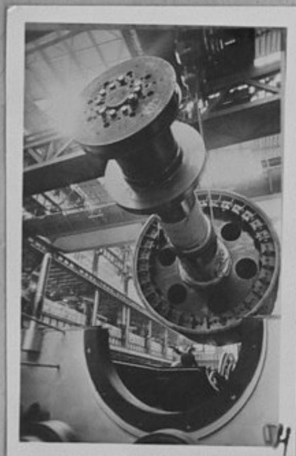
79-488-4-Наричат ленинградското произвествено обединение "Електро- сила" "С.М.Киров" флагман на съв. енергомашиностроене. Монтаж на дви- гател с мощност 11,500киловата за прокатен стан. /репр./ЛА
