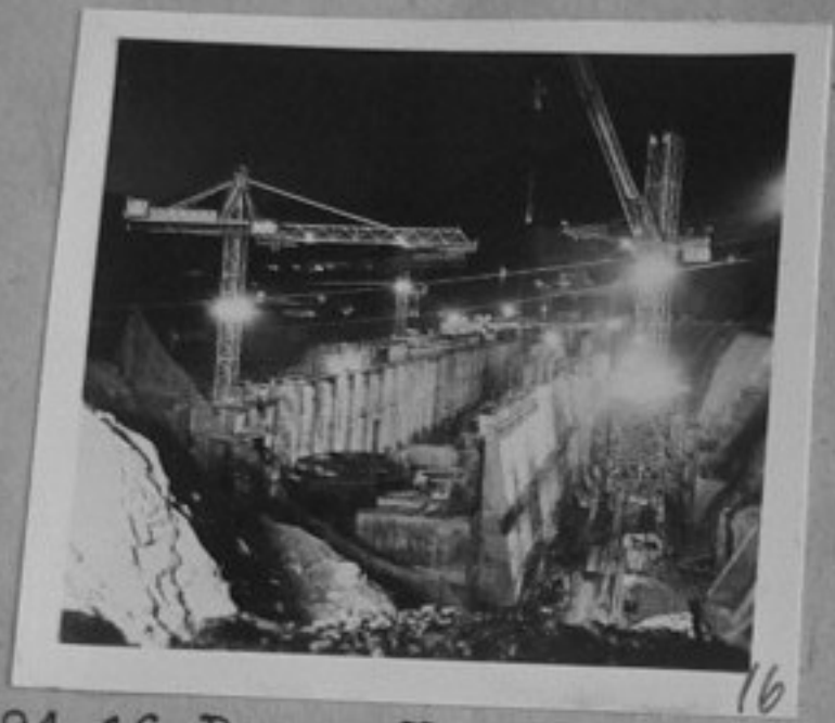
72-5594-16-Расте Нурекската ВЕЦ в Таджикска ССР, която ще има най-високата в света насипна язовирна стена /317 м./ /Репр.П.Щерев/МК
