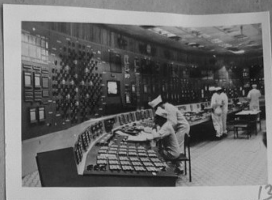
75-1771-13-Централният пункт за управление на Ленинградската атомна електростанция "В.И.Ленин". Най-новите електронно-изчислителни машини осъществяват контрол за оборудването и режима на работа. /сн.А.Стелмах/, репр., ИК
