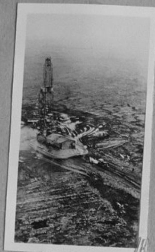
72-4805-18 - Производствени изследвания с експерименталните сондови съоръжения на въздушна възглавница в Тюменска област на РСФСР. Сондата е 170 тона и с помощта само на един трактор се транспортира по труднопроходими и заблатени местности./ЕИ
