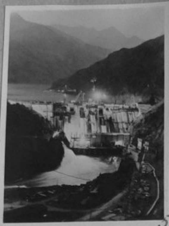
82-1483-5-Общ изглед от строителството на Курпсайската ВЕЦ. репр./ЛА
