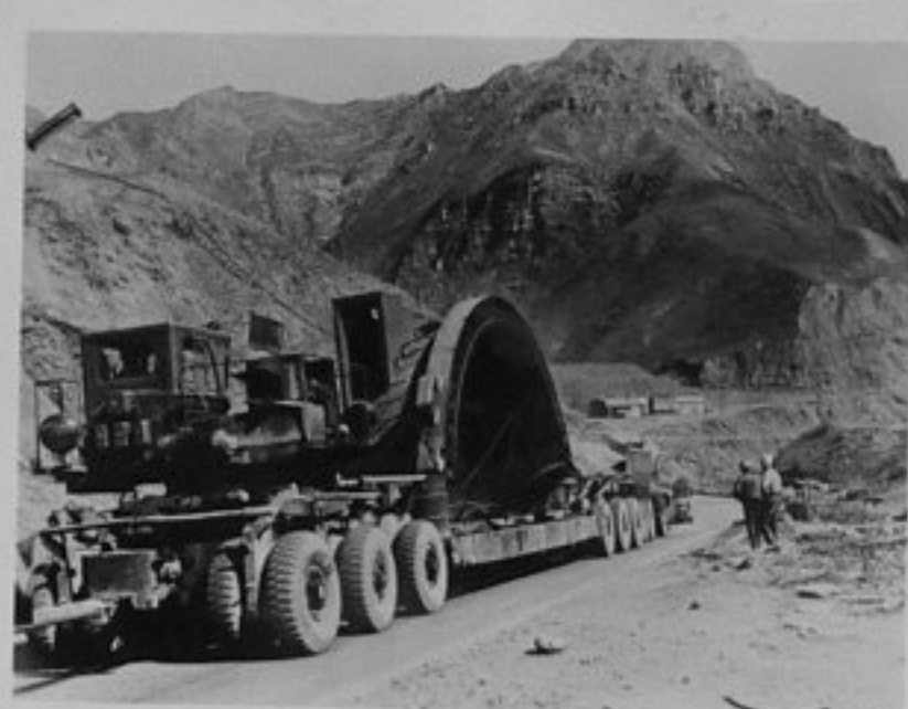
72-2975-30-Транспорт за оборудване на монтажната площадка на Нурекската ВЕЦ, Таджикска ССР. /репр. П.Щерев/МК
