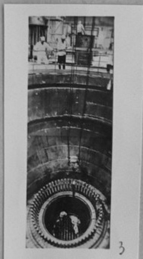
73-1712-3-Товарене на ураново топливо в активната зона на реактора преди физически пуск./Нововоронежката АЕЦ/. /Репр.П.Щерев/МК
