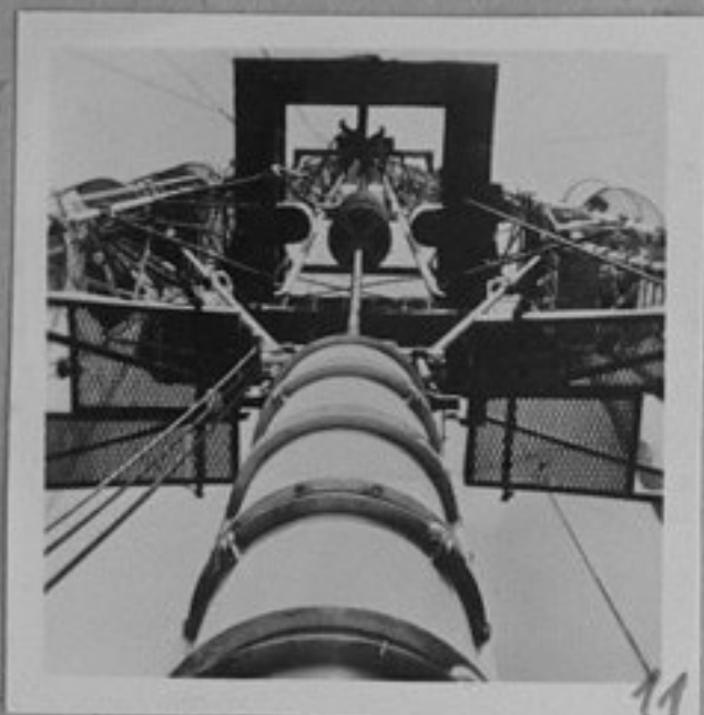
69-3365-Куйбишевския научно-изследователски и-тут по нефтена промишленост и френски специалисти, провеждат експеримент за пробиване на сонди без сондажни тръби чрез маркучо-кабелно сондиране. 11-Експерименталната сонда. 12-Маркучо-кабелното сондиране.
