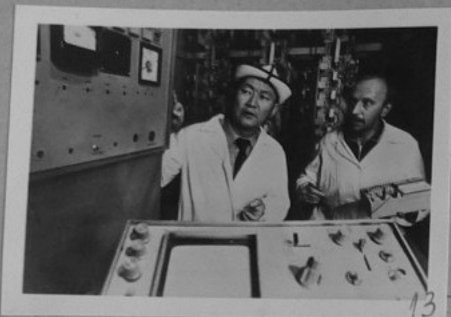
86-111-13-Началник на отдела Б.Ботбаев и научният сътрудник от лабораторията по електроенергетика В.Преображенский на инвентарното подстанция на високопланинската опитно-промишлена линия за предаване на постоянен ток Туз-Аму-Су-самир. /рвпр./ЛА
