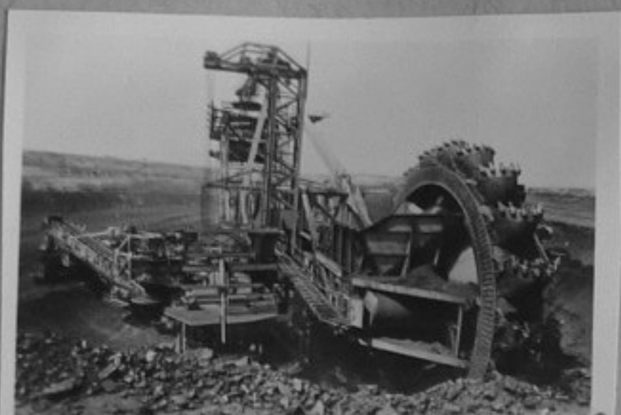
73-3911-23-Роторен ескалатор работи за добиване на въглища в най-големия разрез за въглища в Екибастузкото местонахождение "Богатир"/Казхаска ССР/. /репр. П. Щерев/ТК
