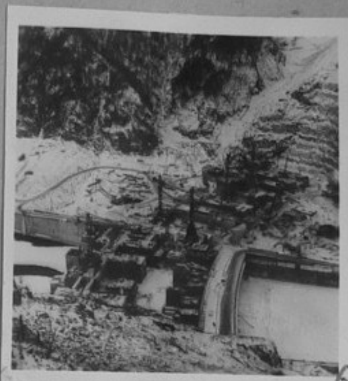
77-894-6 Красноярски край - ударно работят строителите на най-голямата в света Саяно-Шушенската хидроелектростанция на река Енисей. Колективът е поел обещание да предаде първия агрегат през 1978 година. /репр./МД
