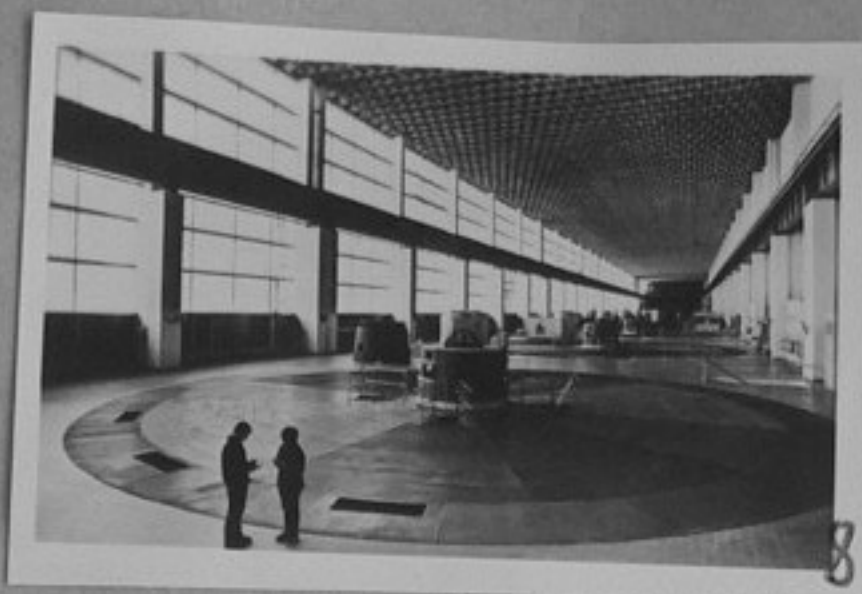
71-3099-8-В машинната зала на Красноярската хидроелектростанция. /репр.П.Щерев/ИК
