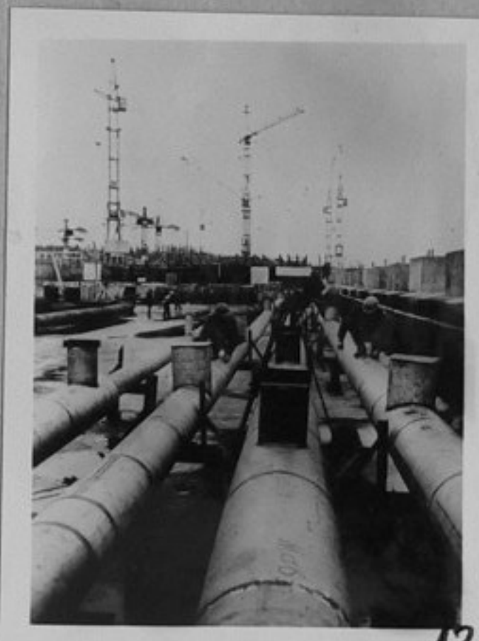
76-3793-13-Монтиране на технологически тръбопроводи на строежа на втората част на Ленинградската атомна електростанция. /репр./ЛА
