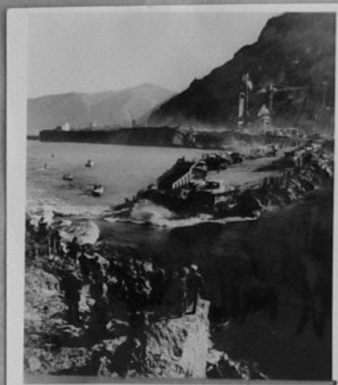
75-4490-32-Преграждане на Енисей. Бреговете разделят последните 20 метра. /репродукция/, ЗЩ.
