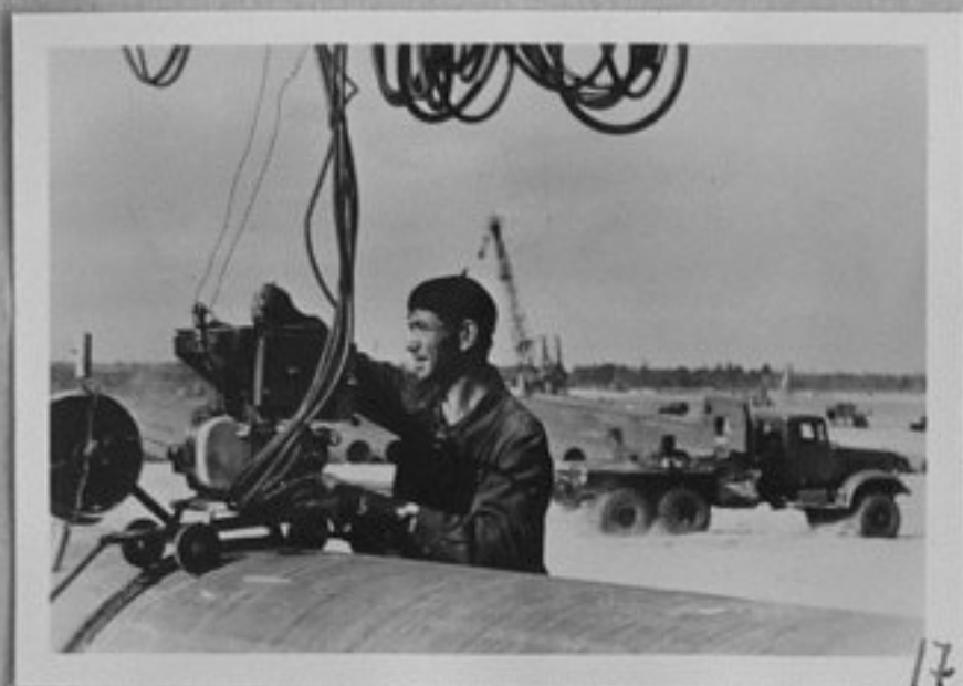
72-864-17-Бригадата по заваряване - монтажници от Уфимския тръст "Нефтепроводмонтаж" работи на северния газопровод. /репр./ ИК
