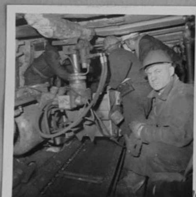
75-769-2,4,6-Запознаване на българската делегация с новия комбайн, работещ под наклон 75 в зависимост от въглищния пласт. /О.Юскеселиев/ТК
