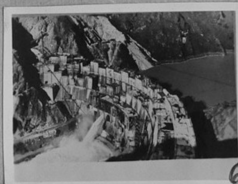
81-2052-6 В планините на голям Кавказ израстват уникален сводов бент на Ингурската ВЕЦ Чохонелидзе/МД
