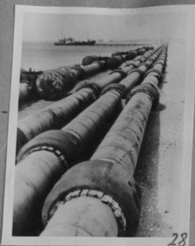
75-1474-28-Монтиране на подводния тръбопровод, който ще съединява нефтеното находище "Бахар" на Каспийско море с Апшеронския полуостров недалеч от Баку. /репр./, ИК
