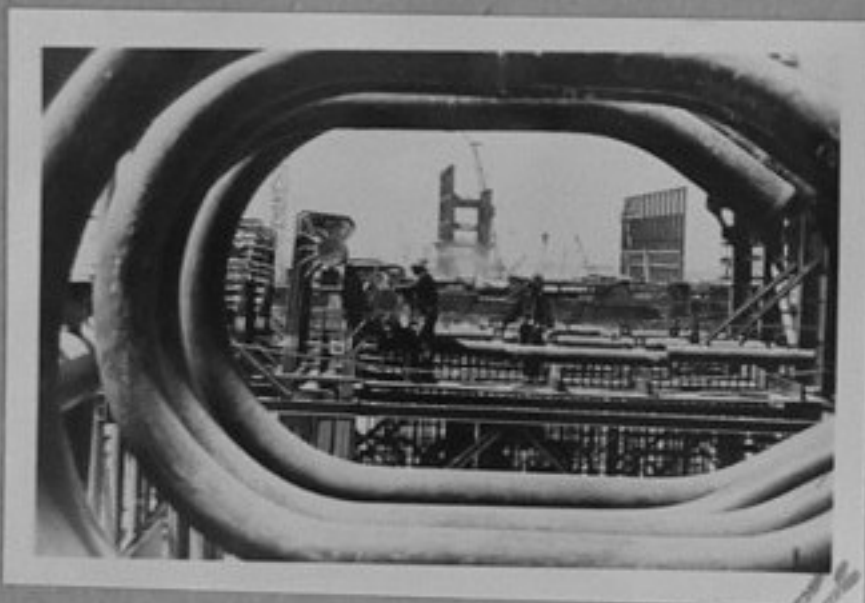
72-4253-14-Паронагревателните тръби на котела на първия енергоблок в Марийската ВЕЦ. Мощността на новия енергиен гинант на Туркмения ще превиши 1 милион и 300 хиляди киловата. Агрегатите му ще работят с природен газ.
