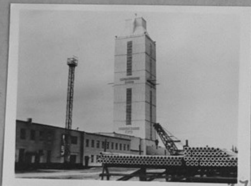
79-4049-27 Колската свръхдълбока сонда, най-дълбоката в света минна изработка. За сега е достигната дълбочина на проникване 9670 м. репр./МД
