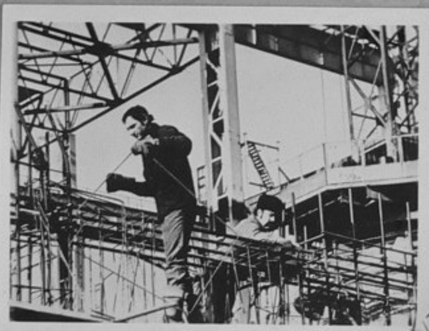
76-711-15-П.Николов и М.Димитров извършват връзването на арматурата на главния корпус на фабриката за гранулиране на рудата. /сн:ТАСС/, /репр./, ЗЩ.
