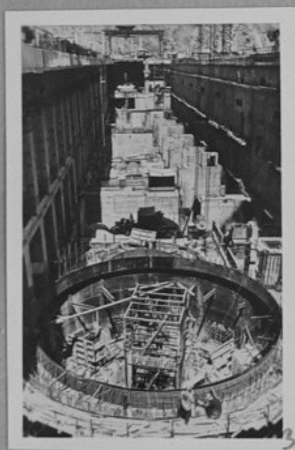
72-4497-3-В машинната зала на Нурекската ВЕЦ. /репр./ ИК
