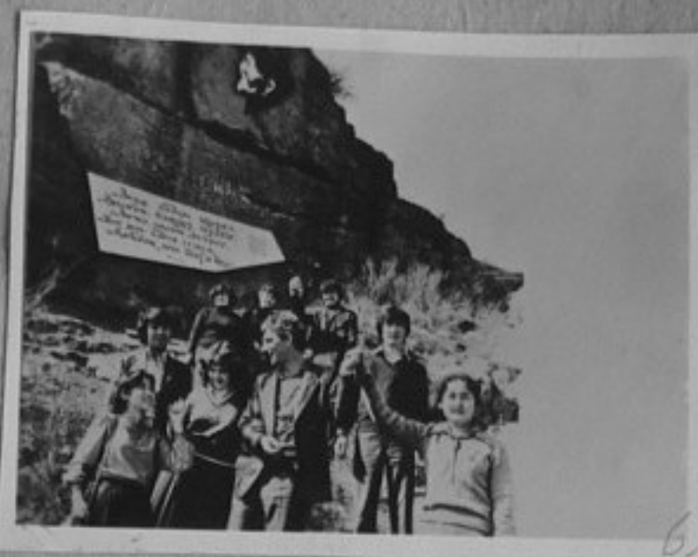
82-1483-6-Курпсайската ВЕЦ е обявена за всесъюзен ударен комсомолски строителен обект. репр./ЛА
