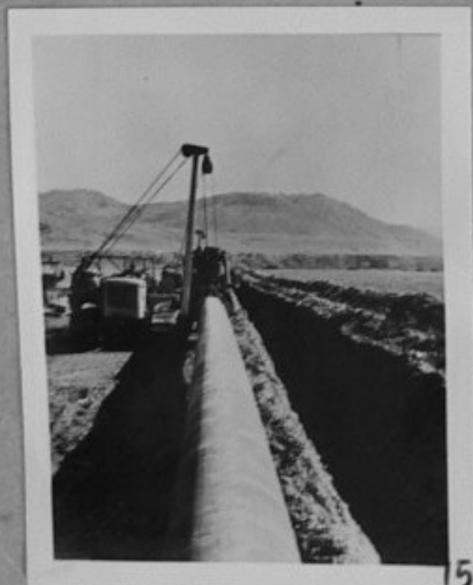
73-5608-15-Закарпатска област. Поставяне на тръби на строежа на газопровода СССР-ЧССР.
