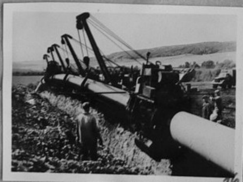
71-1397-16-Поставяне на тръбите на главния участък Алметьевск-Куйбишев, втората магистрала на нефтената подземна магистрала "Дружба", която свързва поволжската нефтени пояса с ПКР, ГПР и УНР.
