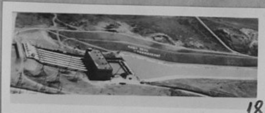
77-3034-18 Помпената станция № 4 е една от шестте станции, построени в безводната Каршинска степ. По всяка от шестте и тръби изтичат към целината по 40 куб. метра вода в секунда, които до края на петилетката ще превърнат в плодородни плантации милиони хектара пустинна земя репр./МД
