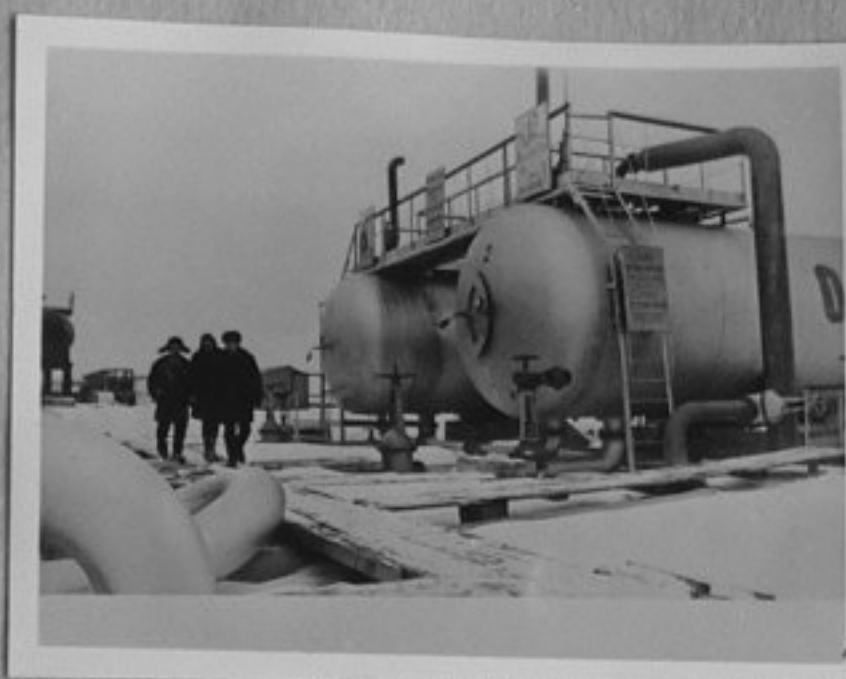
73-283-1-Помпена станция на Самотлор- ското нефто находище, най-голямото в Западен Сибир. /Репр. П. Щерев/МК
