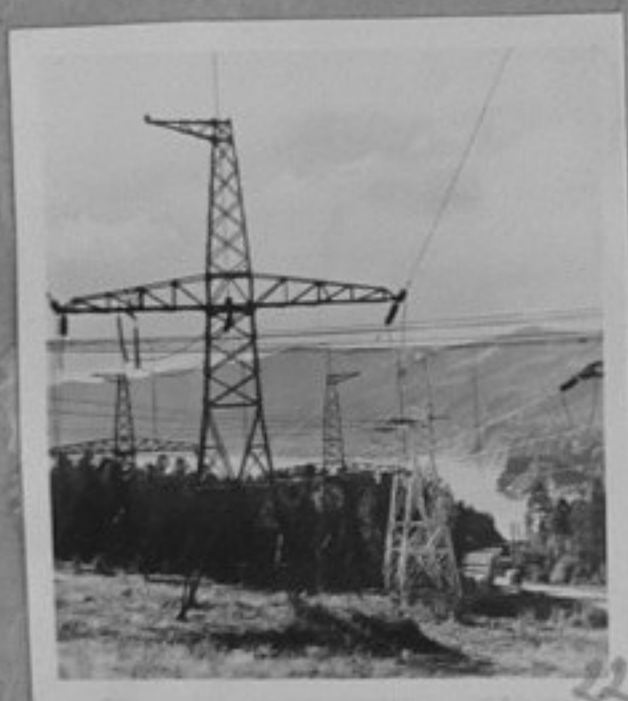
70-885-22-Далекопровод от системата на Красноярската ВЕС. /П.Щерев/ репр. /ИК/
