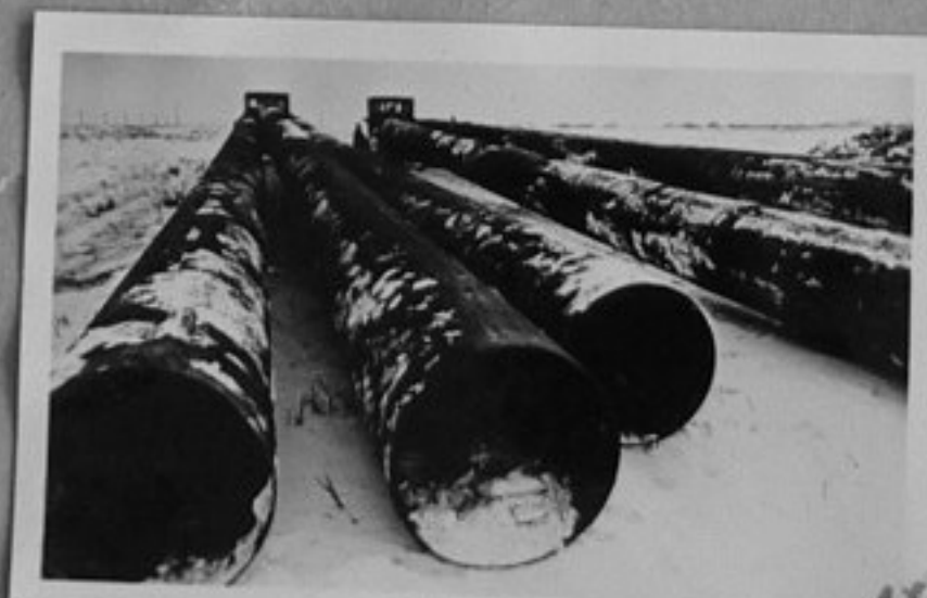
71-1397-17-Превозване на 35 метрови секции тръби на строежа на нефтепровода "Дружба" в Куйбишевската област. /репр.П.Щерев/ ИК
