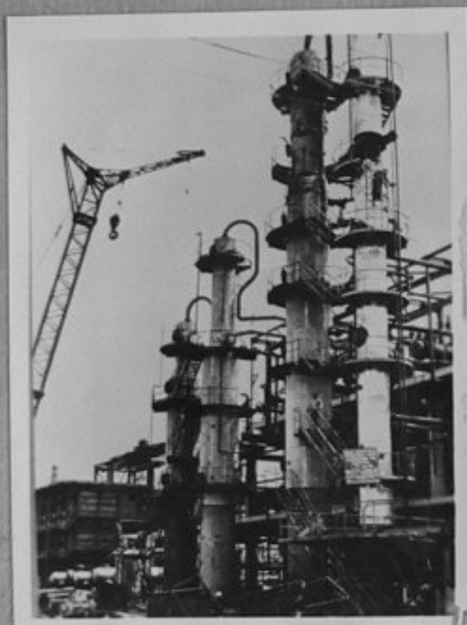
72-3939-15 - Един от блоко- вете на каталитическия завод, който служи за хидроочиства- не на дизеловото гориво и др. /репр. М. Кръстевич/ЕИ
