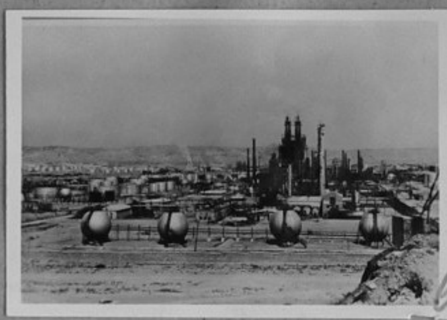
74-5568-6-Туркмения. Красноводският завод, едно от най-съвременните нефтепереработвателни предприятия в СССР. /ТК
