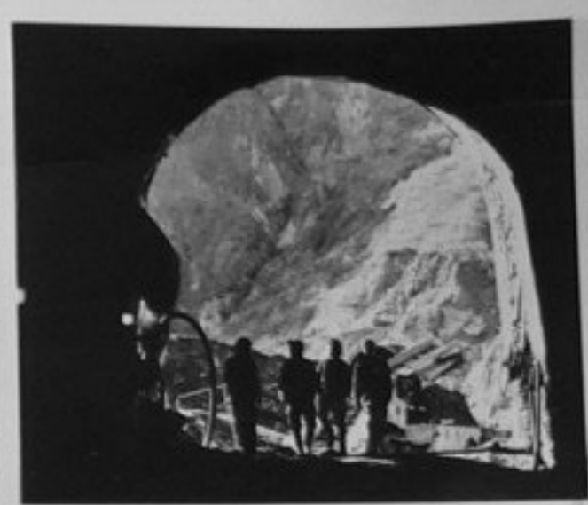
82-815-19 Входът на галерията, водеща към първия строит. тунел на Рогунската ВЕЦ Р.Нетелев/МД
