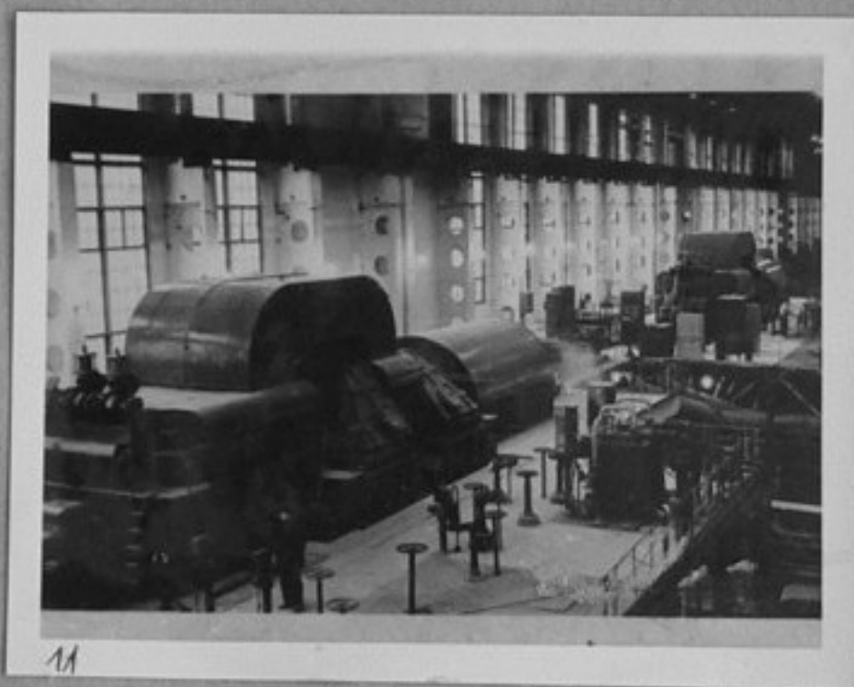
61/4142-11-4. и 5. турбогенератори на Прибалтийската електроцентраля.
