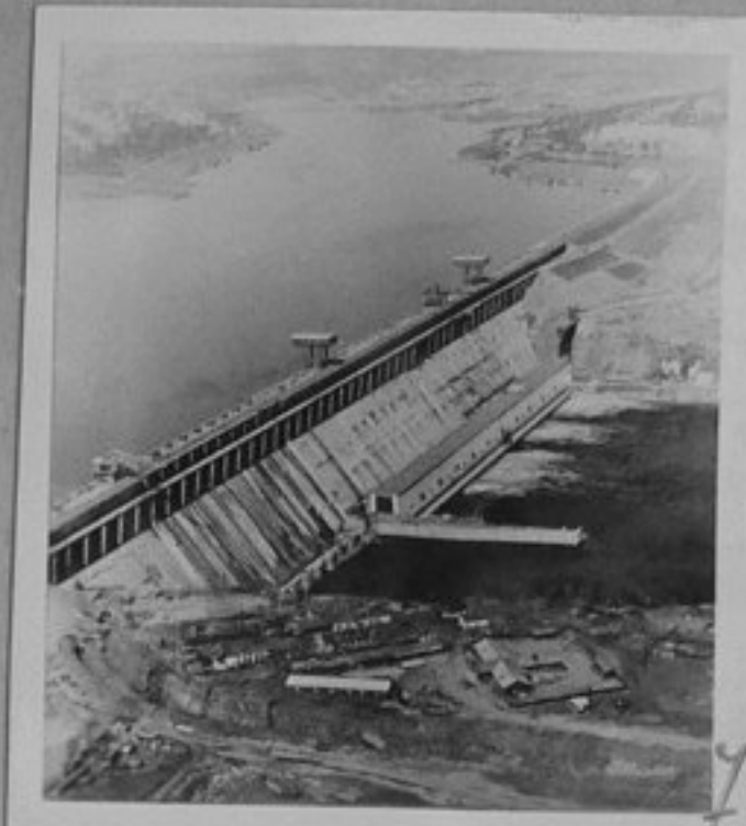
72-4805-7 - Общ изглед от Братската хидроелектрическа станция. /репр./ЕИ
