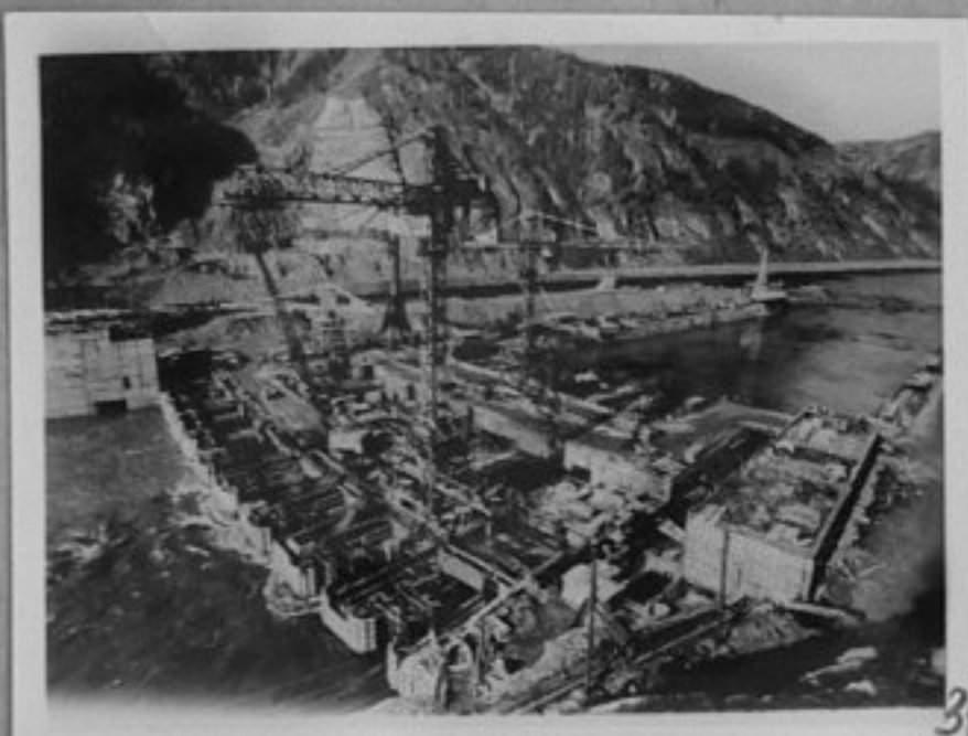
75-4490-31-Изглед от строителството на Саяно-Шушенската ВЕЦ на река Енисей в Сибир - октомври 1975 година. /репродукция/, ЗЩ.
