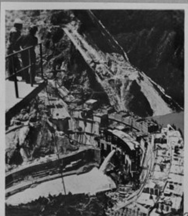
78-2921-23 Грузинска ССР На строежа на уникалната сво- дова язовирна стена на Ингури- ГЕС - Всесъюзен ударен комсо- молски строеж
