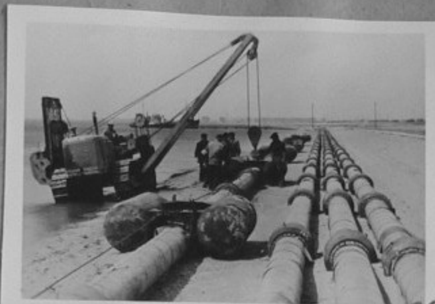
75-1474-29-Подготовка за спускане на дъното на Каспийско море тръбите на новия подводен нефтопровод. /репр./, ИК
