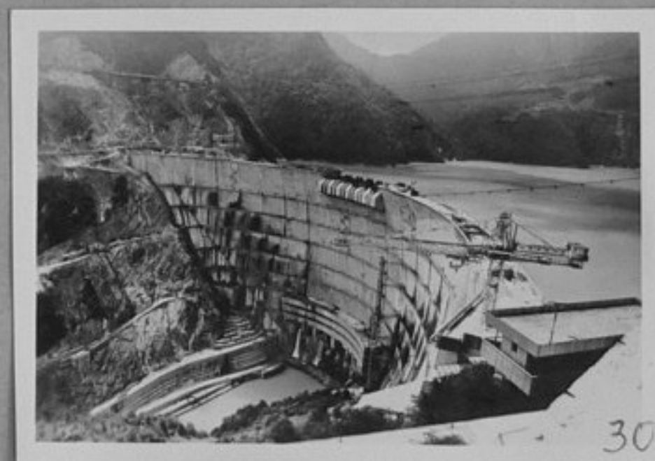
86-1283-30-Грузинска ССР - Ингурската ВЕЦ. Язовирната стена на река Ингури се издига на височина 271,5 метра. репр./ЛА
