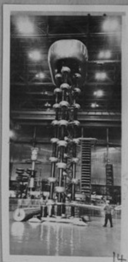
78-2650-14 Запорожие. Инсталация за постоянен ток с напрежение 2 милиона и 5 00 хиляди волта във високоволтова зала на Всесъюзния институт за трансформаторостроене. репр./МД
