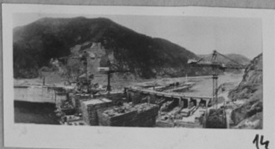
76-3793-14-Красноярский край. На строежа на Саяно-Шушенската ВЕЦ. /репр./ЛА
