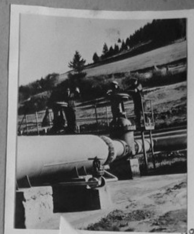
73-5593-48-СИБ. Площадката с филтрите на помпената станция на нефтопровода "Дружба" в Лвовска област. /репр. П. Щерев/ЛА
