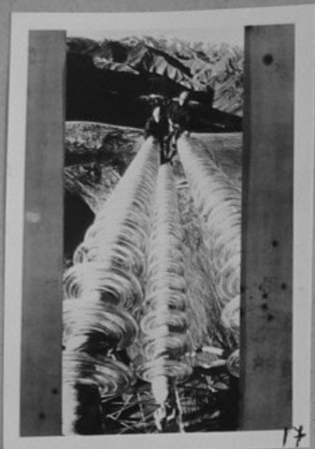
78-765-17-Монтиране на изолятори на високопланинската ЛЭП-500, която ще свързва Токтогулската ВЕЦ със столицата на Киргизска ССР г. Фрунзе. /репрТАСС/МК
