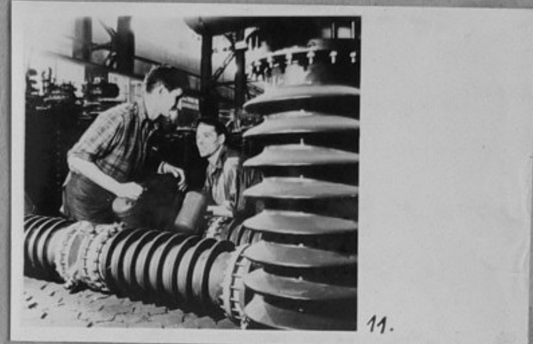
61/2383-11-Г.Голиненко и А.Румянцев работят по електропроводи за пренасиране на електр. енергия от Братската ВЕЦ до завода "Уралелектроапарат".
