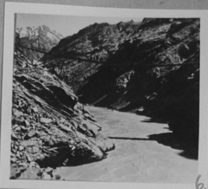
72-4497-6-Мястото на бъдещата Рогунска ВЕЦ. Тя ще бъде най-мощната от станциите на каскадата на Вахтските ВЕЦ-ове. Ежегодно ще дава 14 милиарда квт/ч. електроенергия. /репр./ИК
