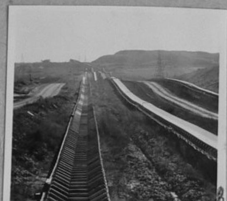
73-4639-8-Транспортни ленти за пренасяне на желязната руда до Рудообогатителния комбинат в Железногорск. /К.Арсов/МК
