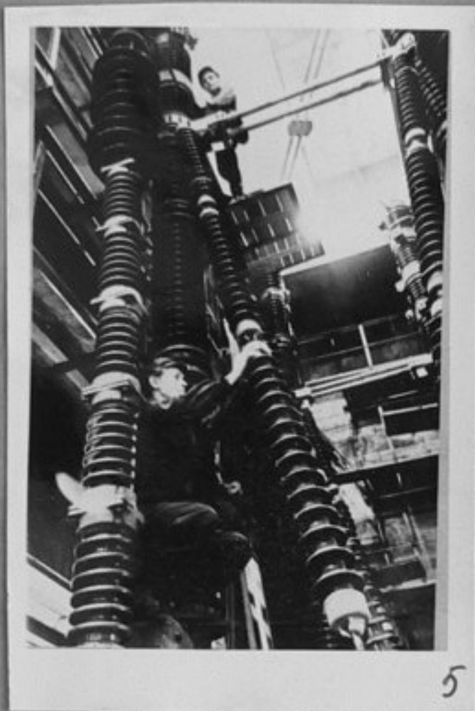
5- Ваздушен вклучител за 330 киловолта 10 милиона киловолт-ампера в завод "Електроапарат" в Ленинград.
