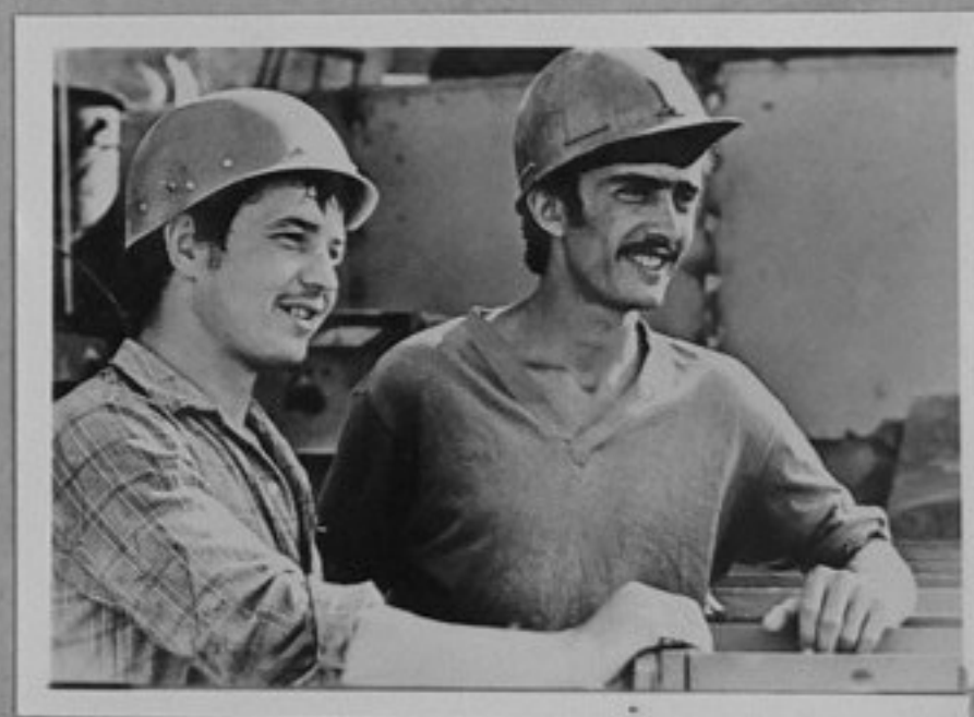
72-4497-4-Млади строители на Нурекската ВЕЦ - плосерът Сергей Слещенко и бетонджията Рахмасаид Шосенов. /репр./ ИК
