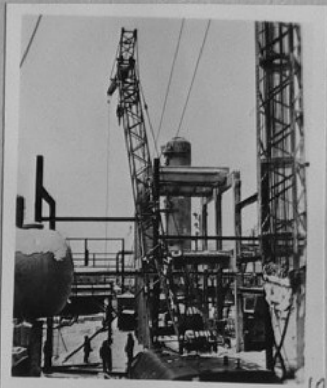
73-1963-10 - На строежа на газопереработателния завод в Карагал. /репр. П.Щерев/Т
