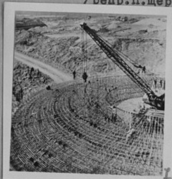
72-3358-7-Монтаж на арматурата на фундамента на димните тръби на ТЕЦ при Комплекса от газопрееработващите заводи в района на станция Каргал.Строят се заводи, котлена станция,ТЕЦ, жилища за работниците. /репр.П.Щерев/ИК
