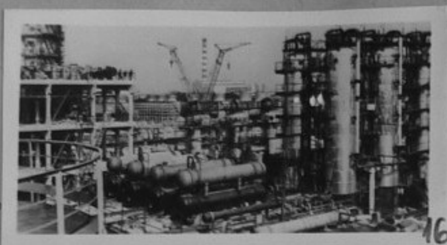
77-3574-16 Монтаж на технологичната уредба за производство на Битум в Мозирския нефто-переработвателен завод - Белорусска ССР. Годишната мощност на уредбата е 500 хиляди тона продукция репр./МД
