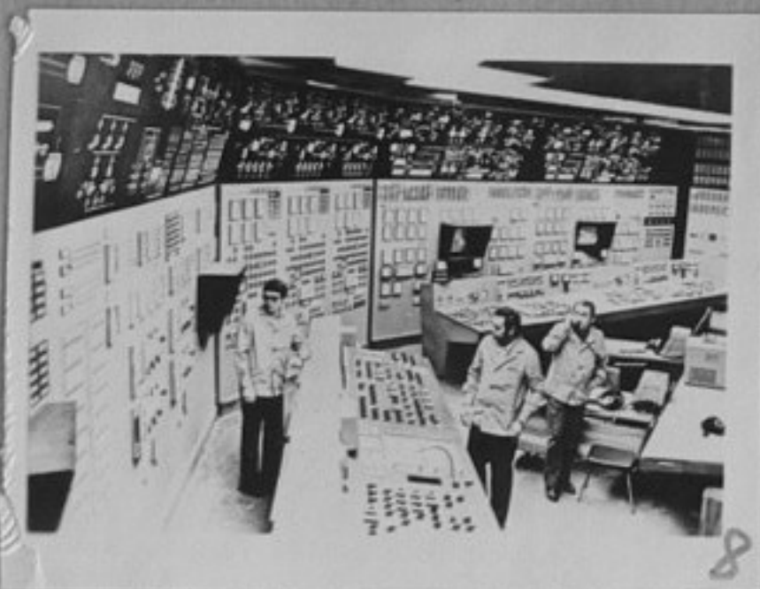
80-1496-8 Блокното командно табло на петия главен енергоблок на Нововоронежката АЕЦ с мощност един милион киловата В.Кожевников/МД
