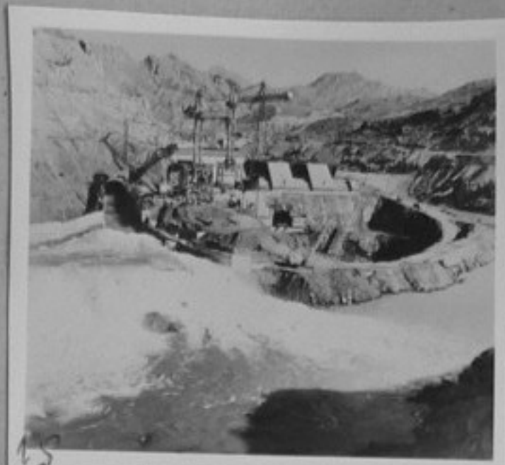
85-888-15-Петата степен на Наринската каскада. На сн.: на строителната площадка на Тал-Кумирската ВЕЦ.
