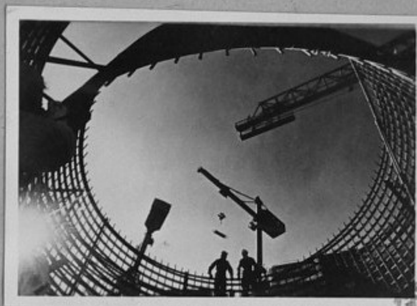
80-911-17а Подготовка на арматурата за третия хидроагрегат на Саяно-Шушенската ВЕЦ репр./МД
