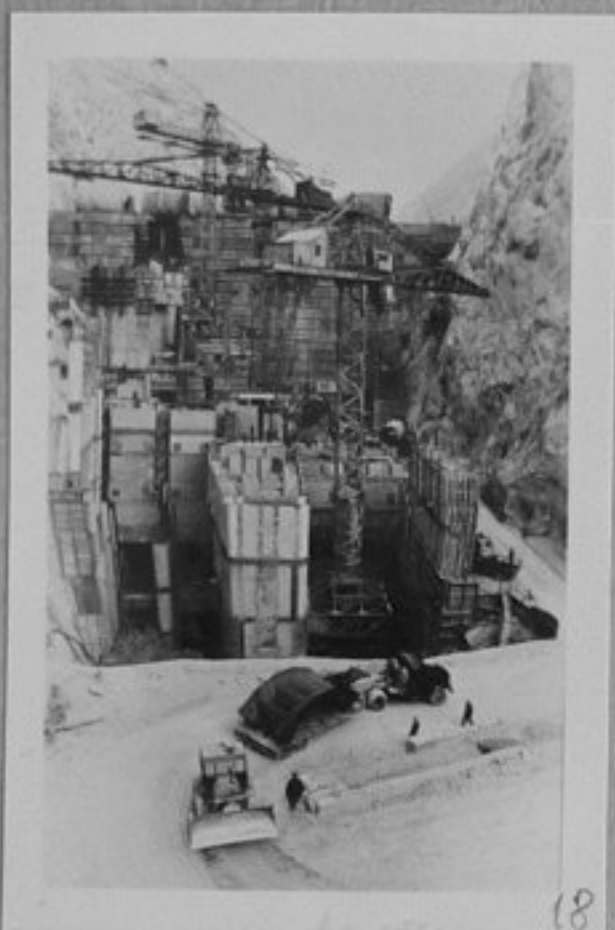
72-4858-18 - Строителни работи /изливане на бетон/ на стената на Токтогулската хидроелектроцентрада.
