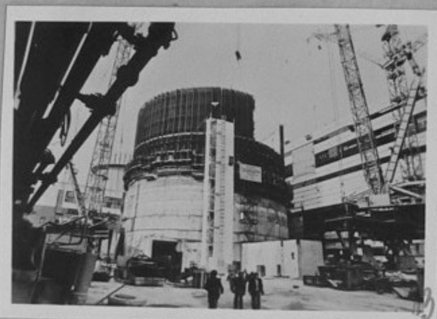
84-18-13-Расте гигантът на южен Буг, Украинска ССР. На Южно-Украинската атомна електростанция е завършен до проектно ниво първият енергоблок с мощност един милион киловата. Строителството на втория енергоблок. репр./ЛА
