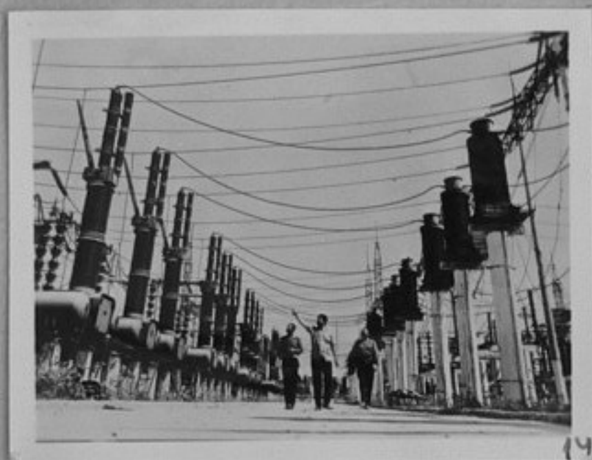
72-5315-14 - Един от участъците на Али-Байрамлинската хидроелектроцентрала "В.И.Ленин". /репр./ЕИ
