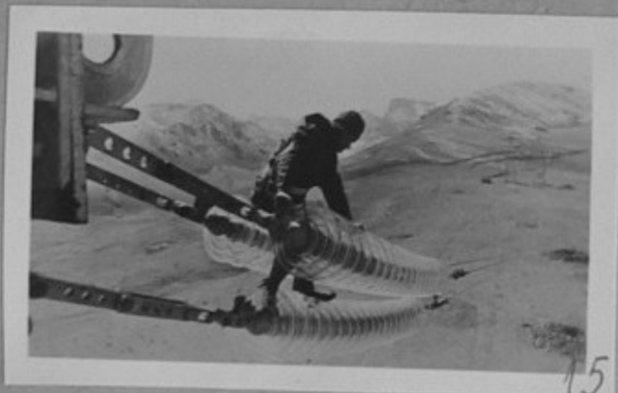
86-111-15-Научният сътрудник от лабораторията за конструкции на въздушни линии Н. Попов ръководи монтажа на датчиците по отклонението на гирляндите от изолятори на опитното разстояние на преваля Кум-Бель. репр./ЛА
