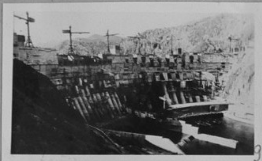
83-2125-9-Участък от строителството на язовирната стена на Саяно-Шушенската ВЕЦ. /репр./ЛА
