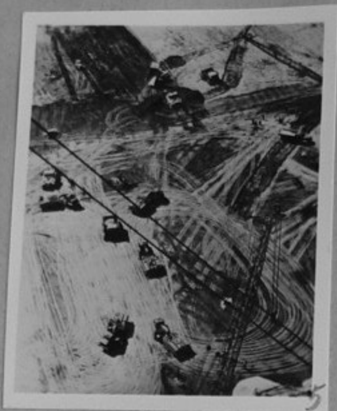
72-4497-5-Насипване язовирната стена на Нурекаската ВЕЦ. Тя ще бъде висока триста метра и ще има водохранилище от 95 кв.ккм. /репр./ИК
