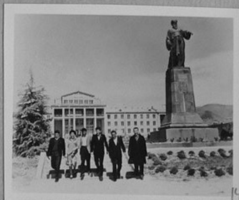
72-4497-14-Сградата на Таджикския селскостопански институт в Душанбе. /репр./ ИК
