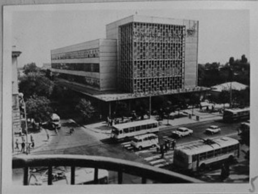
72-5089-5 - Сградата на Между- градската телефонна централа. /репр./ЕИ
