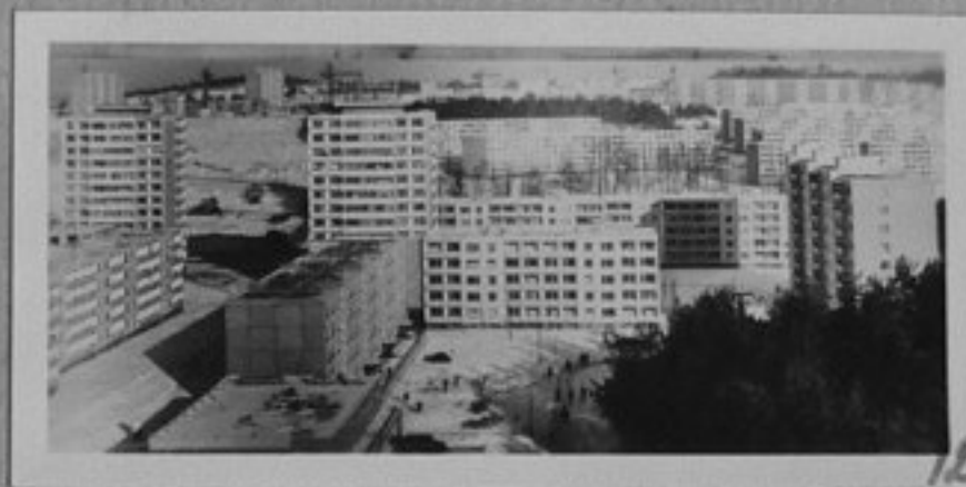
72-4435-12-Част от новия жилищен район "Ладзинай" във Вилнюс, изграден от железобетонни конструкции, произведени във Вилнюския жилищно-строителен комбинат. /репр./ ИК
