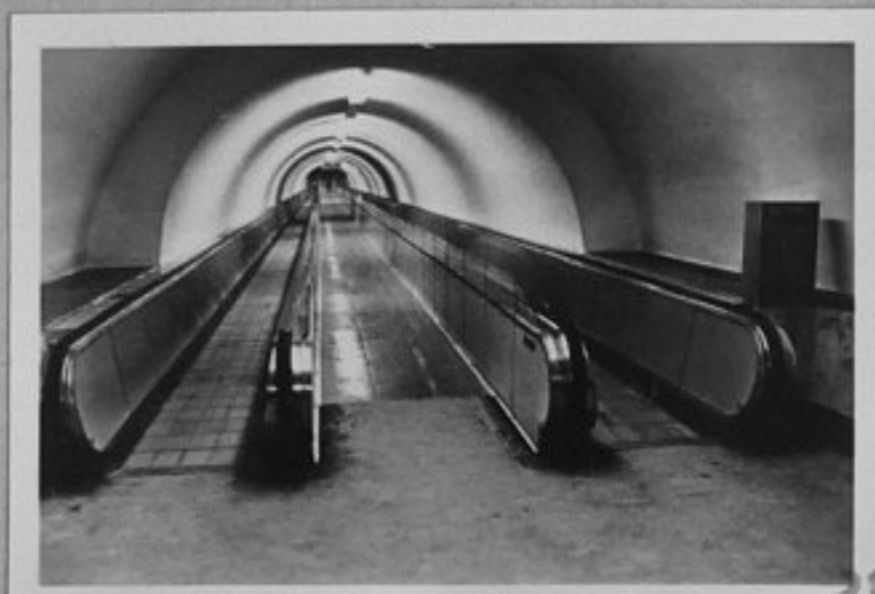
75-1147-23, 24 - "Движещият се тротоар" - конвейър за пешеходци на 120 метров подземен преход от спирка "Самгори" до Кахетинското шосе на метрото в Тбилиси. /репр./, ИК
