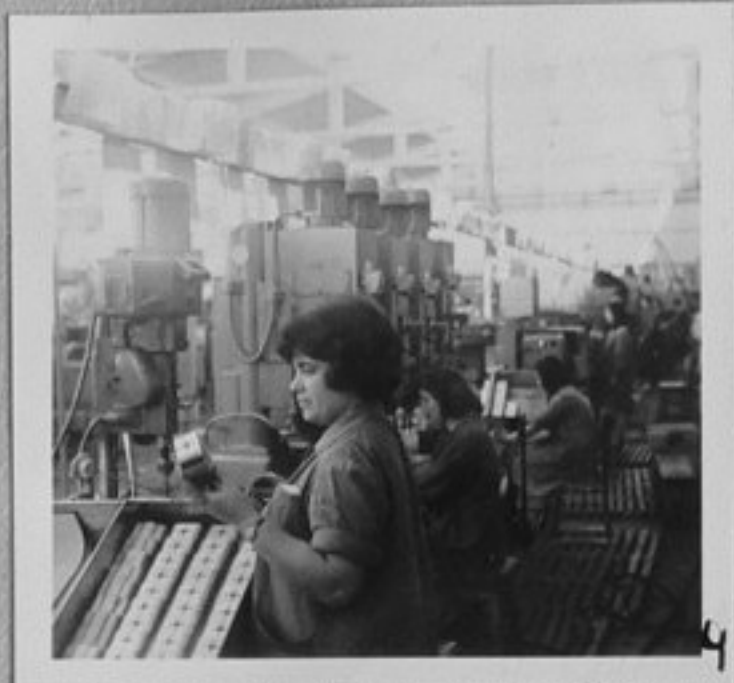
68-1933-3,4,6- На конвейера за производство на тела за зъбни помпи./Крум Арсов/СС
