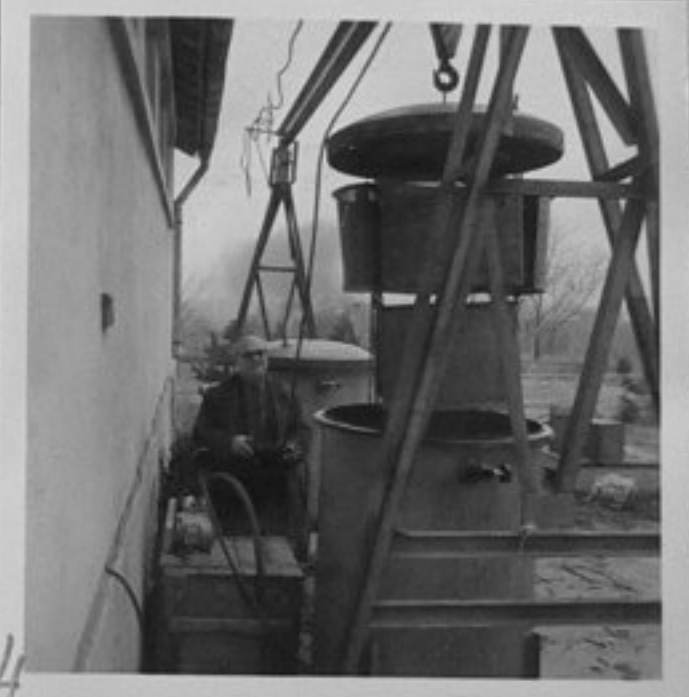
70-1214-3,4-Вакуумна установка за наkisване на калемки и подложки преди облагородяване. /Люб. Чаръкчиев/ XII
