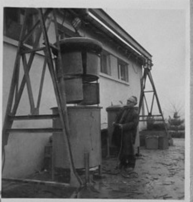
70-1214-3,4-Вакуумна установка за наkisване на калемки и подложки преди облагородяване. /Люб. Чаръкчиев/ XII
