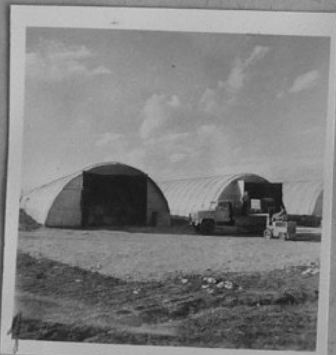
85-99-1-Полимерни складове за съхраняване на картофи и лук в условията на активна вентилация. /Едг.Киров/ЛА
