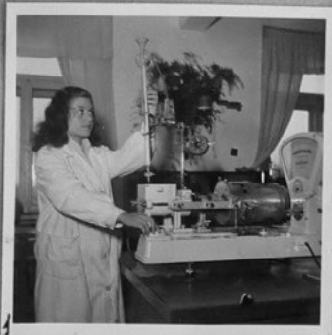
1-Лаборантката С.Пелова определя с фориограф физическите качества на сортовете пшеница.
