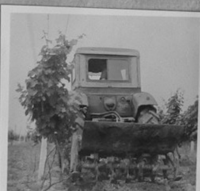
70-2574-7,8-Регулиране работната дълбочина на фреза с трактор "Белорус". /Лало Златков/ ХП
