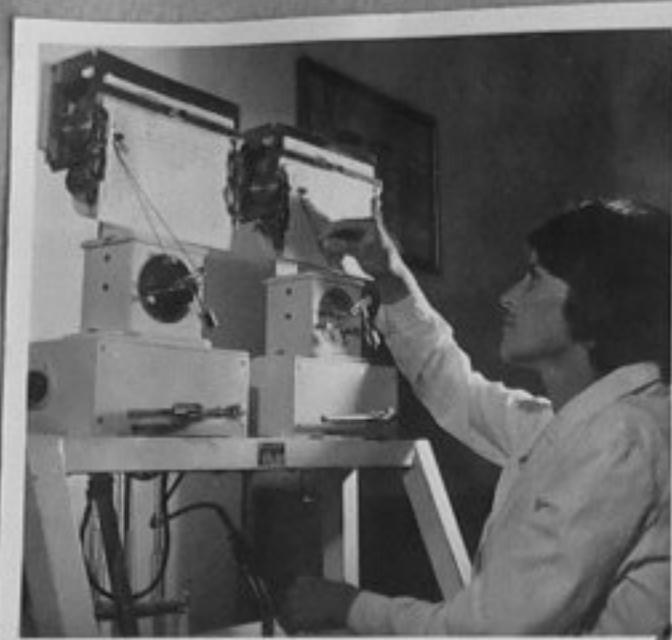
73-3575-11-Лаборантката В.Атанасова определя ферментативната сила на брашното с ферментограф. /В.Иванова/ИК
