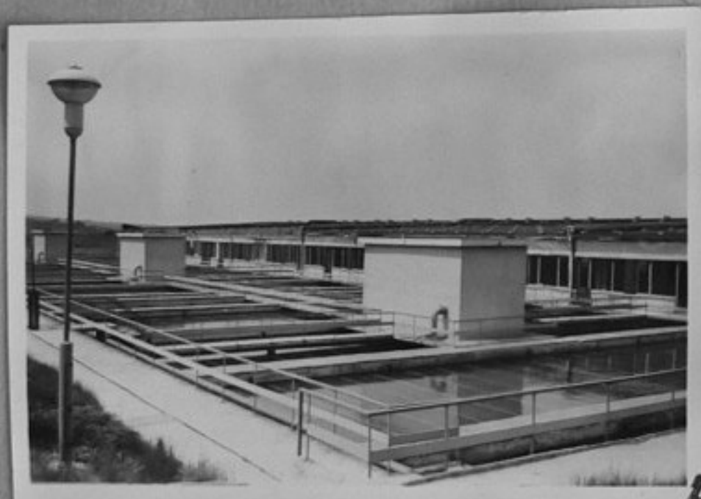
71-2739-2,3-Изглед от станцията.
