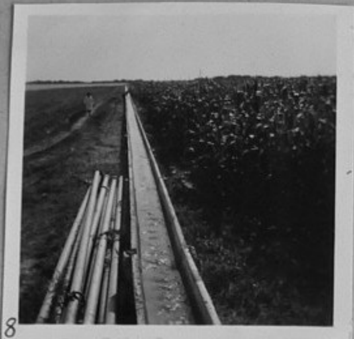
7, 8 - Полутръбен циментов канал.
