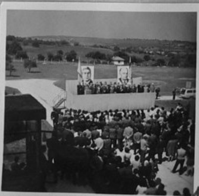
73-2194-1-Тържествено откриване на новата сграда на Фуражния институт в Плевен. Председателят на ОНС в Плевен открива тържеството. /Л.Чаръкчиев/ЕИ
