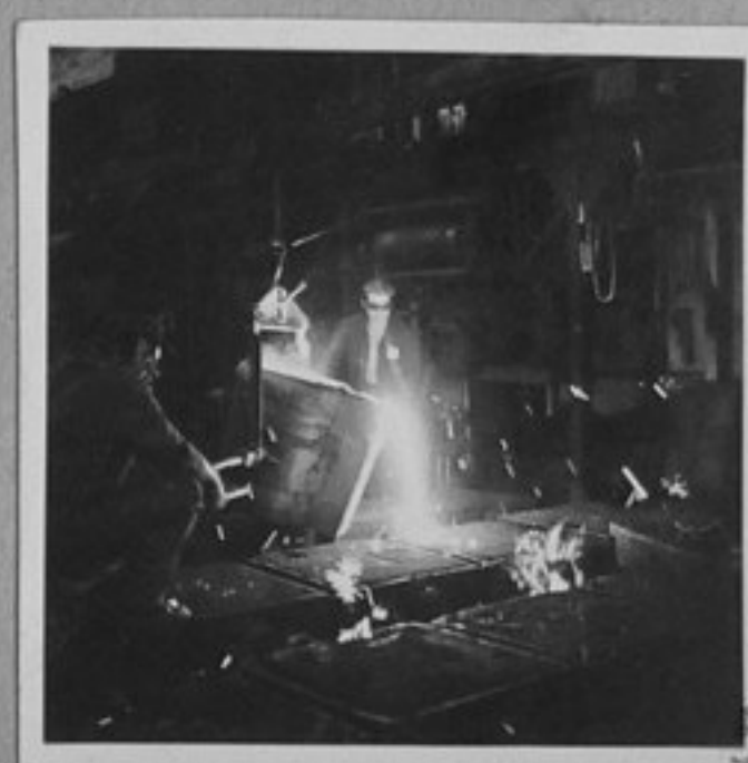
80-3502-5 Изливане метал в лярната - подготовка на детайли за роботи Ем. Богоев/МД
