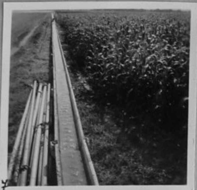
7, 8 - Полутръбен циментов канал.
