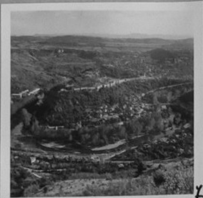
70-4651-7-Изглед от Царевец. /Торос Хорисян/ XII
