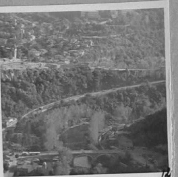
70-4653-12-изглед от Царевец. /Т.Хорисян/ XII
