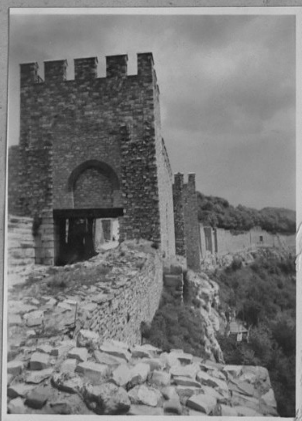
73-1999-6 - Реставрираната средна порта на хълма "Царевец" - Търново. /Торос Хорисян /ТК
