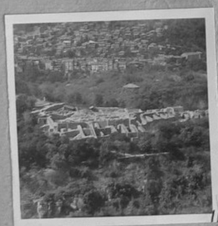
70-4650-11-Изглед от двора на бълг.царе на хълма Царевец. /Т.Хорисян/ ХП
