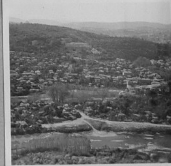
70-4653-1-Изглед от Царевец. /Торос Хорисян/ XII
