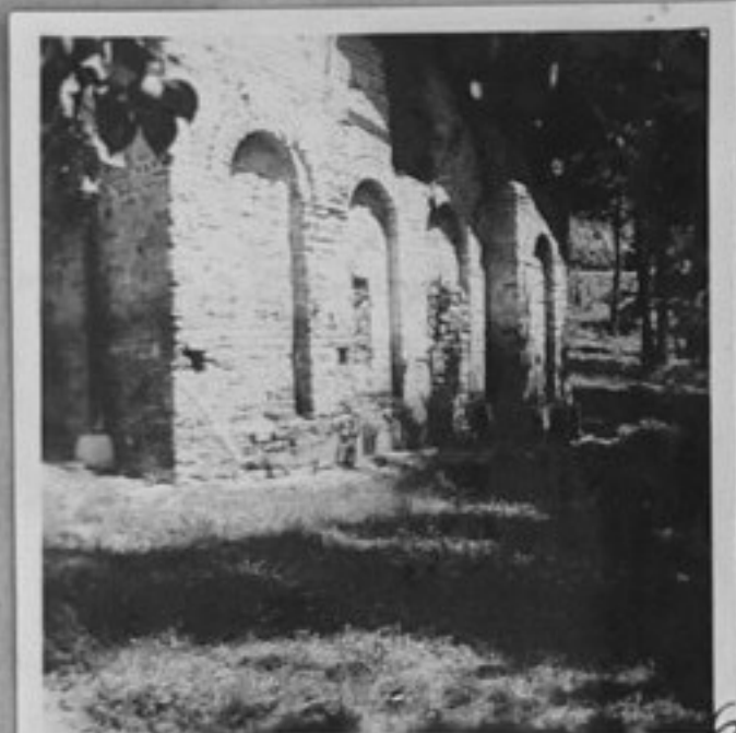
63/2171-6-Западната фасада на църквата "40 мъченика". /Хорисян/ ММ
