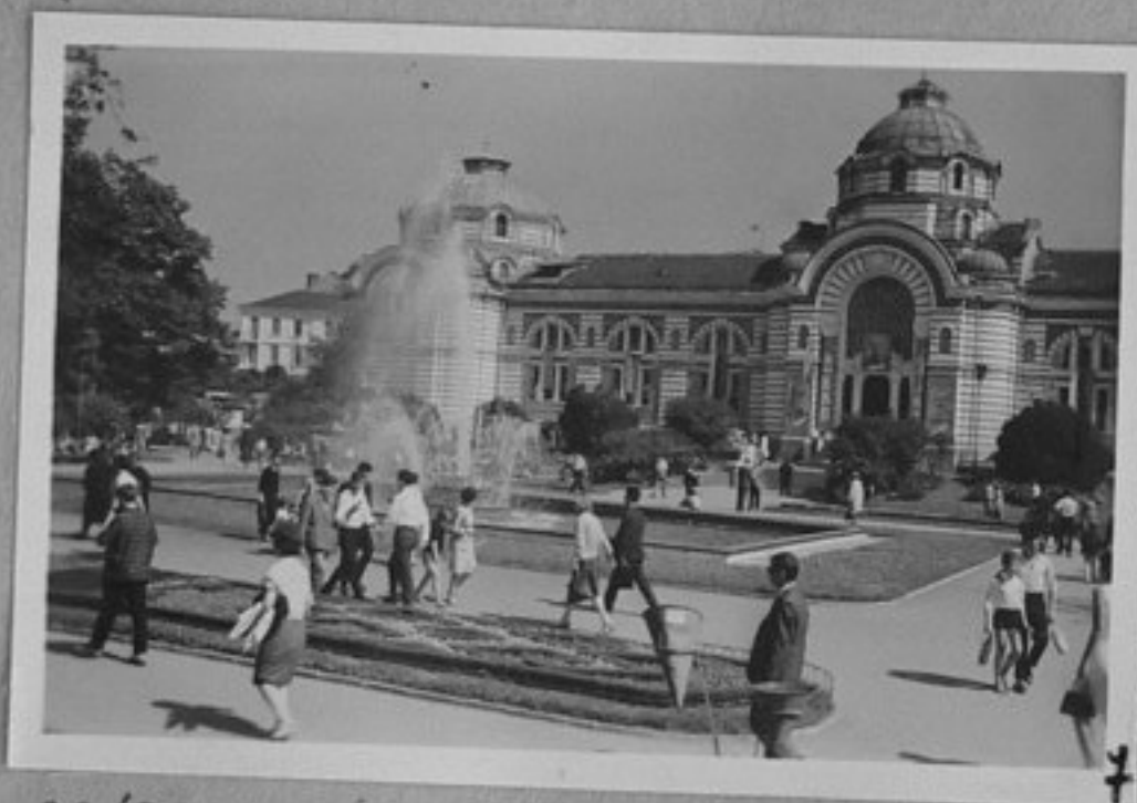
66/2860-7 - Градската баня. /Сигирски/ ЕИ
