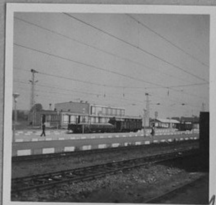
73-3833-1-Новата основно ремонтирана гара "Север". /Р.Марукян/ТК
