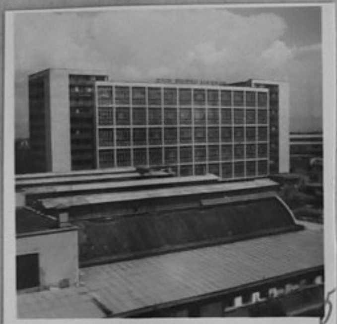
73-3791-5-Сградата на чорапната фабрика "Вълчо Иванов"-София. /Р.Марукян/ТК
