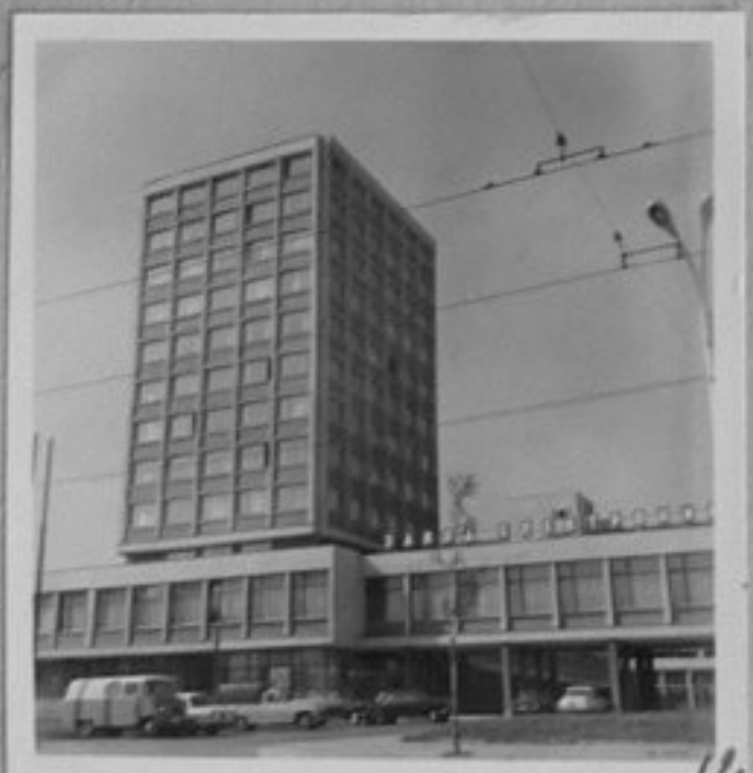
69-2489-12-Външен изглед на завод "Електроника". /В.Иванова/ ИК
