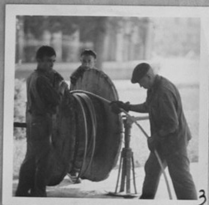
67/2104-3 - Прокарване на телефонна линия. /Борис Юскеселиев/ЕИ
