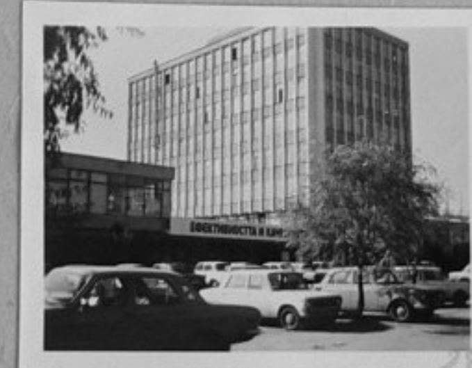
79-4204-28 Заводът за електронни елементи в кв. "Горубляне" Ив. Блъсков/МД
