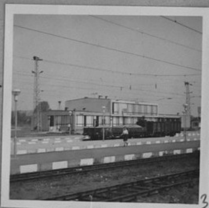
73-3833-3-Новата основно ремонтирана гара "Север". /Р.Марукян/ТК
