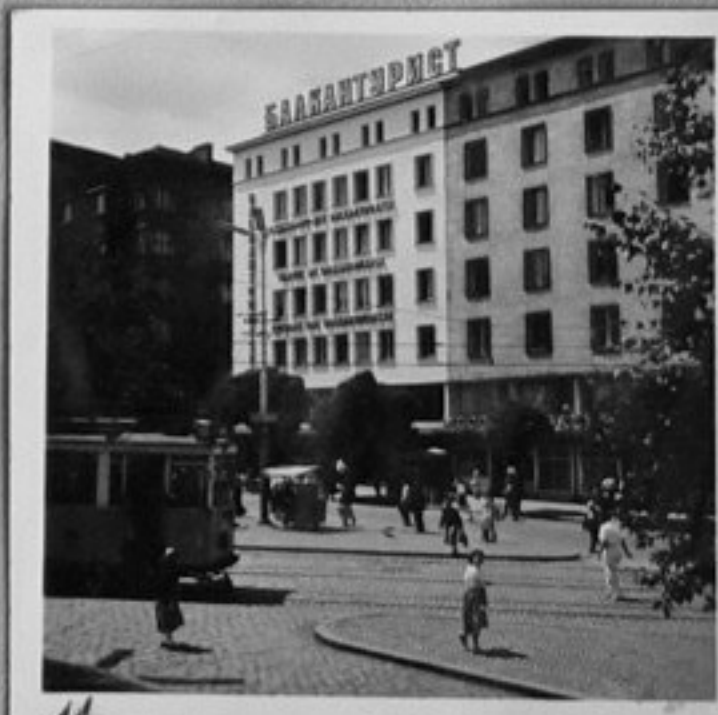
61/2138-11-Новата сграда на Балкантурист на пл. "Ленин". /Попов/
