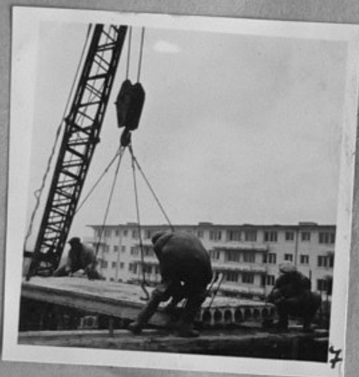
7- Поставяне на монтажни подови елементи на невостроящият се жилищен блок 95.
