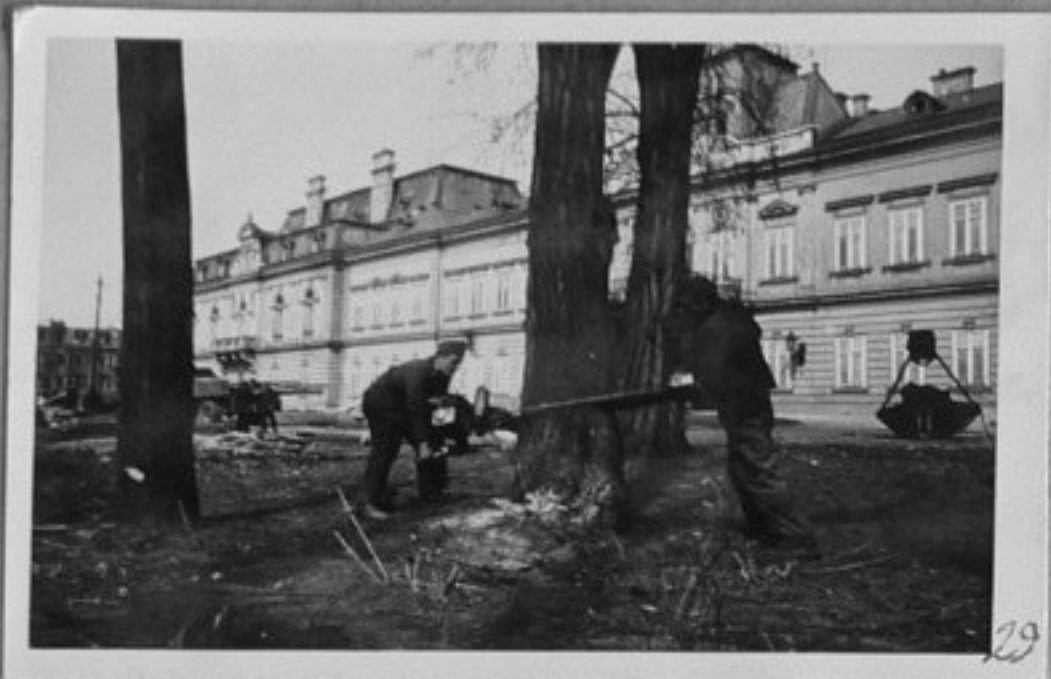
46/95-29 - Момент от събаряне на оградата и караулното помещение на двореца с оглед благоустрояването на площада /Ил. Петров/.
