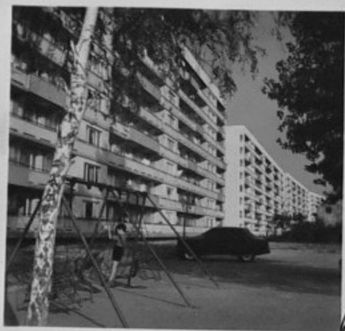
6 - Блокове 11,13,17,19 в жил.комплекс "Красно село"
