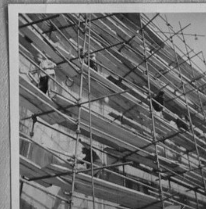
68-1565-9,10-Полагане на бучарда върху западната фасада на строежа на покритата фестивална зала в кв."Гео Милев"./Николай Попов/СС
