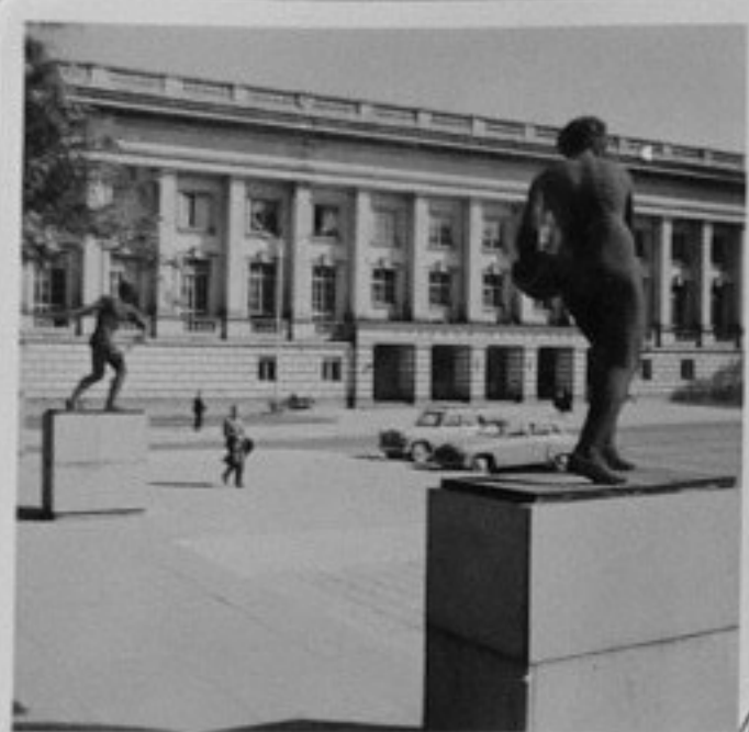
66/1640-1-Фасадата на стадиона. /Божков/ ЕИ
