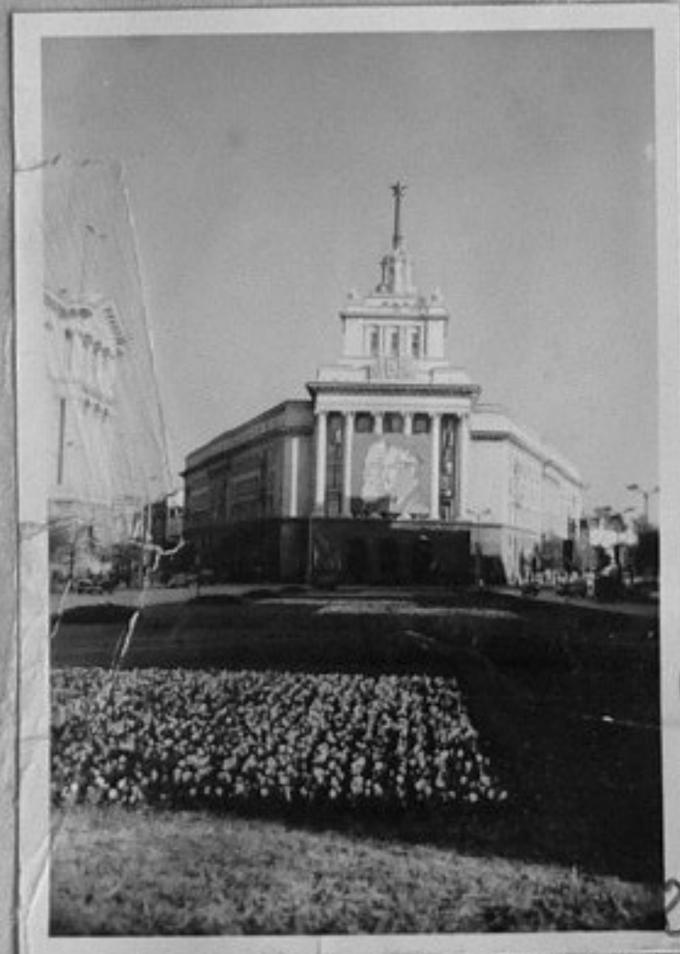
66/3544-2-Сградата на ЦК на БКР. /Сибирски/ ММ
