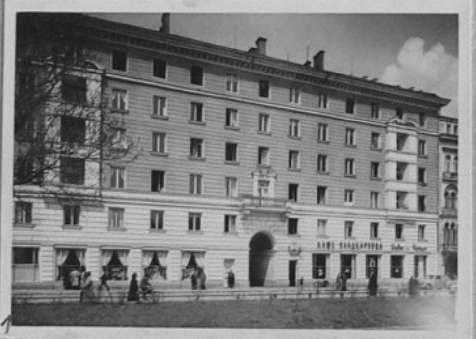
1- Жилищен дом на ул. "Софийска комуна" 8.
