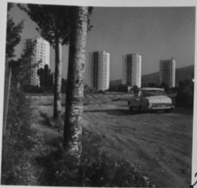
2 - Жил.комплекс "Красно село", високи блокове с пълзящ кофраж.
