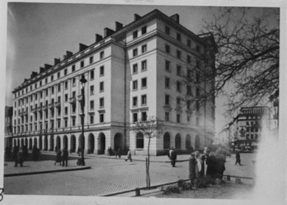
3-Жилищен дом на ъгъла на ул. "Софийска комуна" и "Алабин".
