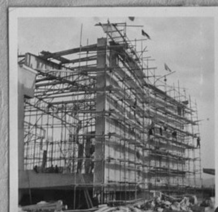
68-1565-9,10-Полагане на бучарда върху западната фасада на строежа на покритата фестивална зала в кв."Гео Милев"./Николай Попов/СС
