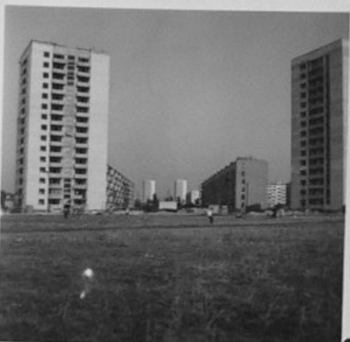
67/3065-12 - Жил.комплекс "Красно село", новостроящи се високи блокове "Емил Марков". /Н.Попов/ЕИ
