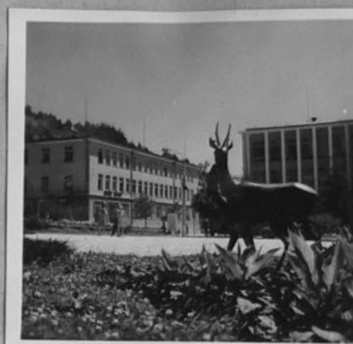
67/2669-3 - Новоремонтираната сграда на пощата в Смолян. /Торос Хорисян/ЕИ
