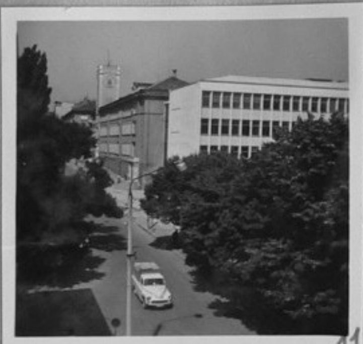
69-2621-11-Външна снимка на ОТП. станция. /Н.Чобанов/ИК
