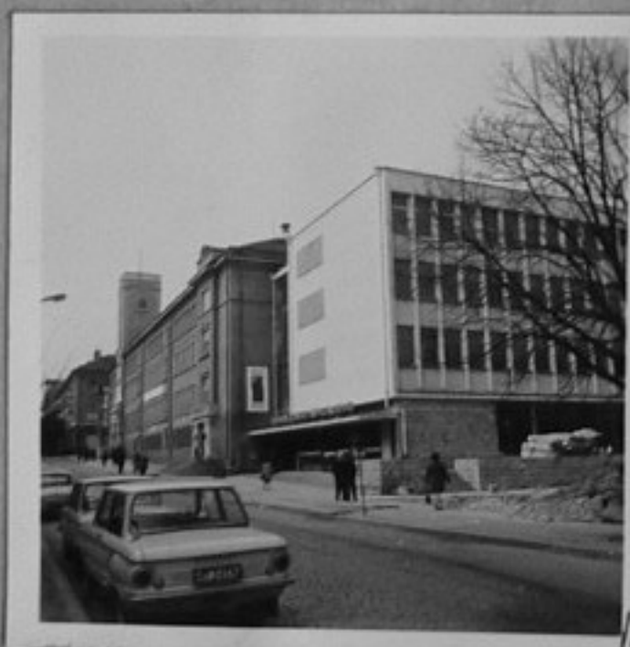
73-947-10-Окръжна станция на съобщенията в града. /Н.Чобанов/МК
