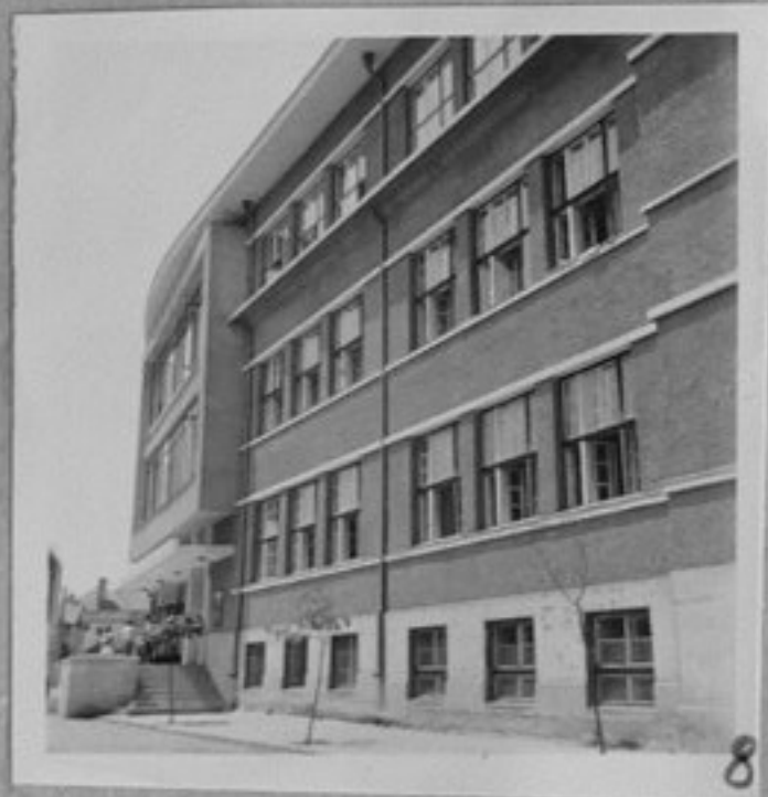
69-2001-8-Фасадата на учителския институт.
