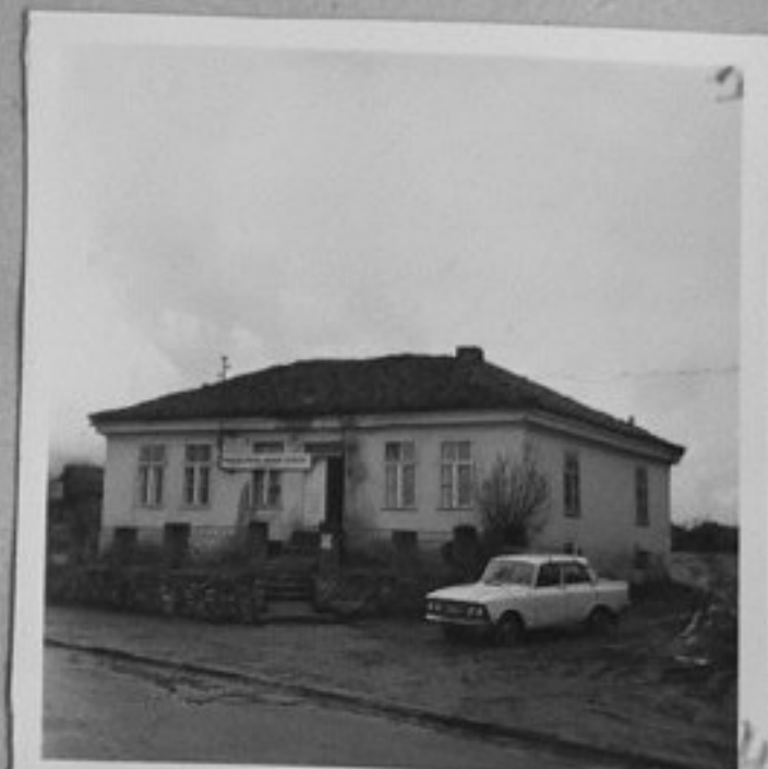
79-1038-4-Сградата на СП Благоустройство и комунал- но строителство в кв.Пир- доп.
