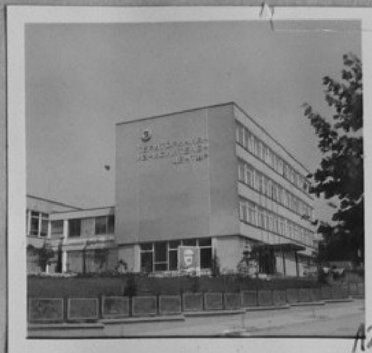
72-3674-12-Изглед от сградата на Териториалния изчислителен център в града. /Н.Чобанов/МК
