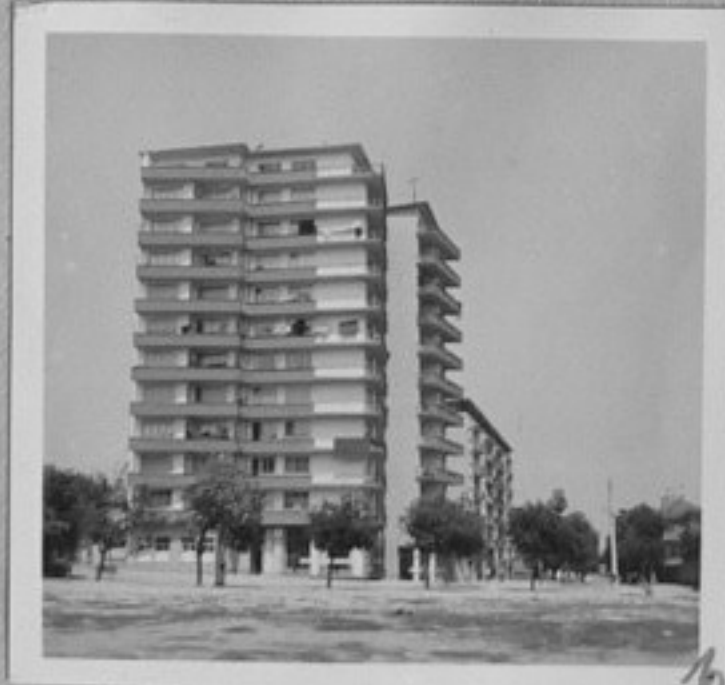
69-2623-10-Блокът на ул. "Августин Траяна".
