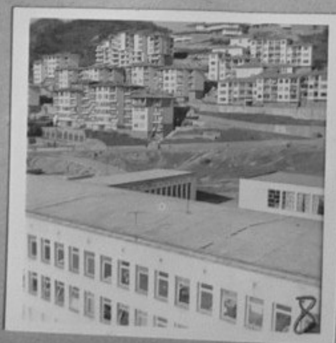
81-3576-5,8-Из строежа на новия център на град Смолян. Т.Симеонов/ЛШ
