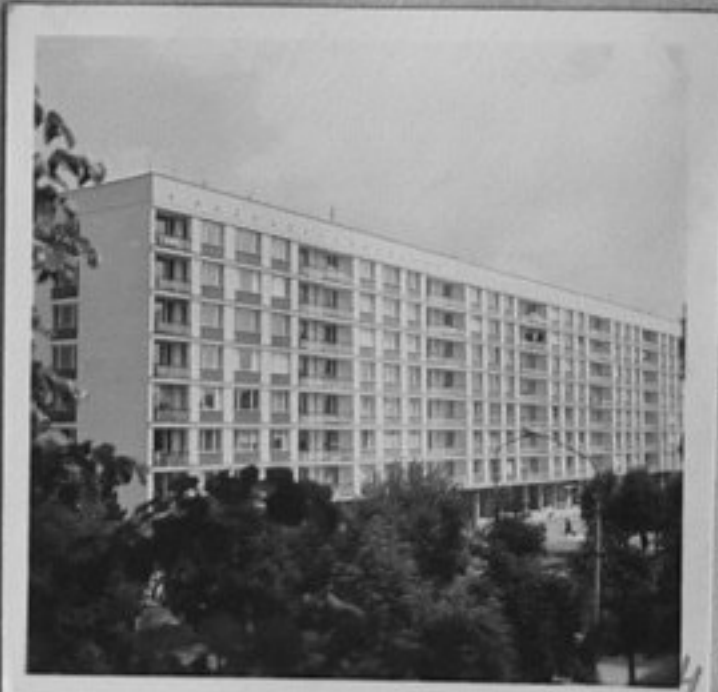
73-2081-4-Нови жилищни бло- кове в жилищен комплекс "Възраждане". /В.Иванова/ ИК
