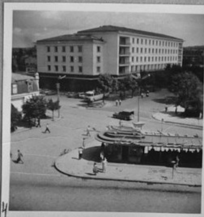
61/2191-4-Новопостроеният гранд хотел "Балкантурист". /Чаръкчиев/
