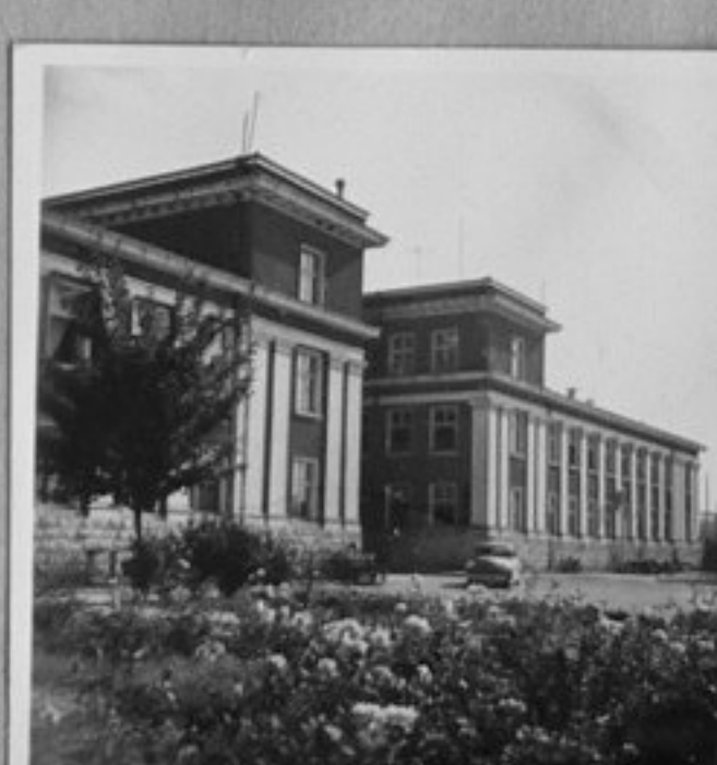
62/2241-11-Фасадата на завода за антибиотици. /Парушев/ ММ
