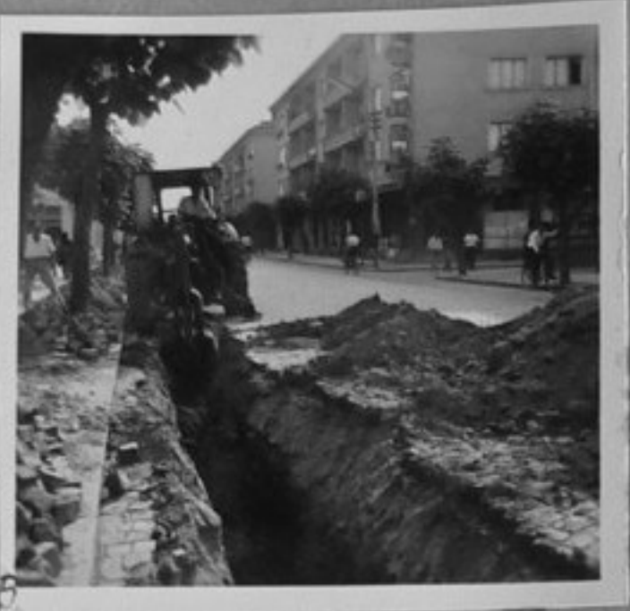
5-Проклаване на из- копи за канализацията на града.
