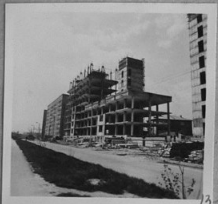
73-1938-13-Ново жилищно стро- ителство в кв. "В. Левски". /Е. Богоев/МК
