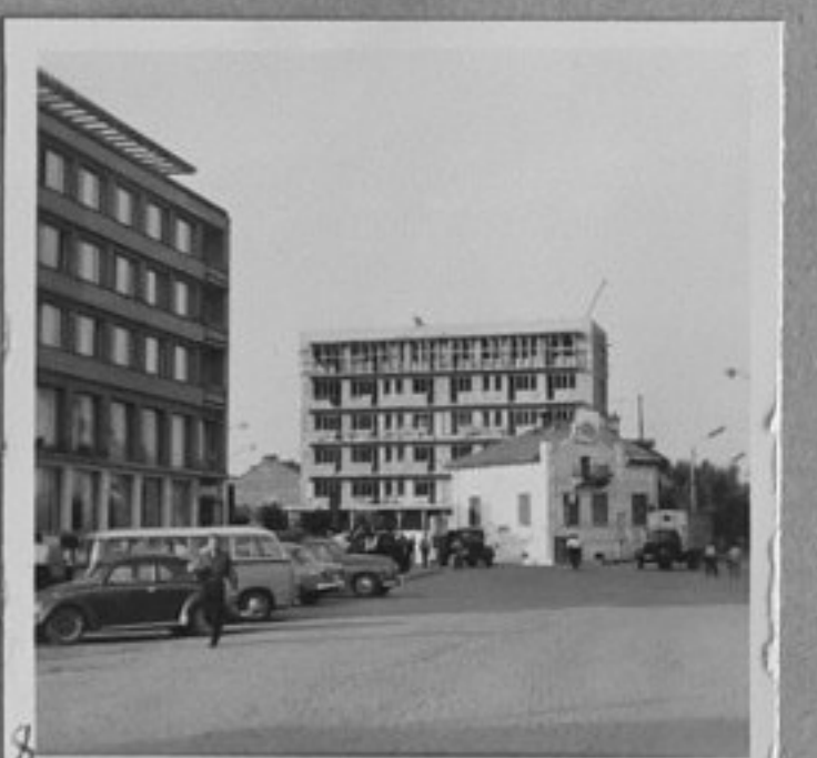
8,9 - Нов блок в строеж на Червения площад.
