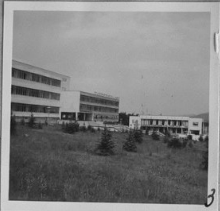
73-3019-3Общи изгледи на заводските корпуси. /Н.Хлебарова/ТК
