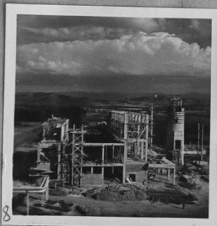
8- Новостроящия се акумулаторен завод. На снимката - акумулаторния и ре- монтния цех.
