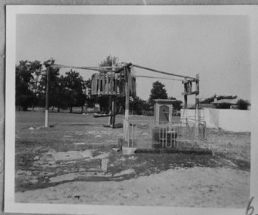
73-3146-6-Старо и ново водоснабдяване на Добруджа с. Соколово. /Н.Чобанов/ТК
