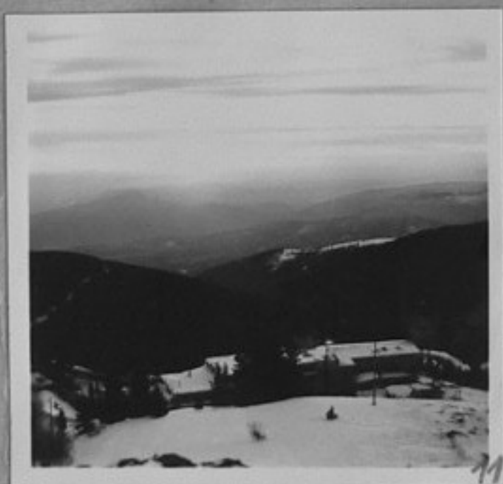
70-549-11-Новостроящата се хижа в района на Алеко. /Р.Марукян/ ИК
