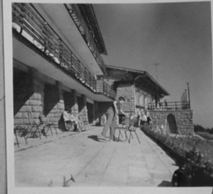
69-3113-17-Външен вид на поч.станция на завод "В.Коларов" - София. /М.Върбанов/ XII
