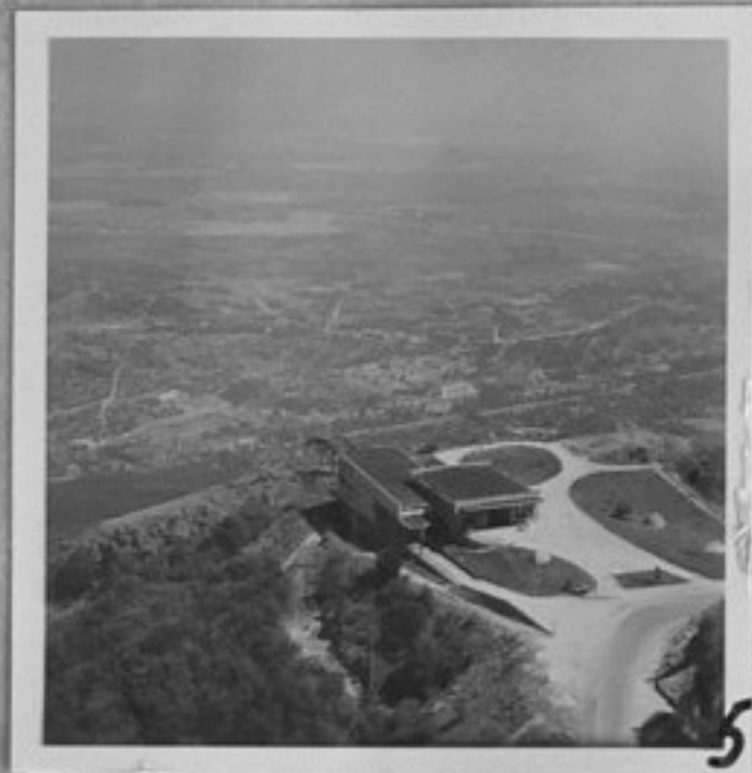
67-2484-5-Горната лифт-станция на "Копитото". /Борис Юскеселиев/СС
