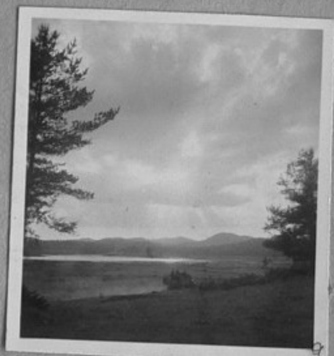
9 - Новостроящият се язовир "Широка поляна", който вли - за в системата на хидро-възела "Баташкия водосилов път".
