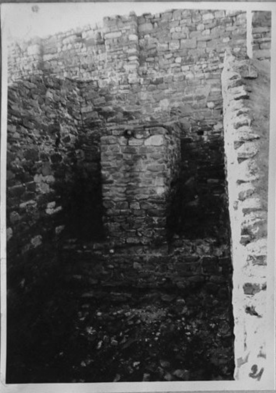
69-469621-Помещение 2 на сграда №2- Царевец. Т.Хорисян/АШ
