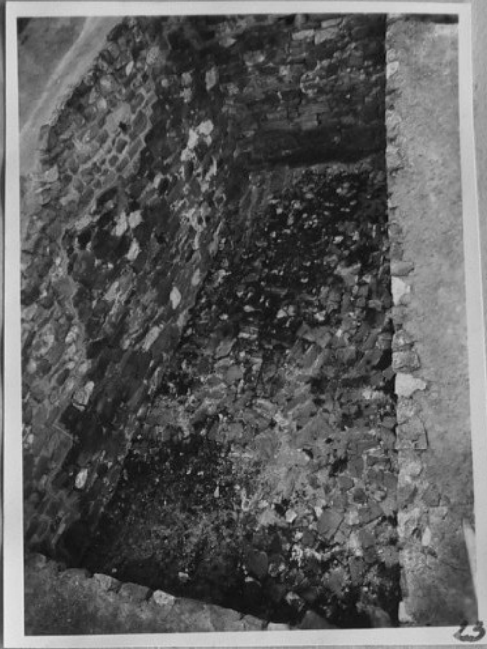
69-4696-23-Помещение № 1 на сграда № 2 и подовата му настилка. Т.Хорисян/АШ
