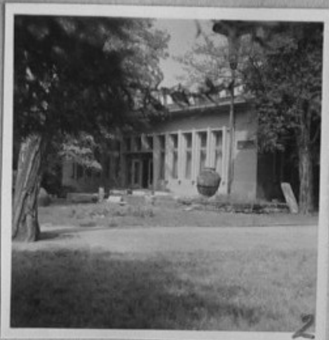
75-1822-2-Сградата на Окръжния исторически музей. /Р.Марукян/ТК
