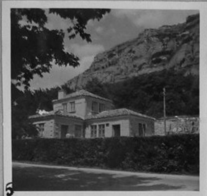
62-2140-5 - Външен изглед. /Томов/ЕИ
