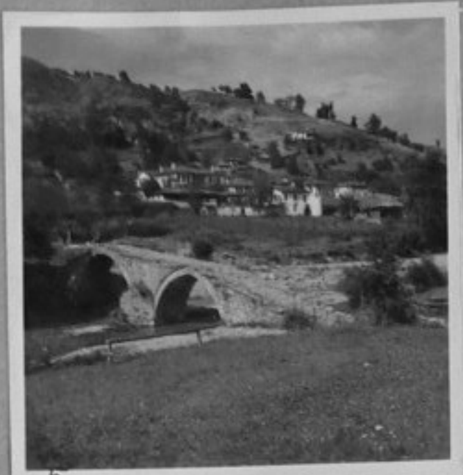
5-Общ изглед на конака на Агушеви със стария каменен мост.
