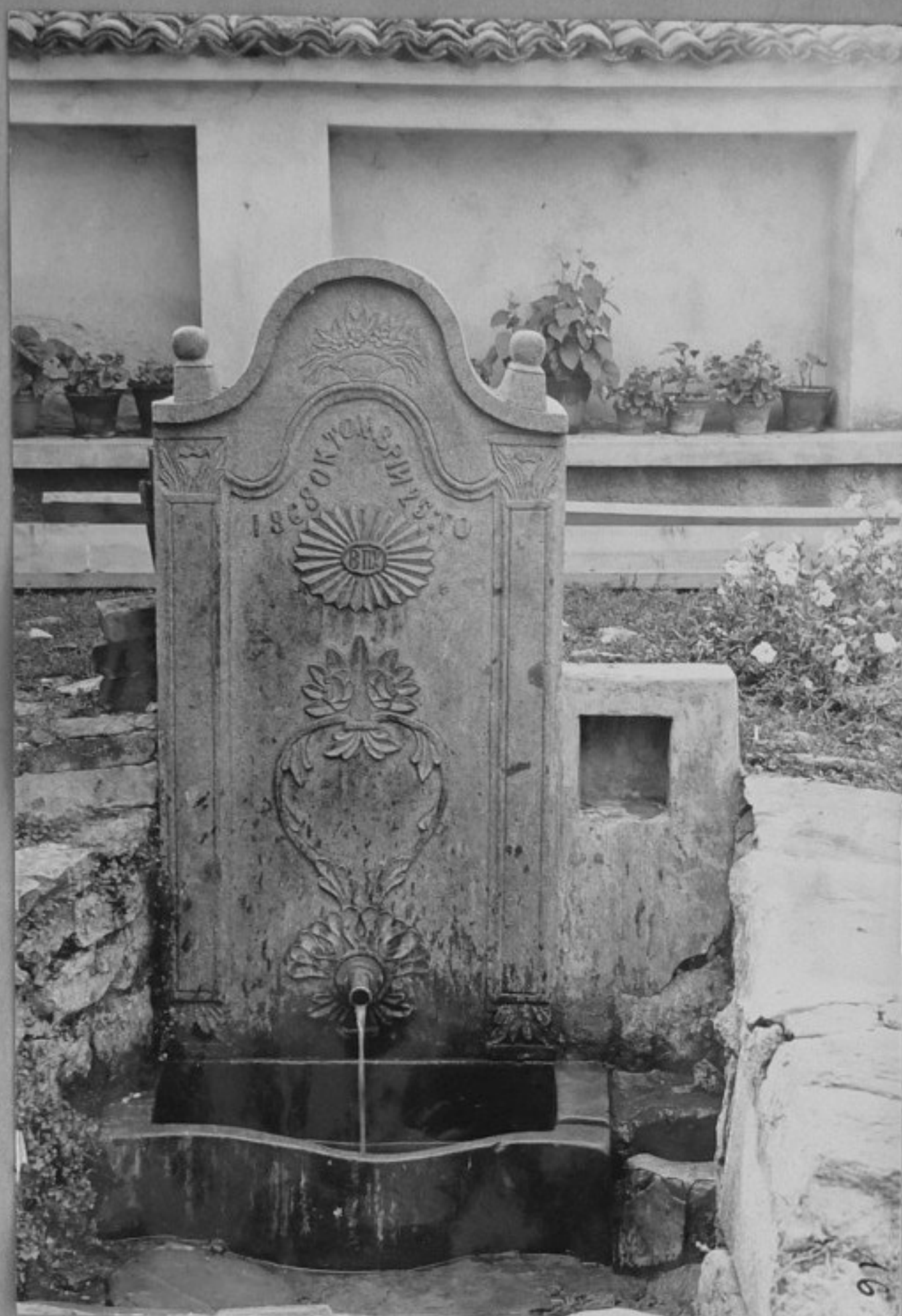
54/2830-16- Стара каменна чешма с елемент на кобилица, поставена ниско от нивото на терена. Чешмата Кучи
