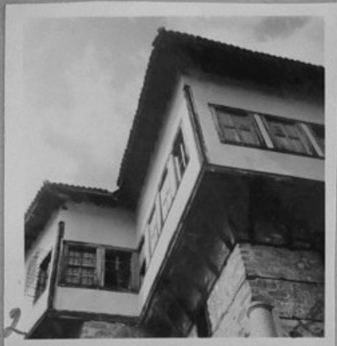
81-1582-2-Характерно оформление на конзоли на еркер от мелнишка къща. /Т. Хорисян/ЛА
