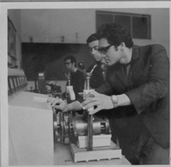
70-1695-3-Изпитване на правотоков генератор за товарни автомобили в лабораторията по електроуредба на трактори и на автомобили. /Д.Рогев/ ИК
