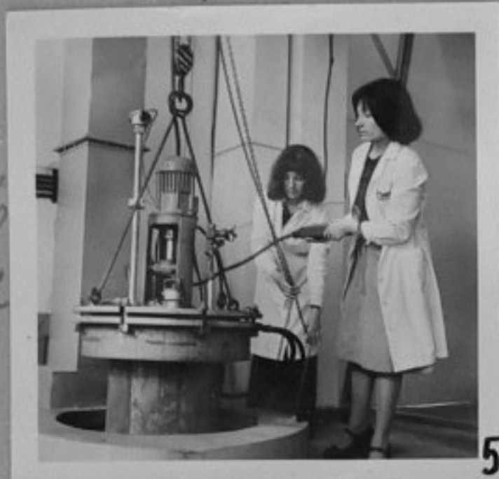
76-1660-5,7-Лаборатория за химико-термично обработване на металите - цех за нискотемпературно газово карбонитриране. /Р.Парушев/МК
