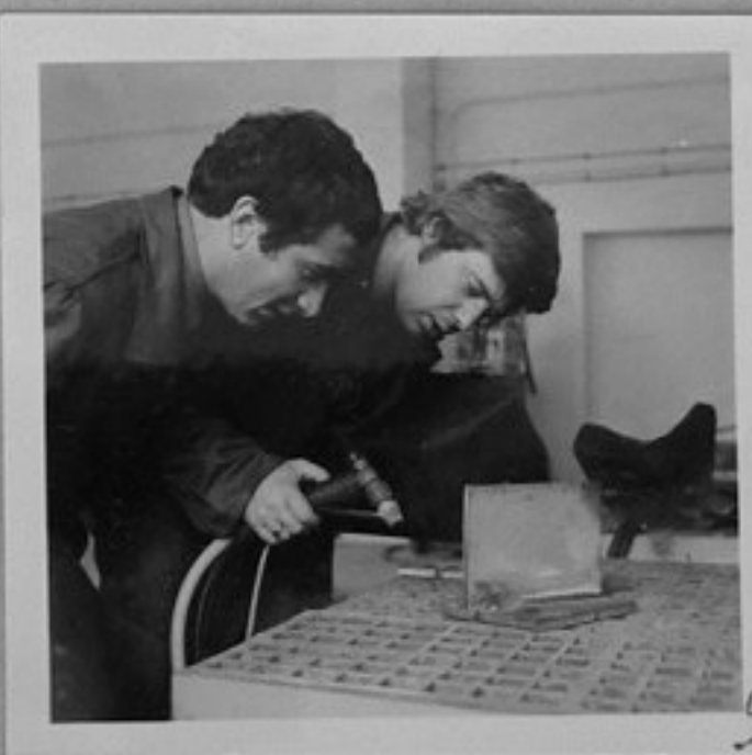
76-1665-8,9-Подготвителни работи за изпитателен басейн за подводно рязане и заваряване-плазмено заваряване на алуминий. /Р.Парушев/МК
