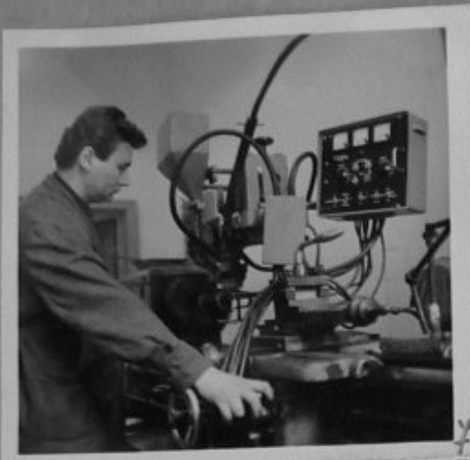
70-1696-7-Установка за автоматично наваряване подслои от флюс на авторемонтни детайли с лентови електроди запълнени с шихта /легиращи елементи/. /Д.Рогев/ ИК
