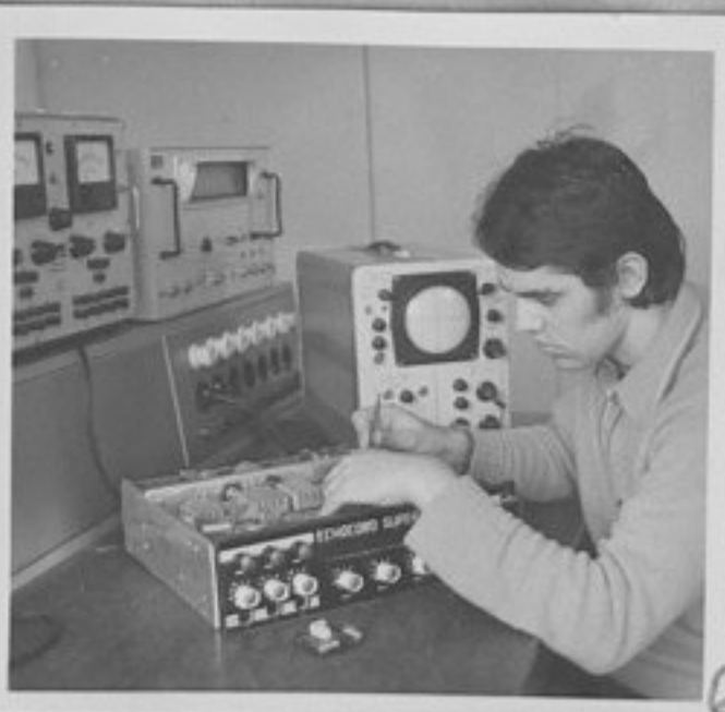
70-1072-6-Кръжочникът от секция "нискочестотни усилватели" П. Костов монтира печатна платка на транзисторен усилвател. /Д.Стаматова/ XII
