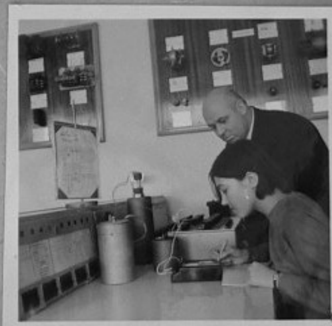
71-681-9-Студентката Ст. Козарева измерва температура с компенсатор. /Д.Стаматова/ ИК
