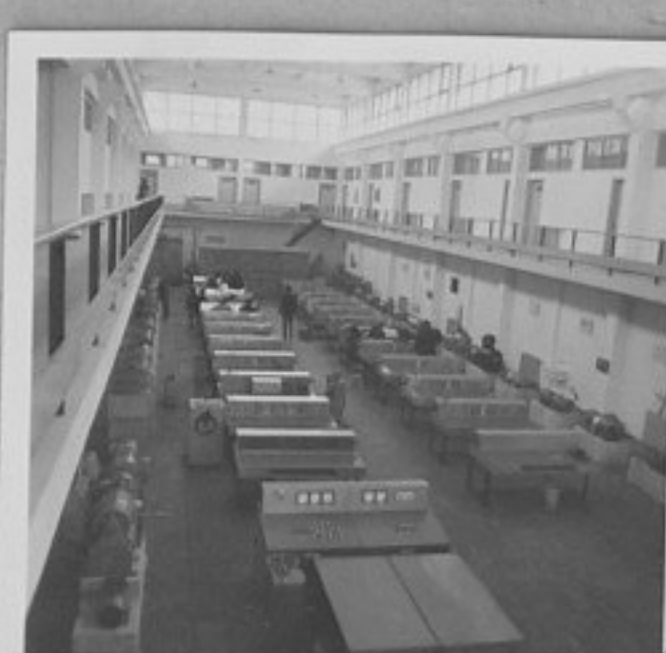
70-1072-8-Халето по електрически машини на ВМЕИ. /Д.Стаматова/ XII
