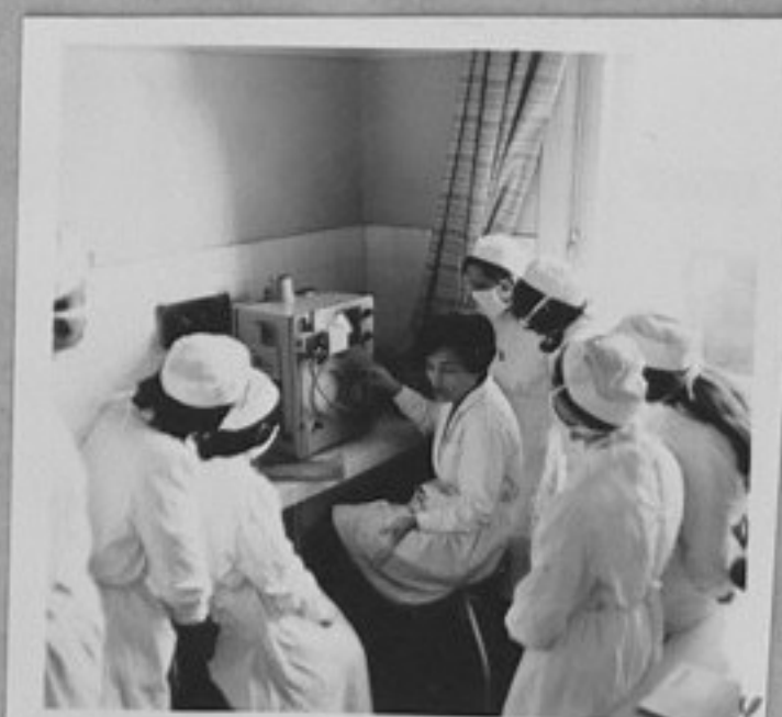
72-5544-6,7-Отчитане на калий и натрий в серум на пламъчен фотометър с ръководител д-р Бакалова по време на лекции със студенти от ВМИ - Пловдив. /Н.Чобанов/ИК
