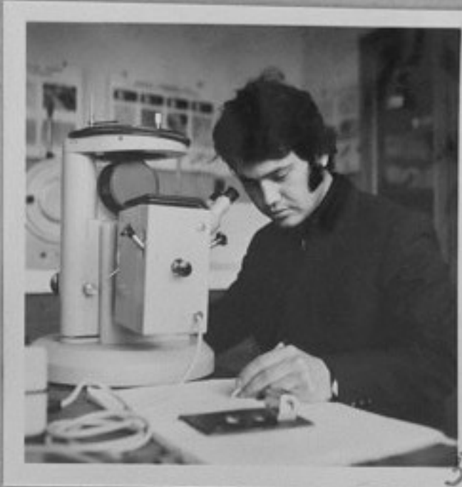
73-2076-4,5-Дипломантът Х.Тонков изследва карбидна нееднородност на стомана Р-18 във връзка с дипломната си работа. /В.Иванова/МК
