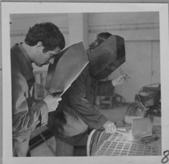
76-1665-8,9-Подготвителни работи за изпитателен басейн за подводно рязане и заваряване-плазмено заваряване на алуминий. /Р.Парушев/МК
