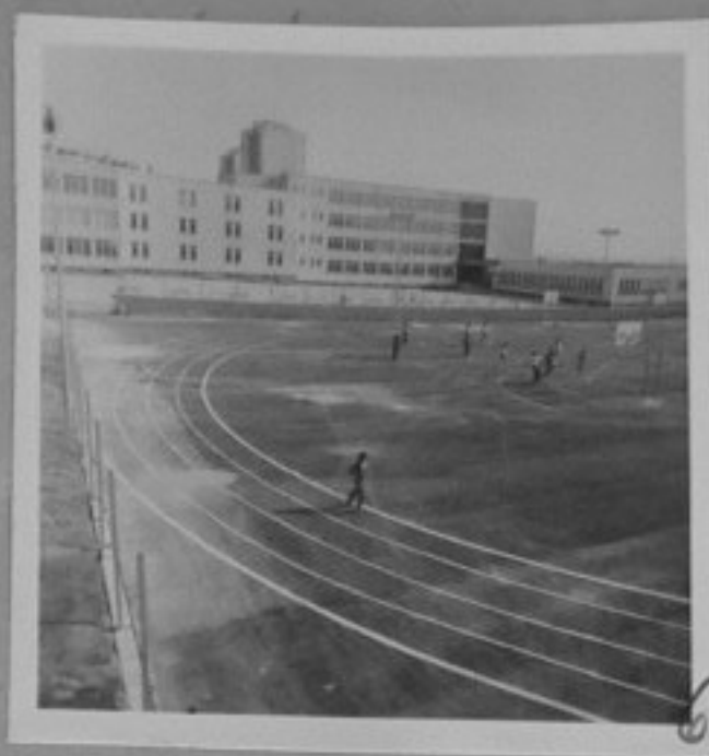
85-574-6-Външен изглед на института "Д.Благоев"-Ямбол. В.Балевска/ЛА
