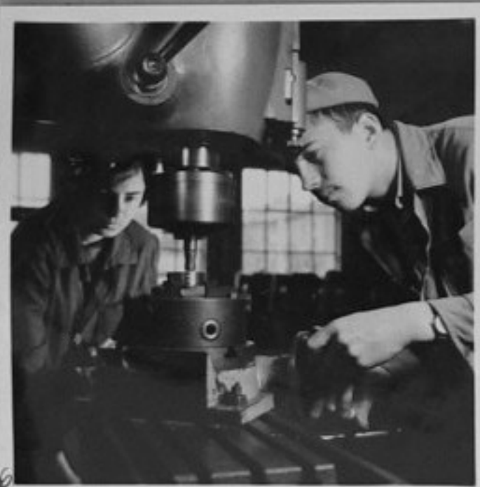
66/3492 - Техникум по механотехника - Плевен. 6' - Ал.Йовчев и Роза Чанева от 3-ти курс,изработват зъбна муфа за струг С-8 на вертикална фрез-машина. 11 - Формовачен цех. Изливане на форми. /Чаръкчиев/ЕИ
