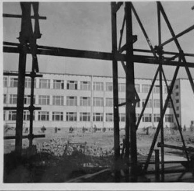
70-220-9-Сградата на учебния корпус на тех- никума. /Д.Стаматова/ ИК
