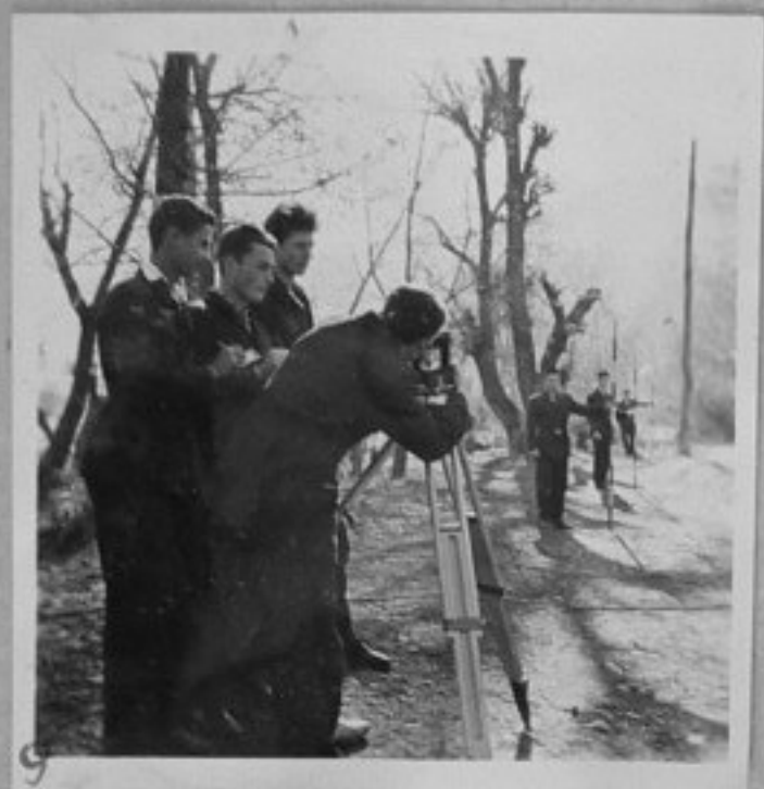
59/681 - Горски техникум "Сава Младенов", Тетевен. /Чаръкчиев/ЕИ 9 - Трасиране на права с "теодолит". 10,11 - В час по физкултура.
