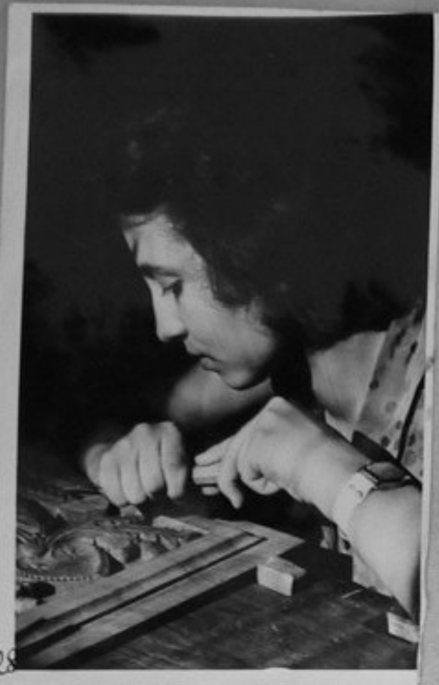
57/3964-28 - Техникум по дървообработване и вътрешна архитектура, Трявна. Ученицката Минка Нинова от III курс прави резба на табла за шкаф. /ЕИ
