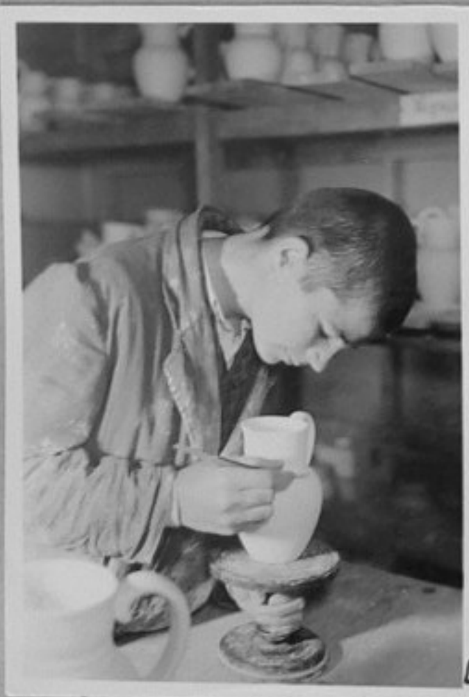
56/1018-4 - Техникум по керамика и стъкло. Почистване след отливането. /Страхинов/ ЕИ
