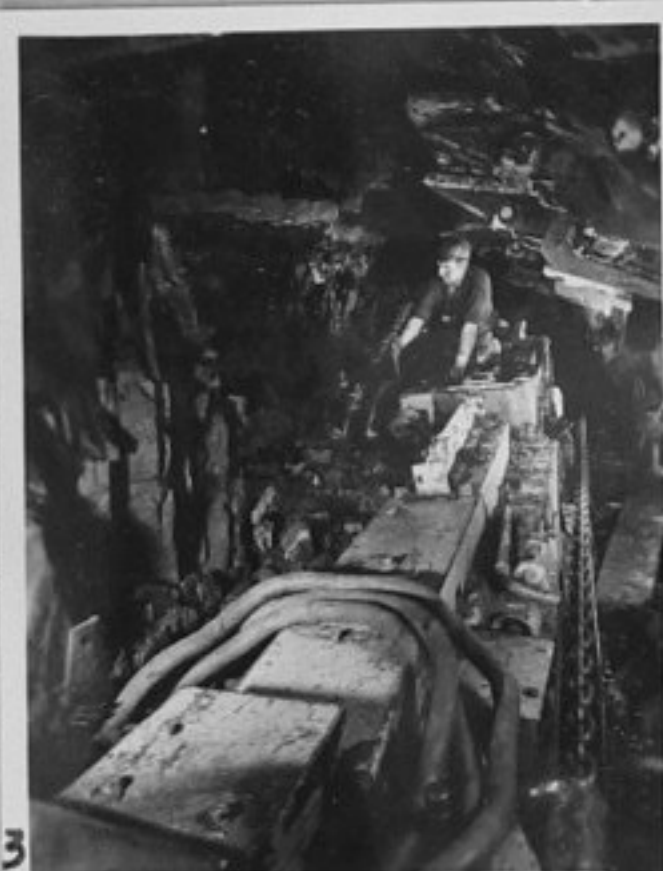
3 - Текущ ремонт на въгледобивния комплекс.
