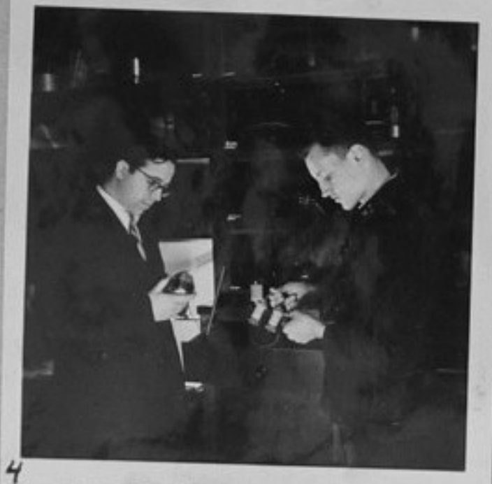
59/580 - Техникум по механотехника - Плевен. /Чаръкчиев/ЕИ 1 - Учителят по физика Христо Петров подготвя експеримент за лекция по румкорфова спирала.
