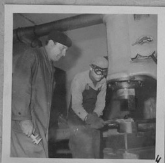
Ученици от Механотехникума в Сливен. 68-4630-4-Изковаване на механичен чук стоманена част.
