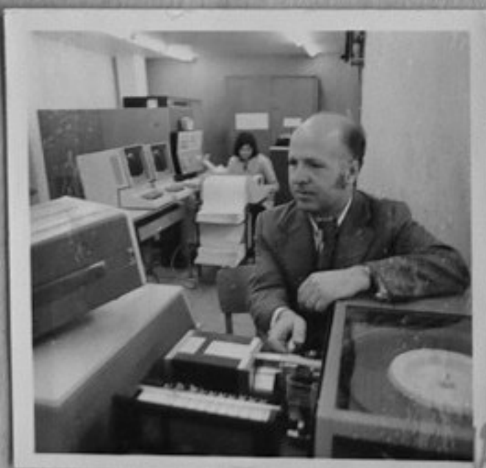
75-1333-12,13-Инж. Живко Паскалев прави настройка на плаващи магнитни ленти с помоща на контролен пункт ЕС-А 527. /Б.Юскеселиев/ТК
