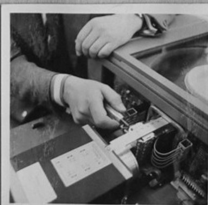
75-1333-12,13-Инж. Живко Паскалев прави настройка на плаващи магнитни ленти с помоща на контролен пункт ЕС-А 527. /Б.Юскеселиев/ТК
