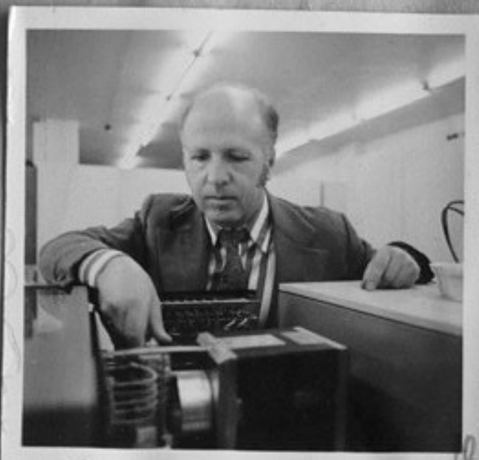
75-1334-3,10,11-Инж. Живко Паскалев прави настройка на плаващи магнитни глави с помощта на контролен дисков пакет. /Б. Юскеселиев/ТК
