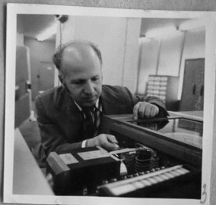
75-1334-3,10,11-Инж. Живко Паскалев прави настройка на плаващи магнитни глави с помощта на контролен дисков пакет. /Б. Юскеселиев/ТК
