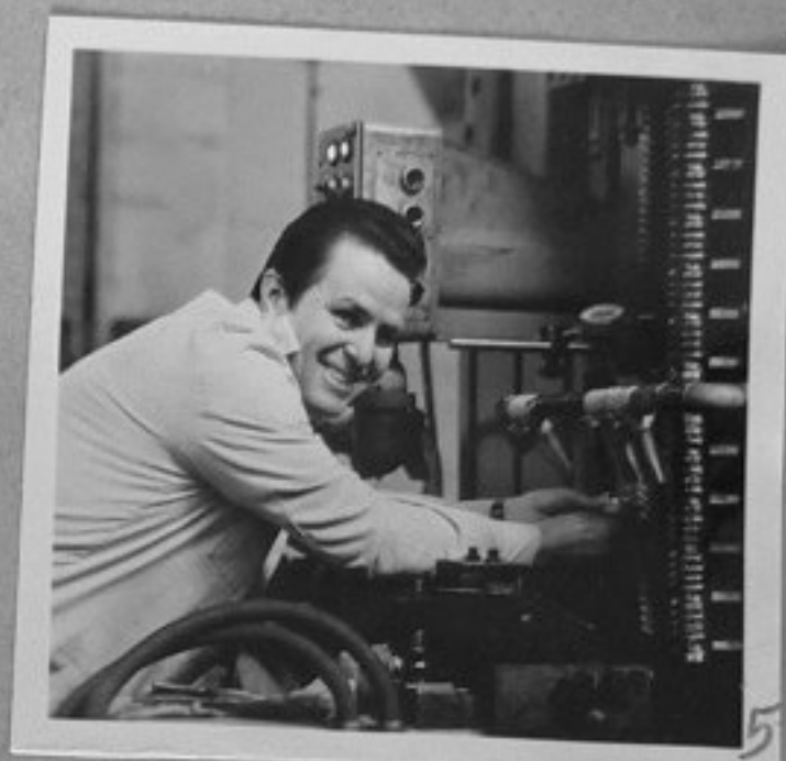
76-684-2,3,5-Петър Брайков - герой на социалистическия труд, работи на съветската протяжна машина за обработване биелите на двигатели "Перкинс" /Завод за дизелови двигатели "В. Коларов"-Варна/. /Р. Парушев/ИК
