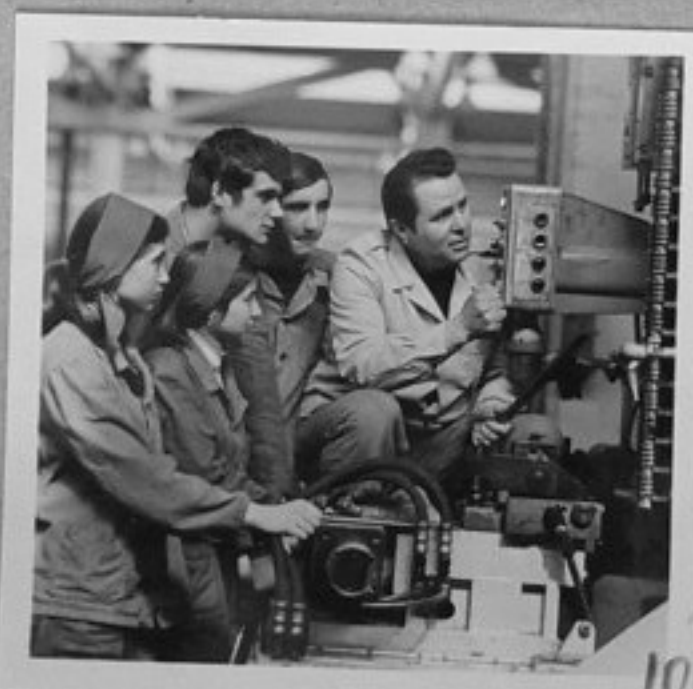
76-684-6-П. Брайков по време на работа на съветската протяжна машина за обработване биелите на двигатели "Перкинс". /Р. Парушев/ИК
