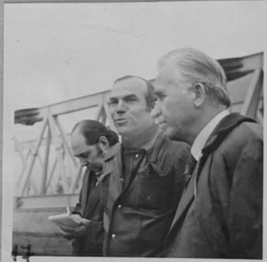
78-3090-17-Главният инженер на "Мосстрой" Анчо Веселинов, отговарящ за строителството на виадуктите "Йорданкино" и "Поток". /П.Цонев/АШ
