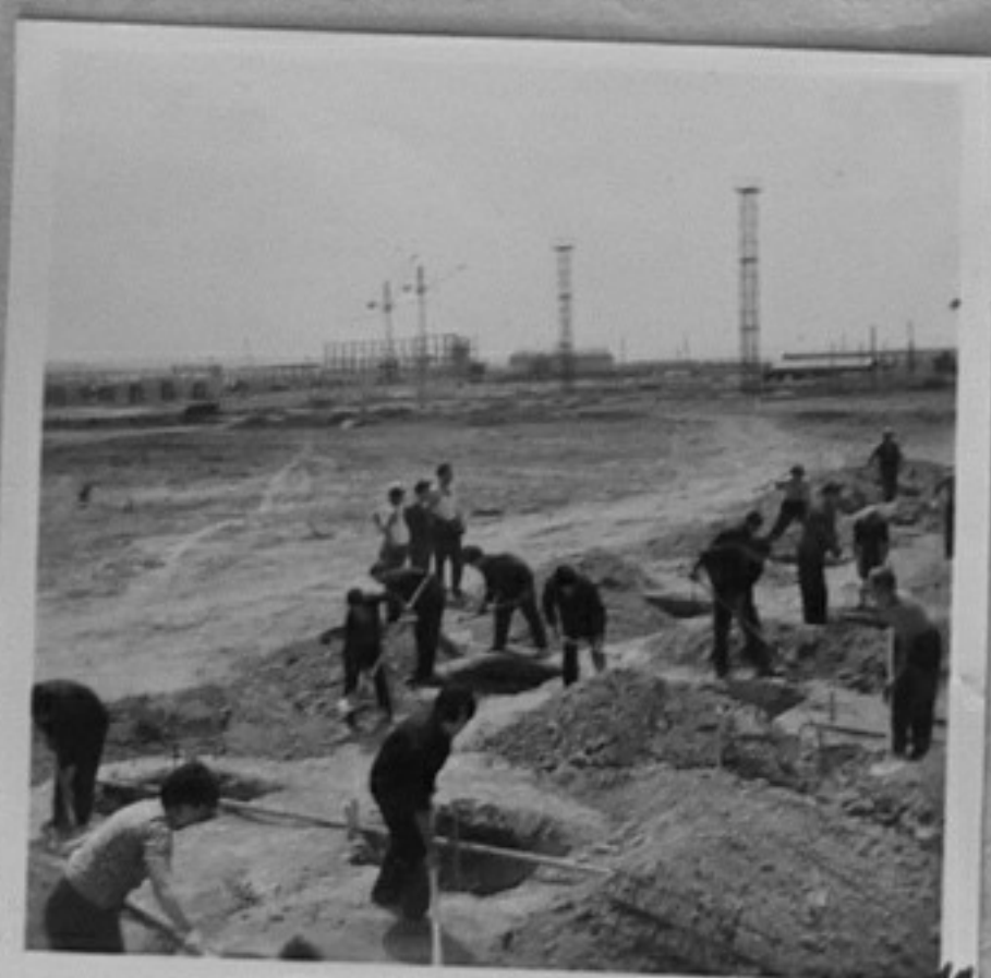
68-3641-10, 13-Комсомолска бригада край с. Ясен, Плевенско, подготвя изкопи за пускане на тръбопроводи за нефт. /Любомир Чаръкчиев/СС
