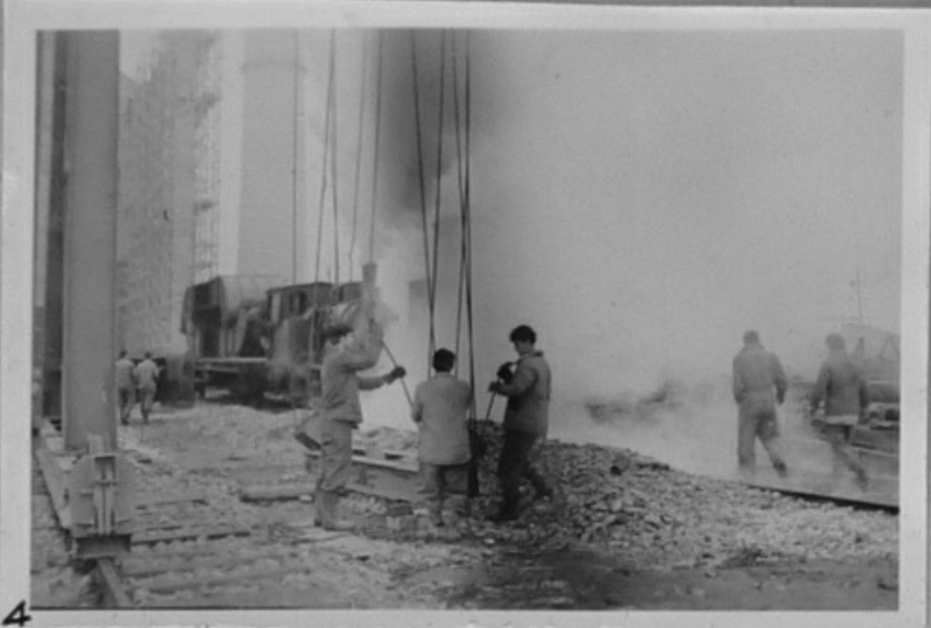
59/3450-4-Комсомолската бригада на Г. Динев монтира портален кран за котелния цех на ТЕЦ „Марица-Изток“. /Страхинов/ ММ
