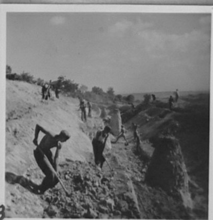
58/3067-3-Изкоп на плават. канал от мл. строит. бригада на ГК на ДСНМ в Плевен. /Караджанов/ ММ
