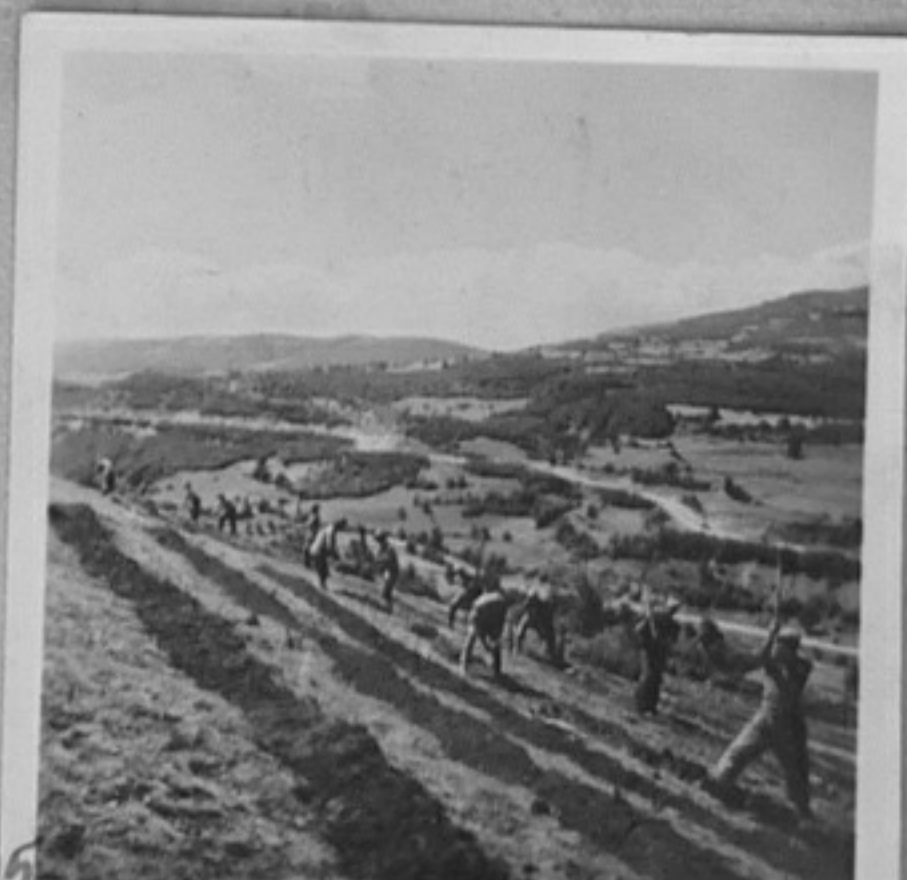
58/2994-5-Скр. мл. бригада "Л. Баръмов" извършва под- готв. работа за започва- ване край с. Насарел, Софийско. /Караджов/ ММ
