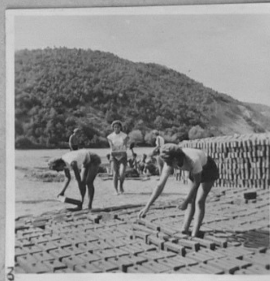
59/2171-3-Средношколска бри- гада извършва подготовителна работа за строеж на язовир "Тракиец". /Карекиян/ ММ
