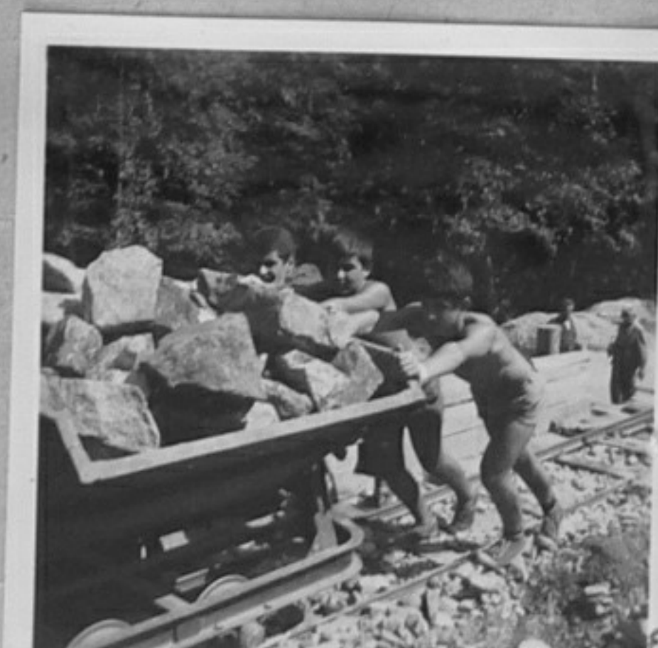
67-2809-8- Бригадири от Ямболски отряд прекарват камъни с вагонетки до каменострошачката за чакъл, пътя Белово-Юндола. /Крум Арсов/СС
