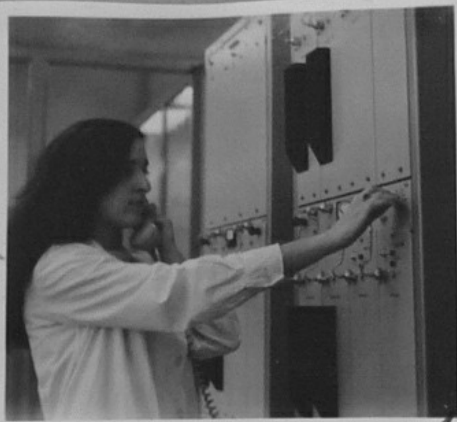
74-1239-12-Настройчика Райна Накова проверява служебен канал за теле- фонна връзка между две станции. /Х.Румян/ЕИ
