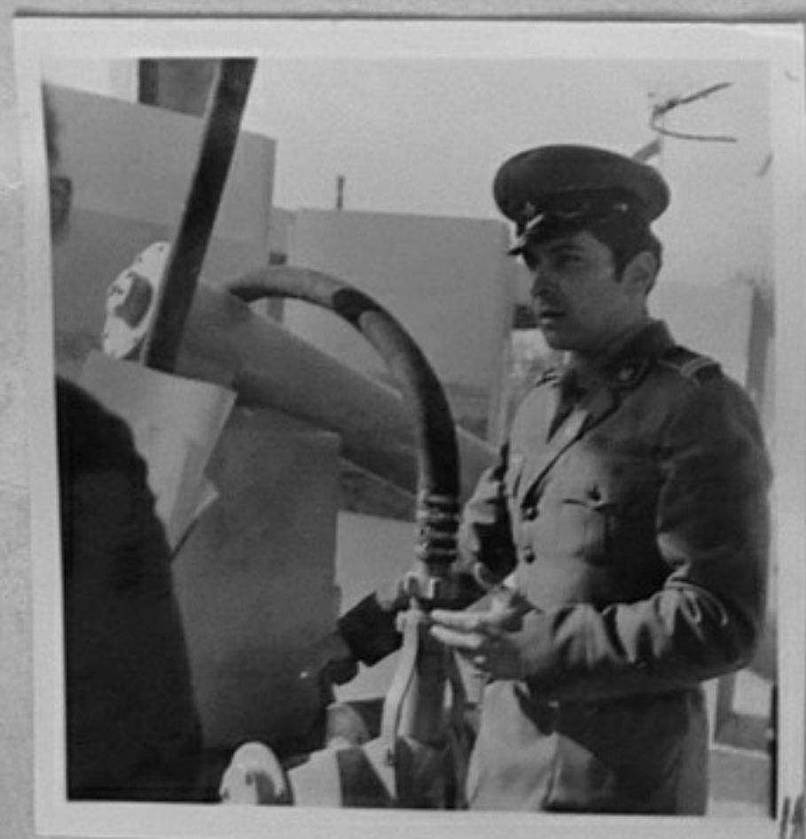
74-4767-11-Механизирана помпа за транспортиране на варови разтвори. Авторы инж.Йорданов от строителни войски в Ст.Загора./Н.Чобанов/ТК
