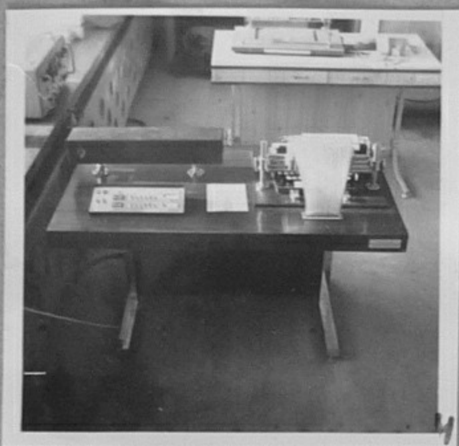
74-407-4,6-Пловдив-ТНТМ завод за пишещи машини. Инж. Паскал Бончев е конструирал стенд за изпитване на портативни пишещи машини. /К.Узунова/ТК
