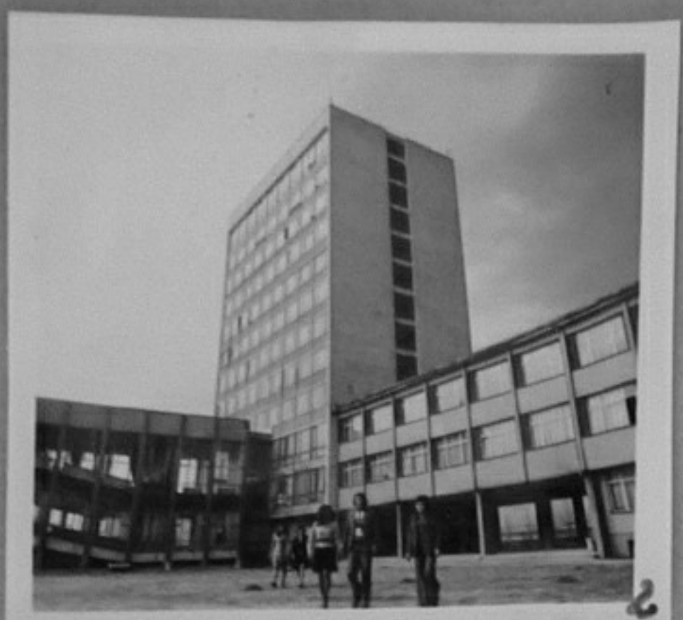
75-1301-2-Сградата на Института по съобщенията "Аврам Стоянов".
