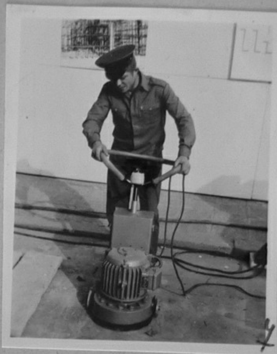
73-4767-7-Машина за почи-ст- ване на метални платна и бетонни плочи.Авт.колектив- ръковод.Ж.Андонов. /Нед.Чобанов/СС
