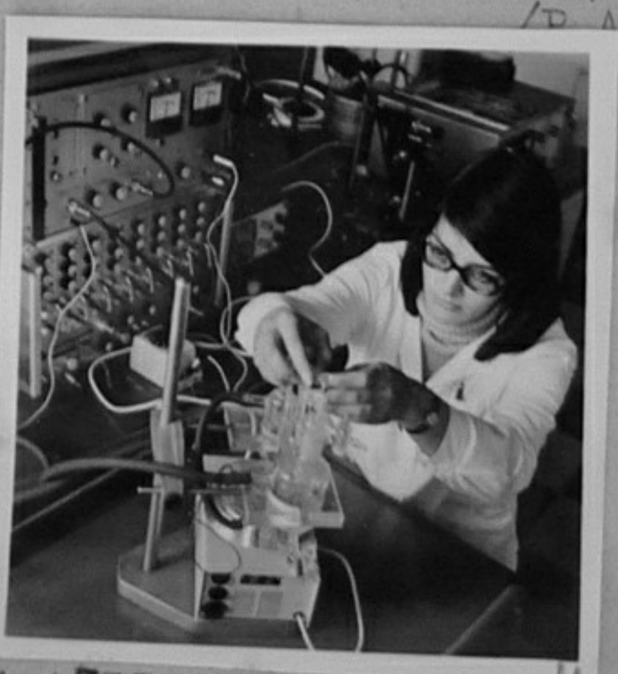
74-1535-11-Алкален електролит за нецианово цинкуване. Работи инж. хим. Маргарита Чомакова. /Р. Атанасова/ТК
