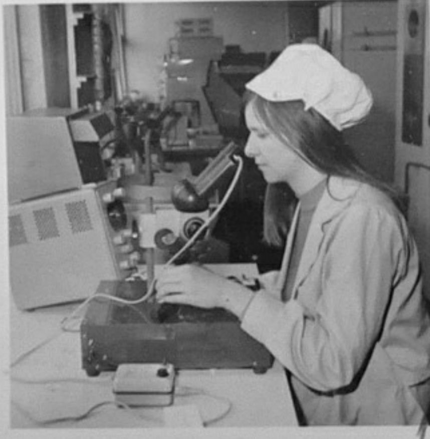
Обекти на окръжната изложба на ТНТМ-Ботевград. /Н.Хлебарова/ИК 76-1217-7-Д.Тодорова сортира пластинки за мощни транзистори, Завод за полупроводникови прибори. 76-1217-12-Цеца Илиева от младежка бригада на Завода за полупроводникови прибори по време на работа. 76-1218-2-Младежка бригада "Н.И.Вапцаров" от Завода за полупроводникови прибори.
