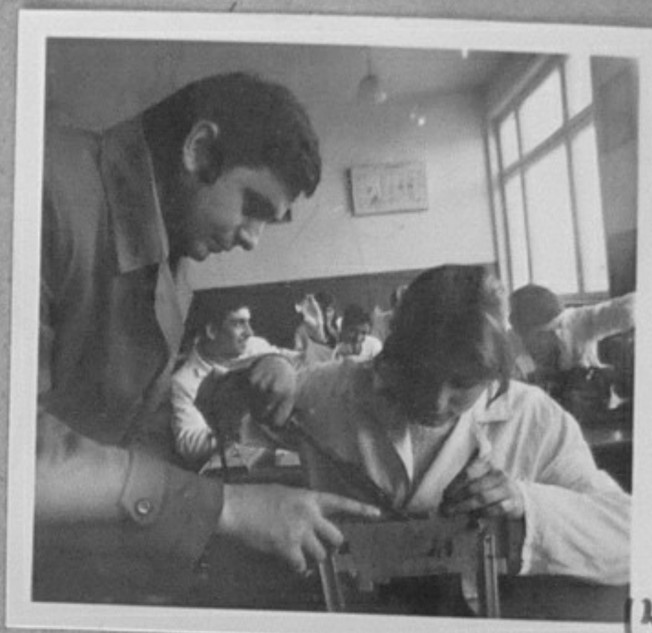
75-784-5,9-Курсисти от техникума с преподавател Л.Цоловски формоват модели с неправилна отделителна линия в леярната на техникума. Ботевград. /Н.Хлебарова/ИК 75-784-13-Преподавателят .Джам- базов контролира направа на радиоприемник "Чайка" в ел. работилницата на техникума.
