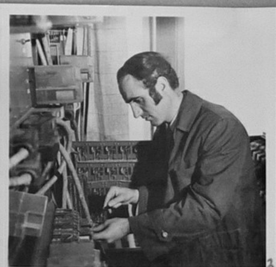
74-1607-3-Г. Малоселски работи по настройка на групите на маршрутно релейната централизация тип "МН-70". /А. Цанков/ТК
