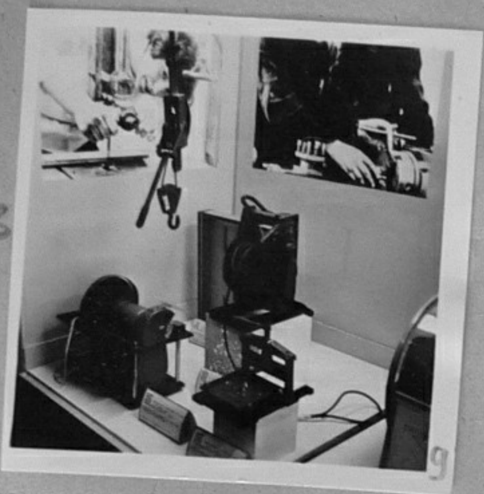
79-3903-9 Четирдесет и четвърто основно у-ще "Неофит Бозвели" - кърт от три уреда - апарат за рязане на теракотни плочки, тресчотка и монтажна лебедка, изработени в пионерския цех в СМК "Кремиковци" Вес. Димитров/МД
