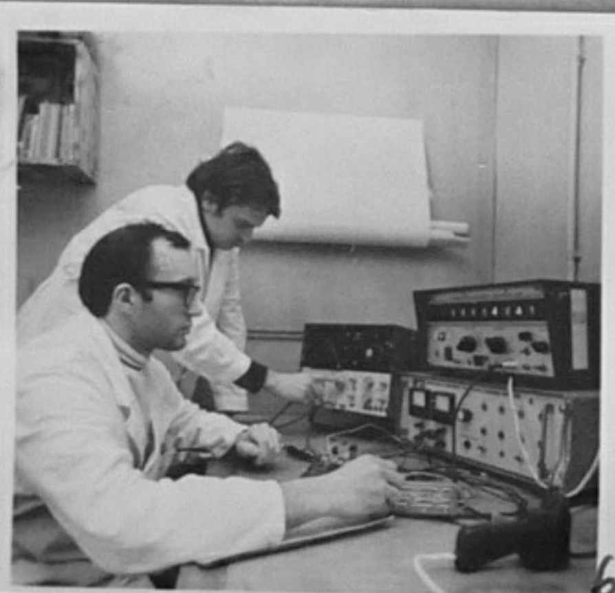
74-1238-6-Инж. Никола Пенчев и инж. Крум Стаменов експериментират схеми по разработка за сигнално повиквателно устройство за АТЦ. /Х. Румян/ЕИ
