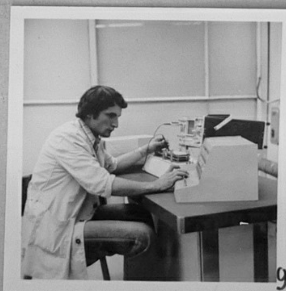
76-1766-9-Красимир Цанев на работното място на автоматичен стенд за информационна проверка на възел дешифратор с карта./Кр.Арсов/ЛА
