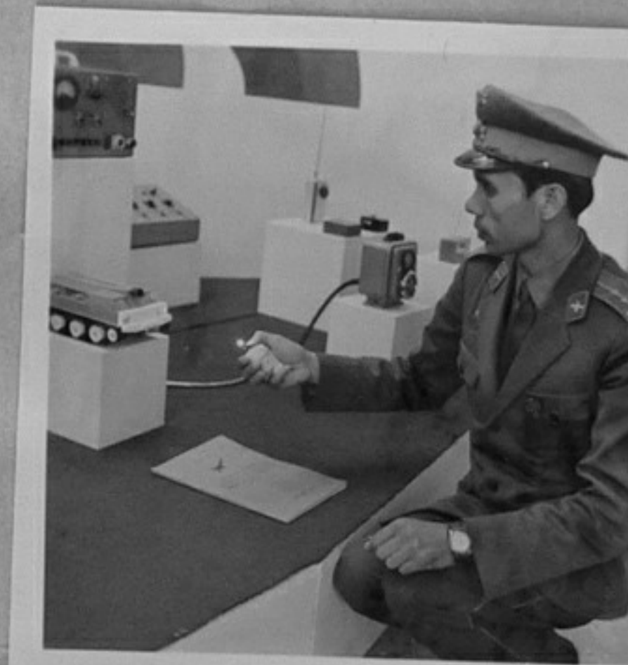
74-4767-9-Прибор за автоматично превключване на къси и дълги светлини на автомобили при разминаване. Автор-инж.Николов от под. 90440. /Н.Чобанов/ТК
