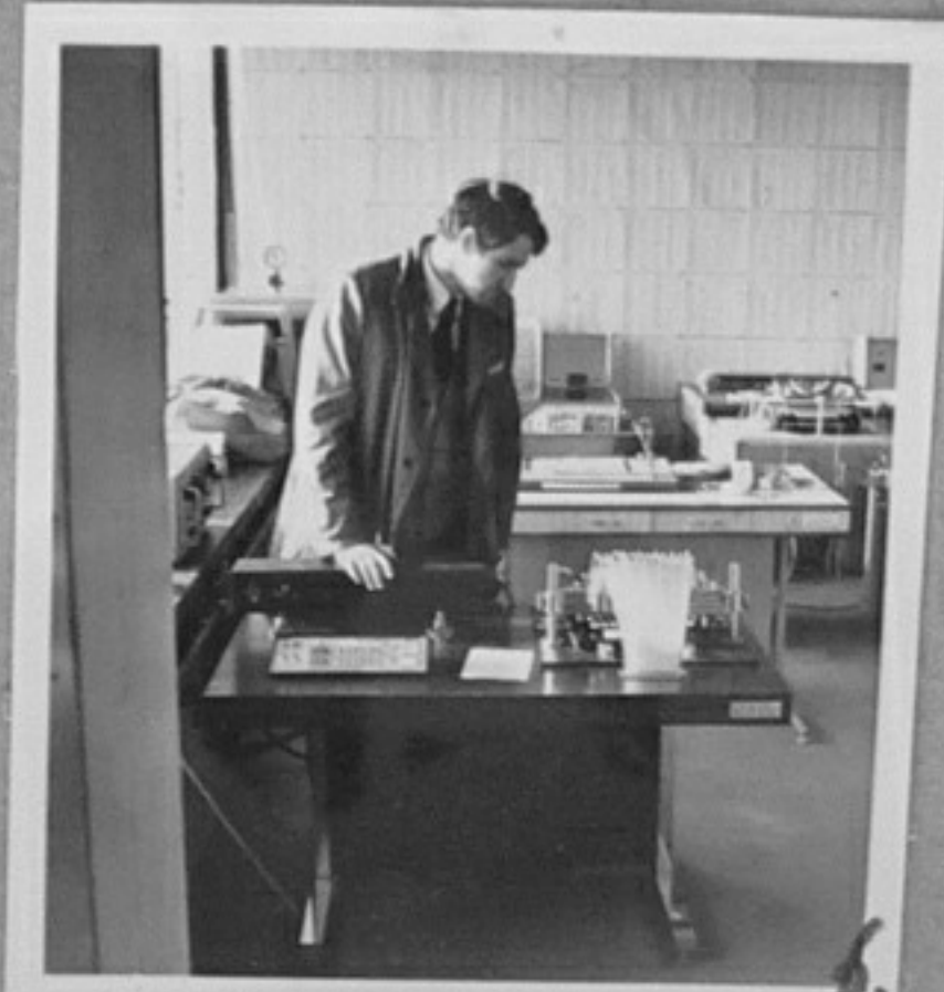
74-407-4,6-Пловдив-ТНТМ завод за пишещи машини. Инж. Паскал Бончев е конструирал стенд за изпитване на портативни пишещи машини. /К.Узунова/ТК
