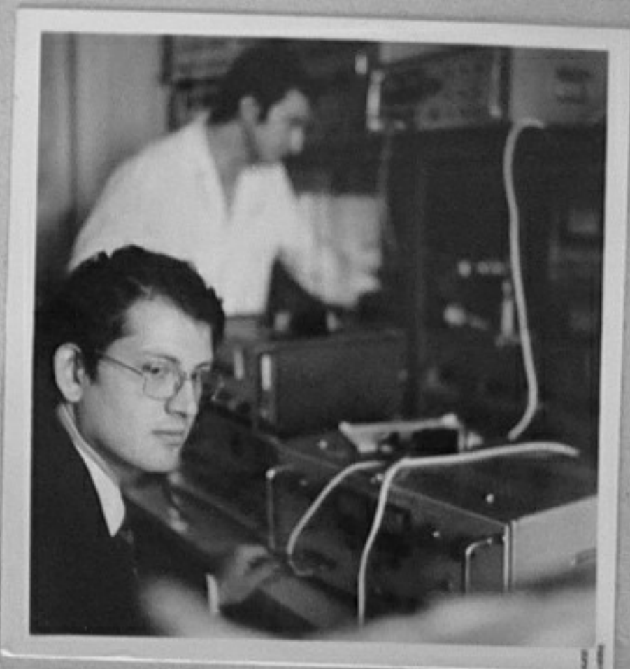
74-1533-11-Апаратура за измерване на свързателни премествания в звуковия и микровълнов диапазон. /Р. Атанасова/ТК
