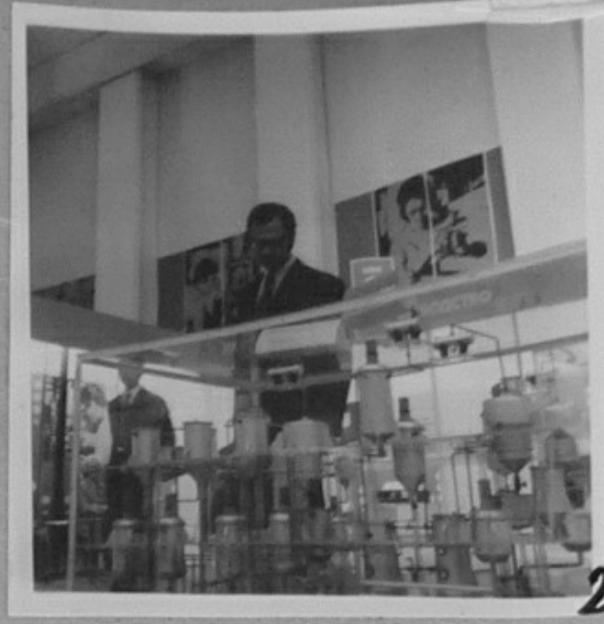
75-4073-2-Модел на цех за извличане на молибден и рений от наши концентрати. /Х.Румян/ИК
