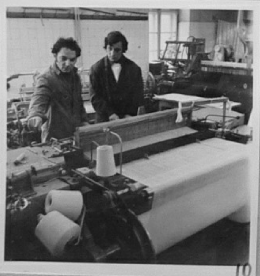
Обекти на ТНТМ-София. Висш машинно-електротехнически институт. /В.Балевска/ИК 76-612-10-Асистентът Чобанов и студентът Л. Маринов по време на упражнението по изучаване на технологичните възможности на стан АТПК за прокарване на повече вътъци едновременно. /В.Иванова/ИК 76-613-4-Електромагнитна установка за въздействие върху леснотопими метали сплави, разработил колектив с ръководител Вл.Христов. 76-613-5-Кръжочникът Димитър Атанасов по време на занимание.
