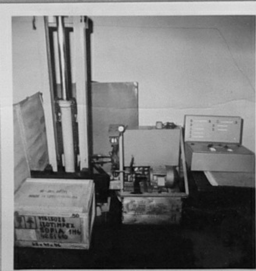
76-592-1-Стенд за изслед- ване на подвигателни елементи на електрока- ри, разработка на доц. К.Донев и инж.П.Стойчев. /В.Иванова/ИК
