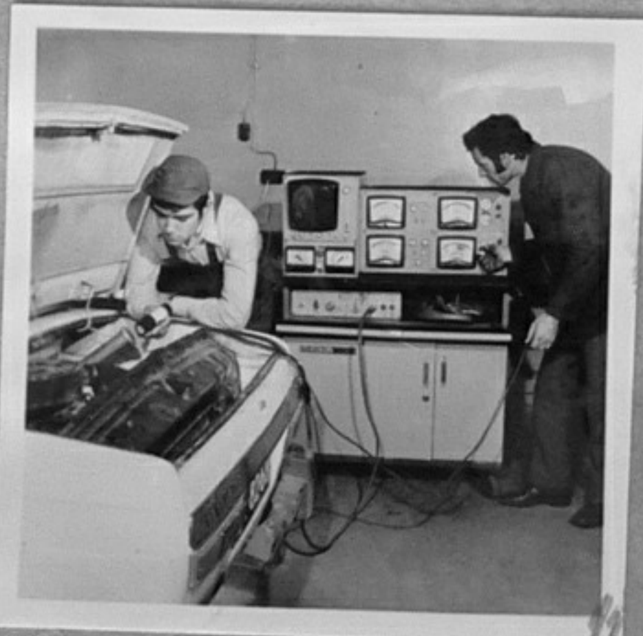
73-5317-11-Диагностичен стенд за мотори с вътрешно горене в техникума по механотехника, Пловдив. /Е.Любомиров/ТК
