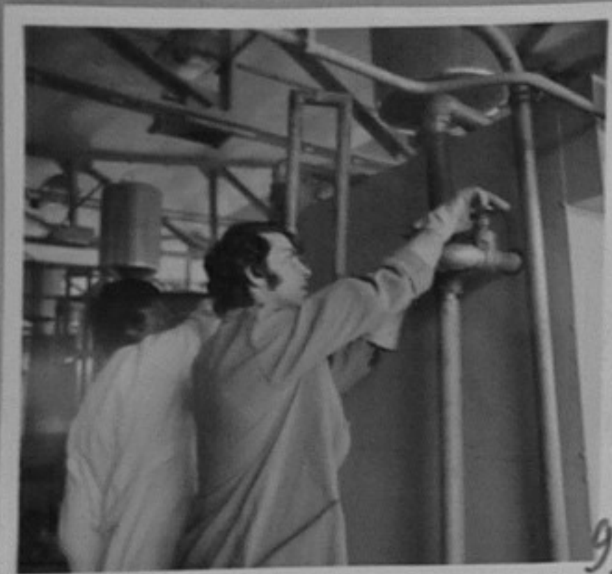
75-815-9-10-Завод за ензимни препарати-ботевград. Филтрация на културална течност при производство на ензими. /Н.Хлебарова/ТК
