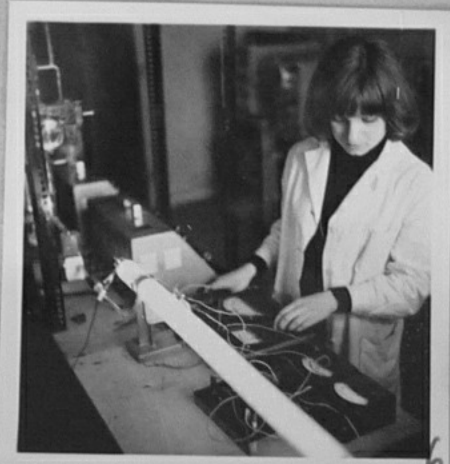
74-1533-6-Експериментална постановка за изследване на високочестотни вълни в ограничена плазма. /Р. Атанасова/ТК
