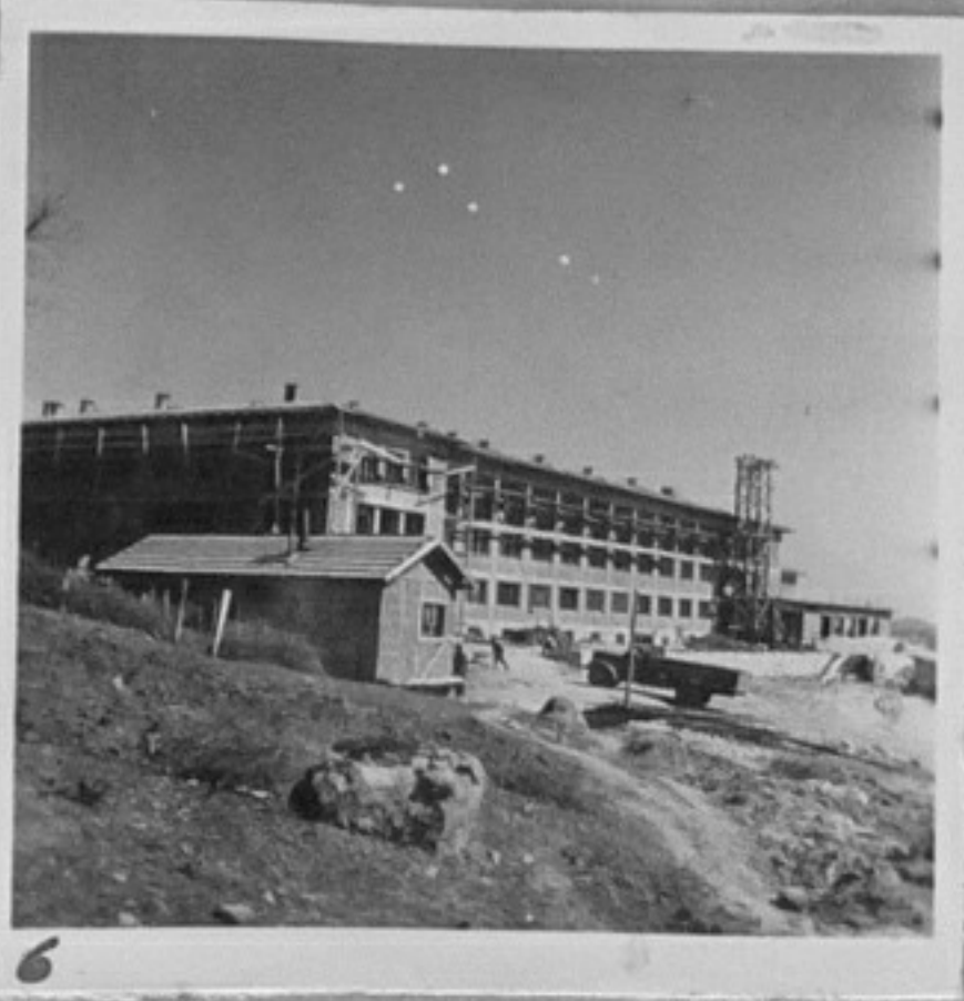
59/950-6-Строеж на почивен дом на трудещите се селяни. /Карекинян/
