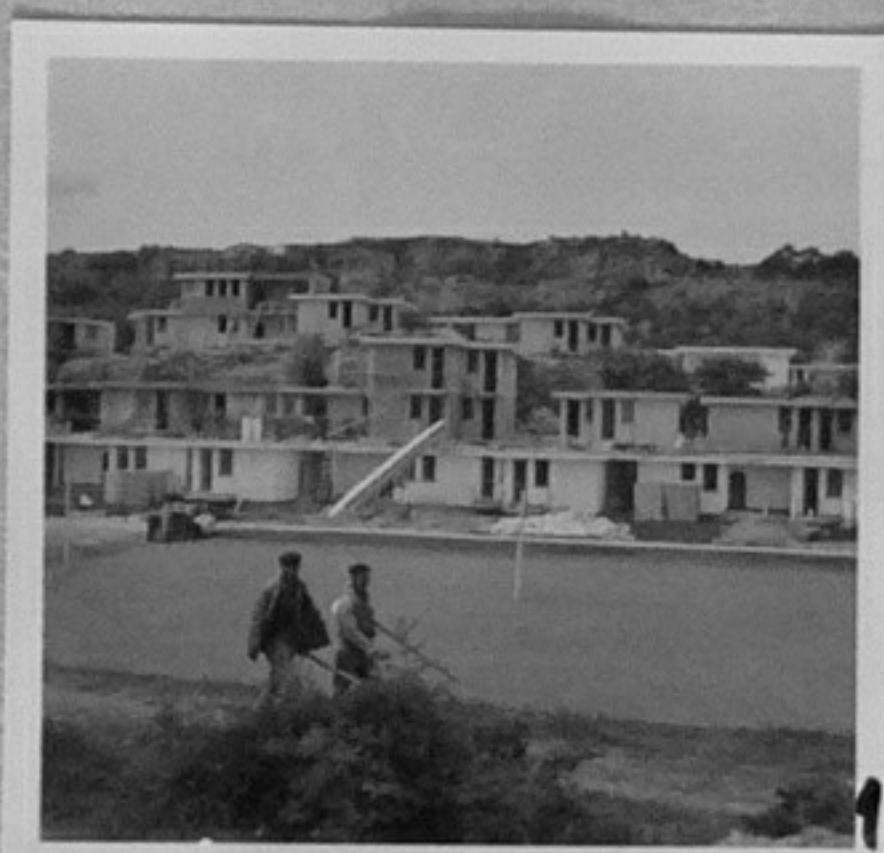
68-1876-1-Строителство на жил. компл. в курорта "Русалка" на Тауклиман, Толбухинско. /Радослав Парушев/СС
