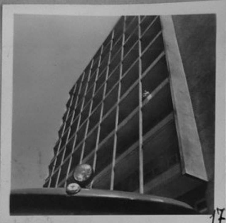
68-1007-17 - Главната сграда на Института. /Г.Бурмов/ЕИ
