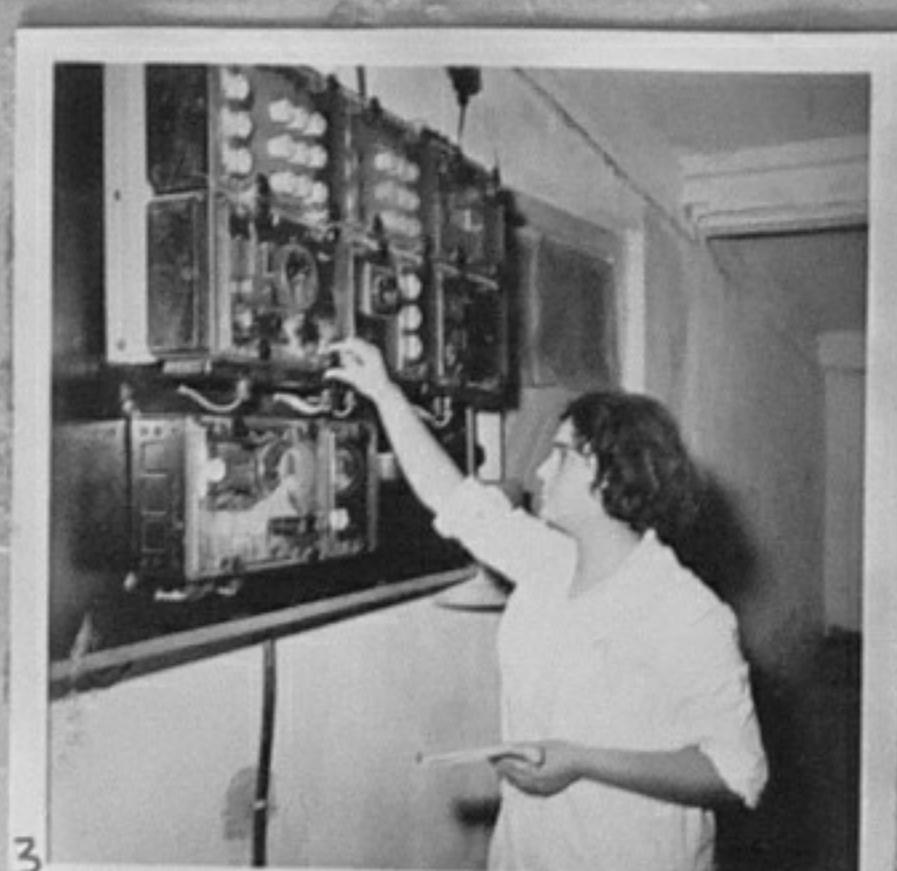
67-4303-Из птицекомбината в с. Дончово, Толбухинско. 3- Командно табло за регулира- не осветлението, храненето и вентилацията на пилетата.
