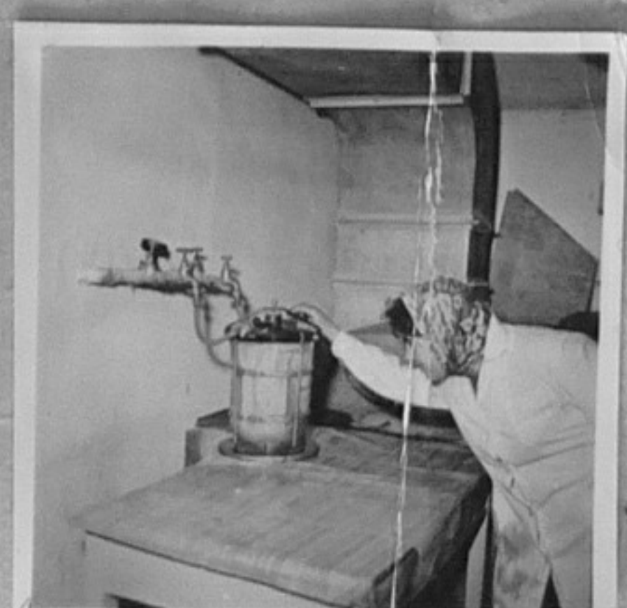
4- Автомедик-уред за автоматично дозиране и раздаване лекарства на птиците.
