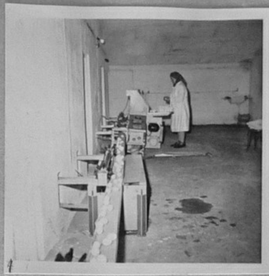
67-4305-1-Яйце събирачна машина в помещението на стоките носачки в птицекомб. с. Дончово, Телбухинско. /Тодор Симеонов/, СС
