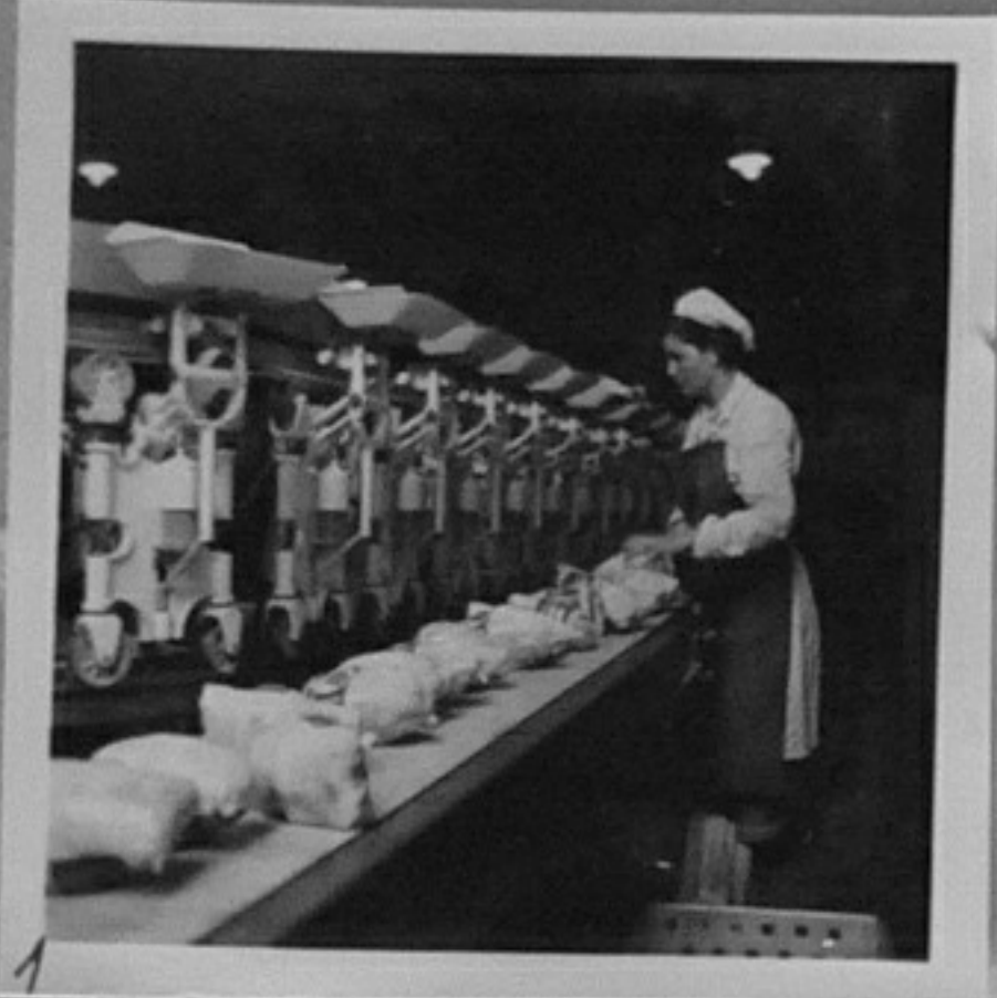
67/1213 - В птицекомбината край Костинброд. /Любомир Чаръкчиев/СС. 1 - Автоматично отмерване грамажа и разпределяне на пакетите с бройлери. 5 - Амбалиране. 11 - В птицекланицата с капацитет 3,500 пилета на час.
