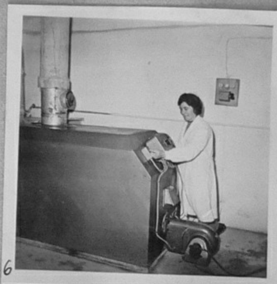
6- Включване на калорифера, апарат за автомат. отопление на помещението.
