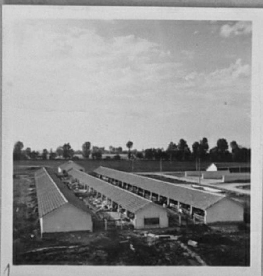
61/1399-1,5 - Изглед на образцова свинеферма, снабдена с автопоилки и автохранилки, приспособена за угодване на 2000 прасета от един гледач. - ДЗС "Ал.Стамболийски" край Пловдив. /Караджанов/
