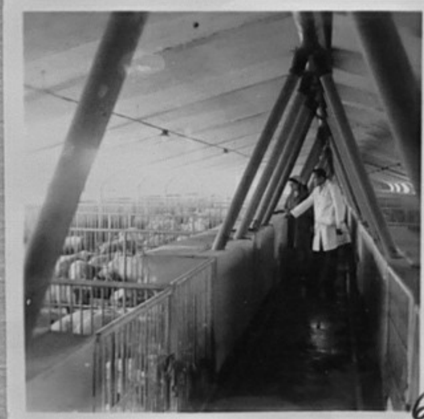
Междукооперативно свиневъдно стопанство в гр.Кнежа. /Л.Чаръкчиев/ ИК 70-3268-4,6,8-Механизиран свинарник с шнекове за подрастващи свинемайки.
