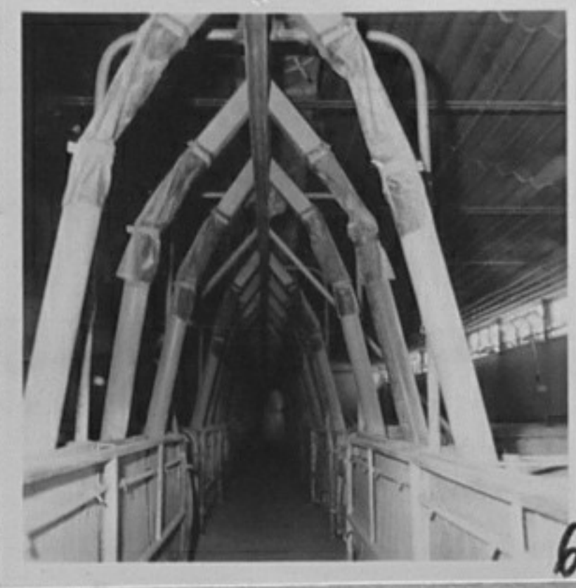
77-2357-6-Механизирано хранене на подрастващи прасета с българска инсталация за хранене./Л.Чаръкчиев/ЛА
