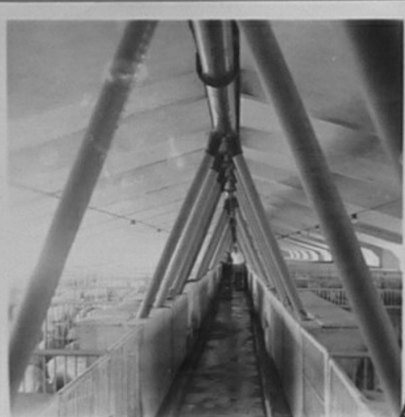
Междукооперативно свиневъдно стопанство в гр.Кнежа. /Л.Чаръкчиев/ ИК 70-3268-4,6,8-Механизиран свинарник с шнекове за подрастващи свинемайки.
