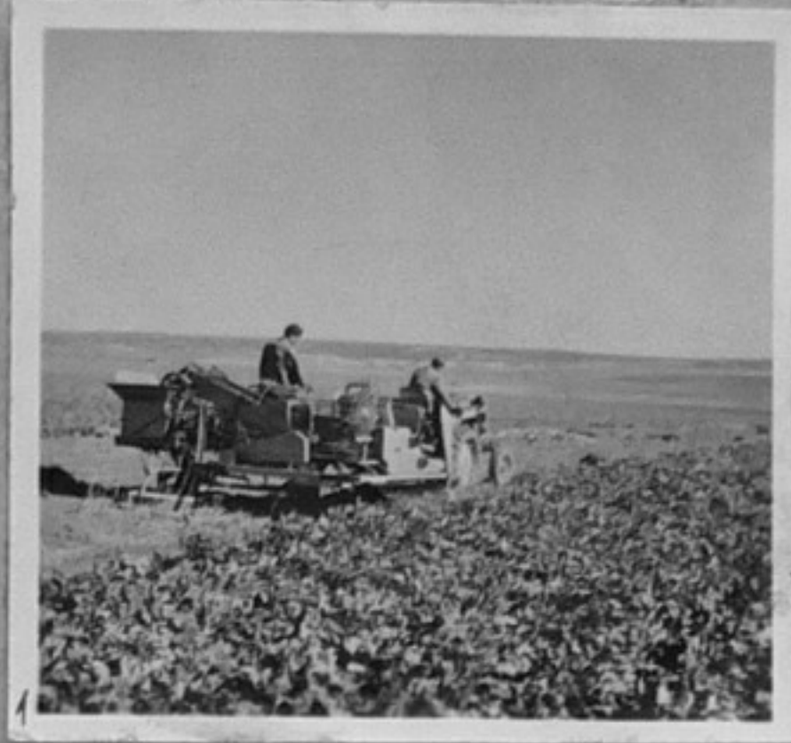
64/3125-1,4 - Механизирано вадене на цвеклото с цвеклокомбайн в ТКЗС с. Суворово.
