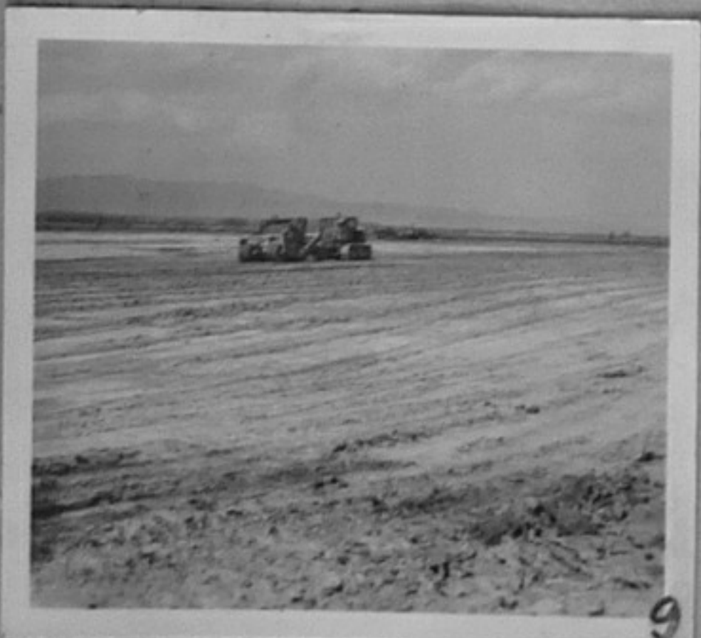
69-2375-9, 11-Изравняване на обширни терени за оризища в Пловдивско, посредством скрепери.
