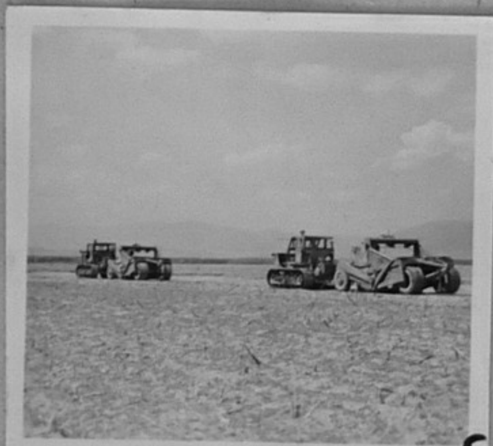
69-2375-5, 8-Изравняване на обширни терени за ори- зища в Пловдивско, посредством скрепери. /Петър Божков/. ЗЩ.
