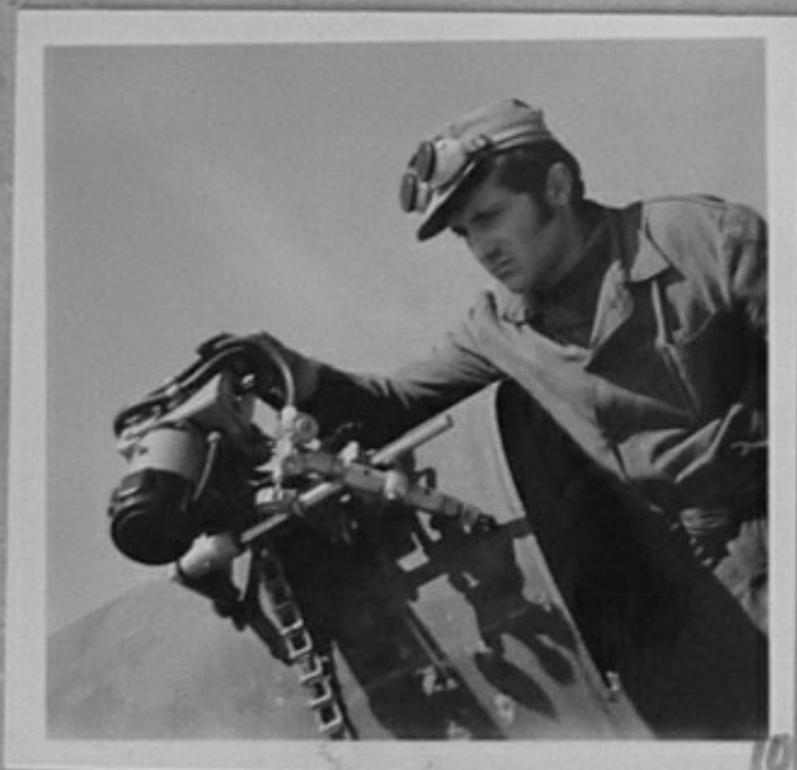
Газопровод СССР-България. /Л. Златков/ МК 72-1637-10-Газорезещата ма-шина "Спътник" за автомат. отрязване на тръбите се на-стройва от Г. Борисов.
