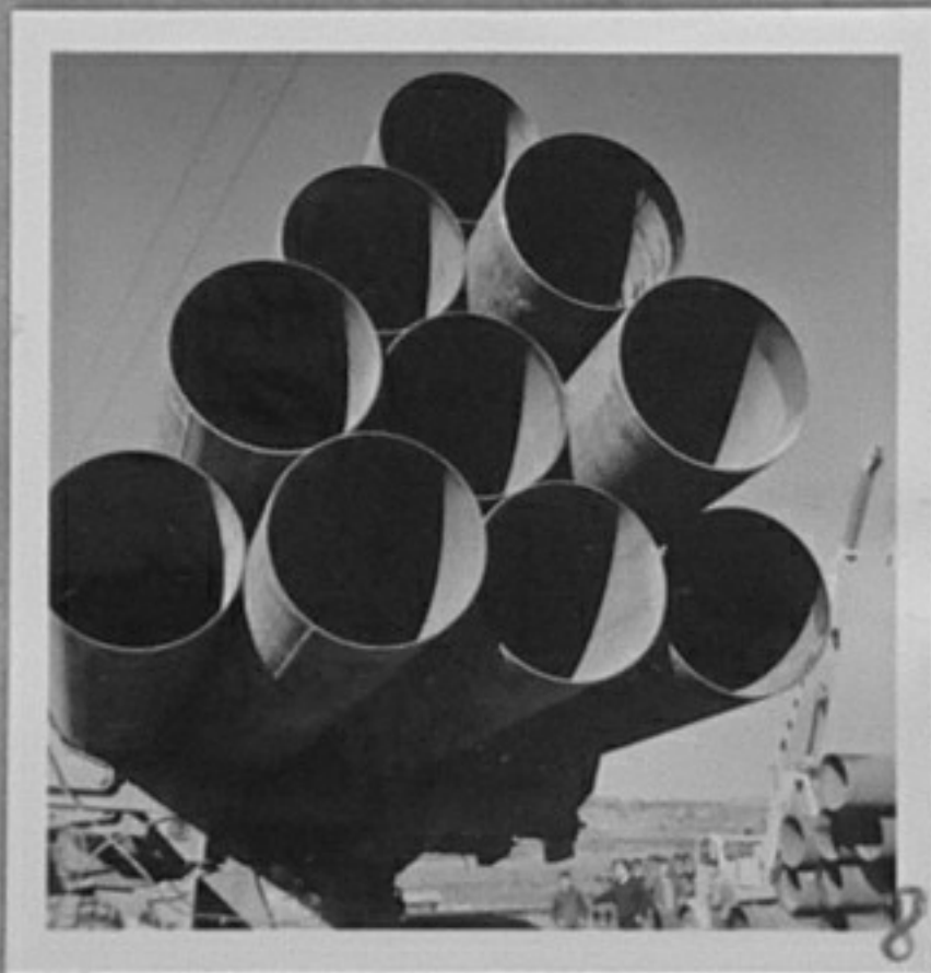
73-4837-5,8,12-Новодокарани тръби, необходими за строителството на газопровода СССР-НРБ. /Т.Хорисян/ИК
