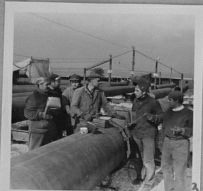
73-5154-3,5-Бригадата с ръководител Кало Калов - заваряване на тръбите-тройки. /Р.Парушев/ИК
