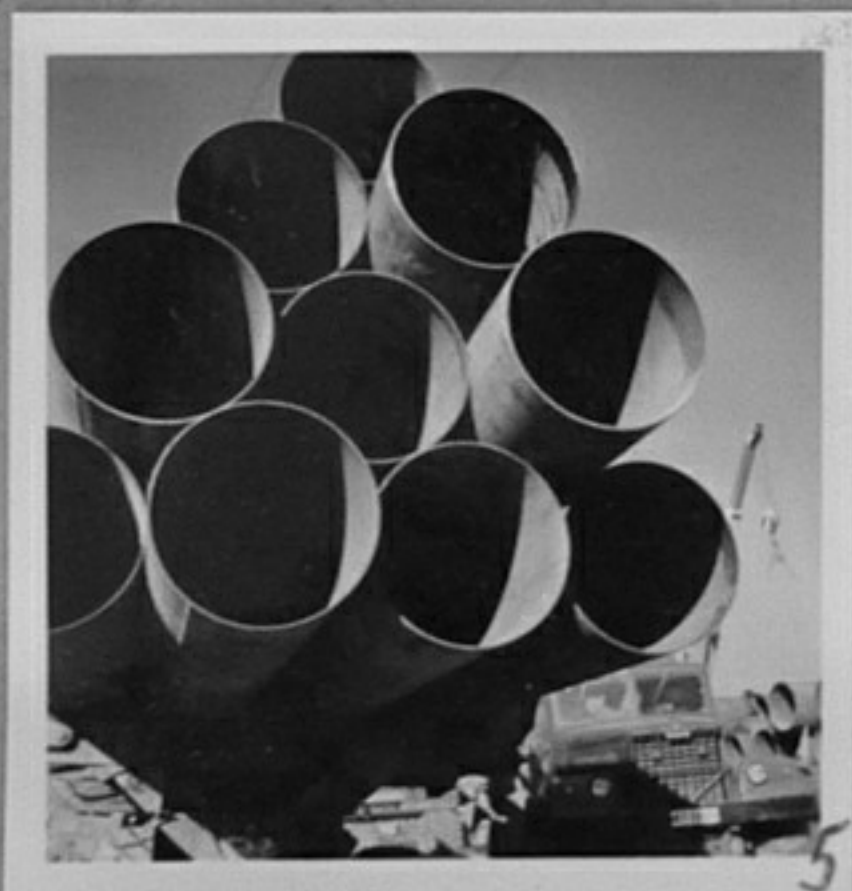
73-4837-5,8,12-Новодокарани тръби, необходими за строителството на газопровода СССР-НРБ. /Т.Хорисян/ИК
