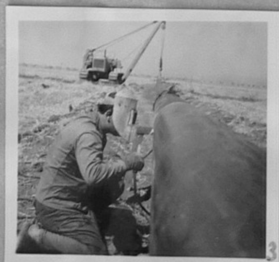
72-3854-5,6,10-Бригадата на Димитър Скарлатов извършва монтаж на петролопровода Бургас - Пловдив. /Н. Чобанов/ МК
