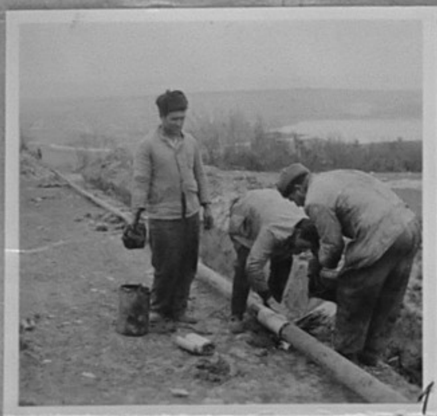
ГАЗОПРОВОДЪТ НОВО ОРЯХОВО-БЕЛОСЛАВ. Същият ще има дължина 27 км и ще свързва газов. находище в с. Ново Оряхово с ДИП "Стойко Из. Пеев", с. Белослав. 1- Изолация на места на свързв. на тръбите. 3, 5- Полагане на стоманените тръби в изкопа от комплексната монтажна бригада на Ат. Евтимов.
