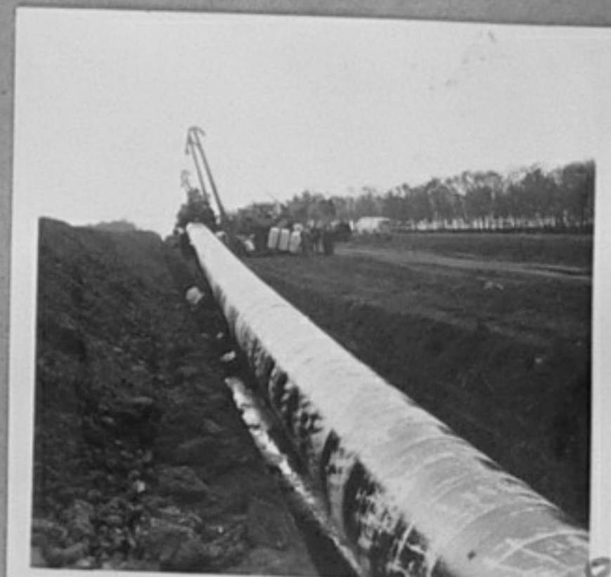
73-5156-2,5,8-Изоляционната колона, където работи бригадата на Ганчо Чернев. /Р. Парушев/МК
