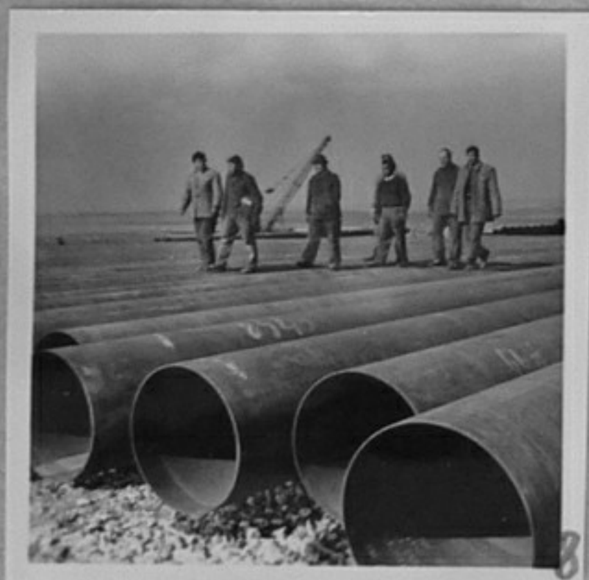
Газопроводът СССР-България. 73-5154-8,11,12-Бригадата с
