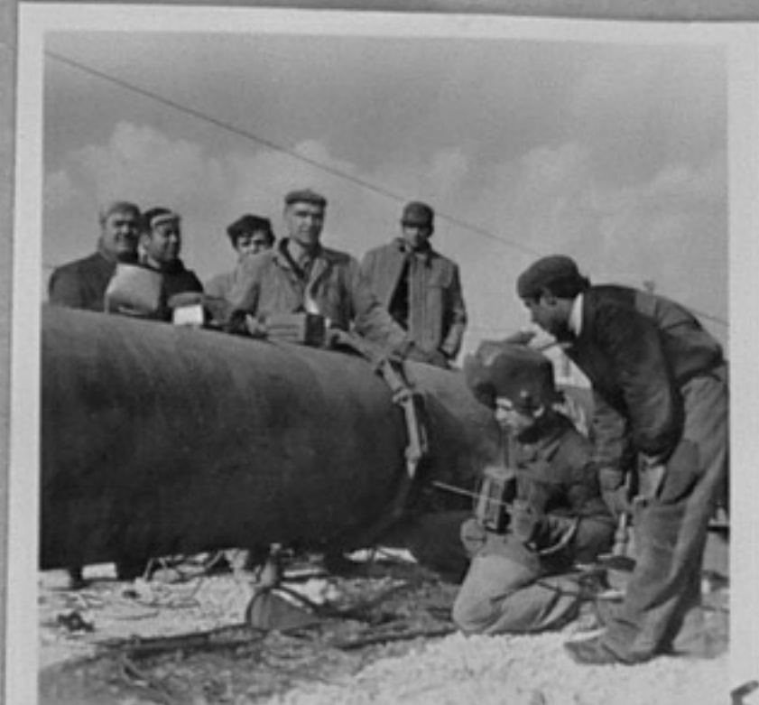
73-5154-3,5-Бригадата с ръководител Кало Калов - заваряване на тръбите-тройки. /Р.Парушев/ИК
