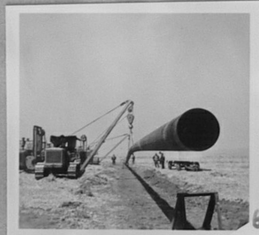
72-3854-5,6,10-Бригадата на Димитър Скарлатов извършва монтаж на петролопровода Бургас - Пловдив. /Н. Чобанов/ МК
