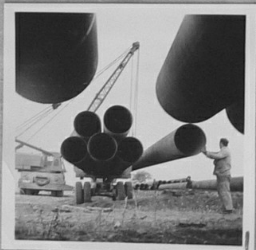
Газопроводът СССР - България. 73-5155-1-Товарене на готовите тройки-тръби на Чернев.
