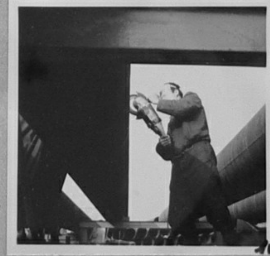
База за строеж на газопровода от СССР край гр. Плевен. /Л. Златков/ XII 71-5384-1-Заверяване на тръби необходими за газопровода. 71-5384-5-Електроженистът Д. Цветанов работи на автом. машина за скосяване на тръби. 71-5384-10-Монтьорът В. Трендафилов зачиства заварки с ръчен шмиргел.
