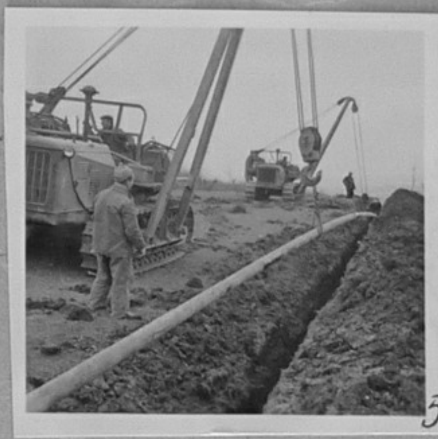
ГАЗОПРОВОДЪТ НОВО ОРЯХОВО-БЕЛОСЛАВ. Същият ще има дължина 27 км и ще свързва газов. находище в с. Ново Оряхово с ДИП "Стойко Из. Пеев", с. Белослав. 1- Изолация на места на свързв. на тръбите. 3, 5- Полагане на стоманените тръби в изкопа от комплексната монтажна бригада на Ат. Евтимов.
