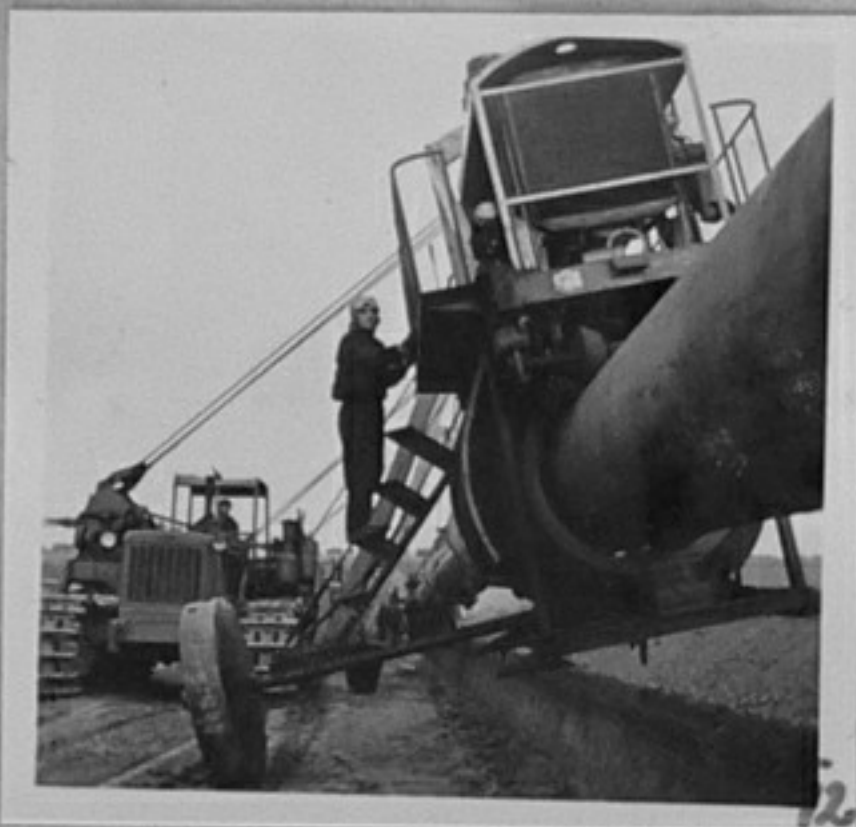
Газопроводът СССР - България. /Р. Парушев/ИК 73-5155-10, 12-Изолационната колона - бригадир Ганчо Чернев.
