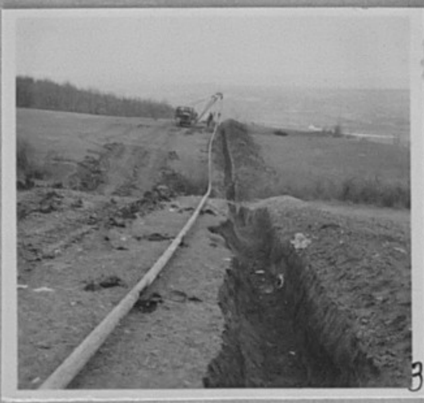
ГАЗОПРОВОДЪТ НОВО ОРЯХОВО-БЕЛОСЛАВ. Същият ще има дължина 27 км и ще свързва газов. находище в с. Ново Оряхово с ДИП "Стойко Из. Пеев", с. Белослав. 1- Изолация на места на свързв. на тръбите. 3, 5- Полагане на стоманените тръби в изкопа от комплексната монтажна бригада на Ат. Евтимов.
