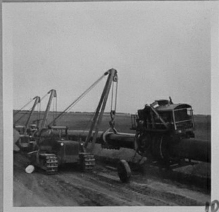
Газопроводът СССР - България. /Р. Парушев/ИК 73-5155-10, 12-Изолационната колона - бригадир Ганчо Чернев.
