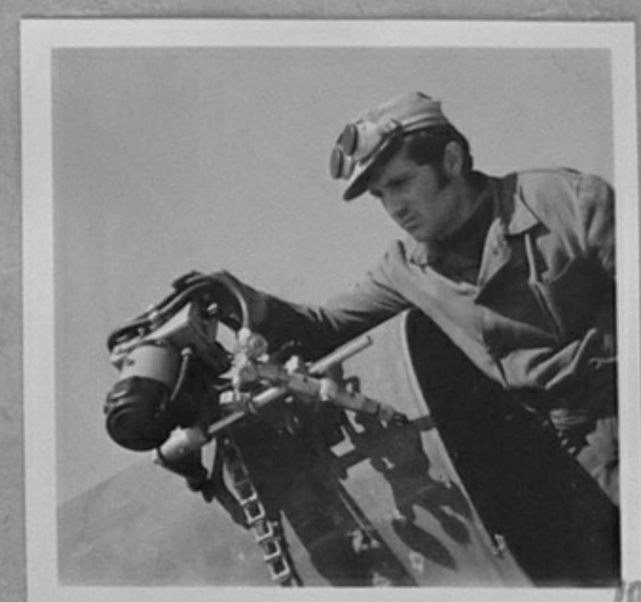
Газопровод СССР-България. База за автоматично заваряване на тръби за газопровод и вода, в с. Тодорово, Плевенски окръг. /Л. Златков/ МК 72-1637-2-Съветският специалист по заварките Б. Оболенски дава инструктаж на работници от базата. 72-1637-5-Тръби за газопровода. 72-1637-10-Газорезещата машина "Спътник" за автоматично отрязване на тръбите се настройва от комсомолец Георги Борисов.
