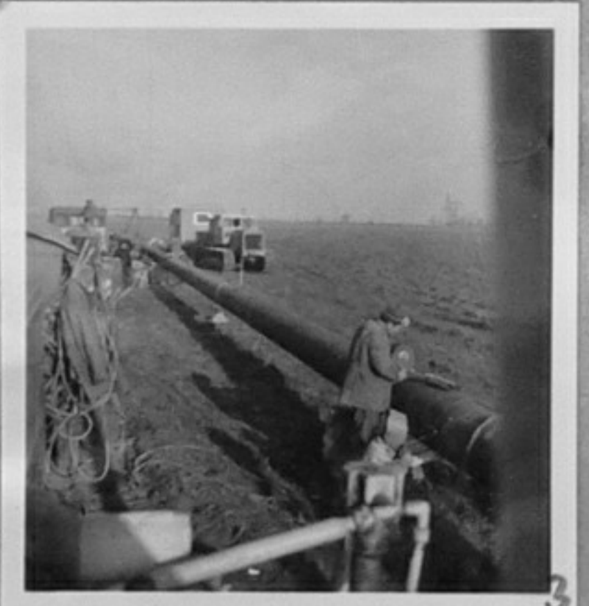
75-395-2,3,10-Строежът на газопровода СССР - НРБ.
