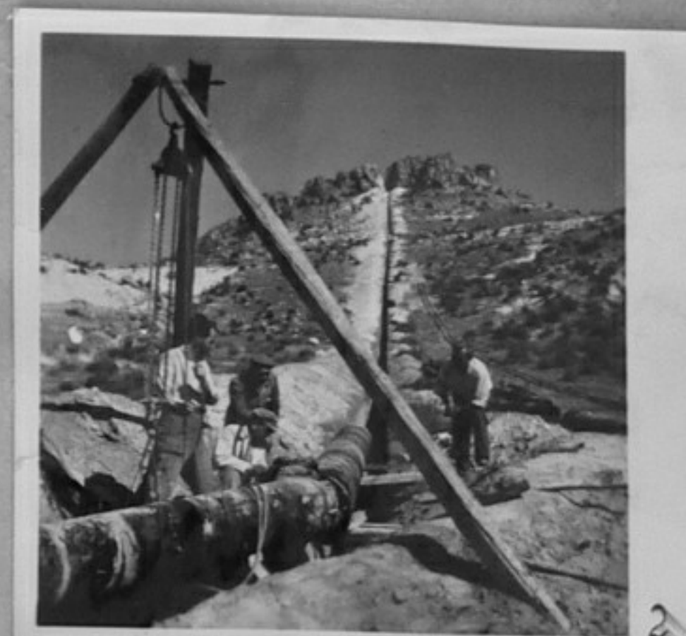
57/3246-2-Строеж на водопровода Девня-Варна. /Парушев/ММ
