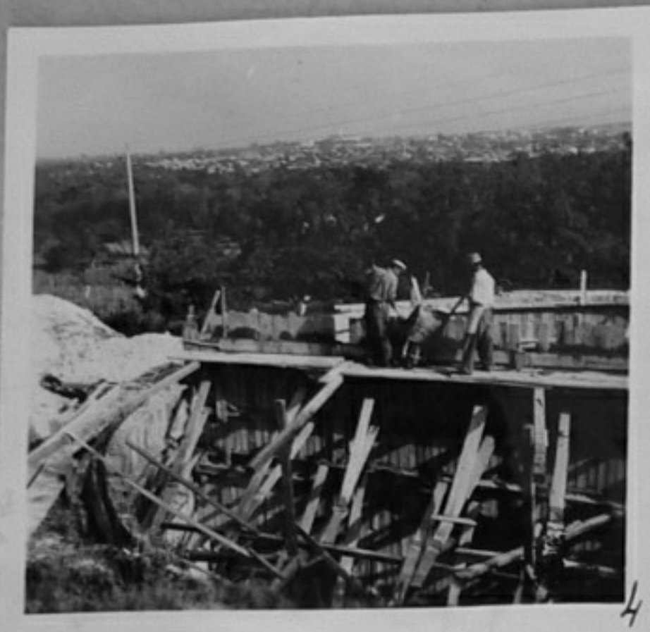
4,7 - Строеж на кръгъл железобетонен водоем с вместимост 500 м за IV водоснабдителна зона на Варна.
