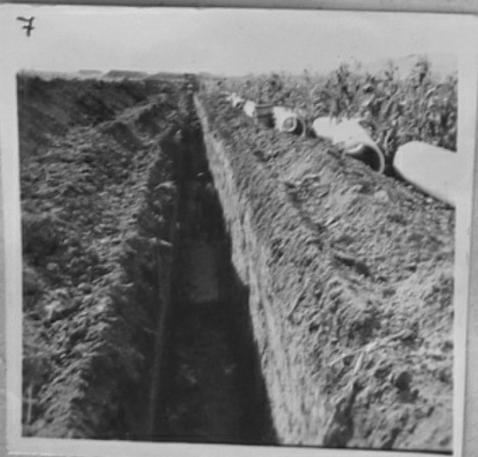
57/2906-7,8,9 - Строеж на водопровода Девня-Варна. /Парушев/ ММ
