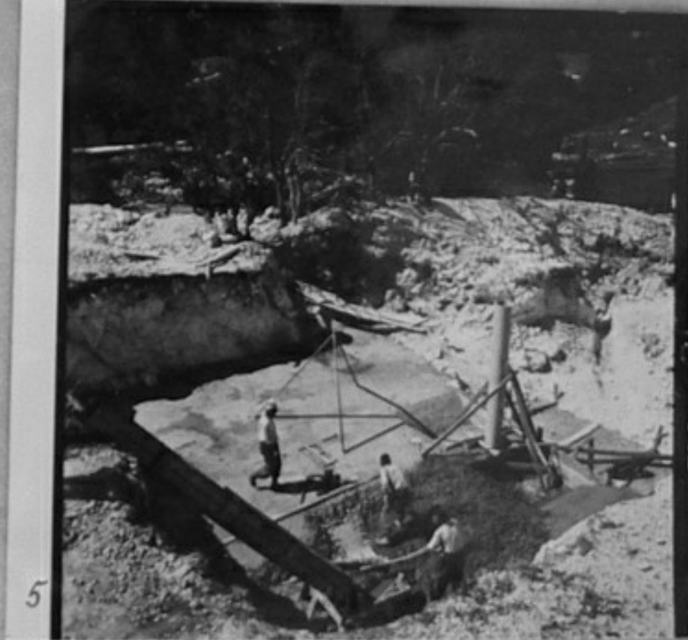
4,5 - Прокоспаване на канали за тръбопроводи в местн. "Демир баба"
