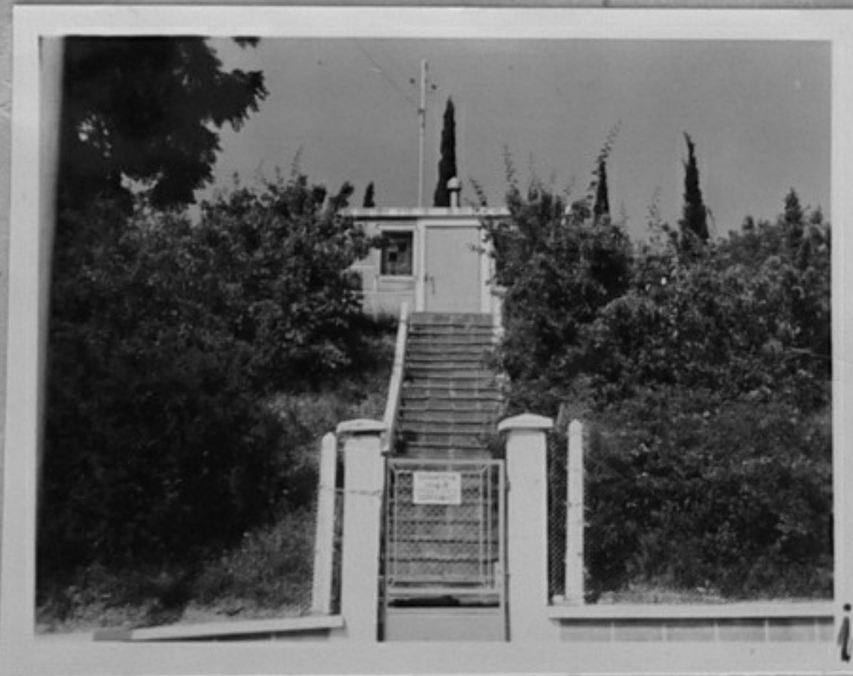
74-3346-1-Резервоарът "Средна зона"- водоснабдяване - гр.Стара Загора. /Н.Чобанов/ИК
