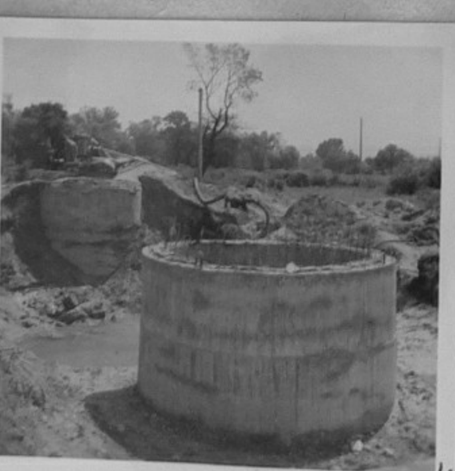
71-4009-4,7-Хващане дъно на бункерна помпена станция, Стара Загора.
