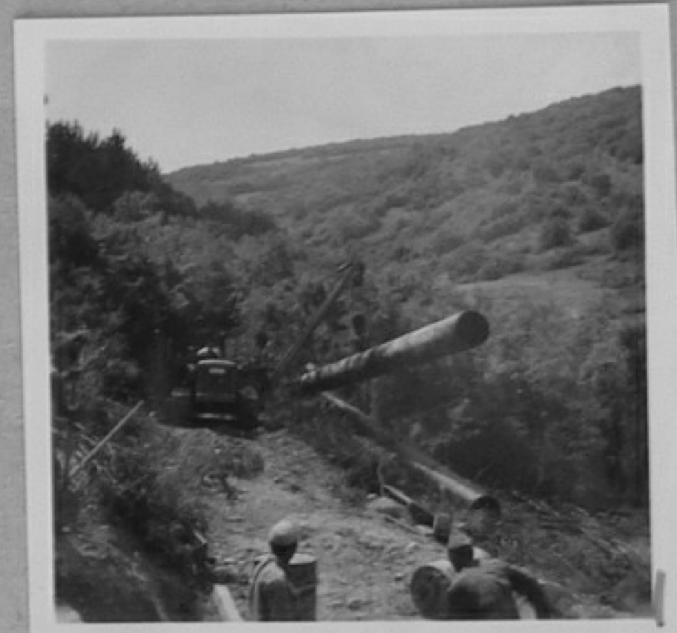
71-4011-1-Поставяне на тръби при силно наклонен район - Стара Загора. /Нед. Чобанов/ XII
