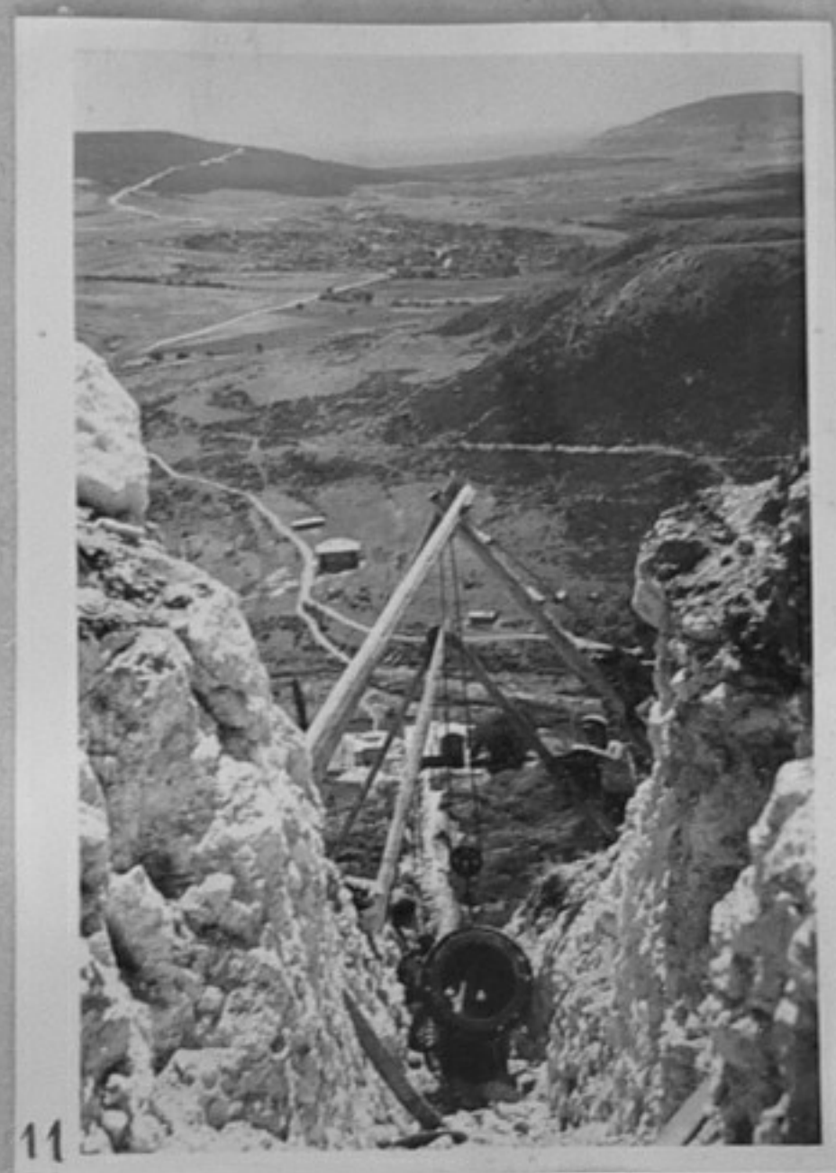
56/69-8,11,12 - Моменти от прокарване на водопровода за помпената станция при село Оброчище, Балчишко. /Абаджиев/ ММ
