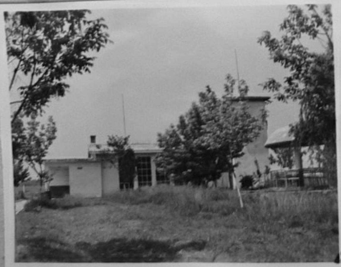
74-2870-3-Помпена станция в Горно Ботево. /Нед.Чобанов/ЕИ
