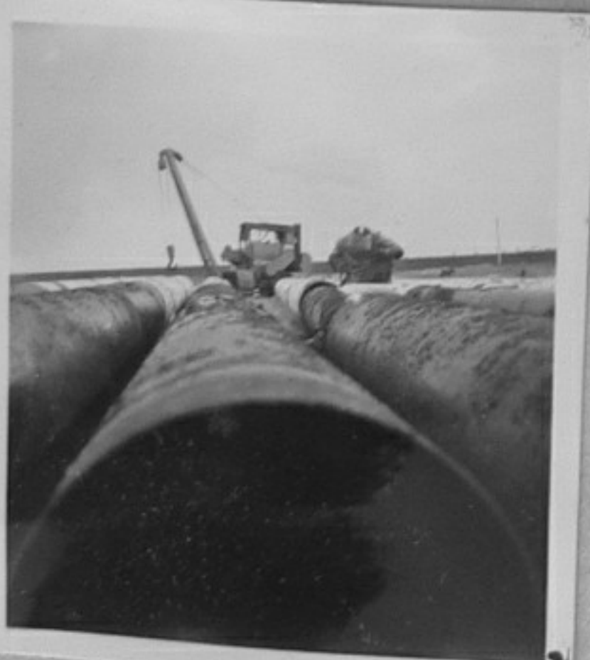
70-3615-3-Заваряване водо- провода на Нефтохимическия комбинат - Бургас. /Д.Стаматова/ ХП
