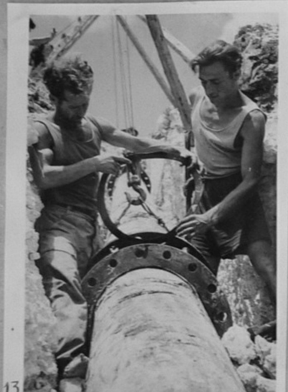
56/69-13,14,16 - Моменти от прокопаването на водопровода, направен за помпената станция при село Оброчище, Балчишко. /Абаджиев/ ММ
