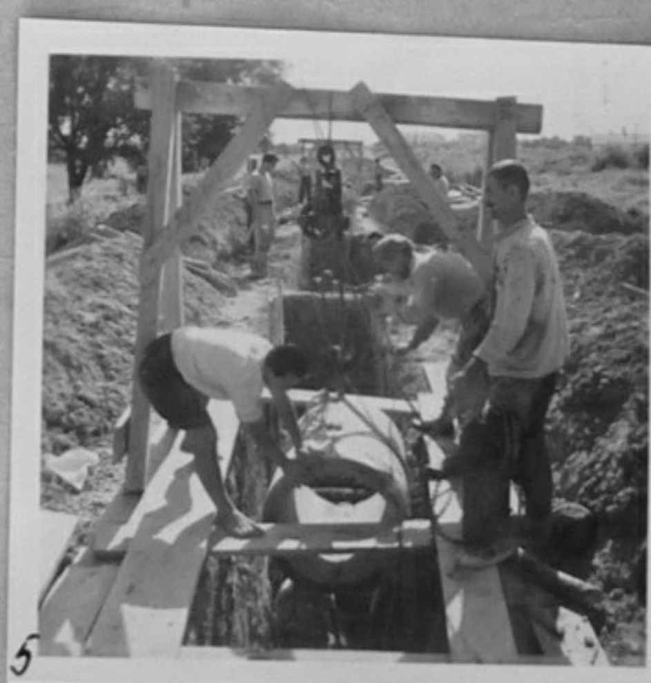
54/2473-5-Търговище - поставяне на тръби на канализация. /ММ/
