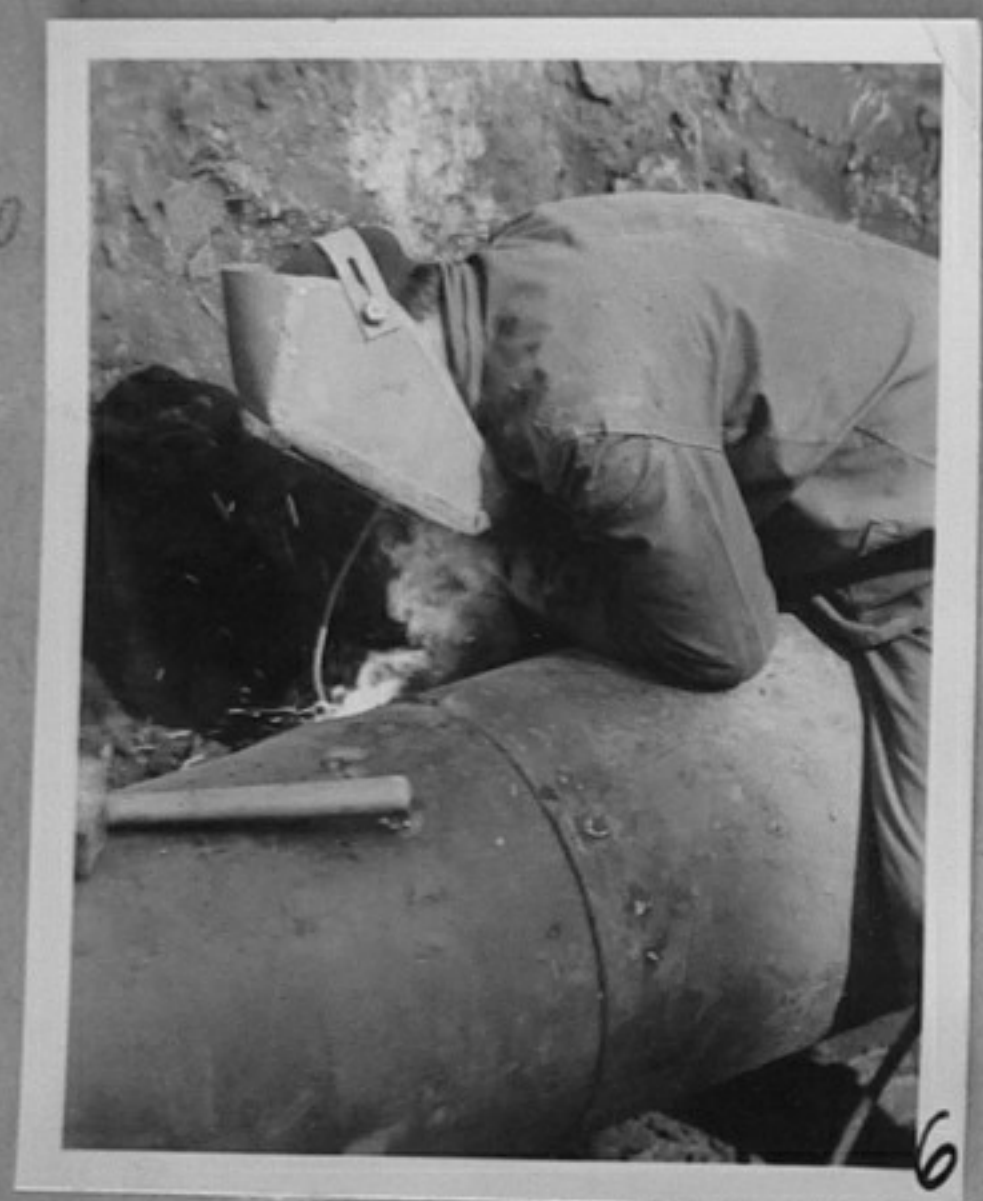
67/2046-6 - Строеж на топлопровод в комплекс "Гео Милев". /Б.Юскеселиев/ЕИ
