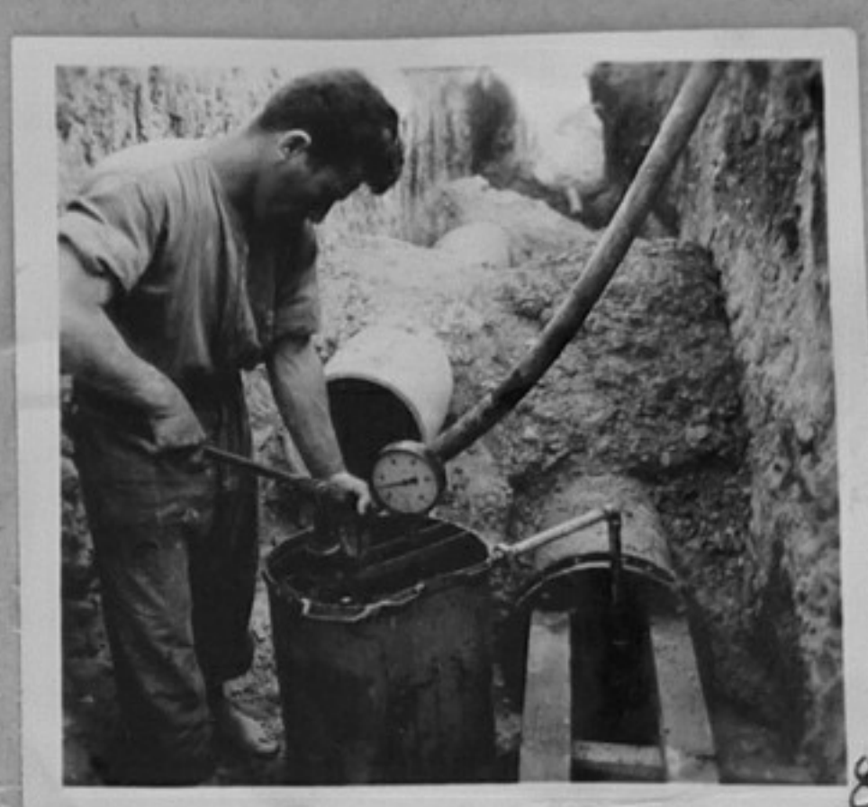
8 - Извършване изпитание на водното налягане на част от каменния водопровод за IV зона, Варна.
