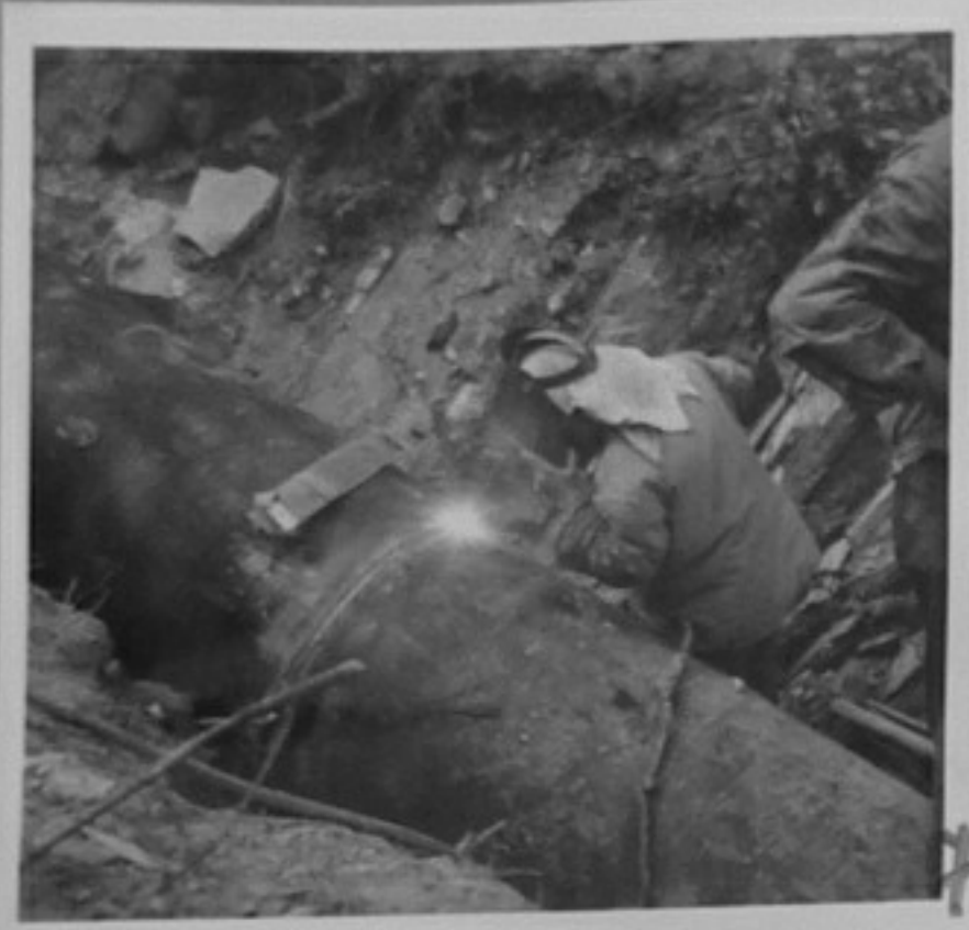
Водоснабдяване на Стара Загора. /Н.Чобанов/ XII 71-4012-7-Заварка на стоманени тръби в канала на водопровода. 71-4012-12-Пренасяне до мястото за полагане на стоманени тръби с тръбоклад.
