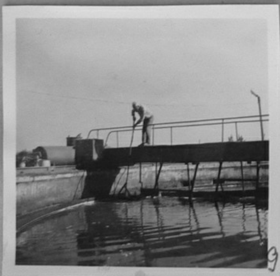
85-1377-9-Пречиствателните устрой- ства на станцията./М. Велинова/ЛА
