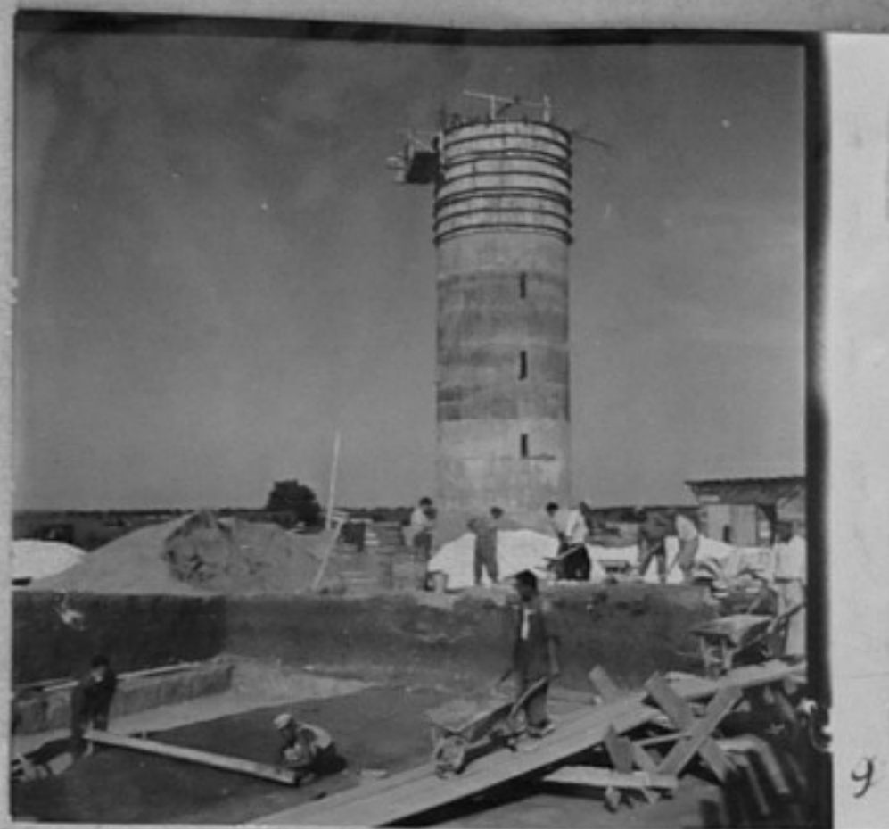
56/1437-8,9 - Стро еж на централна водоемна кула, свързана с помпена станция "Демир баба". /Абаджиев/ ММ
