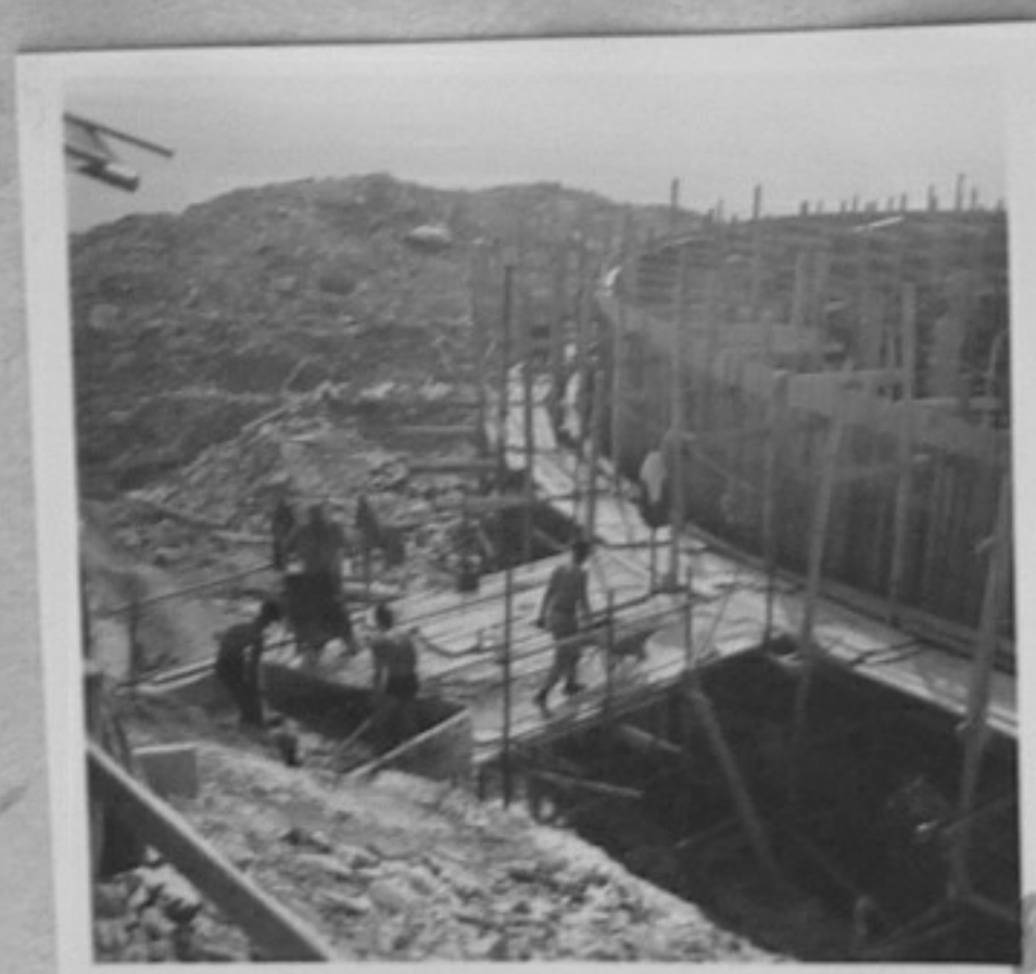
71-4011-8,12-Полагане бетон на I-ви водоем. /Нед. Чобанов/ XII
