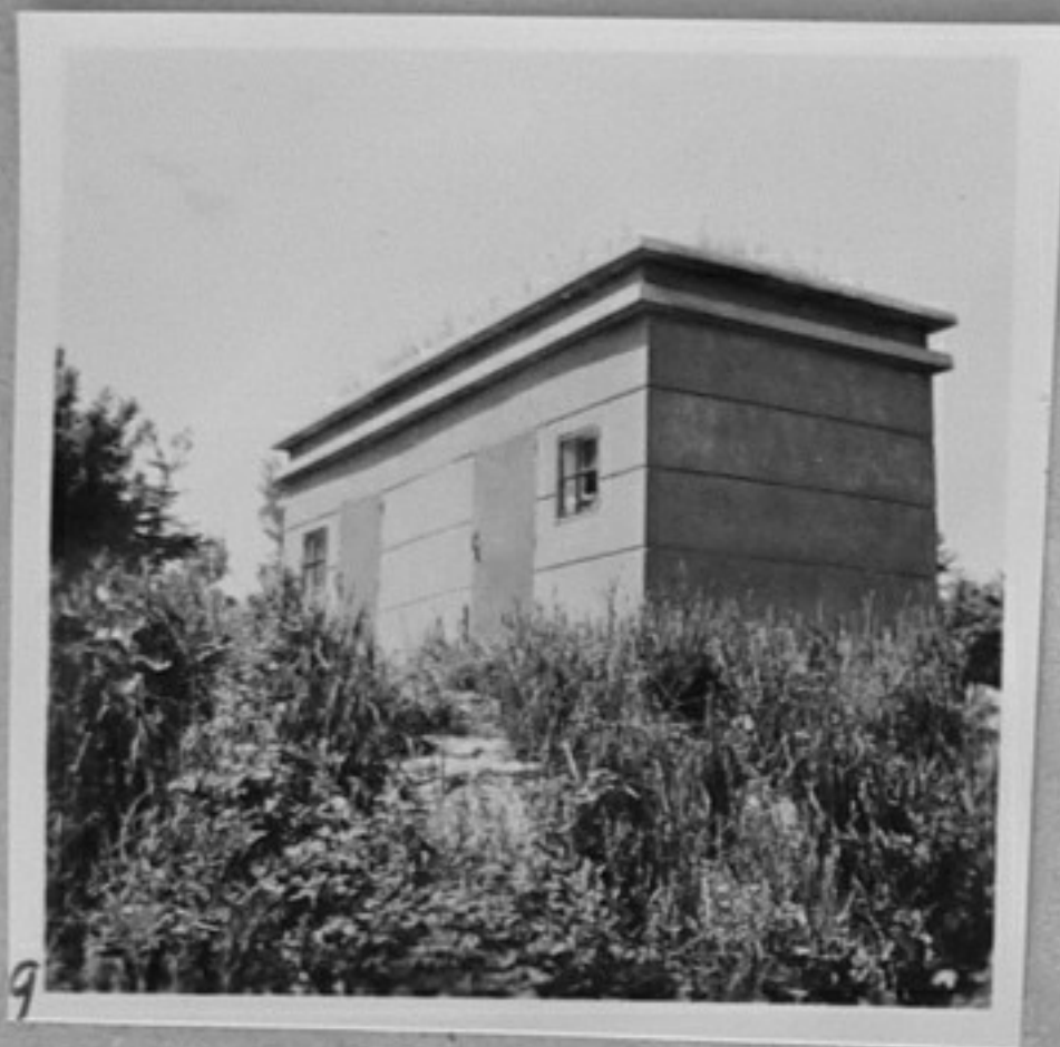
9-Събирателна шахта-хлоратор на водопровода за "Златни пясъци".
