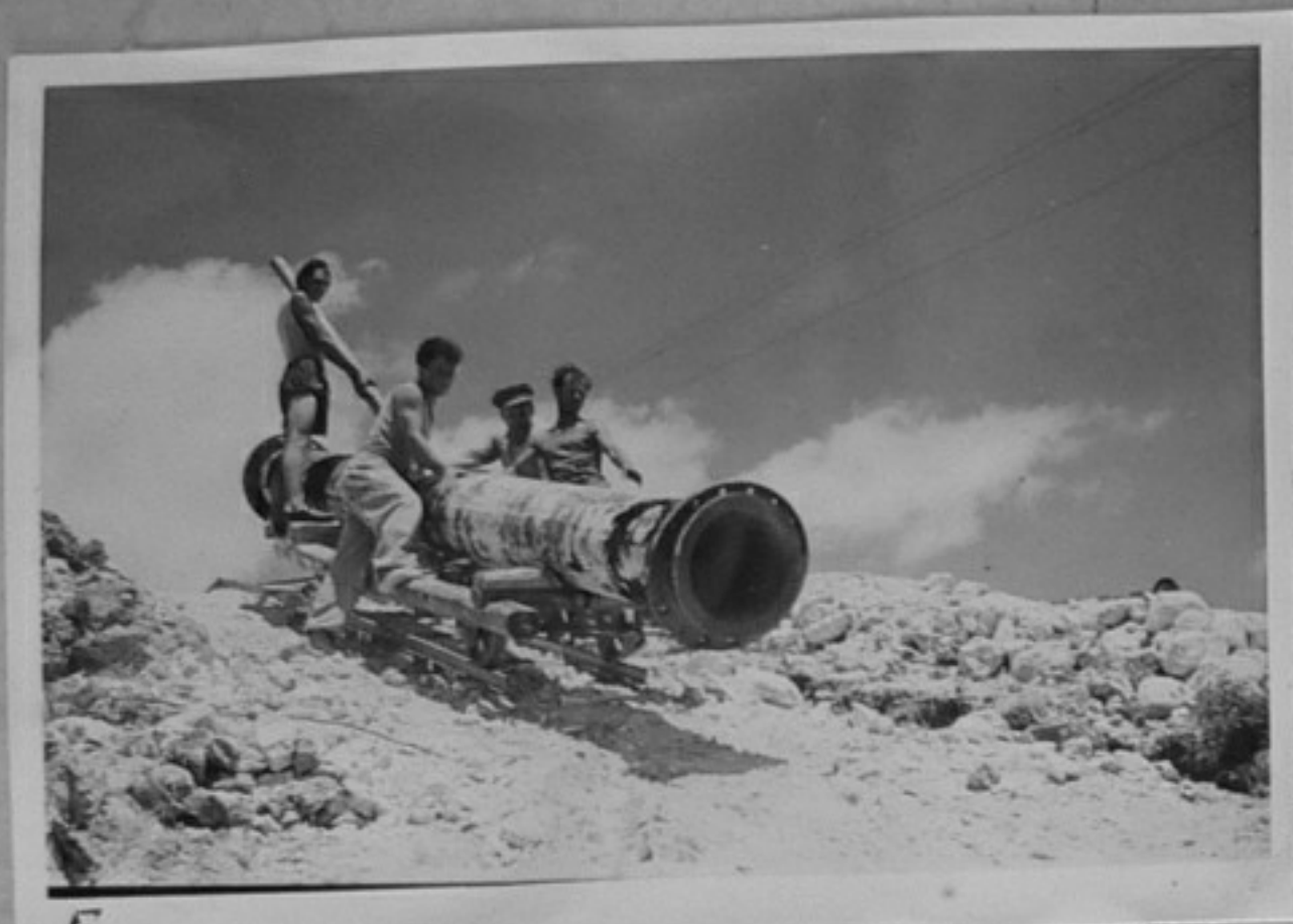
56/69-5,6 - Моменти от прокарване на водопровода за помпената станция при село Оброчище, Балчишко. /Абаджиев/ ММ
