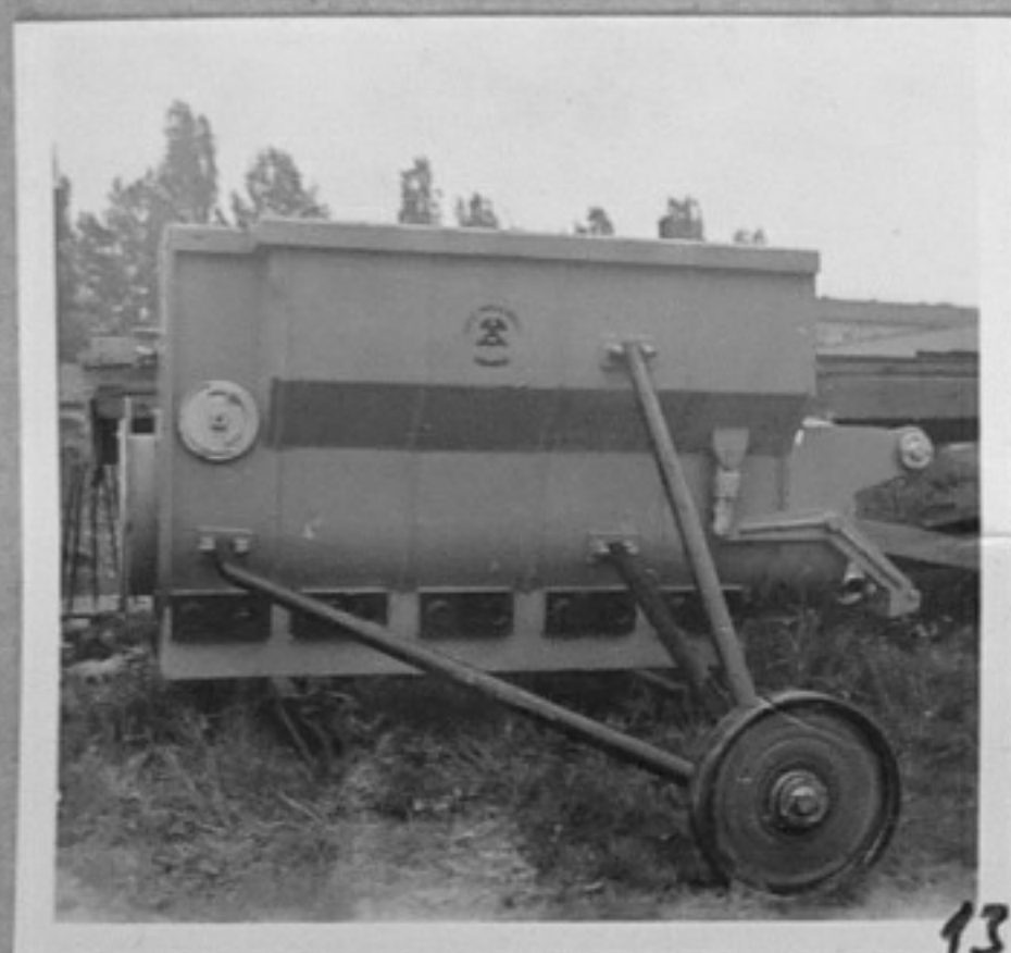
74-2781-13-Тръбна изолационна уредба за асфалтиране на тръби и канали. /А.Бояджиева/ТК
