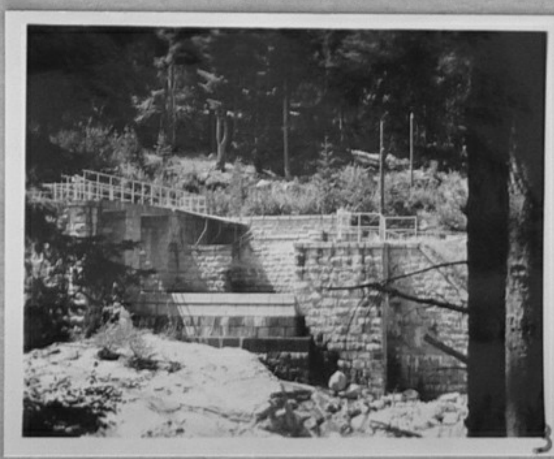
72-4388-3-Водохващането на р. Бели Искър за водоснабдяване на Столицата. /Е.Любомиров/ИК
