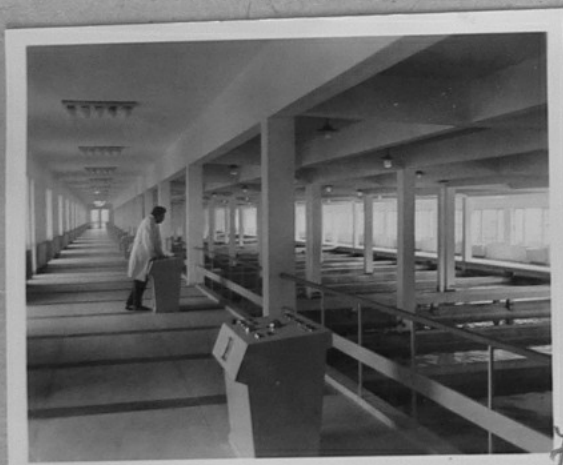
72-4389-7-Пречиствателната станция край Панчарево. /Е.Любомиров/ИК
