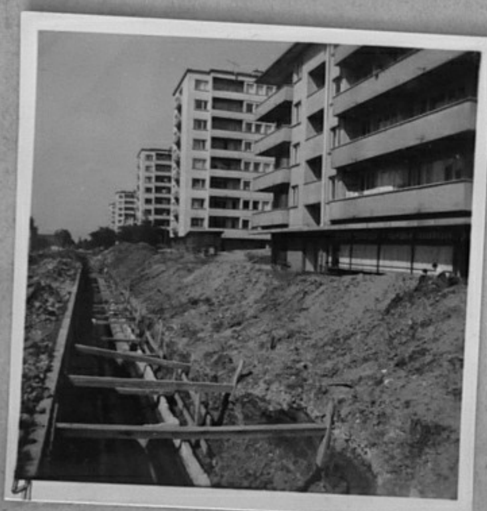
67/2047-4 - Строеж на топлопровод по ул. "Христо Кабакчиев" в комплекс "Гео Милев". /Б.Юскеселиев/ЕИ
