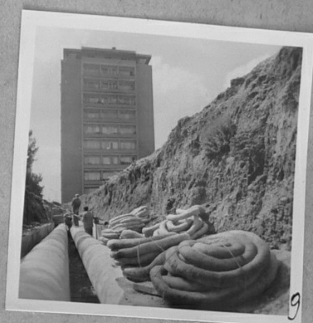
67/2048-9 - Строеж на топлопровод в комплекс "Изток". /Борис Юскеселиев/ЕИ
