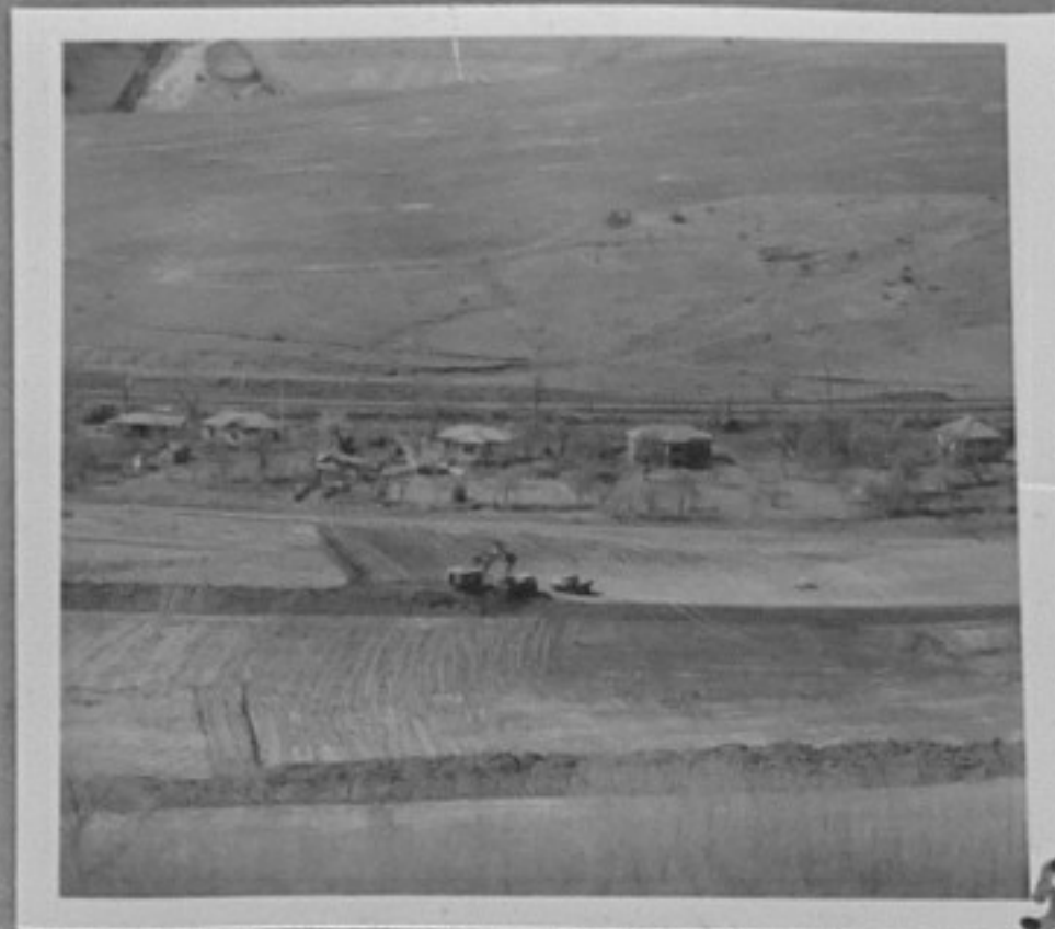
75-1276-5-Строеж на пречиствател- ната станция за гр.Перник. /Крум Арсов/ИК
