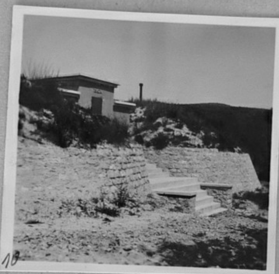
10-Железобетонен водоем за "Златни пясъци".
