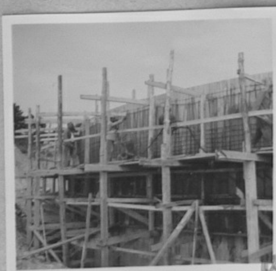
71-4011-8,12-Полагане бетон на I-ви водоем. /Нед. Чобанов/ XII
