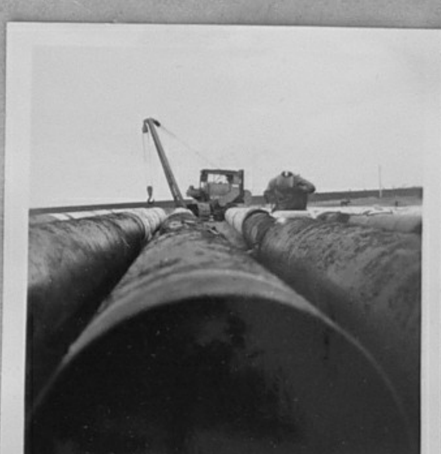
70-3615-2-Заваряване водо- провода на Нефтохимическия комбинат - Бургас. /Д.Стаматова/ ХП
