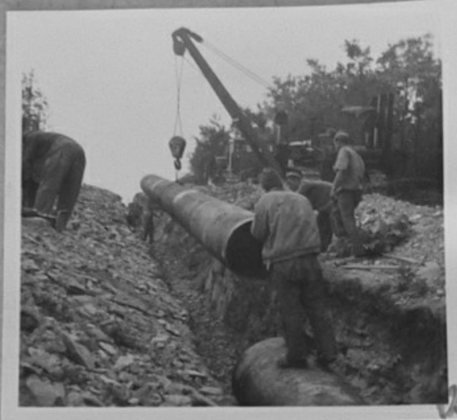
Водоснабдяване на Стара Загора. /Н.Чобанов/ XII 71-4012-7-Заварка на стоманени тръби в канала на водопровода. 71-4012-12-Пренасяне до мястото за полагане на стоманени тръби с тръбоклад.
