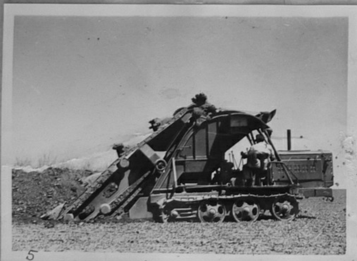
54/1121-5 - Прокопаването на канали за водоснабдяването на Добруджа става механизирано. /ММ/
