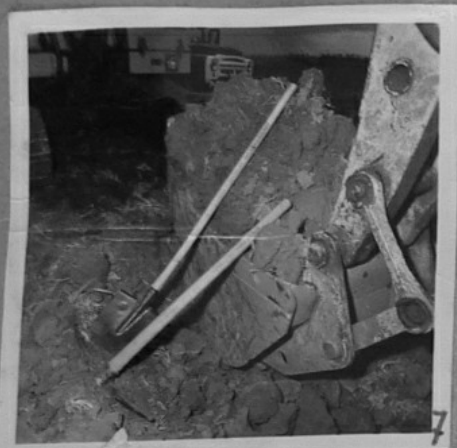
74-4786-7-Трите инструмента, с които е направена първата копка на строежа на пречи- ствателната станция за отпадъчни води -София. /О.Юскеселиев/ТК
