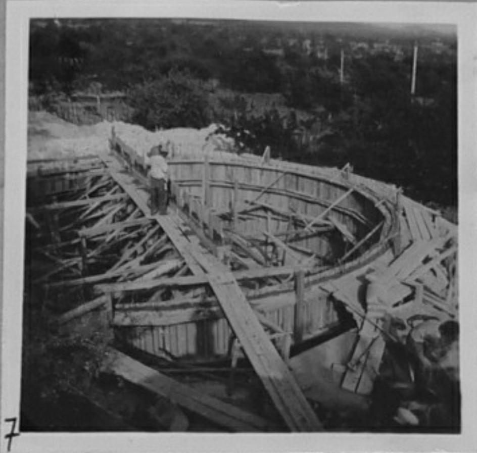
4,7 - Строеж на кръгъл железобетонен водоем с вместимост 500 м за IV водоснабдителна зона на Варна.
