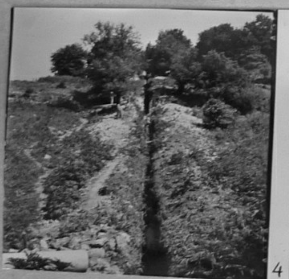
56/1437-4-Поставяне на тръбопровода за помпената станция край местн. "Демир баба". /Абаджиев/ ММ
