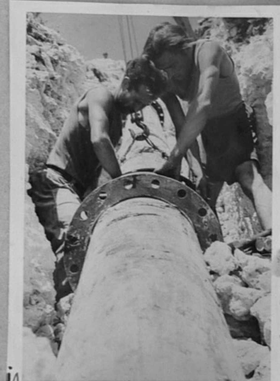
56/69-13,14,16 - Моменти от прокопаването на водопровода, направен за помпената станция при село Оброчище, Балчишко. /Абаджиев/ ММ
