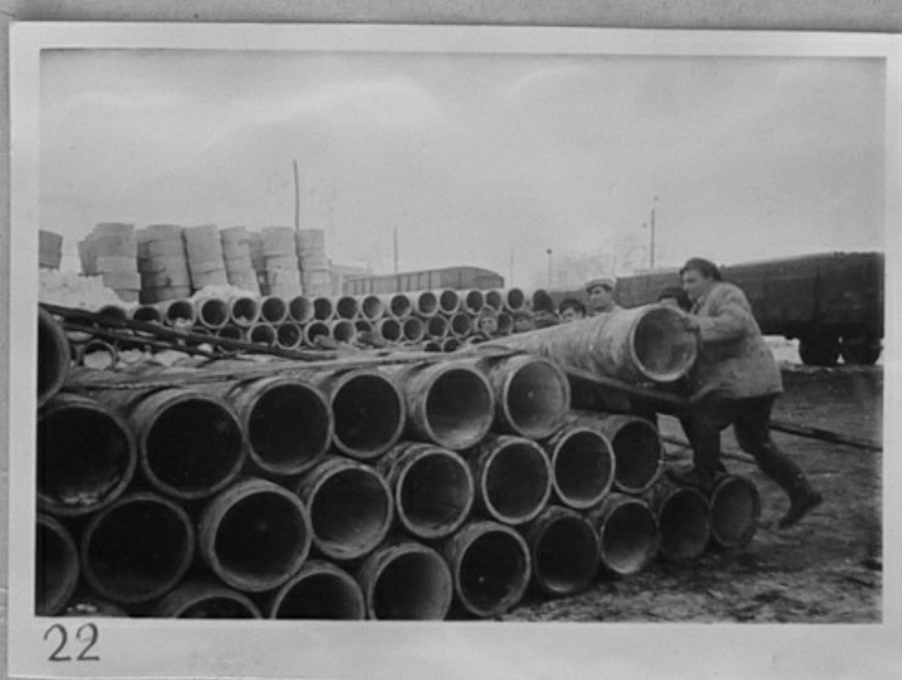
56/69-22 - Депото край гр. Толбухин за складиране и разпределение на етеритовите тръби, използвани при изграждането на водопроводните мрежи в Добруджа. /Абаджиев/ ММ
