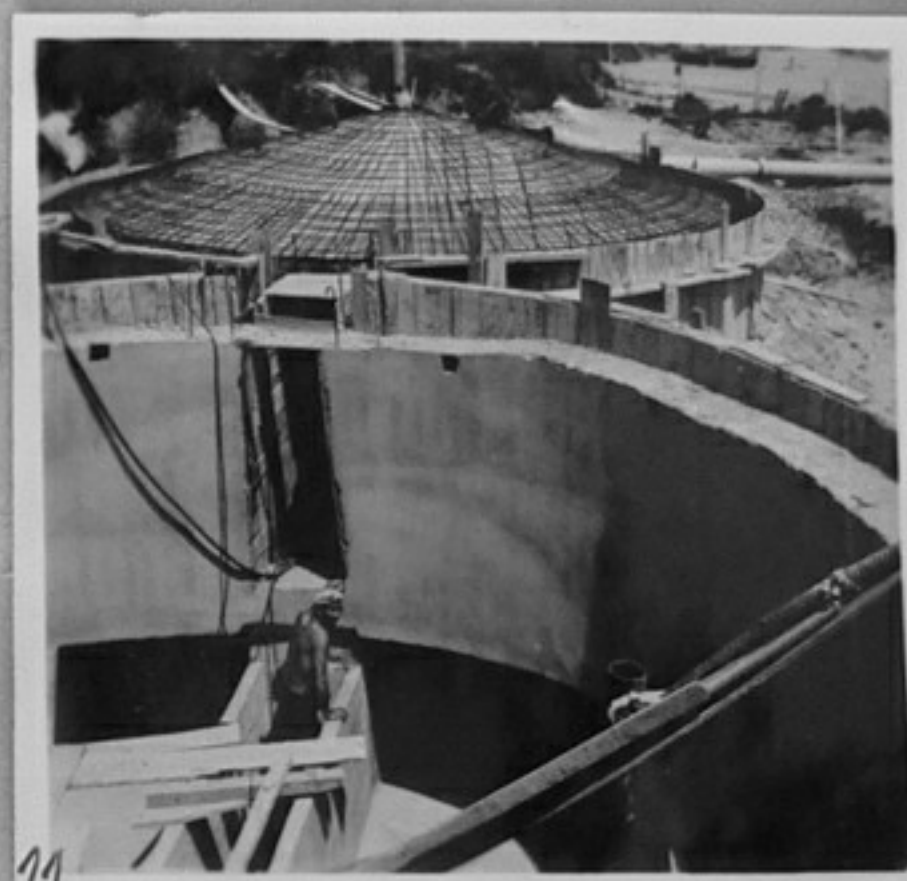
11-Строеж на прочиства-телни съоръжения за "Златни пясъци".
