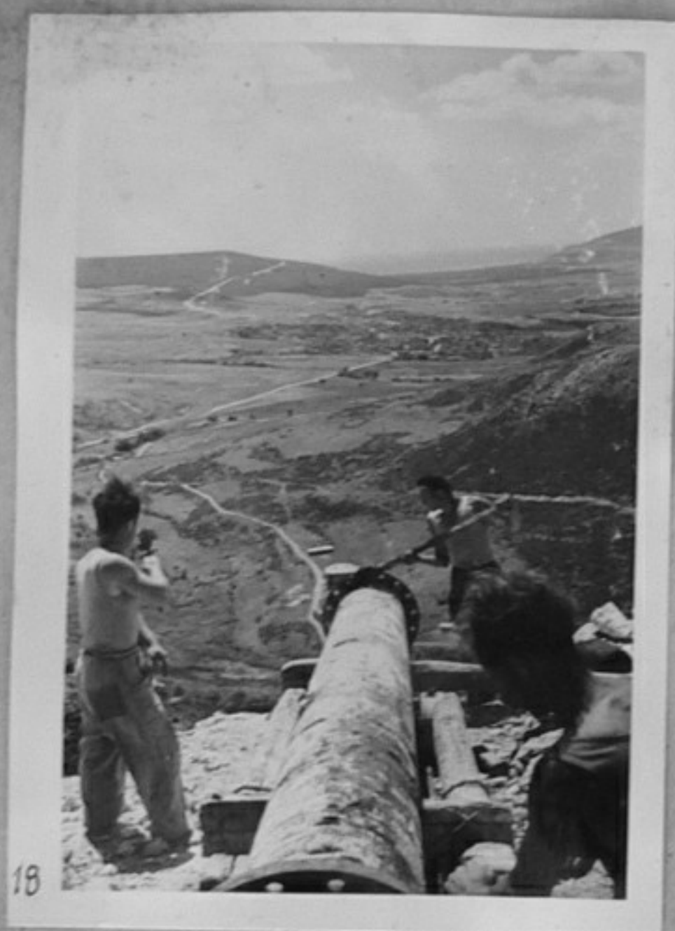
56/70-18,19 - Отделни моменти от построяването на водоснабдителната мрежа в местността "Оброчище", Балчишко. /Абаджиев/ ММ
