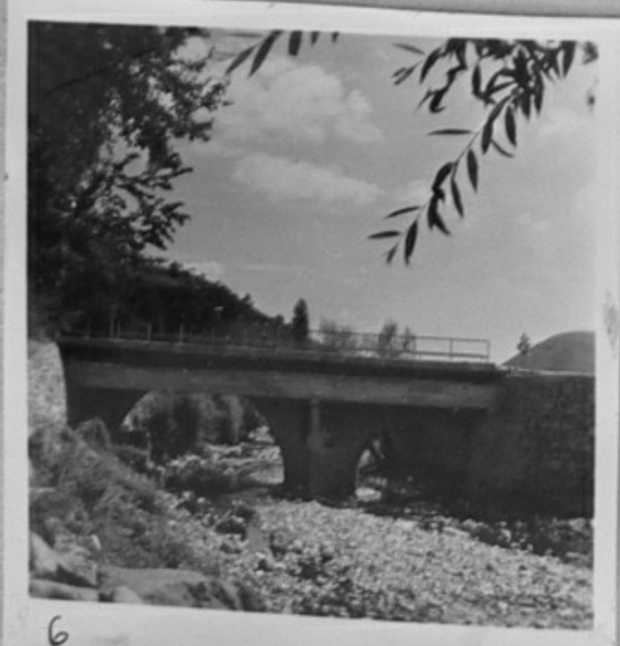
6-Сандък на водопровода при преминаване на моста на р. Бяла в гр. Устово.
