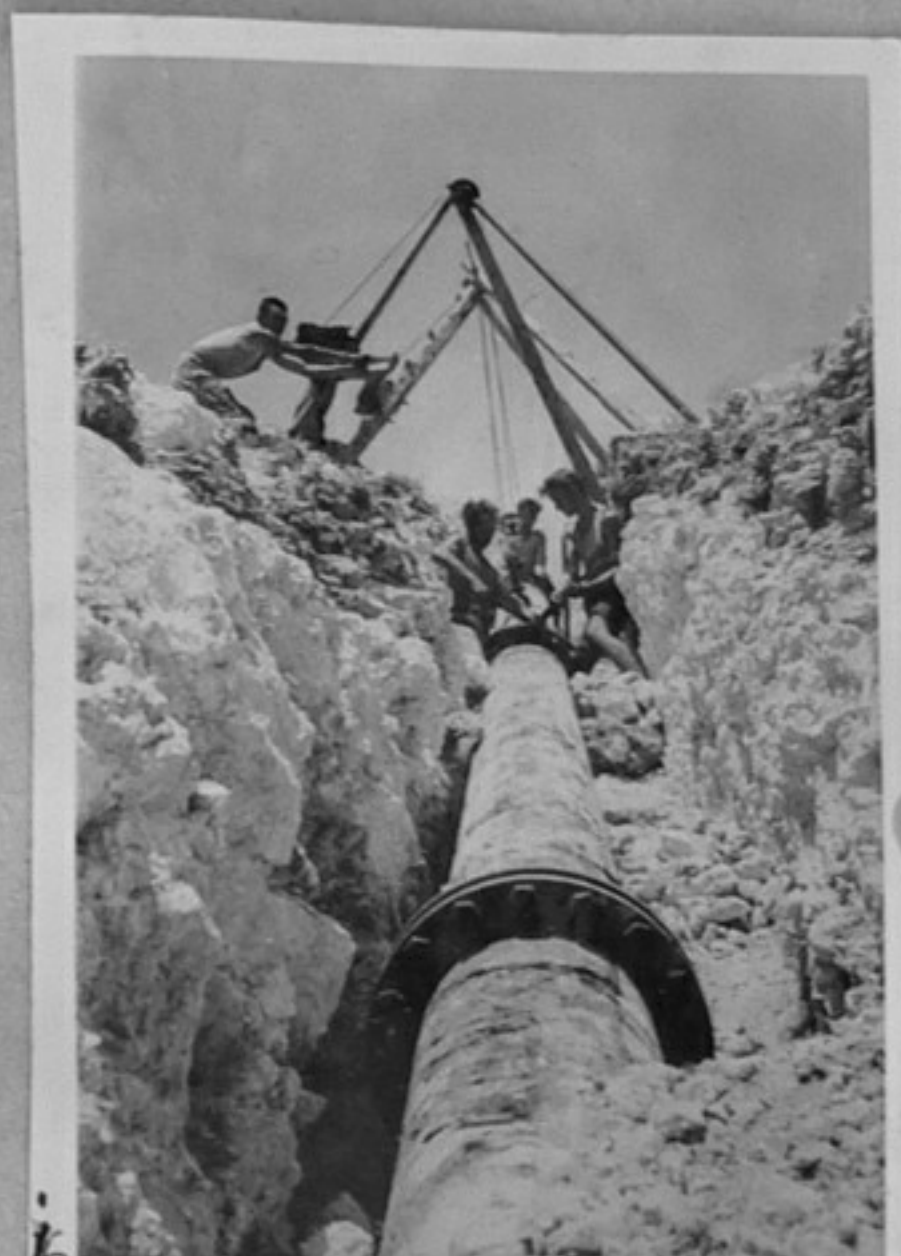
56/69-13,14,16 - Моменти от прокопаването на водопровода, направен за помпената станция при село Оброчище, Балчишко. /Абаджиев/ ММ
