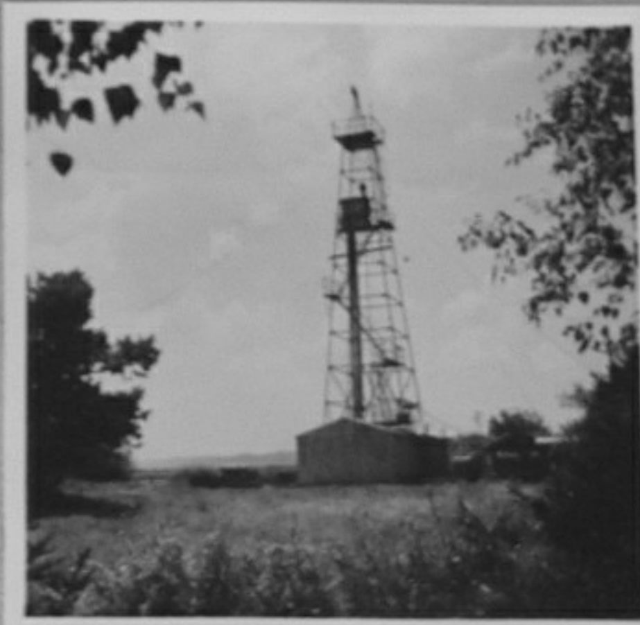
66/2279-8 - Сливен - сонда ЗИФ-1200 работи близо до Сливенските минерални бани под ръководството на инж. Стоян Христов. /Хорисан/ ЕИ
