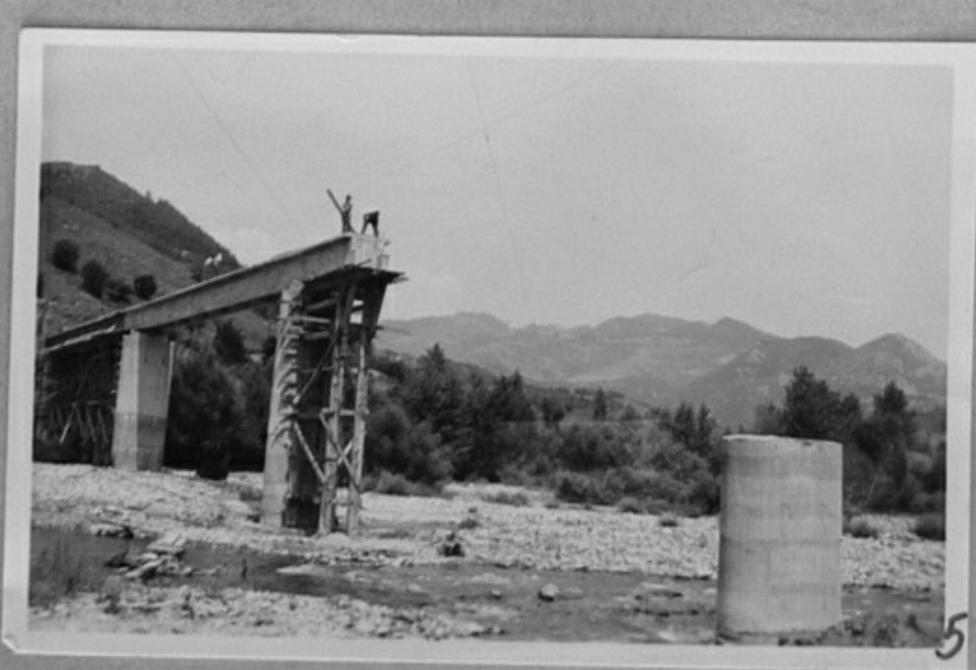
69-2671-5-Строеж на топлопровода, който ще отведе топлината минерална вода от землището на с. Беден до град Левин, Смолянски окръг. /Т. Симсонов/ ИК
