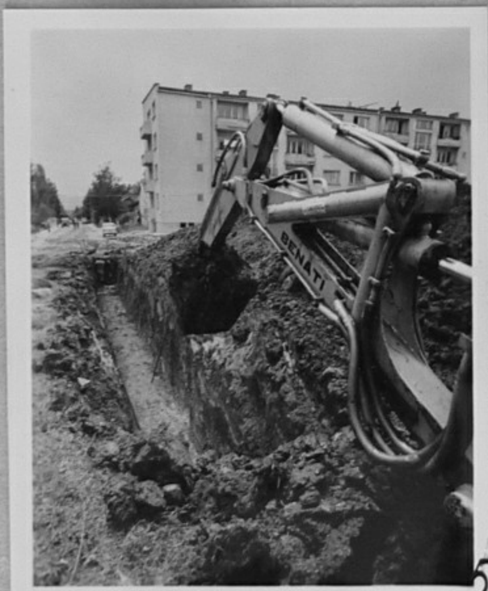
67/2044-5,8 - Строеж на топлопровода в кв. "Изток" /Борис Юскеселиев/ЕИ
