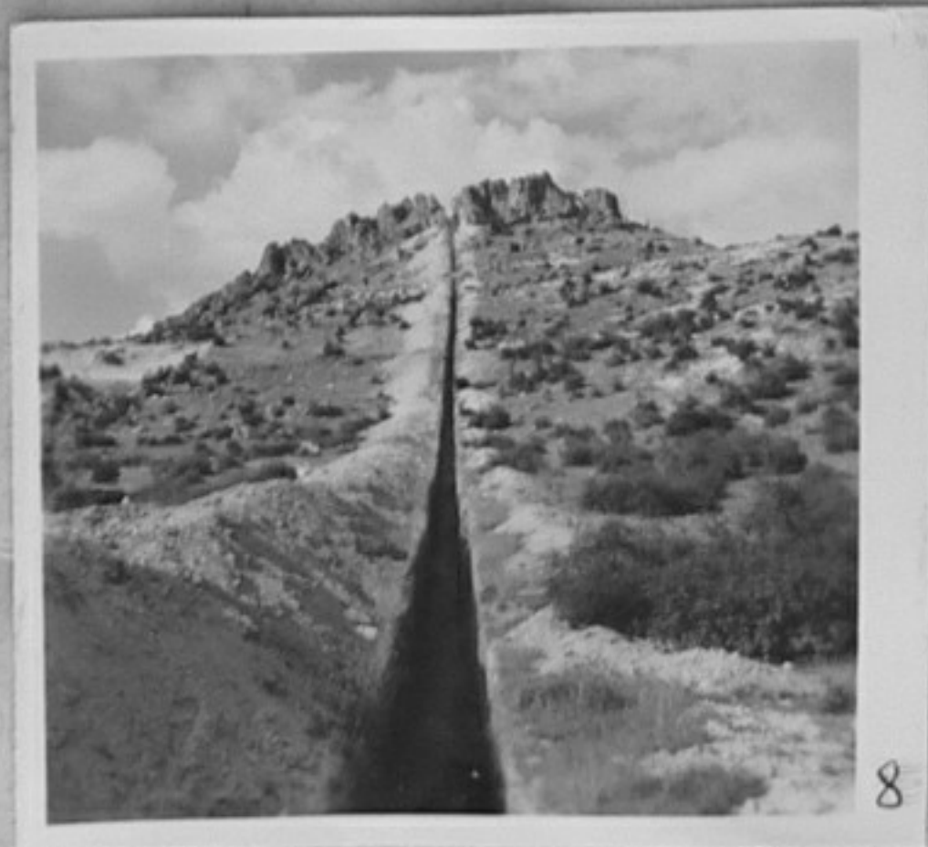
57/2909-8-Строеж на водопровода Девия-Варна. / Парушев / ММ
