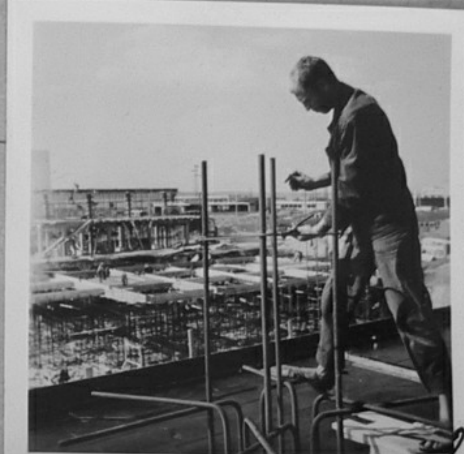
66/2284-2 - Димитър Шопов армира колона на главния производствен корпус. /Хорисян/ ЕИ
