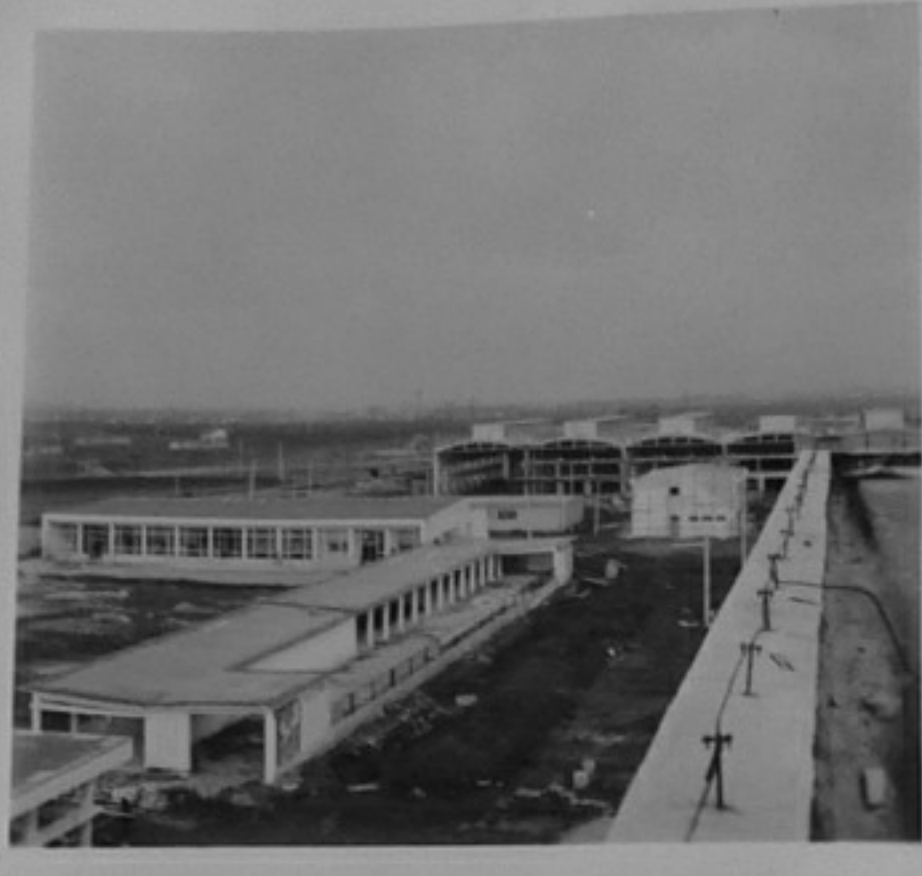
67/322-8 - Ремонтно механичният цех. /Симеонов/ЕИ
