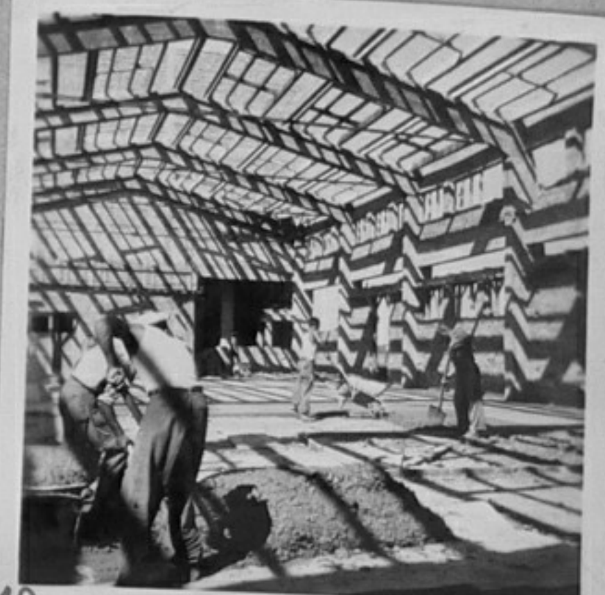
9,10 - Бетонджийската бригада на Сали Исмаилов излива бетонния под на материално-снабдителния склад.
