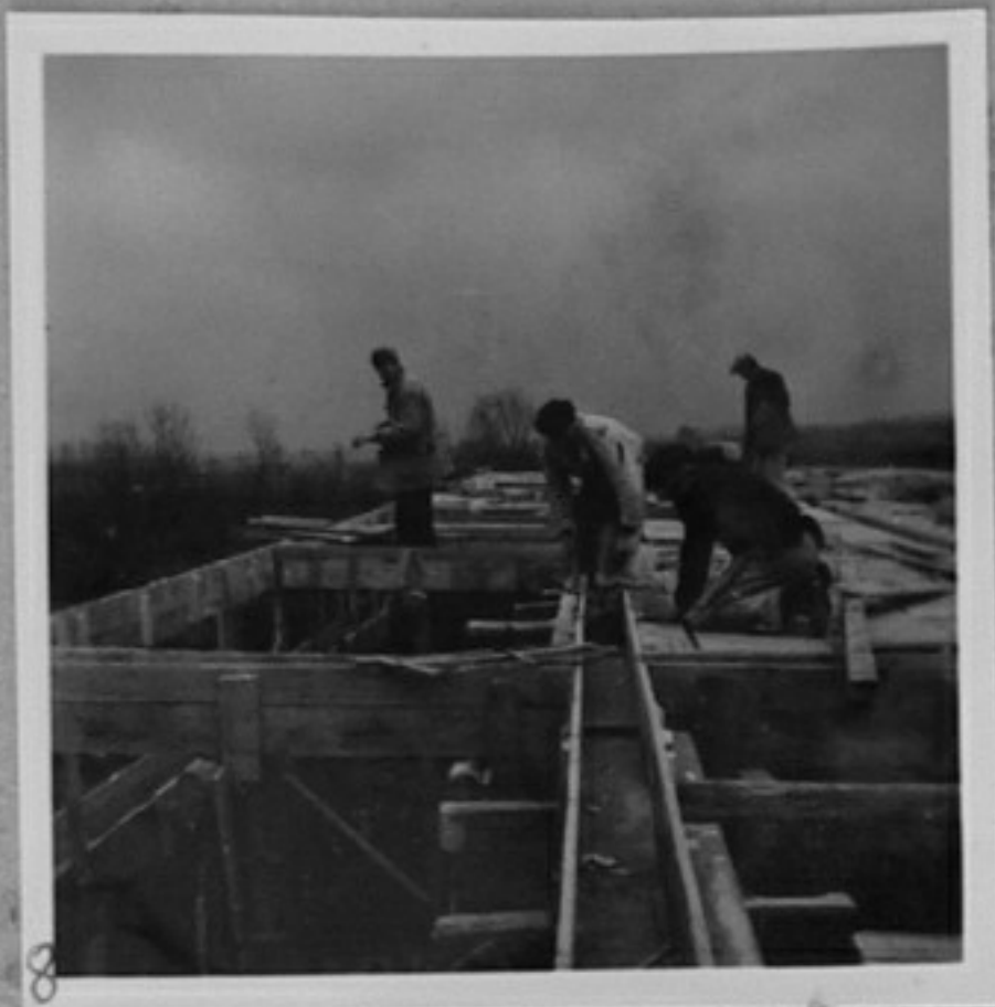
59/3483-3-Кифража за изливане на покривната плоча на цеха за материяли. /Янев/
