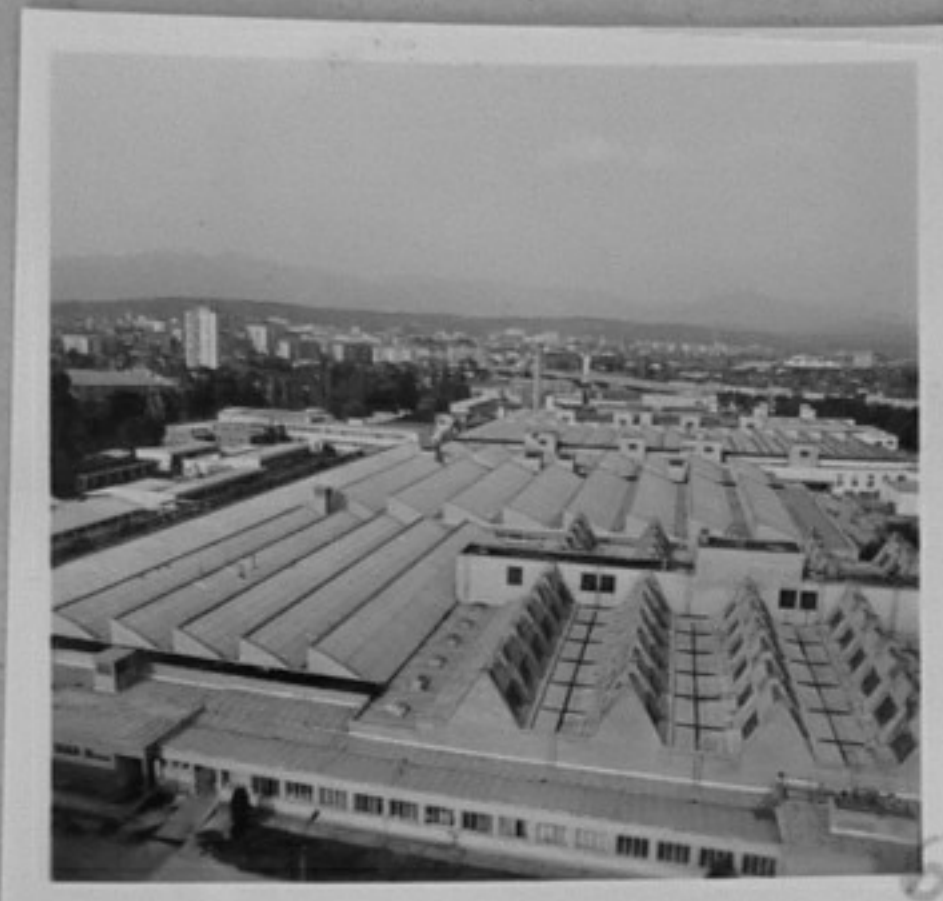
79-2000-6-Външен изглед на комбината. /В.Балевска/АШ
