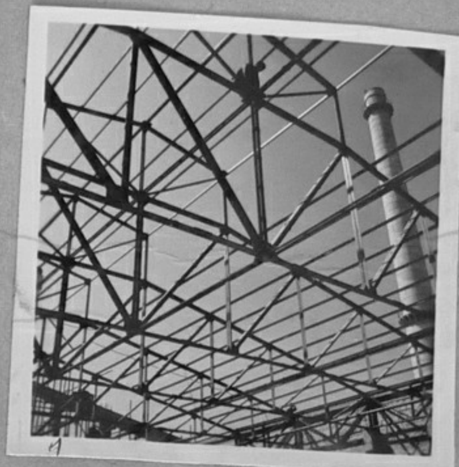
60/2906-1-Покриват на главния корпус на завода в строеж. /Хорисан/
