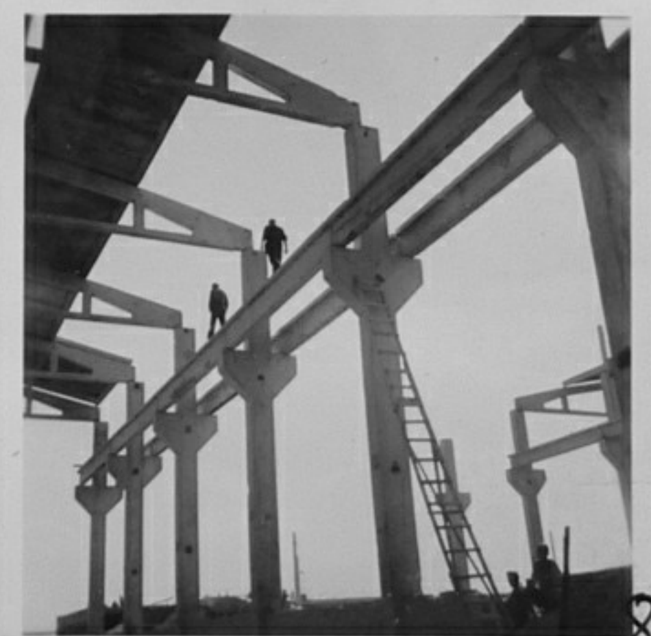
66/2285-8 - Из строежа на ремонтно механичния цех. /Хорисян/ ЕИ
