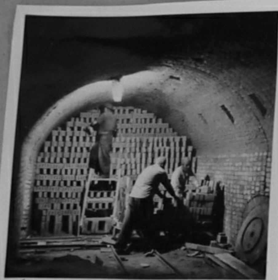
4-Новата рингова пещ с два тунела с непрекъснат технологичен процес-заредане на пещта със сурови тухли-керамичен завод - гара Разделна.
