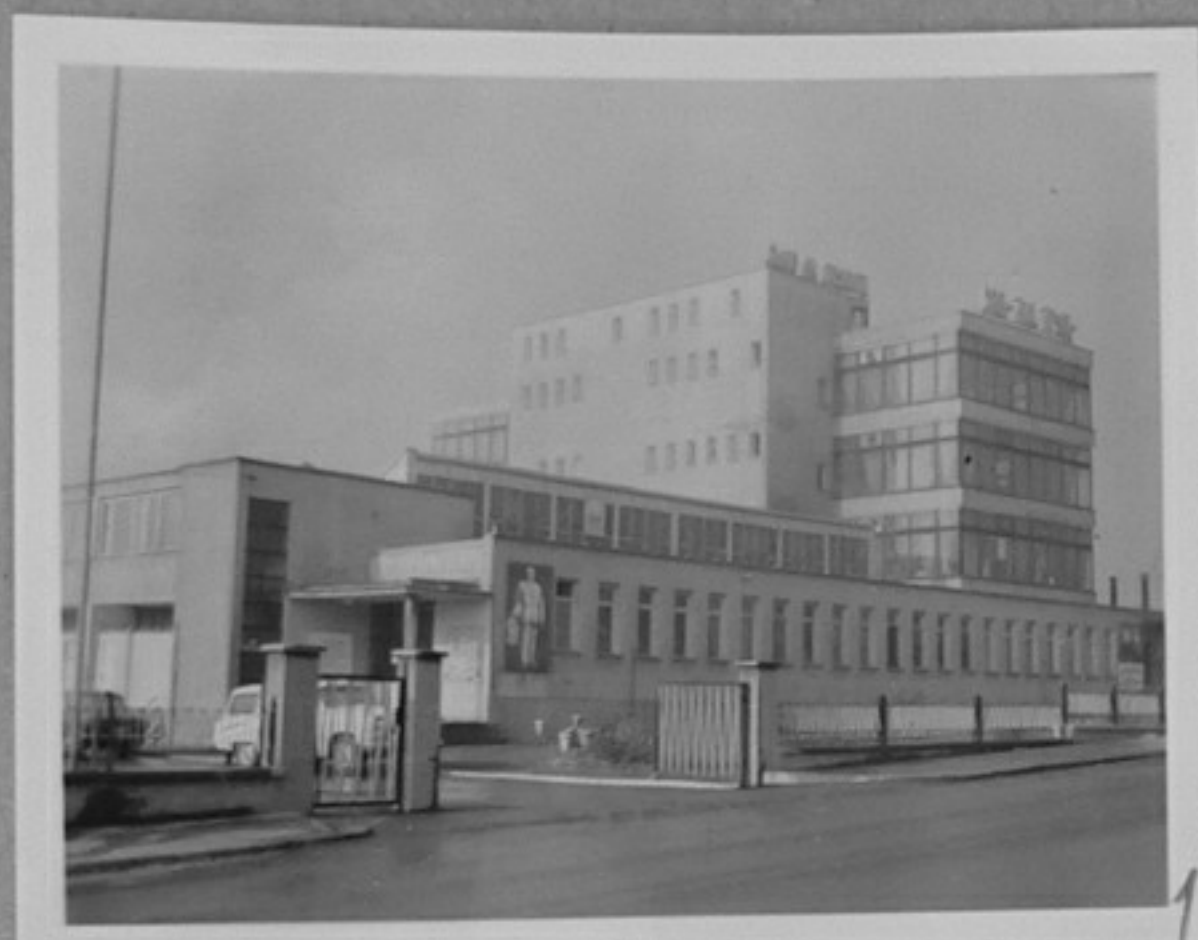
74-323-1-Външен изглед на производствения цех към завода. /Н. Чобанов/ТК
