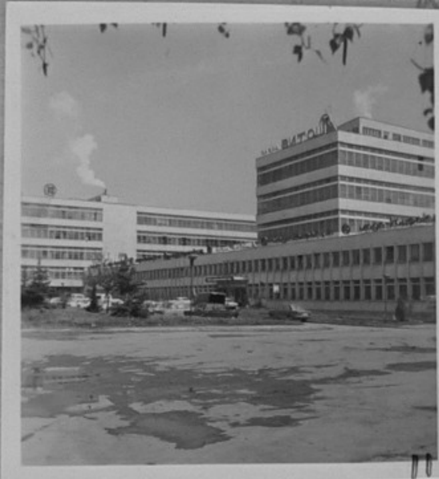
78-1132-11 Външен изглед на завода В.Балевска/МД
