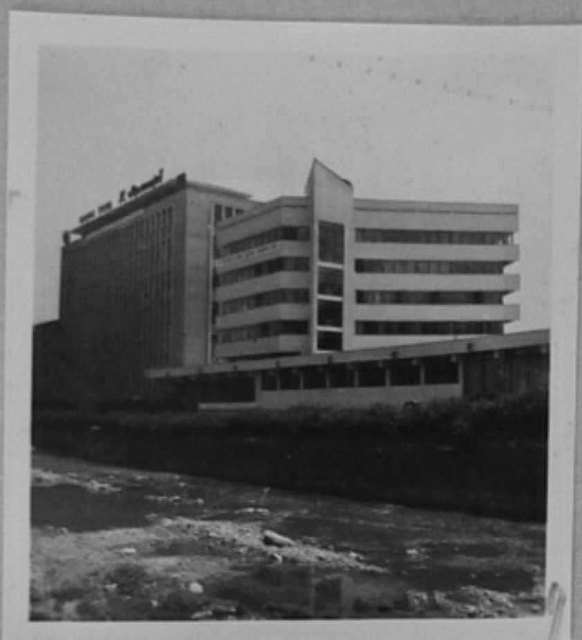
72-2931-9-Сградата на завода. /Е.Богоев/МК
