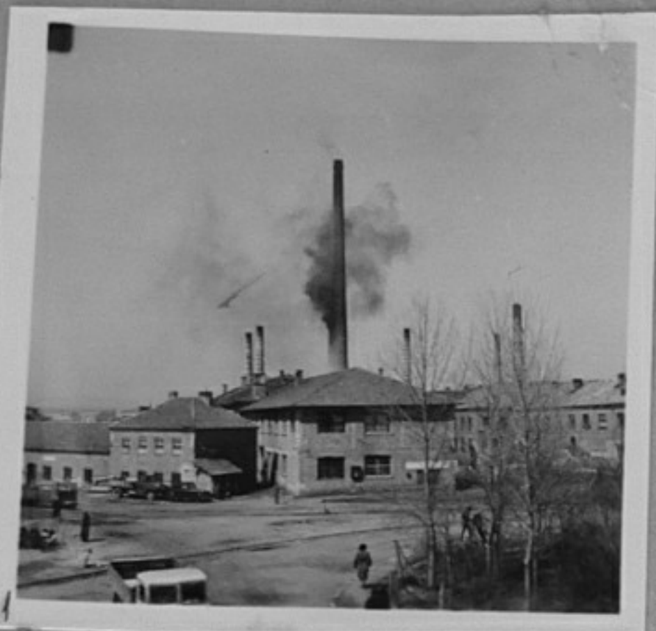
58/1105-11-Външен изглед. /Парушев/
