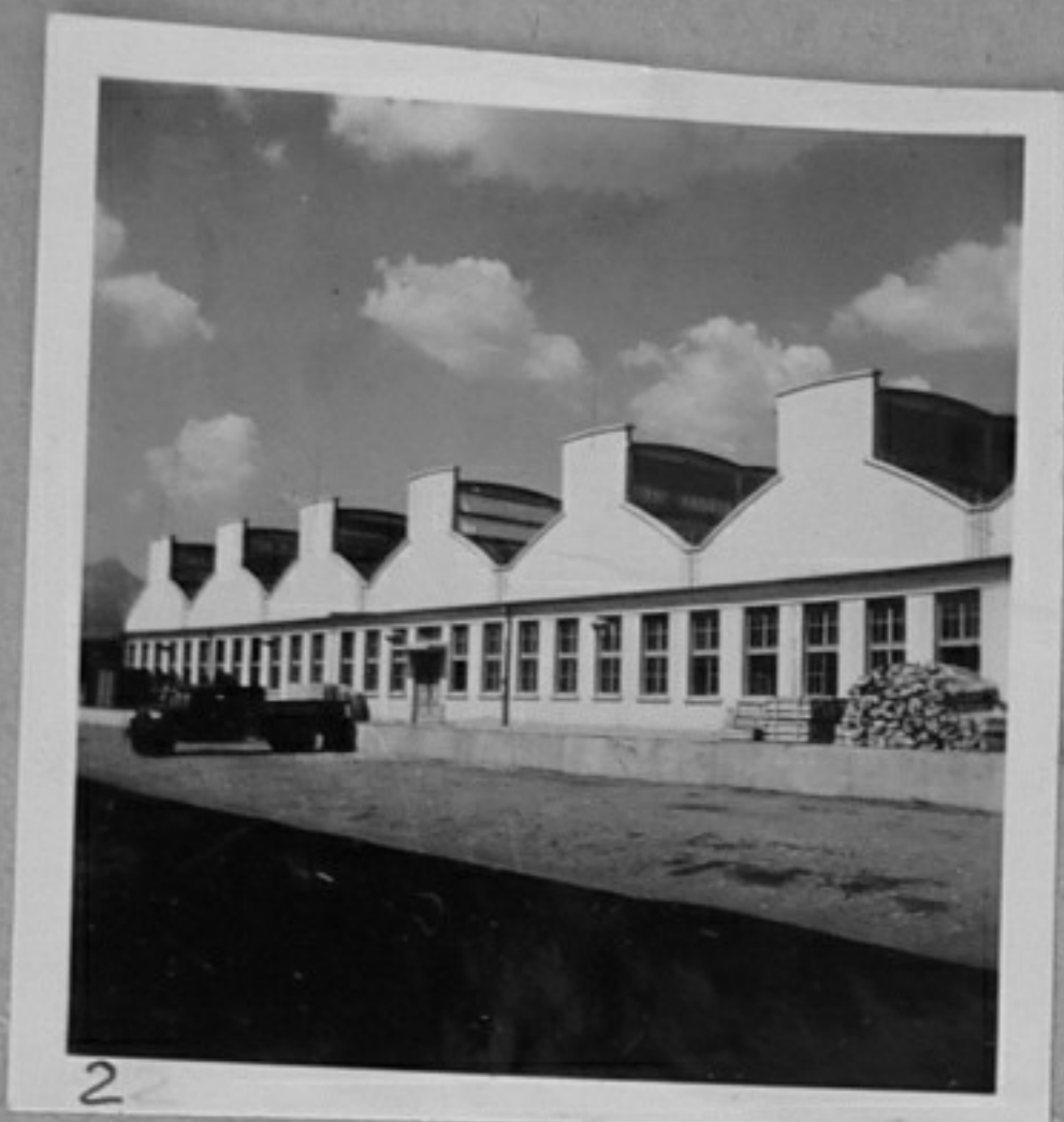
2 59/1877-2-Външен изглед на апретурния цех./Хорисян/
