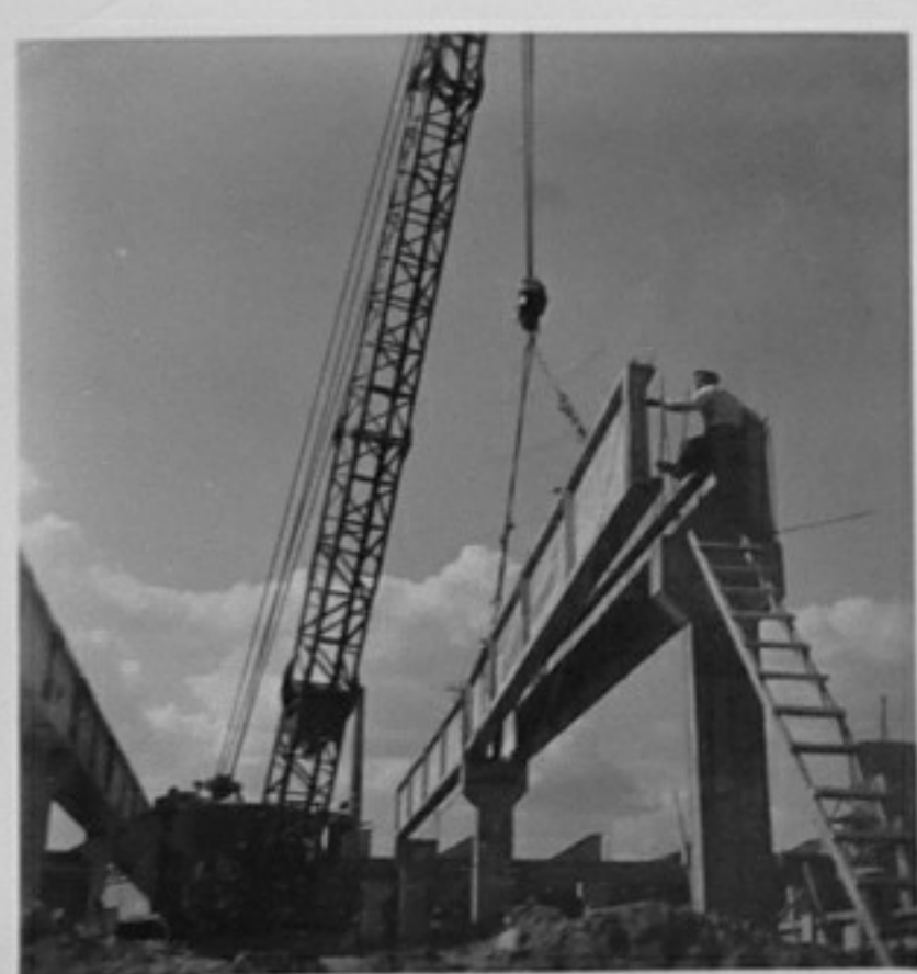
12-Поставяне вибробетонни елементи с багер.
