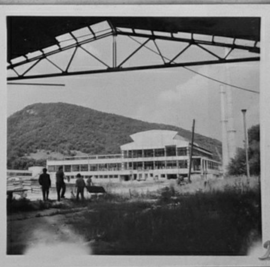
74-3073-2-Строежът на завода. /Т.Хорисян/ИК
