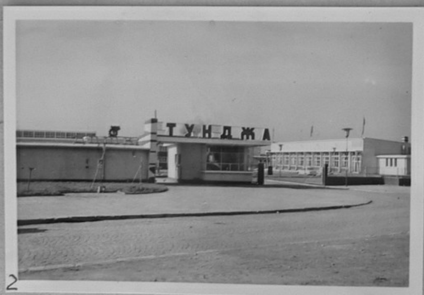
63/2835-2- Входът на новия комбинат./Д.Янев/ ЕН.
