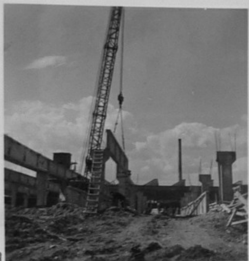
9-Електроженистът П.Тодоров заварява сглобените вибробетонните елементи.
