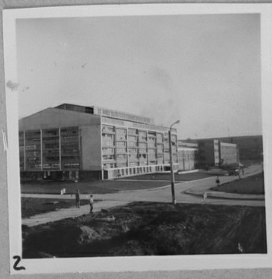
66/3445-2 - Изглед от завода. /Зиновиев/ ЕИ
