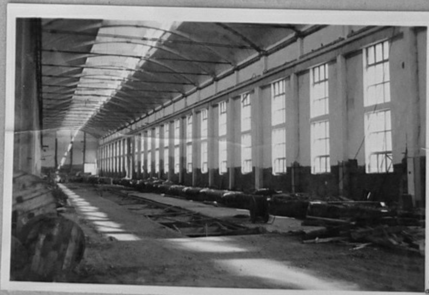
59/2853-2-Вътрешен изглед на новата сграда на пресовачния цех на завода. /Янев/
