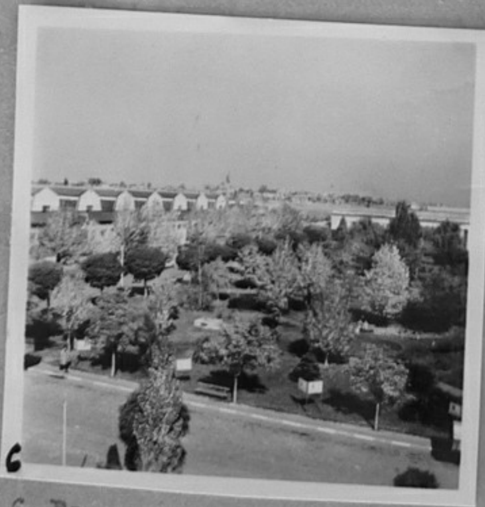
6-Външен изглед на завода.
