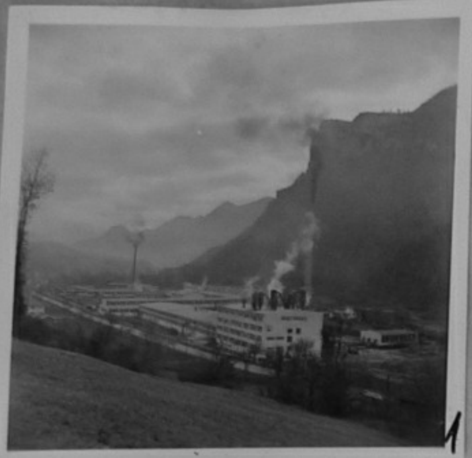
67-4069-1-Общ изглед на целия завод. /Здравка Минчева/СС
