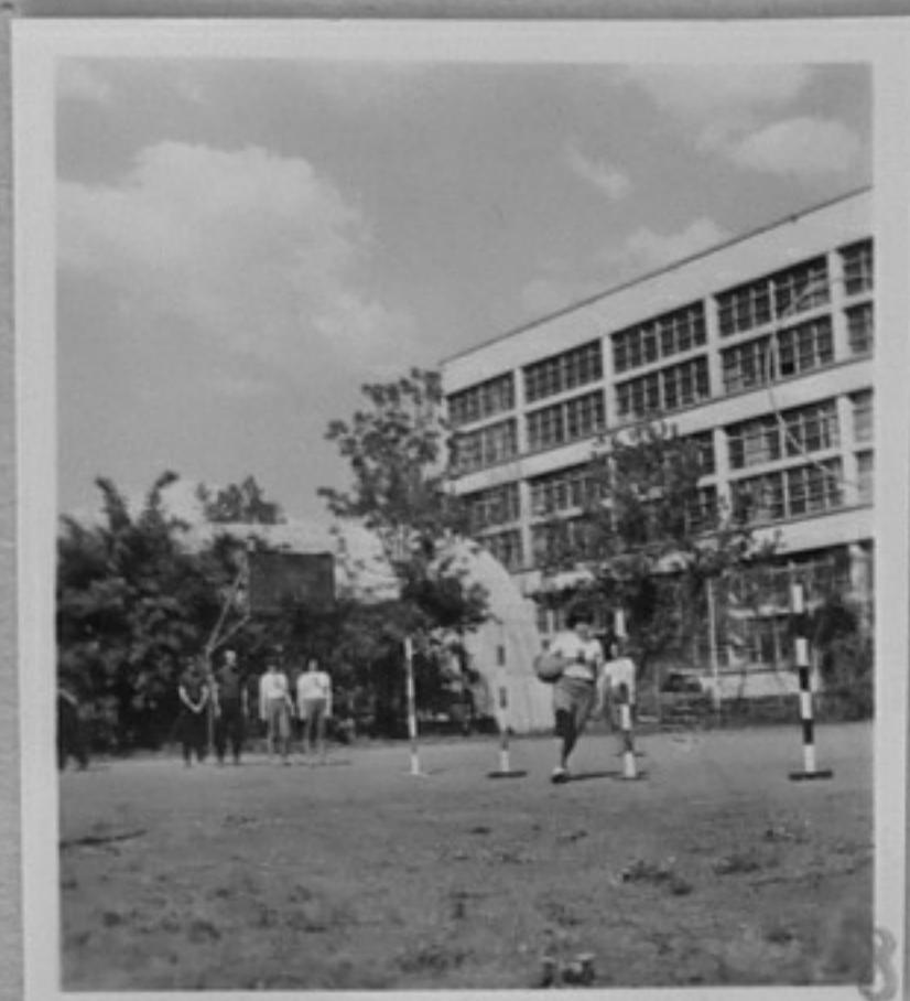
79-1509-8-Сградата на За- вода за телеграфна и те- лефонна техника, гр.София. /В.Балевска/АШ
