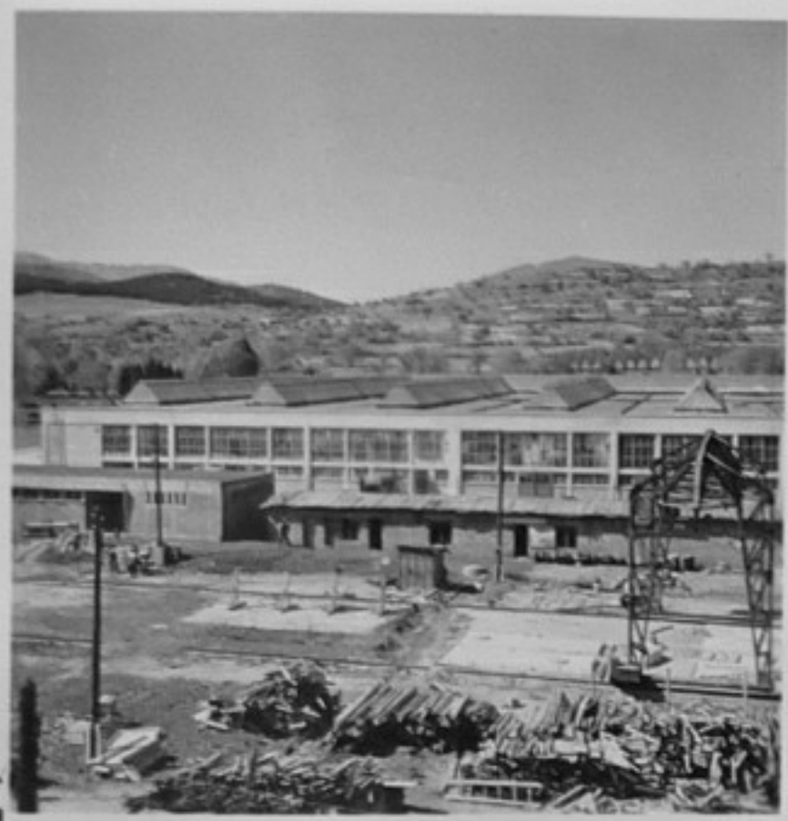
6-Нов ремонтно-механи- чен цех.
