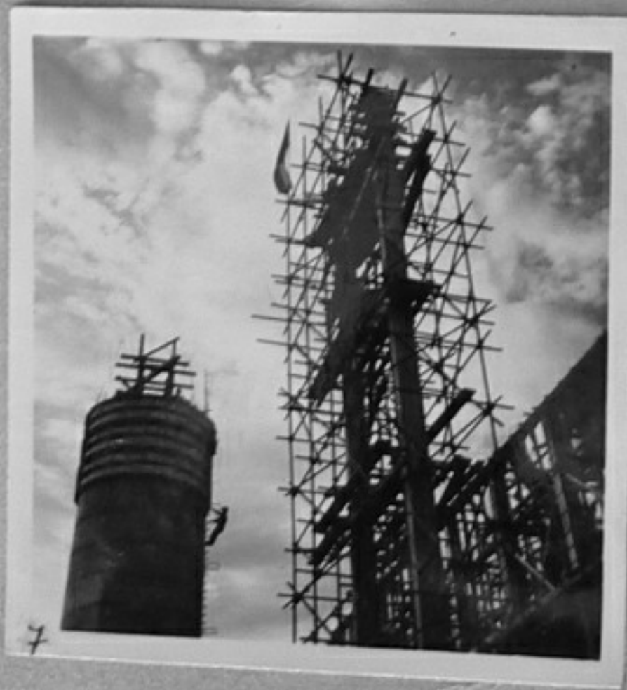
7- Строеж на кумина на парната централа.
