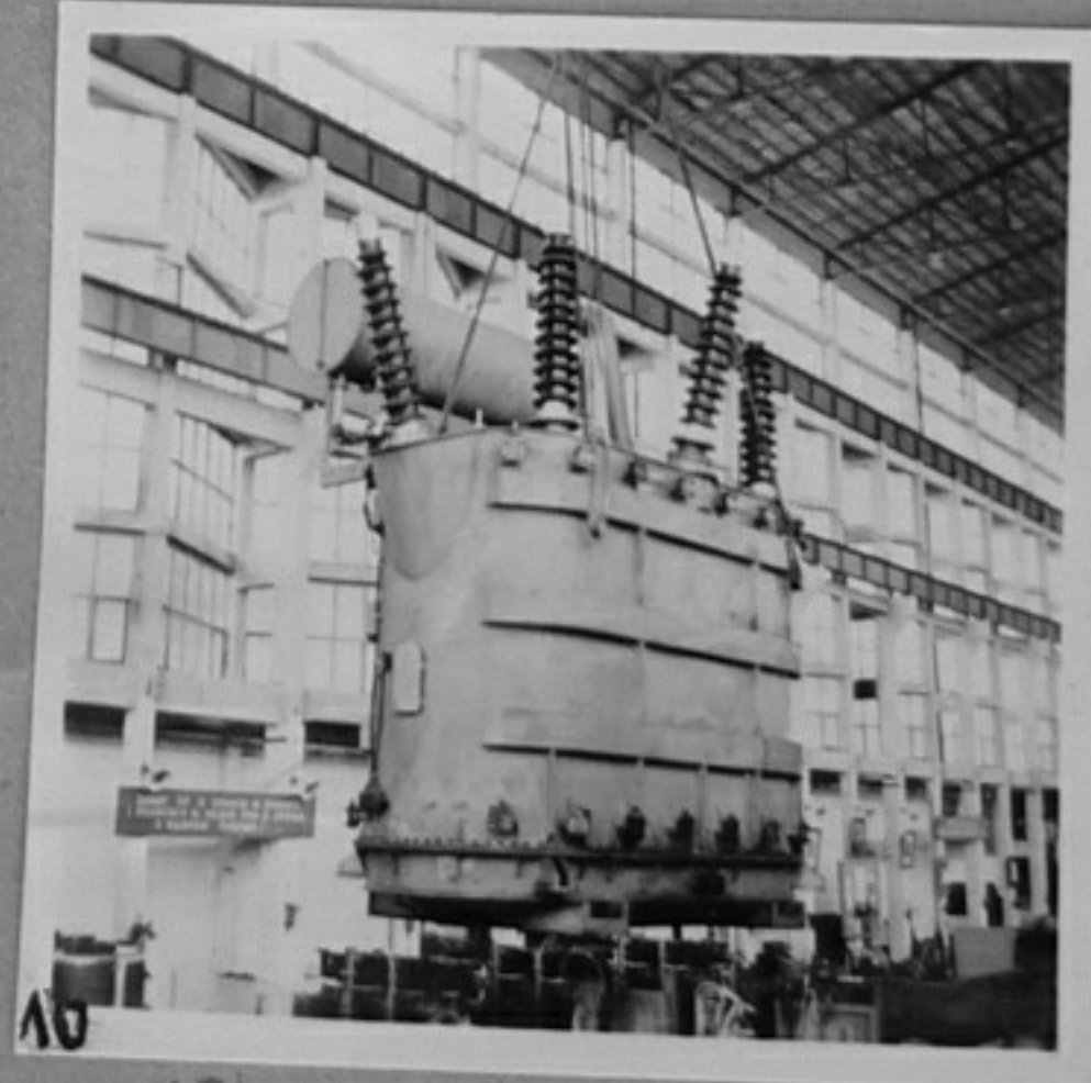
10-Трансформатор 12,000 KVA по време на монтаж.
