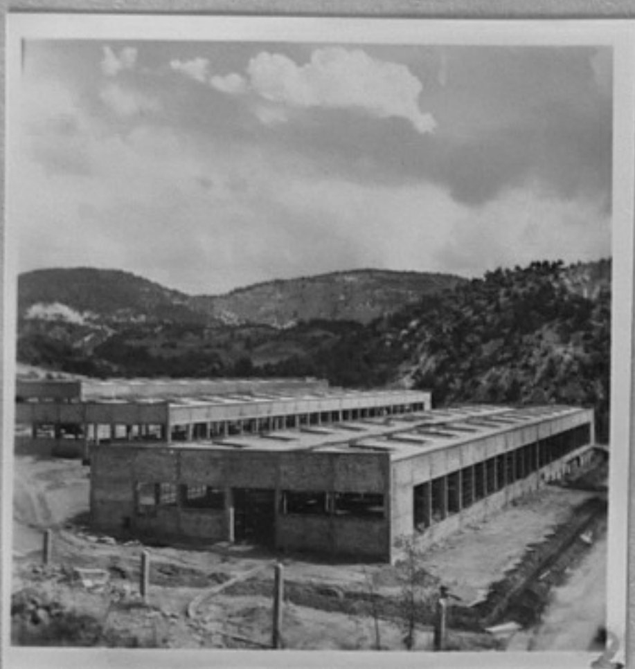
72-4092-2-Строителството на кабелен завод в Смолян. /Т.Хорисян/МК
