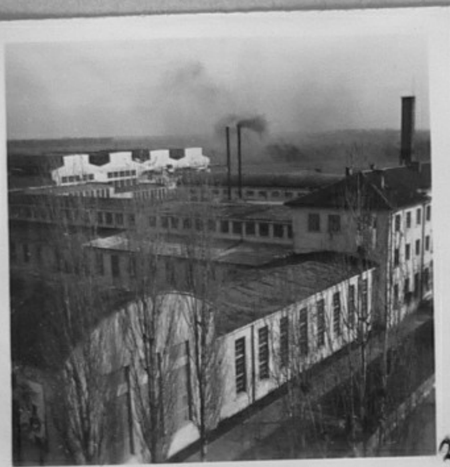
68-462-3-Общ изглед на завода. /Георги Бурмов/СС
