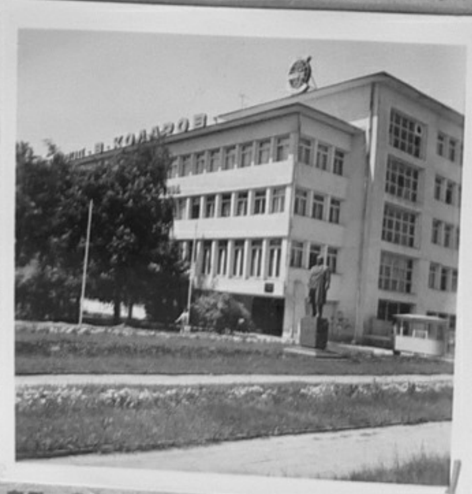
73-2248-1,3 - Сградата на завода. /Т.Симеонов/ ЕИ
