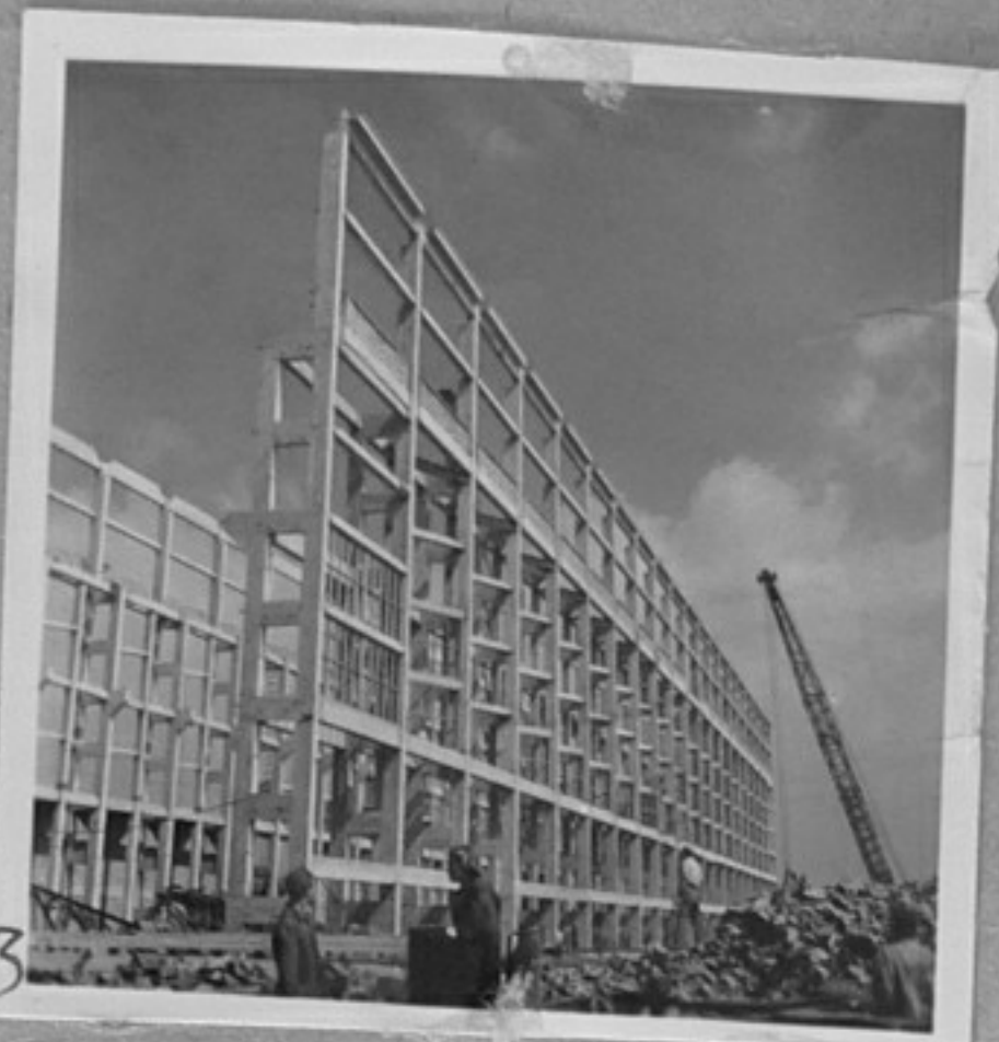
60/2698-2,3 -Строеж на новия трансформаторен цех в завода. /Попов/
