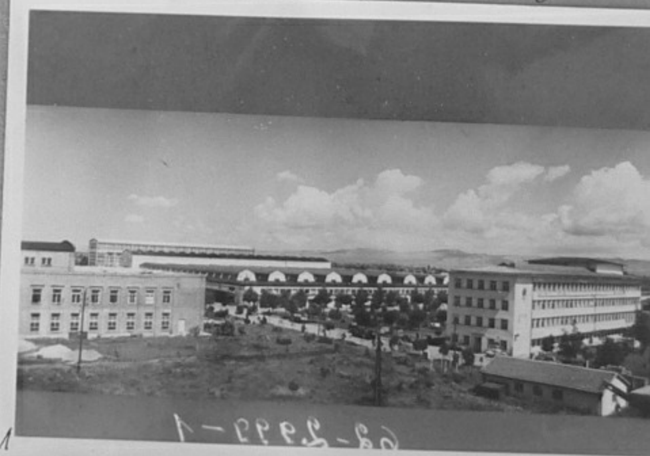
62/2999-1-Външен изглед на завода. /Чаръкчиев-монтаж/.
