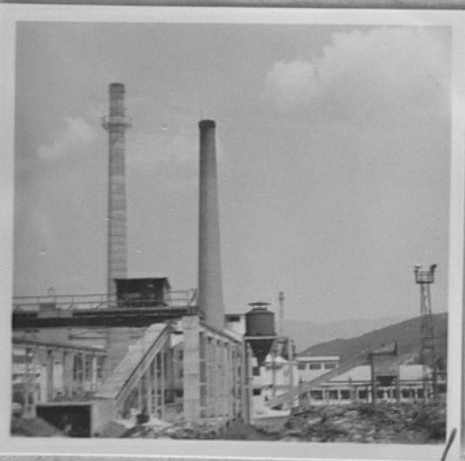
70-2109-1-Външен вид на завода. /Крум Арсов/ ИК
