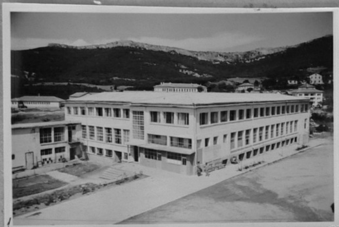
64/1647-1- Изглед на завода. /Л. Томов/ЕН
