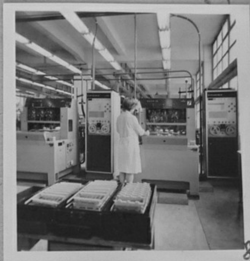
83-1348-8-Автомат за опро- водяване на касети за елек- тронни автоматични телефон- ни централи ЕСК-400 Е. На снимката: работничката Слав- ка Николова, ударник, най-до- бър в професията.
