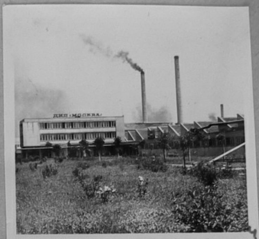
70-2030-4-Общ вид на завода. /Крум Арсов/ ИК
