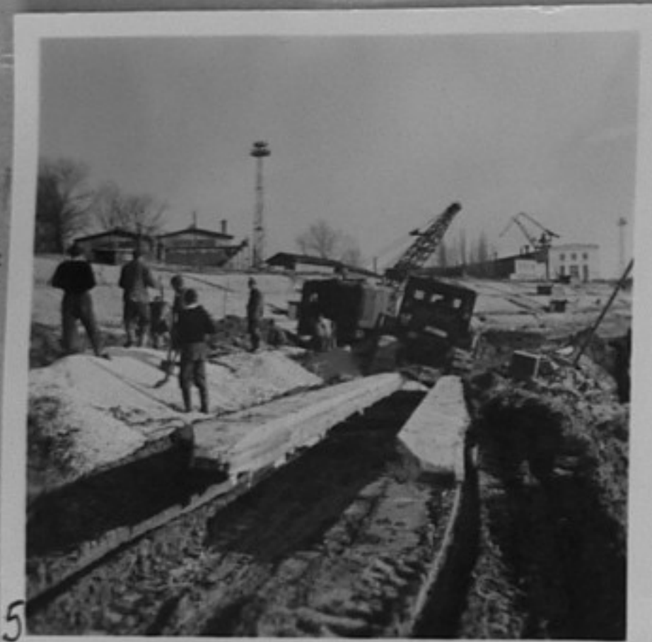
5- Превозване със шейна на железобетонните пилоти за шпунтовите огради.
