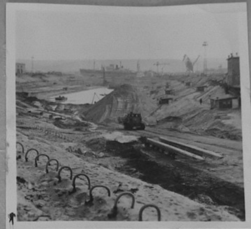
65/464-1- Общ изглед на площта, която се отводнява за построяване на две докови камери за разшир. на завода. /Р. Парушев/ ЕН
