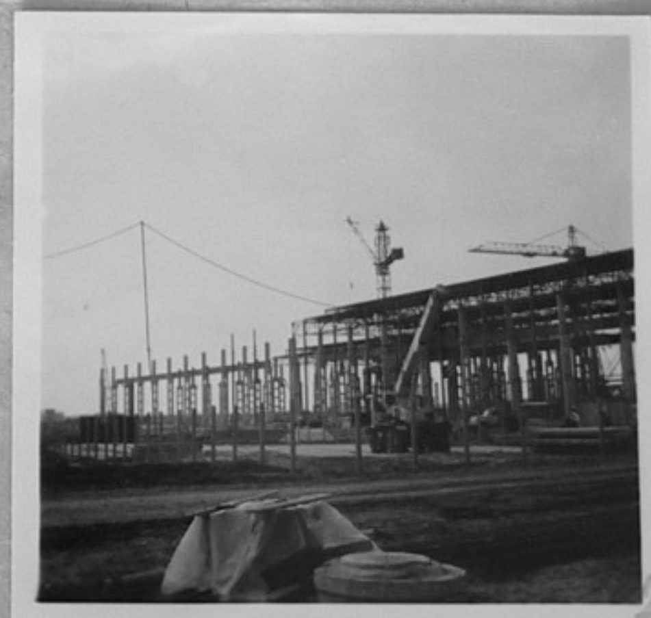
79-1015-2-Корпусът на Механо-монтажен цех. Монтиране на метална конструкция. /М.Георгиева/АШ
