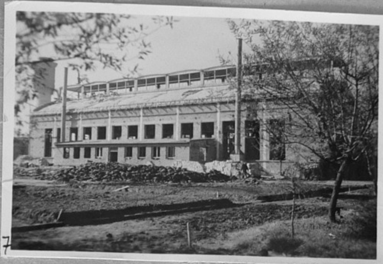
59/2850-7-Строеж на ковашкия цех. /Страхинов/
