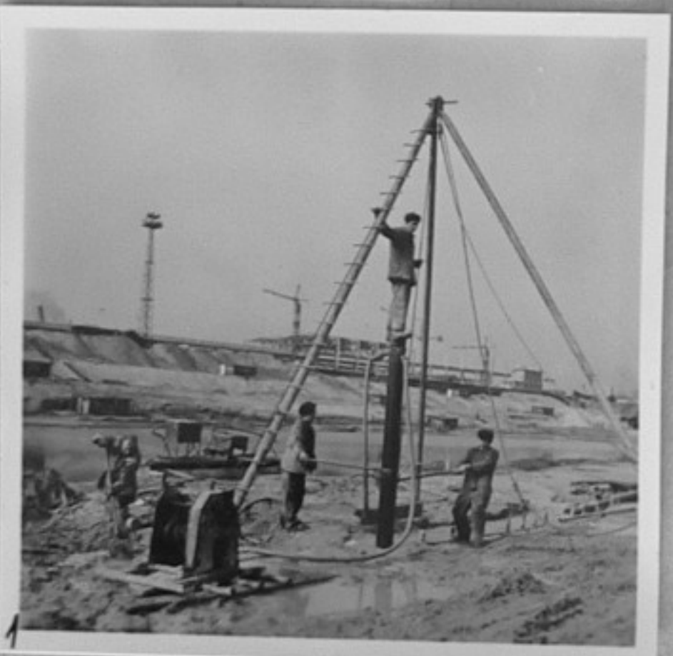
1, 6, 11 - Етапи от набиването на иглофилтри за изпомпване на подпочвени води.
