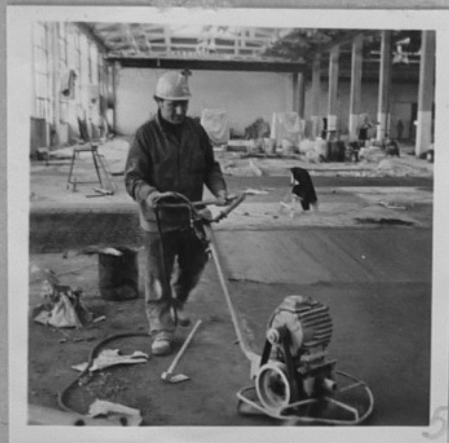
79-1013-5-Иван Великов, звеновод от бригадата на Асен Китанов. Същият из- пълнява операцията шлай- фане на бетонова настил- ка. /М.Георгиева/АШ
