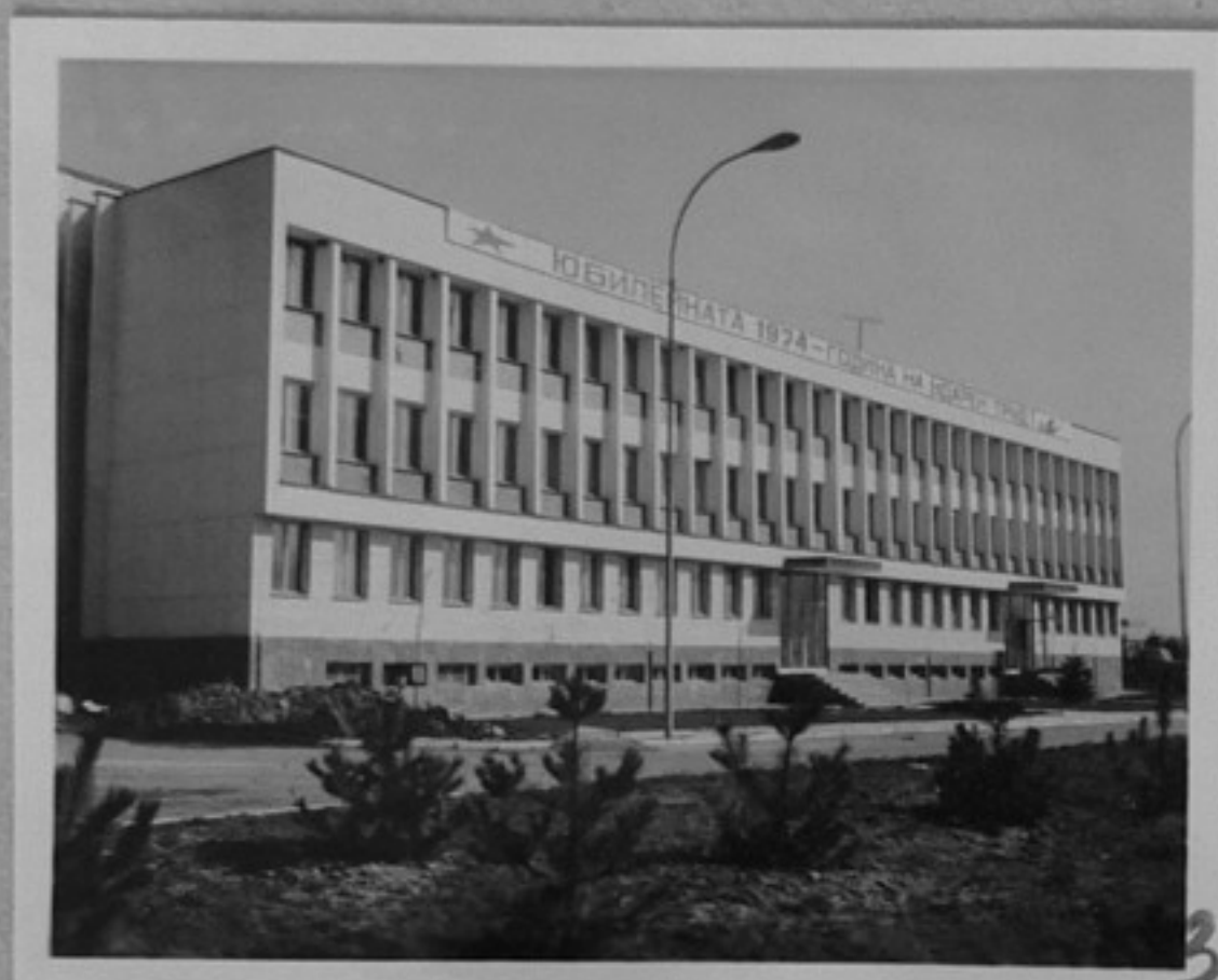
74-1104-3 - Външна снимка на завода.
