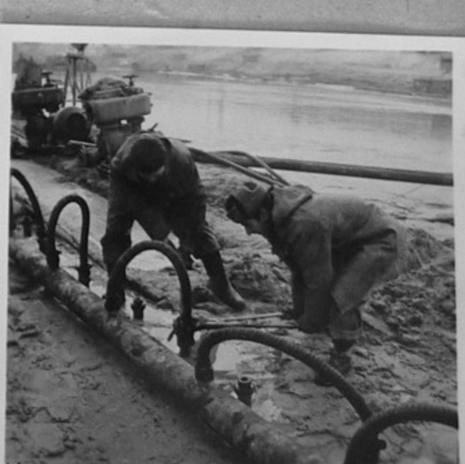
1, 6, 11 - Етапи от набиването на иглофилтри за изпомпване на подпочвени води.
