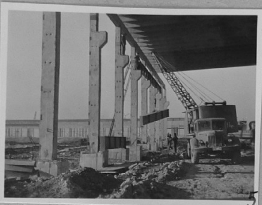
77-3881-5 Бригадата на Христо Опрев работи върху монтажа на кислородния цех /Кр.Узунова/МД
