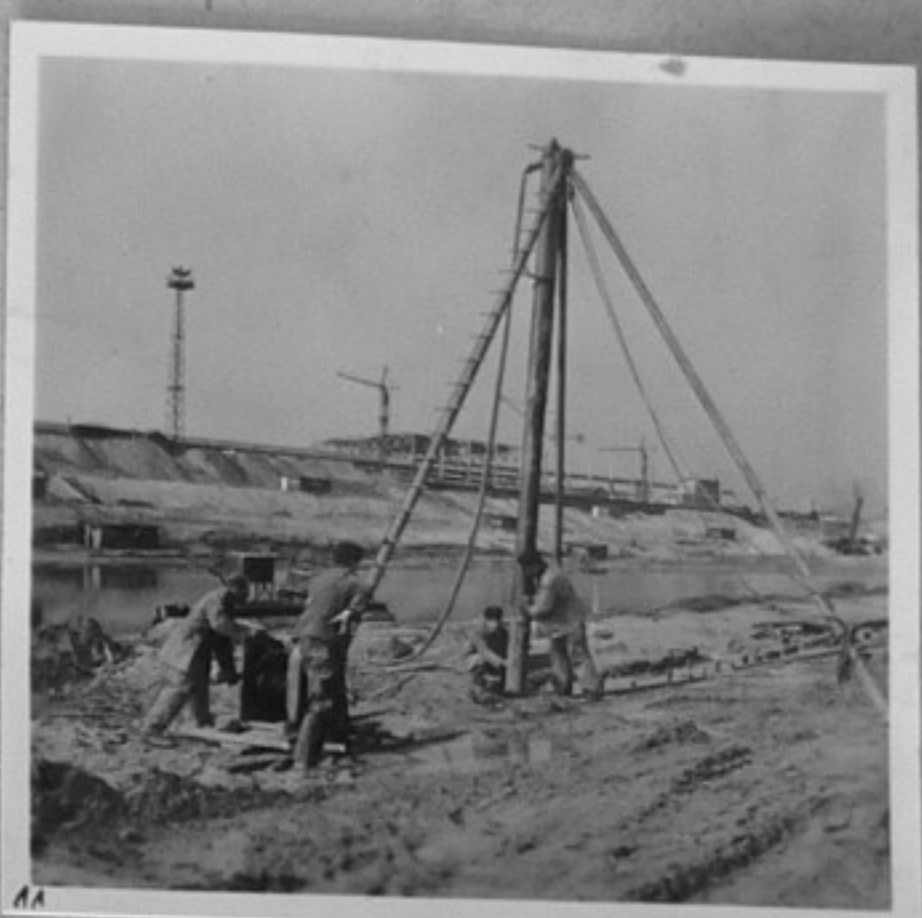
6-11 - Етапи на набиването на иглофилтри за изпомпване на подпочвени води.
