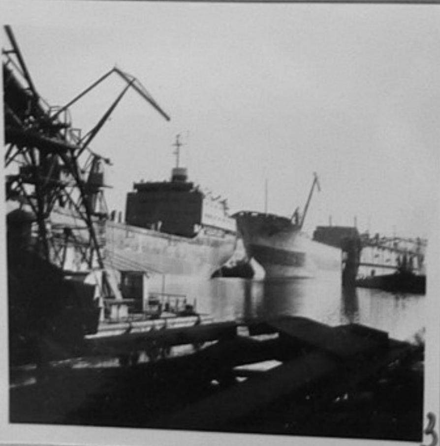
71-313-3,8,10-Изглед от завода.
