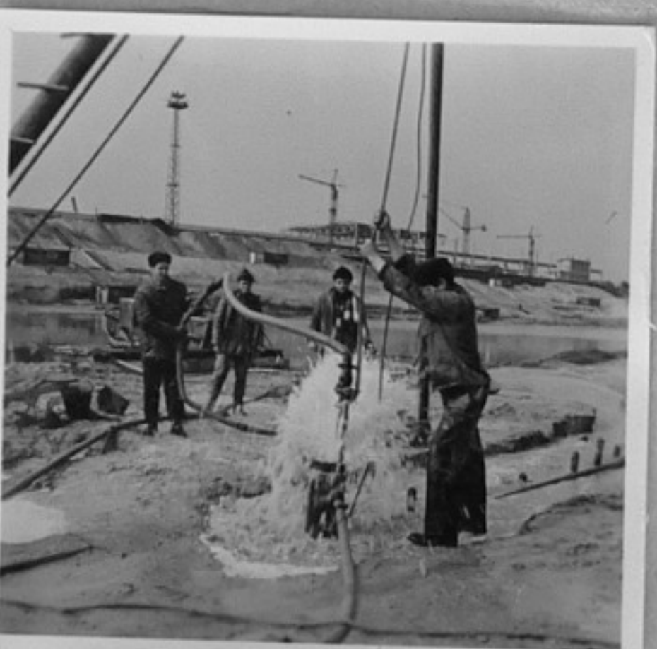
1, 6, 11 - Етапи от набиването на иглофилтри за изпомпване на подпочвени води.
