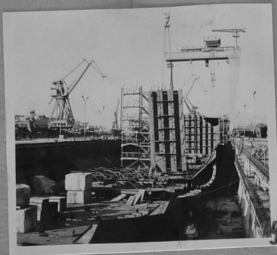
71-314-9-Строежът на 23500-тонен товарен корпус. /Рад. Парушев/ ИК
