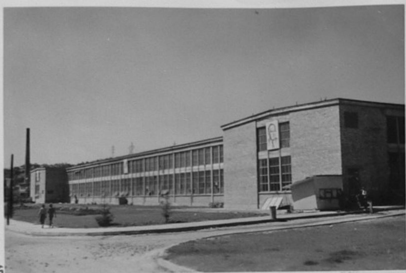
5-Външен изглед на завода.
