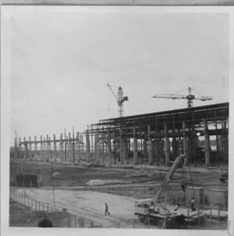
79-1014-11-Корпусът на Механо-монтажния цех. /М.Георгиева/АШ
