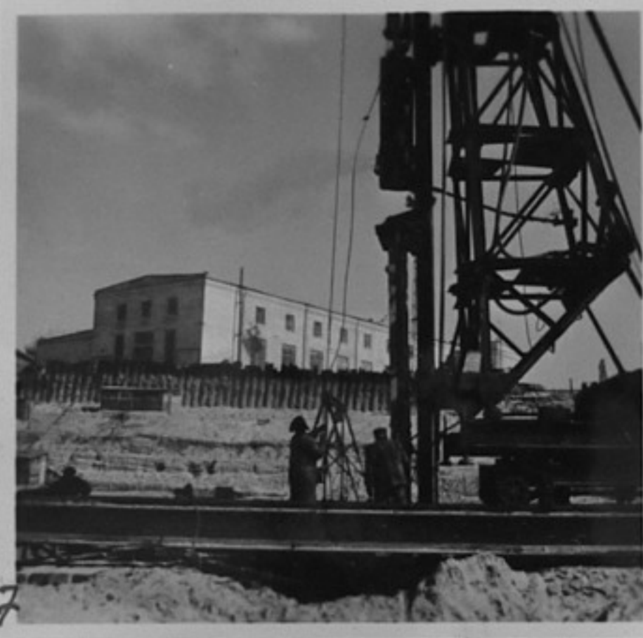
7- Набиване на пилотите на шпунтовите огради.
