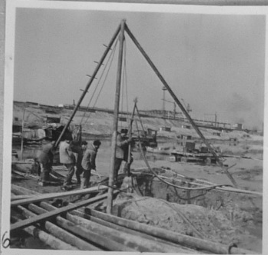
6-11 - Етапи на набиването на иглофилтри за изпомпване на подпочвени води.
