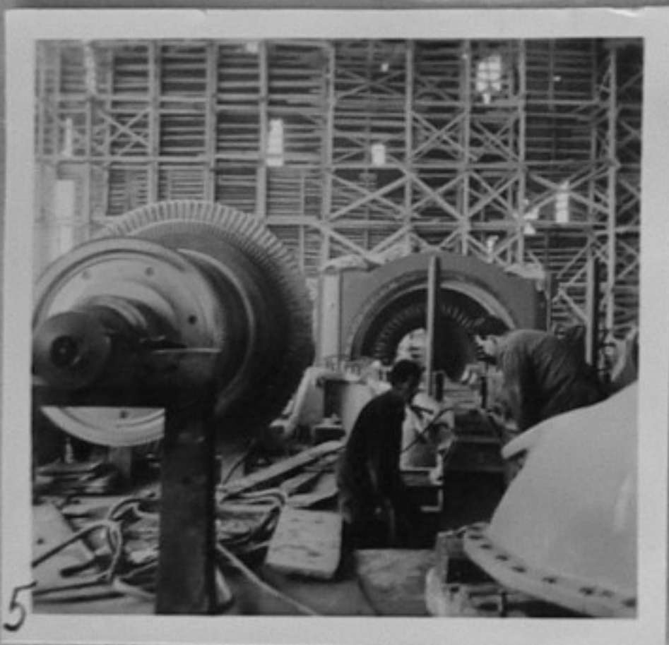
65/707-5,7,8 - Монтаж на втора турбина - работи бригадата на Крум Славчев. /Парушев/ ММ
