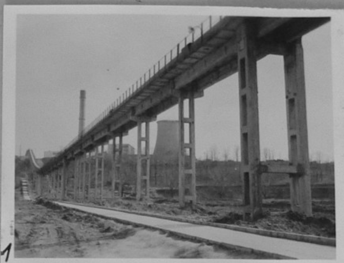
65/755-1,2 - Външен изглед на специалната естакада за въглеподаването. /Янев/ ММ
