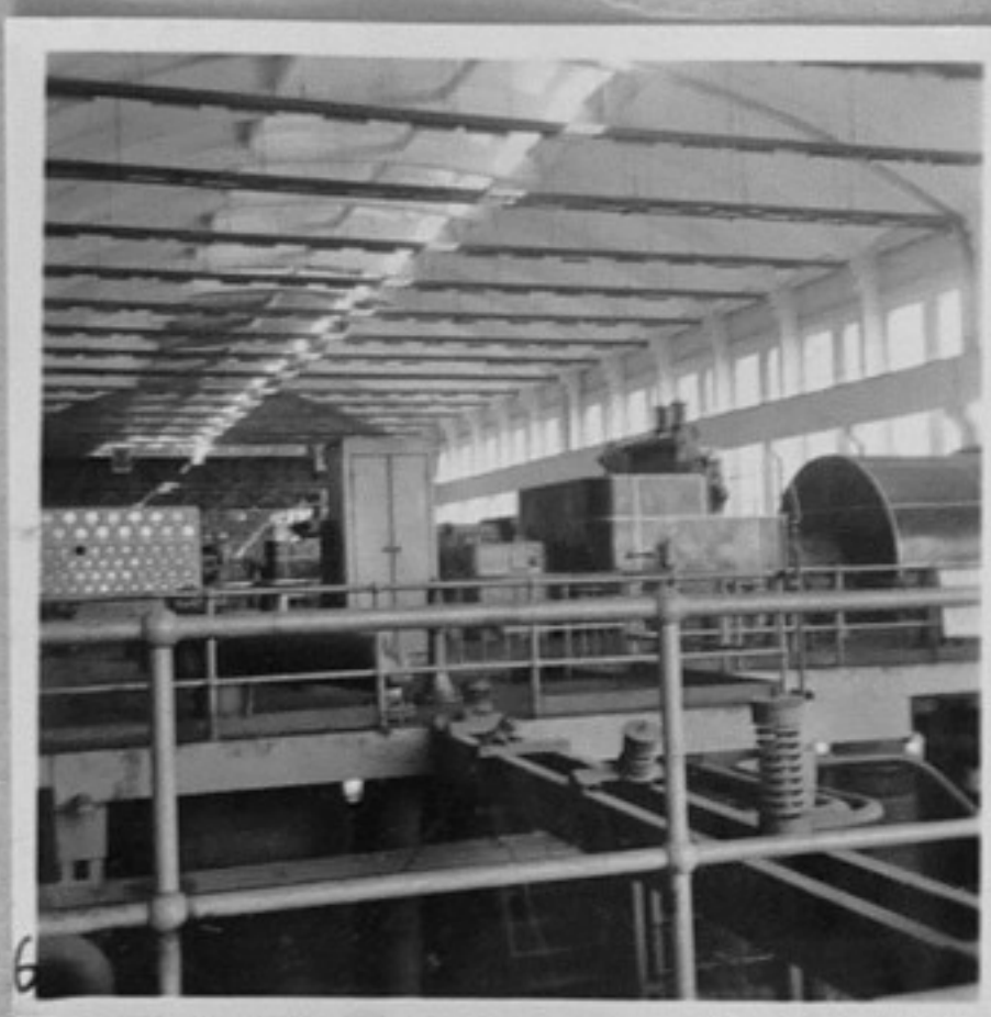
6-Общ изглед от котелния цех № 7.
