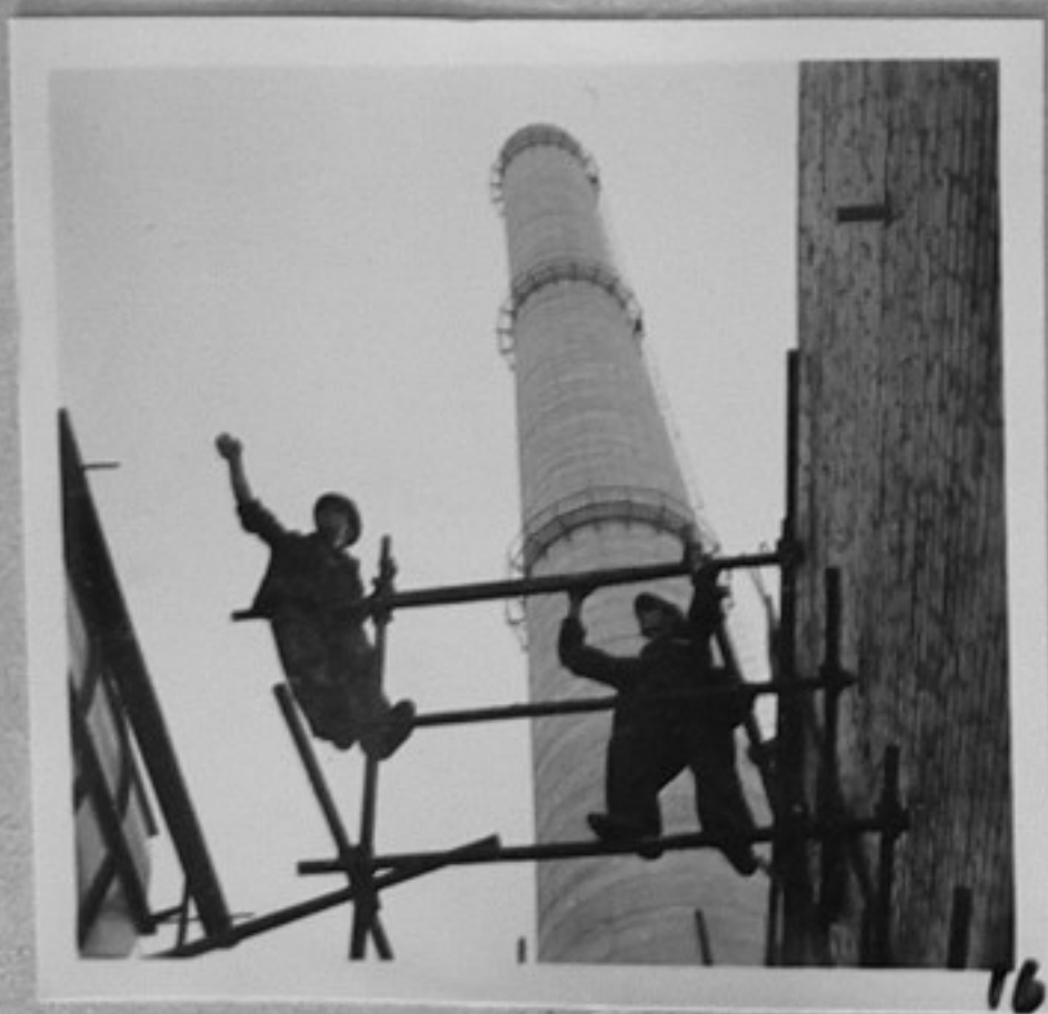
68-2446-16-Строители на ТЕЦ - Сливен.
