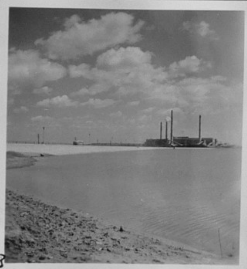
63/1023-3-Общ изглед на топлоцентрала с езерото. /Божков/ ММ
