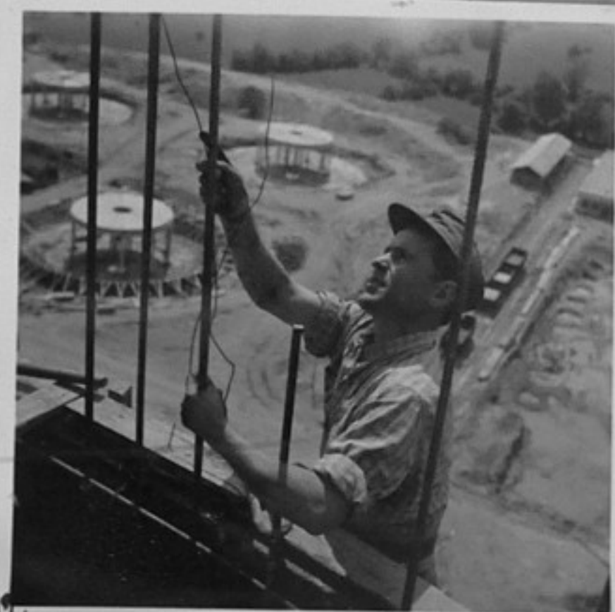
12- Котлажистът Мирчо Стоянов на върха на котла, е увиснал във въздуха, за да закрепва котлажните табли.
