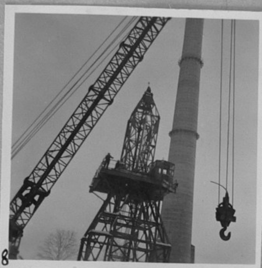
8-Монтаж на огромния релсов /подвижен/ кулукран модел КБ 300.
