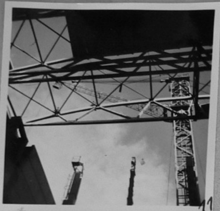
65/2257-11 - На строежа на главния корпус /Йорданов/ ЕИ
