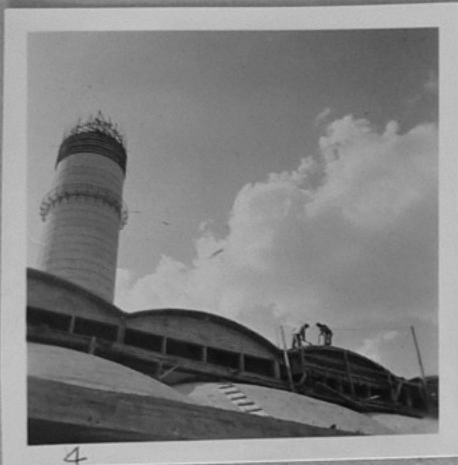
4- Бетонджии от бригадата на Станчо Миленов изливат бетон на покривните чурепки.
