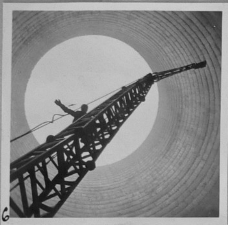
6-Монтаж на вътрешността на голямата охладителна кула на ТЕЦ.
