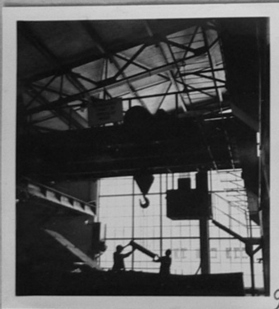
9-Монтаж на тръбопроводите в пресовия цех.
