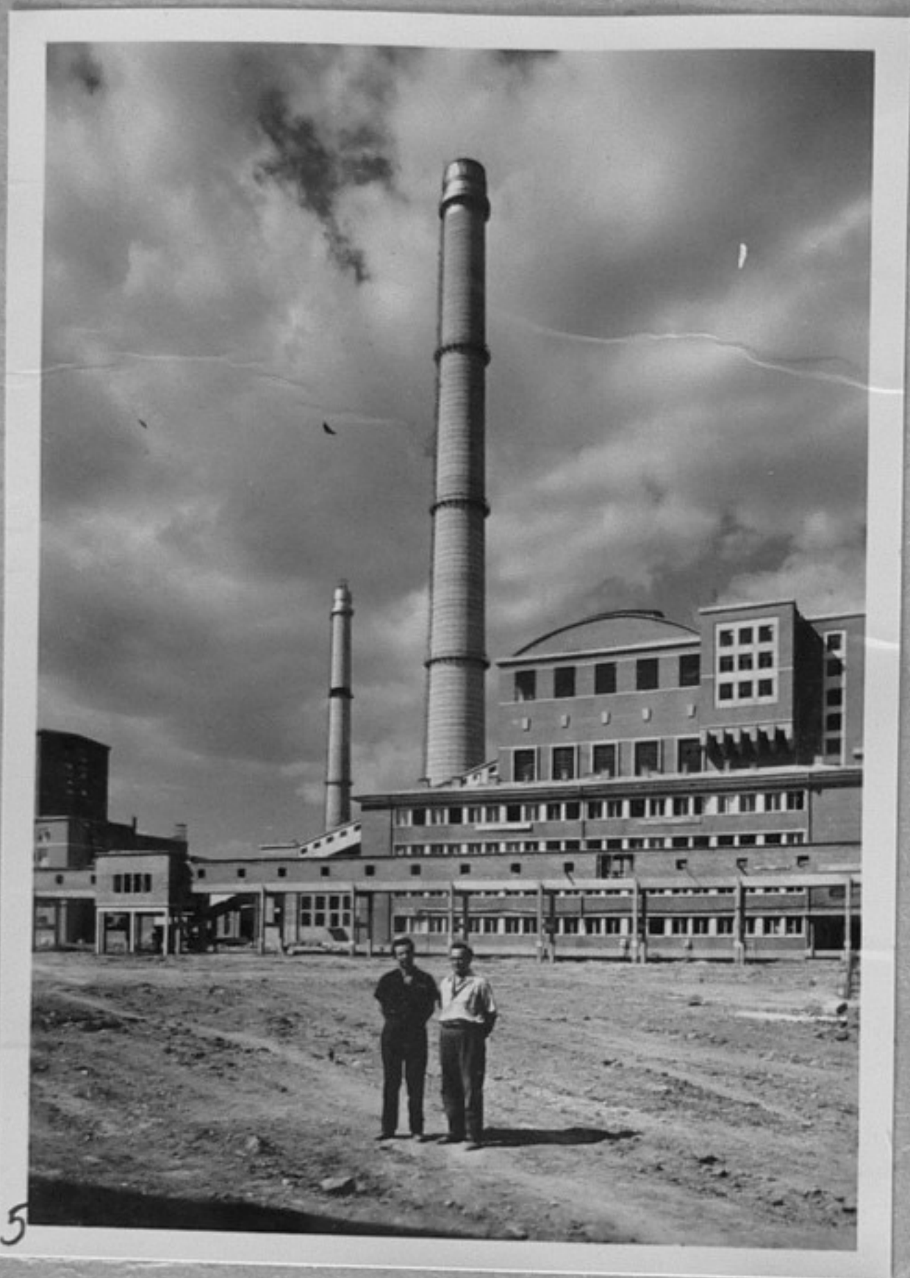
5- Корпуса на централата ТЕЦ "МАРИЦА-ИЗТОК".
