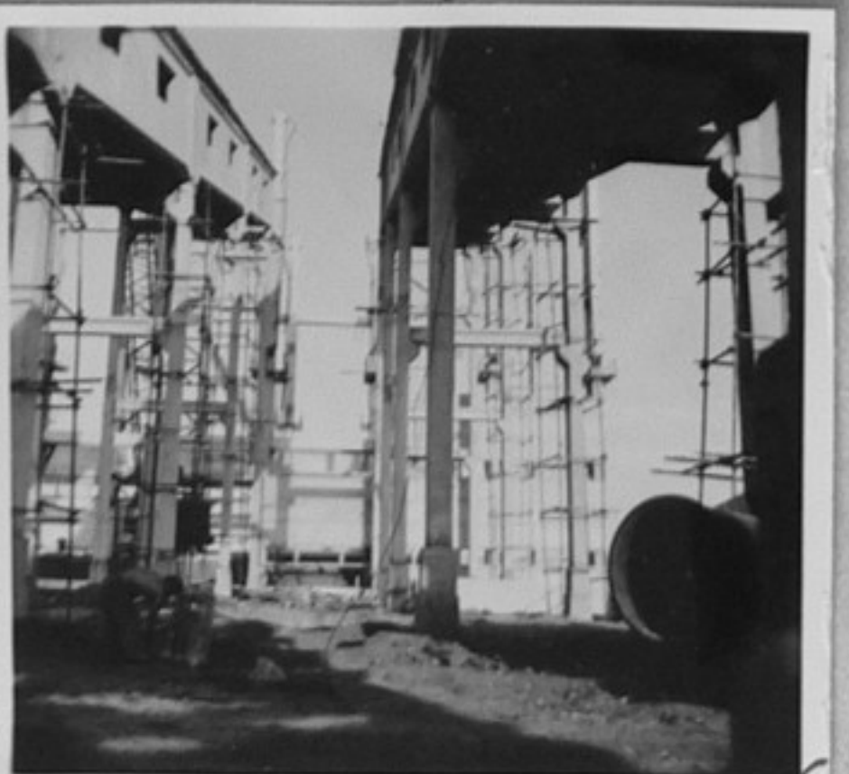
5 - Естакада въгледодаване към сушилни цех
