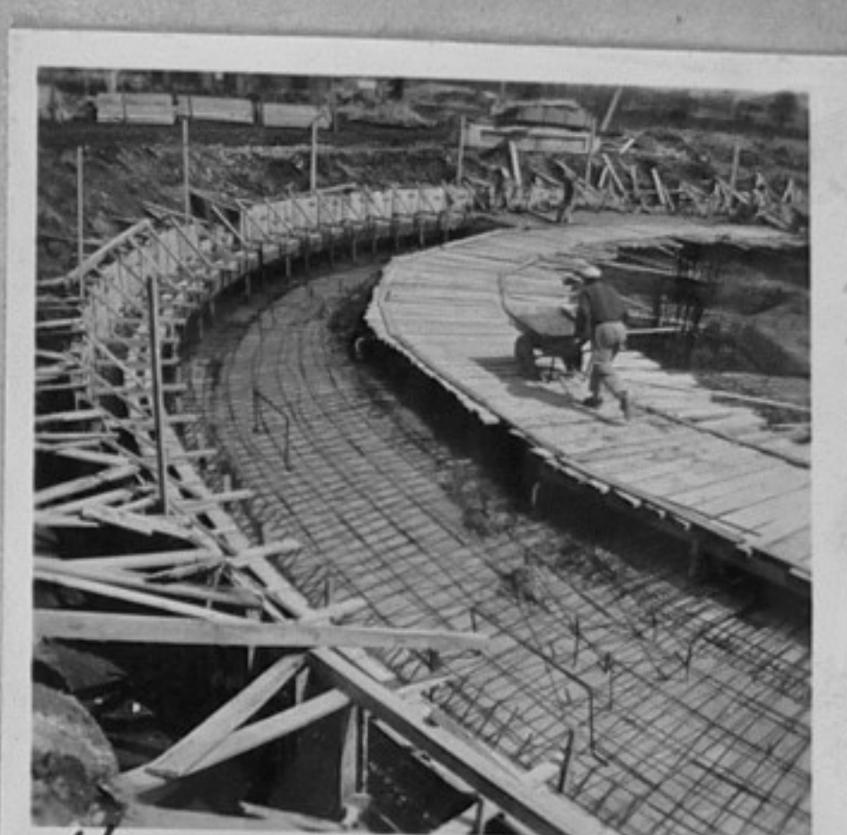
11-Полагане на основи от бетон за резервоар.
