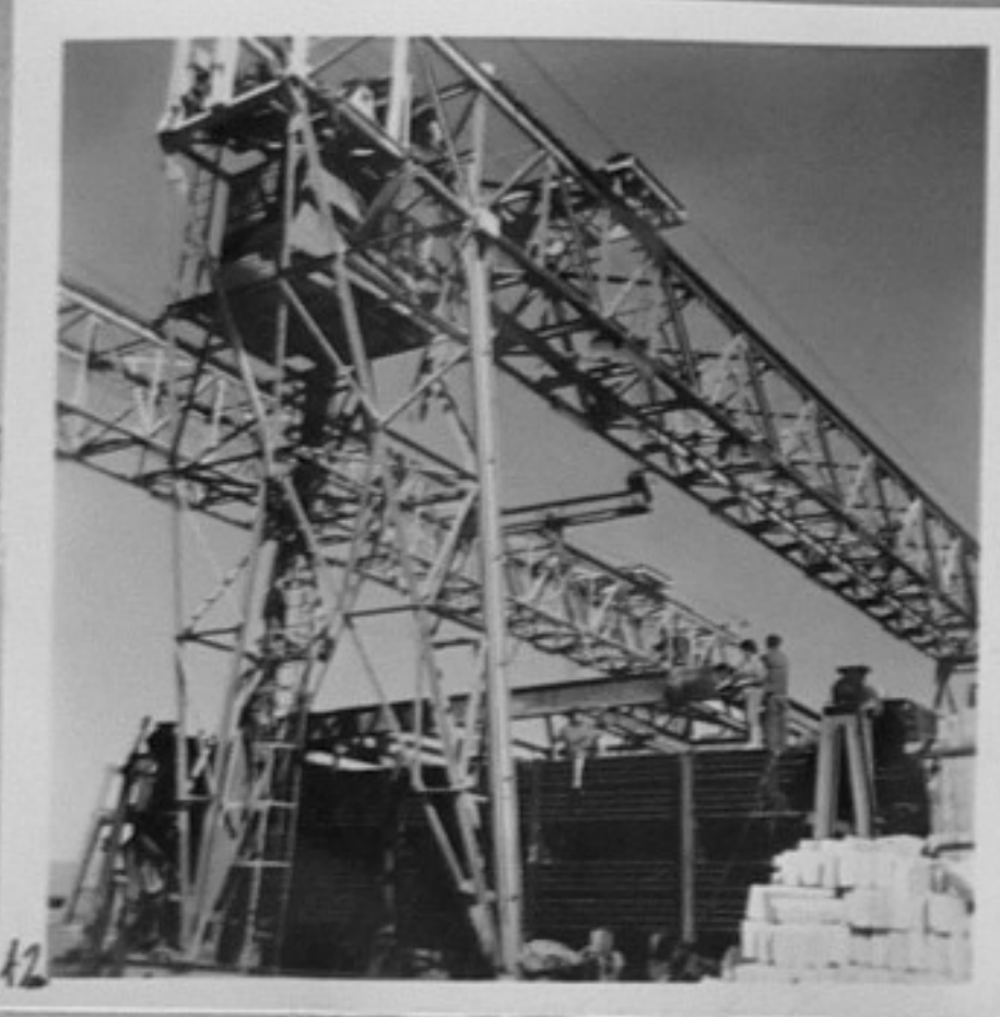
62/2563-12-вдигане на блок за 7-мия котел. /Йорданов/ ММ.
