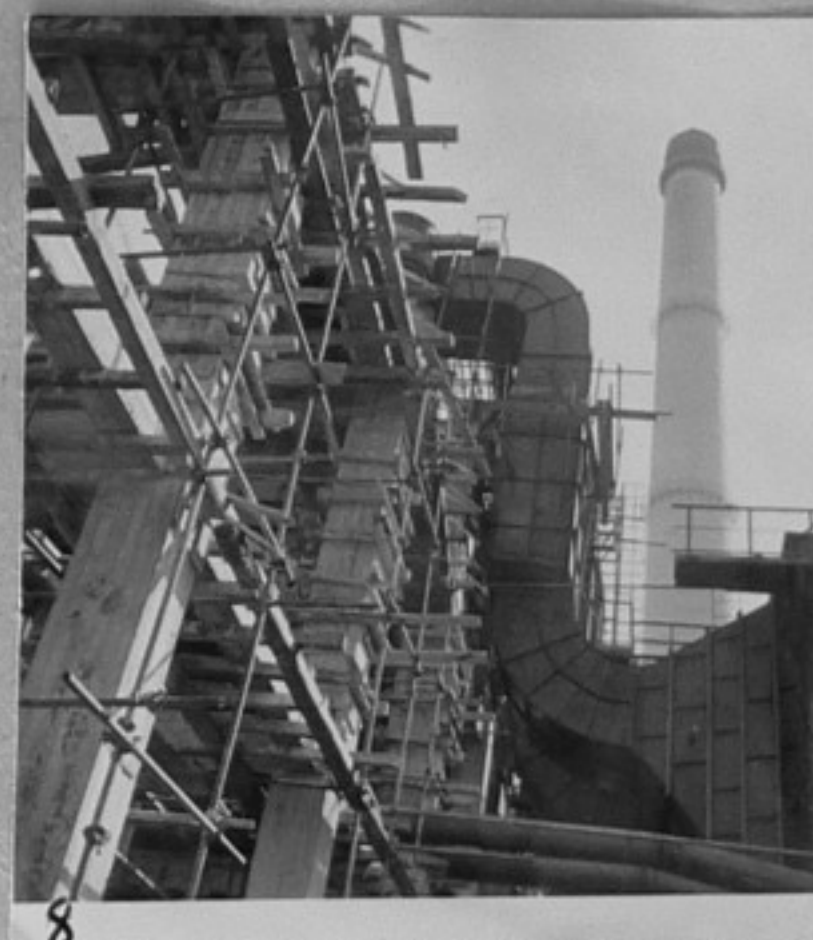
63/1025-8-В монтаж са инсталациите на разширението на ТЕЦ. /Божков/ ММ
