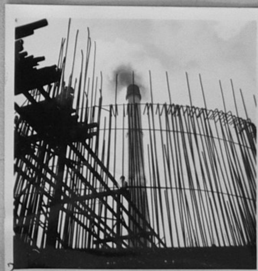
62/1007-2- Заварчикът Лико Проданов от метало-конструкт.бригада на Господин Казамазов работи на 180-метровия комин/Чаръкчиев/.
