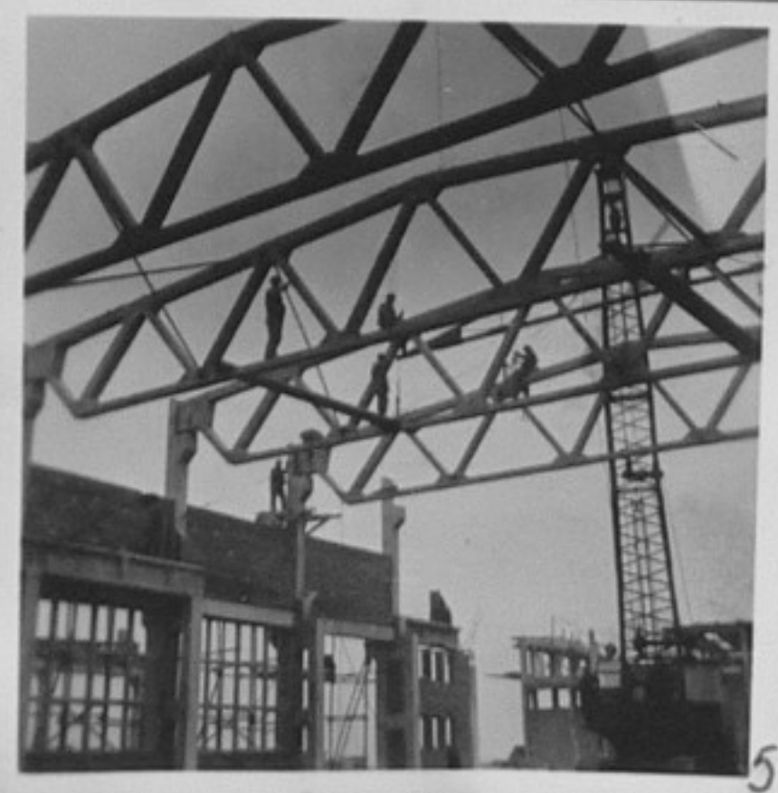
59/3495-1,5 - Работа по монтажа на големите покривни сглобяеми ферми на механичната работилница при бри- кетната ф-ка при ТЕЦ "Марица изток". /Янев/
