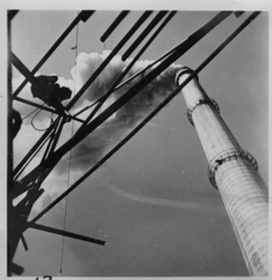
12-Строеж на 180-метровия комин, най-голям за сега на Балканите. Заварчикът Апостол Дамов заварява основните мостове на коминна/Чаръкчиев/.
