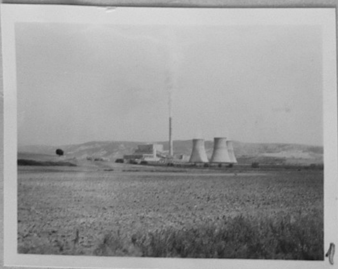
80-2787-1 80-2787-1 Външен изглед на ТЕЦ "Бобов дол" Кр.Узунова/МД
