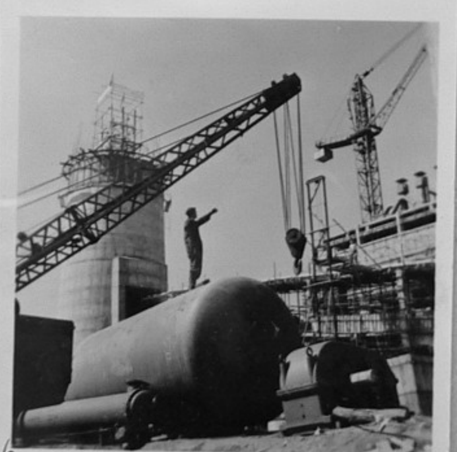
6,8 - Строежа на главния корпус.
