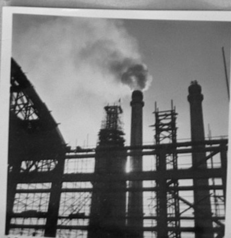
10-Последен етап от за- вършването на 7,8,9,10 котелна сграда.
