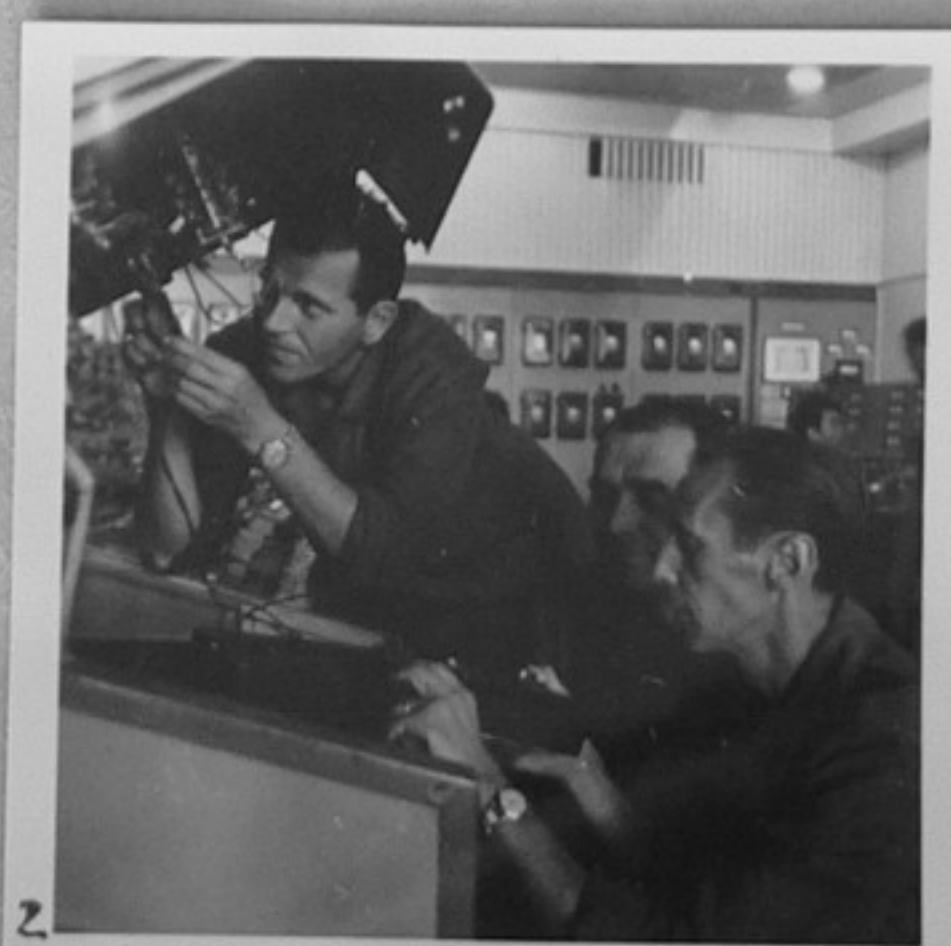
64/2451-2-Монтаж на пулт в топлинния щит. /Ангелов/ ММ
