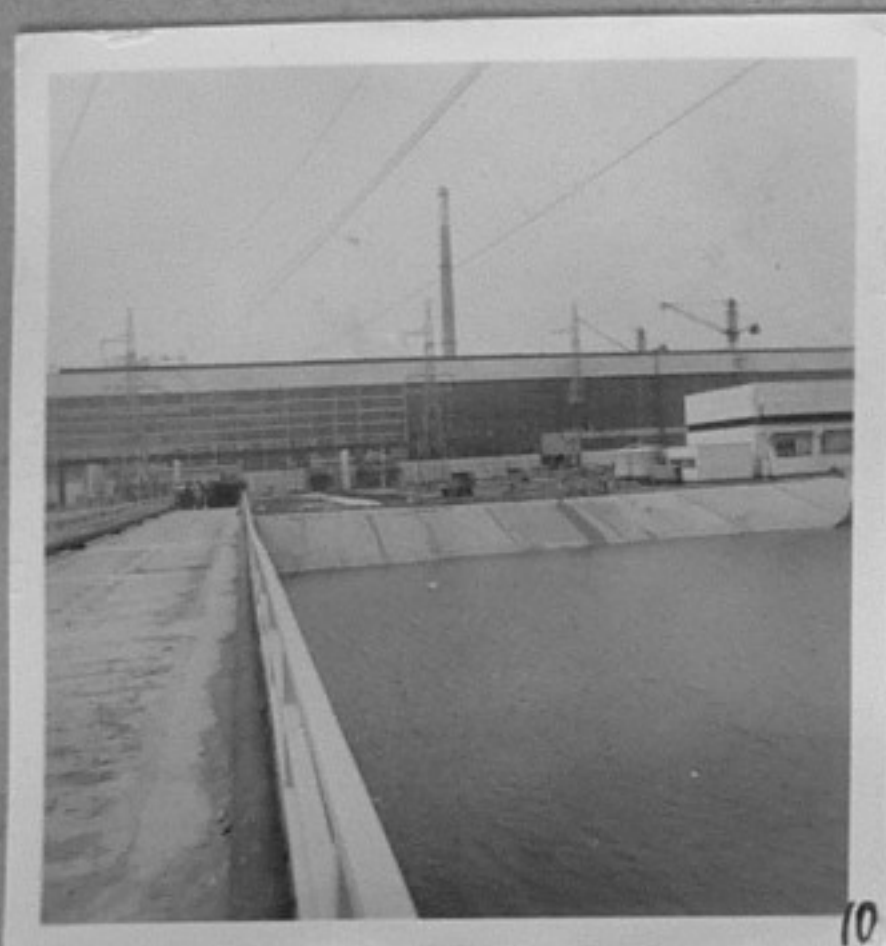
74-2829-10-Каналите за снабдяване централата с вода. /О.Юскеселиев/ТК
