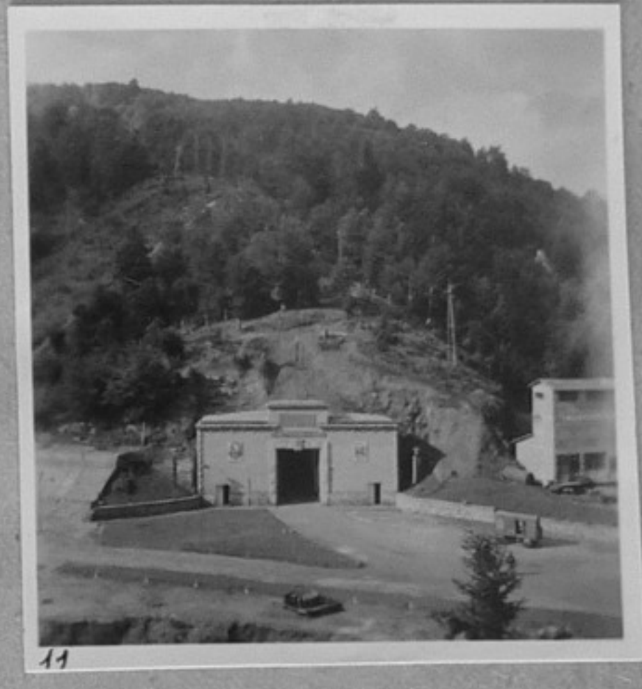
11 - Входът на ВЕЦ.
