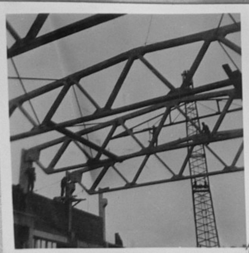
59/3495-1,5 - Работа по монтажа на големите покривни сглобяеми ферми на механичната работилница при бри- кетната ф-ка при ТЕЦ "Марица изток". /Янев/
