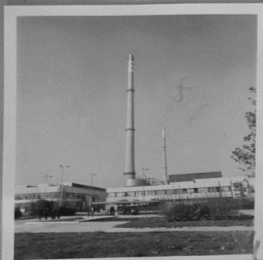
80-3759-4-Химически цех. В дъното се виждат комините на трите енергоблока.
