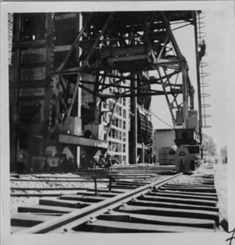
8-Монтаж на огромния релсов /подвижен/ кулукран модел КБ 300.
