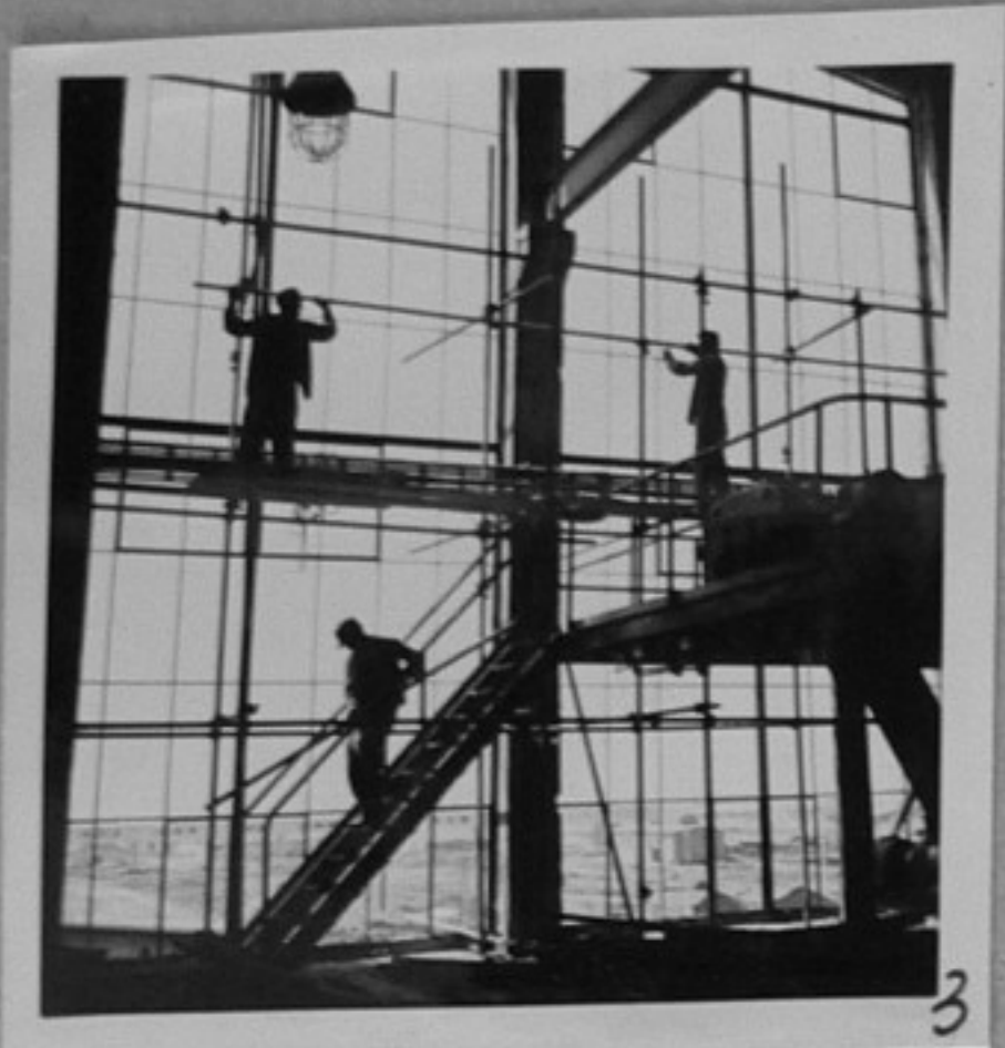
3-Монтаж на тръбно скеле в охладителното отделение.
