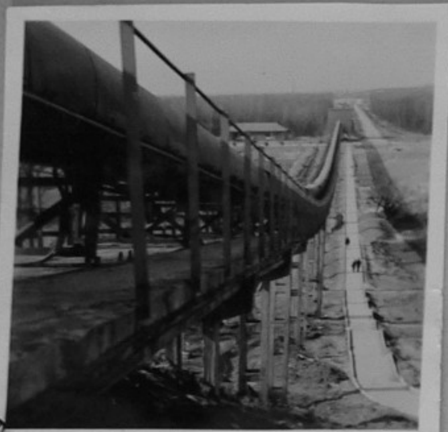
65/755-1,2 - Външен изглед на специалната естакада за въглеподаването. /Янев/ ММ
