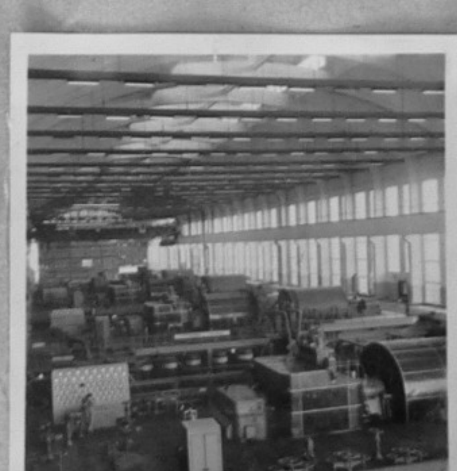
12-Общ изглед от турбо- генераторния пех.
